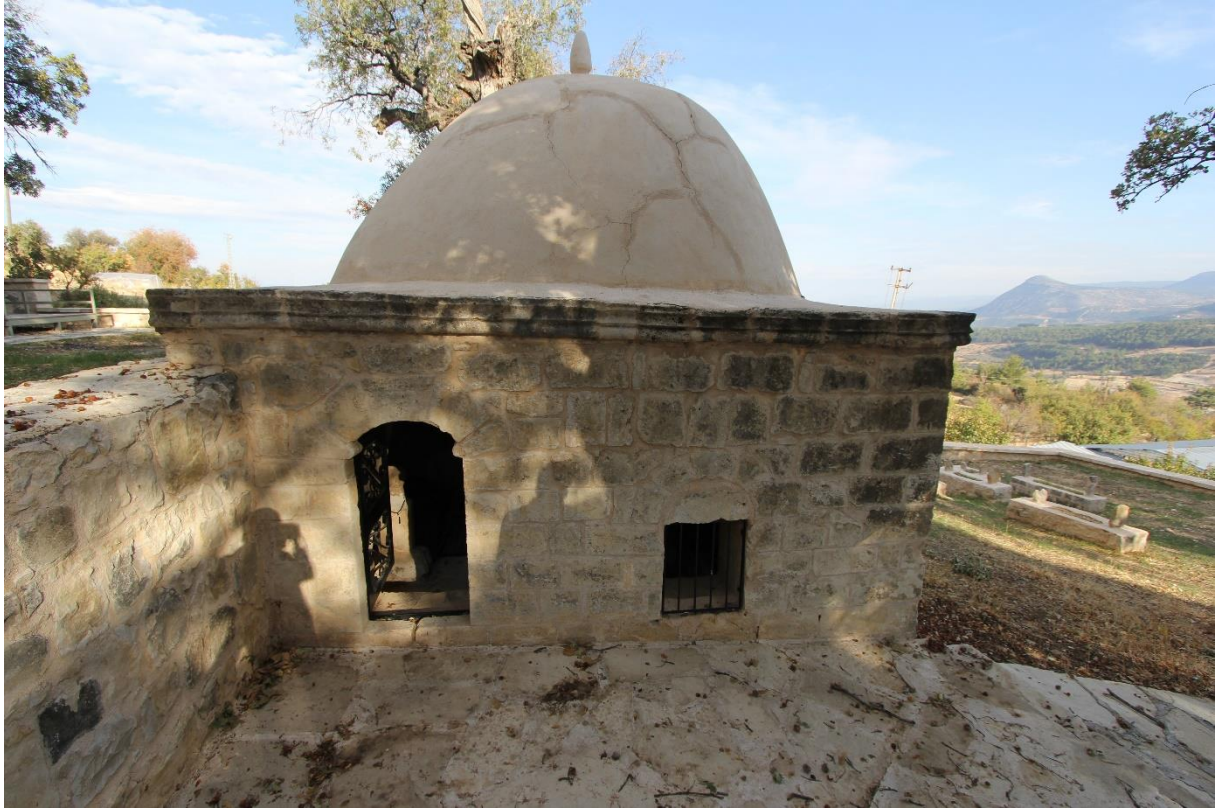
Görsel 137: Bozca Şeyh Türbesi Doğu Cephe
