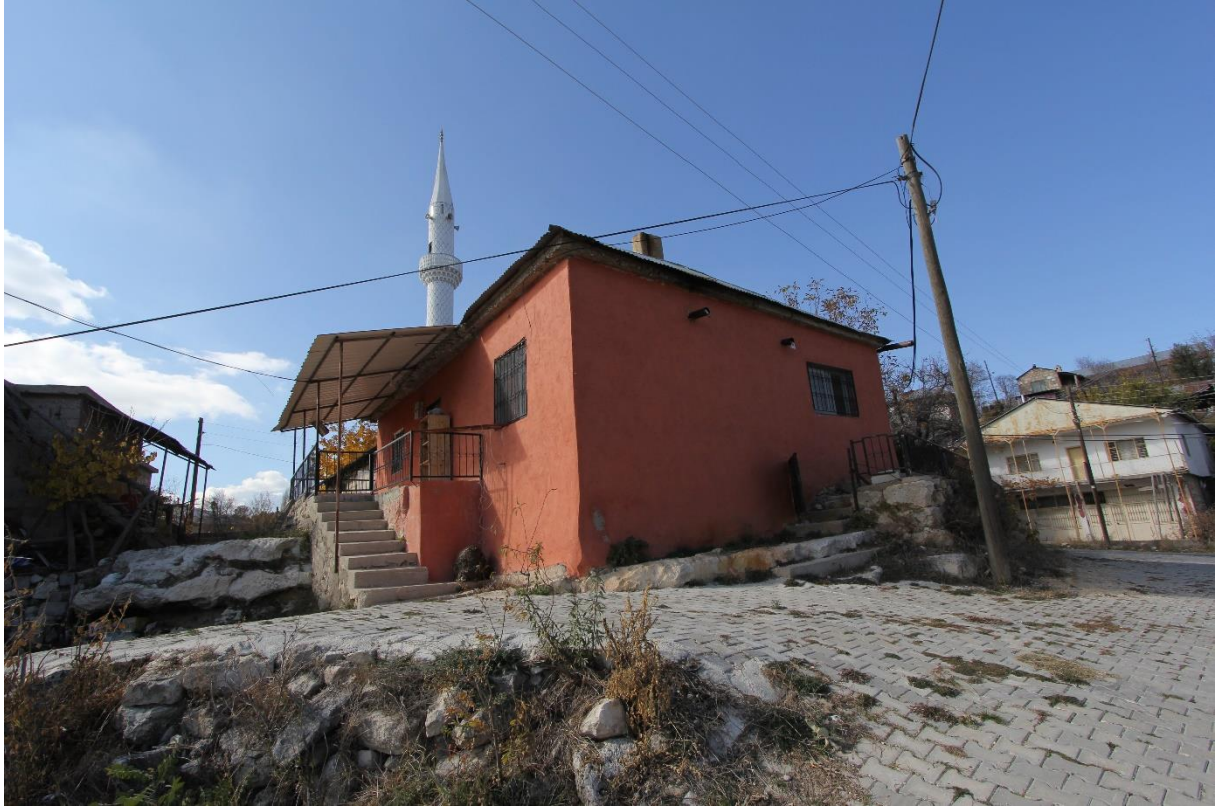
Görsel 72: Taşoluk Medrese Cami Doğu Cephe
