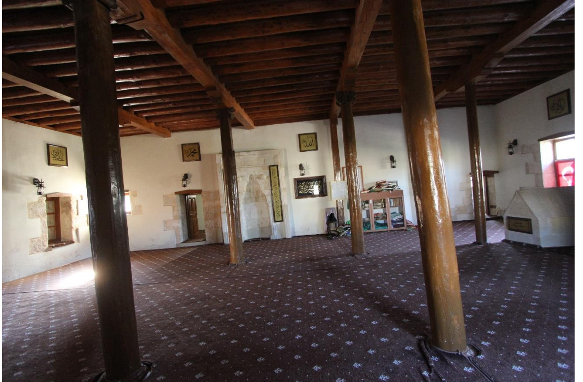
Görsel 12: Şeyh Ali Semerkandi Zaviyesi Mescidi Güney Duvar
