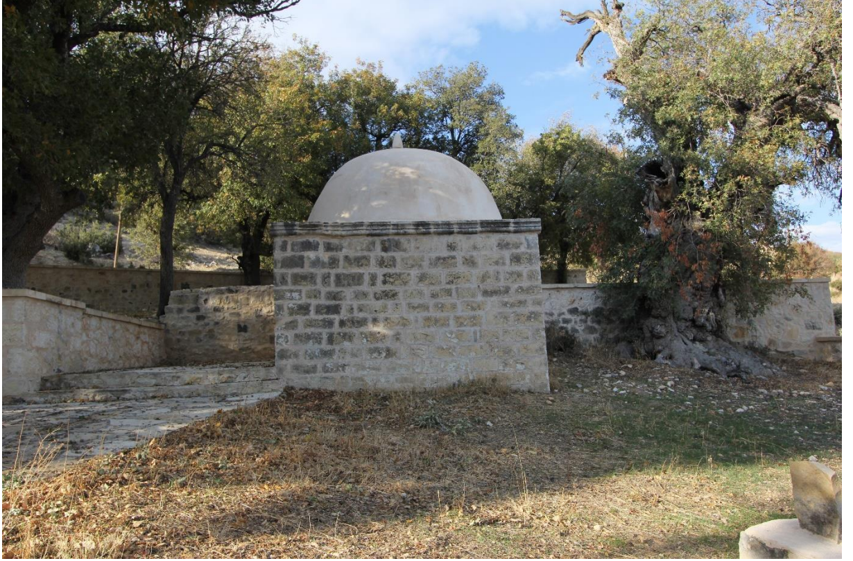
Görsel 140: Bozca Şeyh Türbesi Güney Cephe
