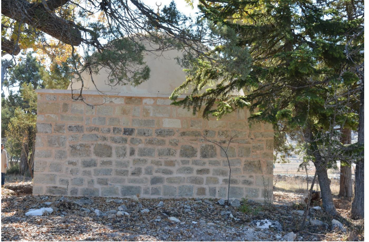
Görsel 96: Halife Yakup Türbesi Kuzey Cephe
