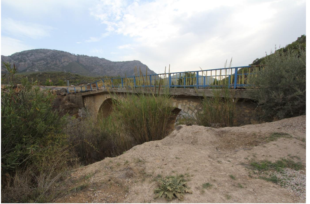
Görsel 201: İlice 2 Köprüsü Mansap görünümü
