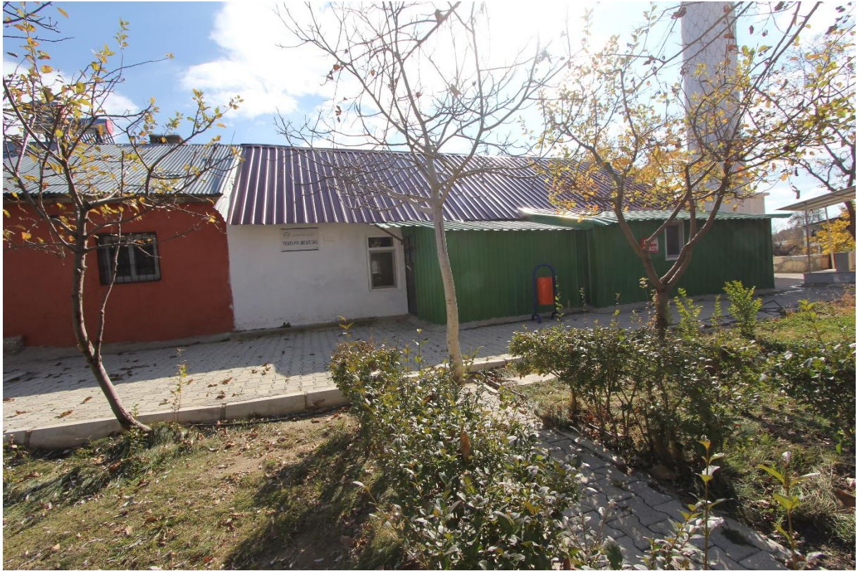
Görsel 71: Taşoluk Medrese Cami Genel Görünüm
