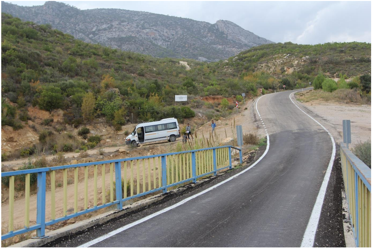
Görsel 202: İlice 2 Köprüsü Tabliye Görünümü
