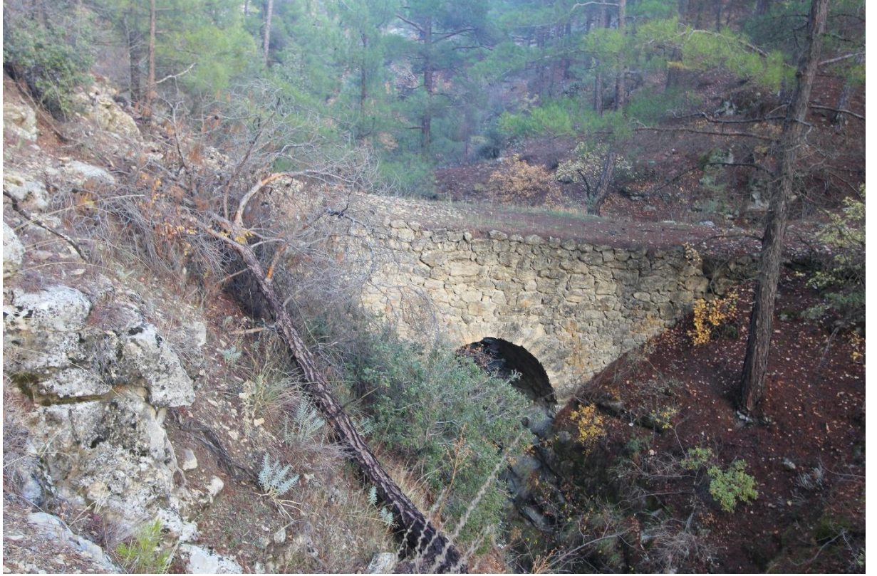
Görsel 191: Konur Eski Köprü Mansap Görünümü
