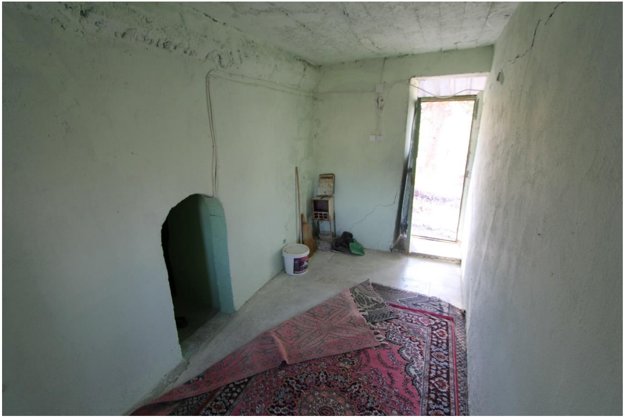
Görsel 155: Şeyh İsa Türbesi Giriş Bölümü
