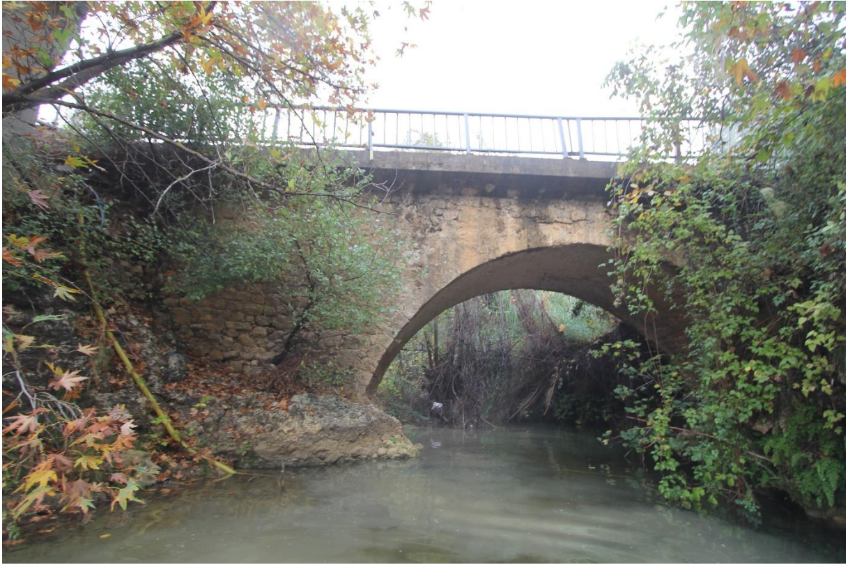
Görsel 196: İlice 1 Köprüsü Menba Görünümü
