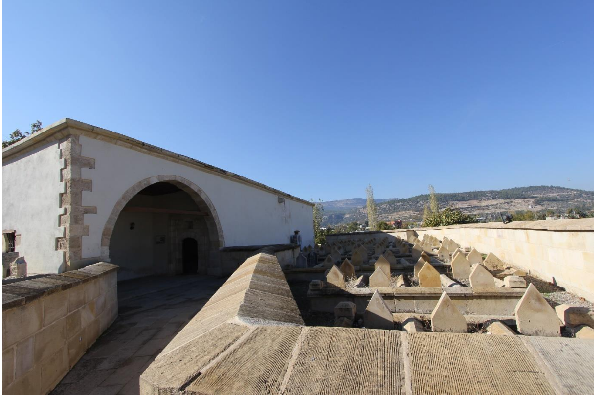
Görsel 7: Şeyh Ali Semerkandi Zaviyesi Kuzey Cephe Görünümü
