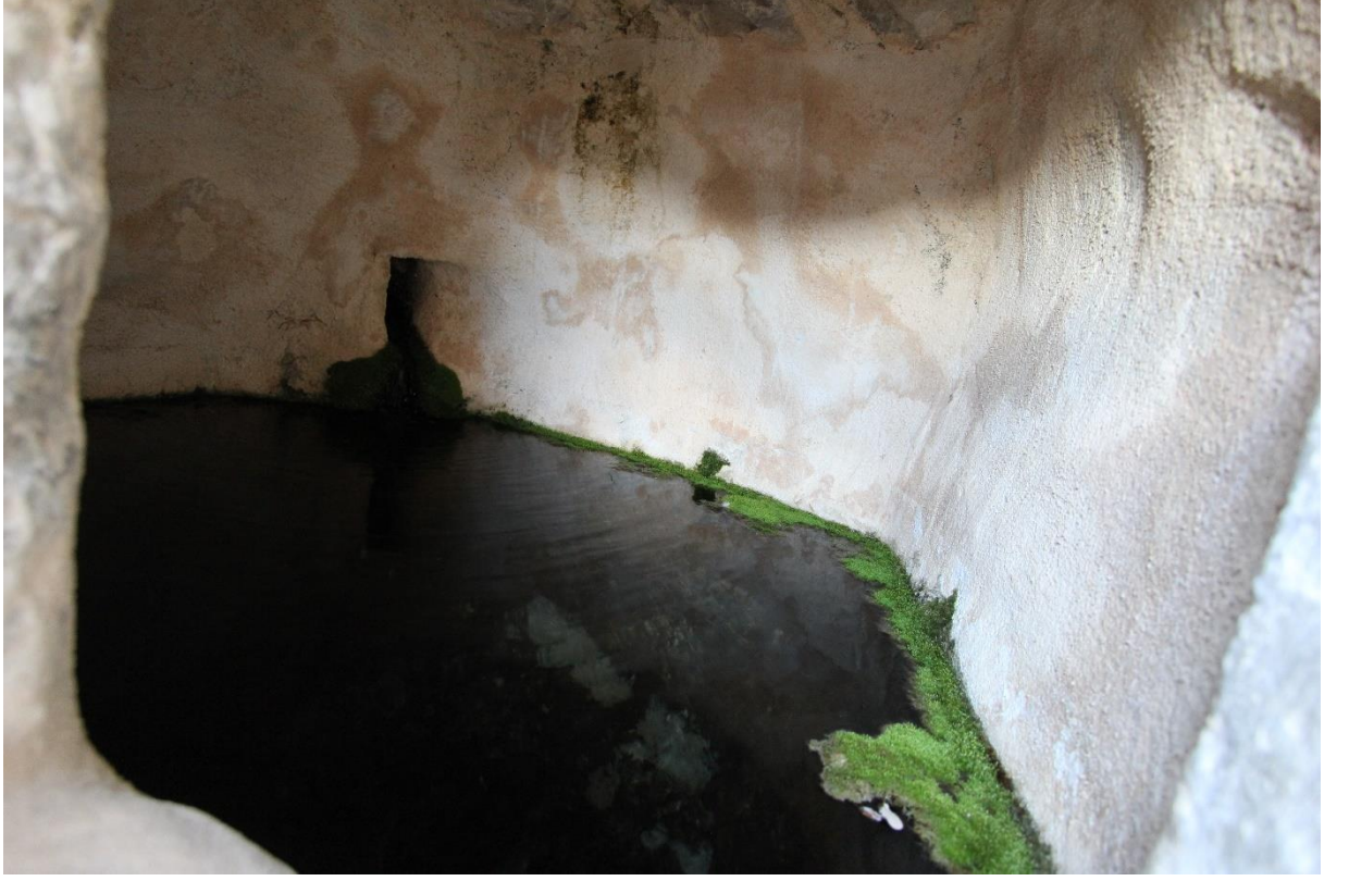
Görsel 164: Bozca Şeyh Çeşmesi Tatlı Su Dinlendirme Havuzu
