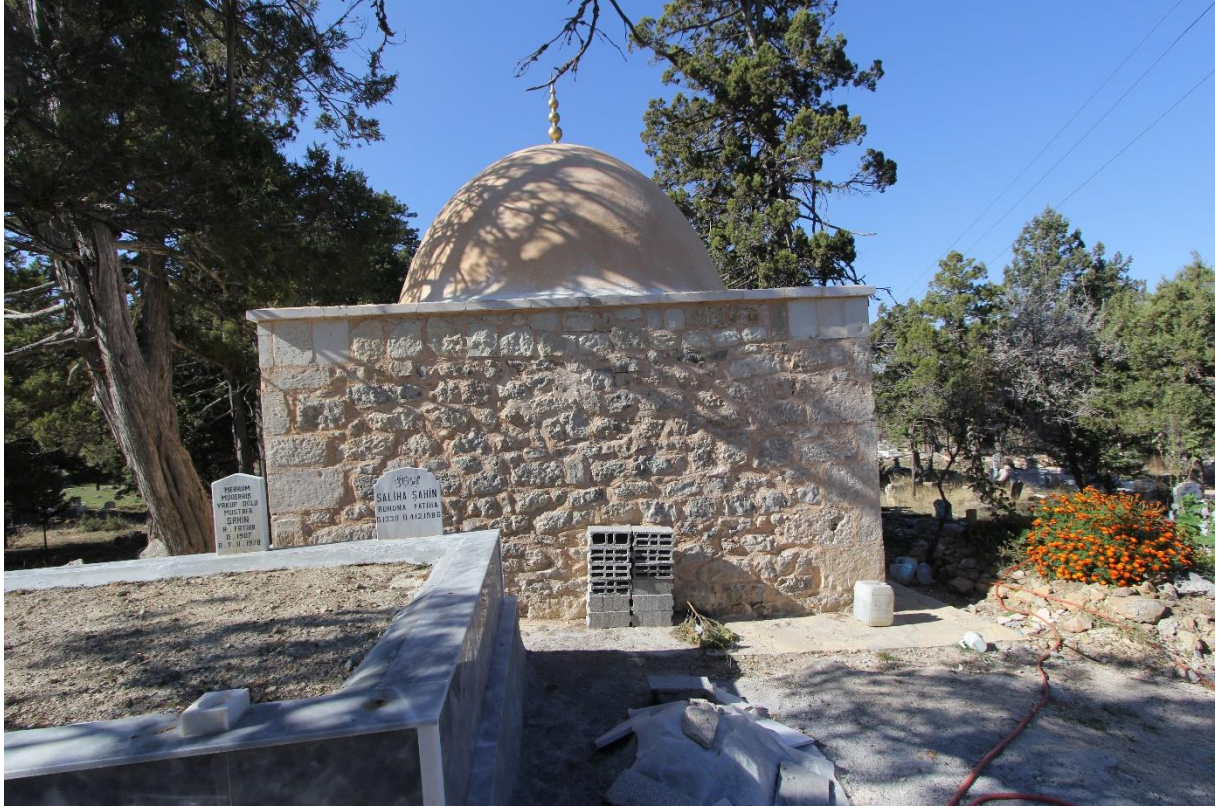
Görsel 106: Şeyh Ahmet Türbesi Doğu Cephe
