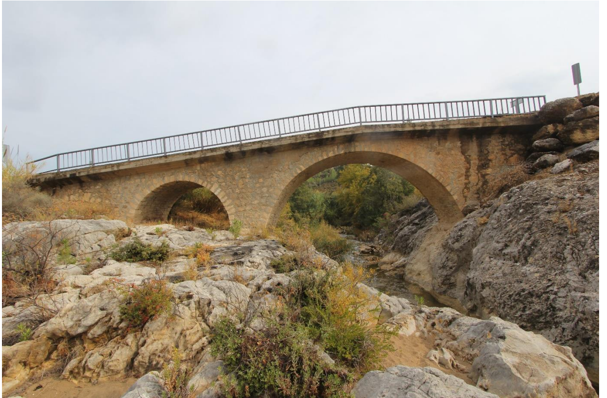
Görsel 200: İlice 2 Köprüsü Menba görünümü
