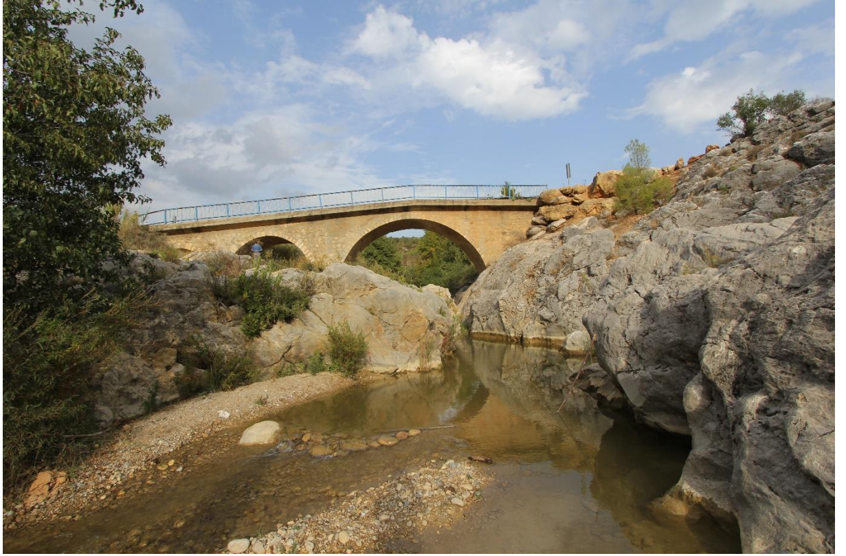
Görsel 199: İlice 2 Köprüsü Menba görünümü
