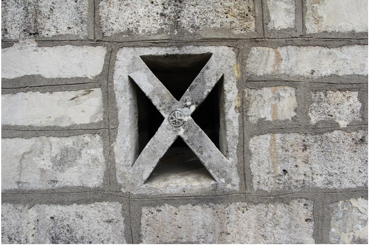
Görsel 114: Şeyh Ömer Türbesi Güney Cephe Pencere Detay
