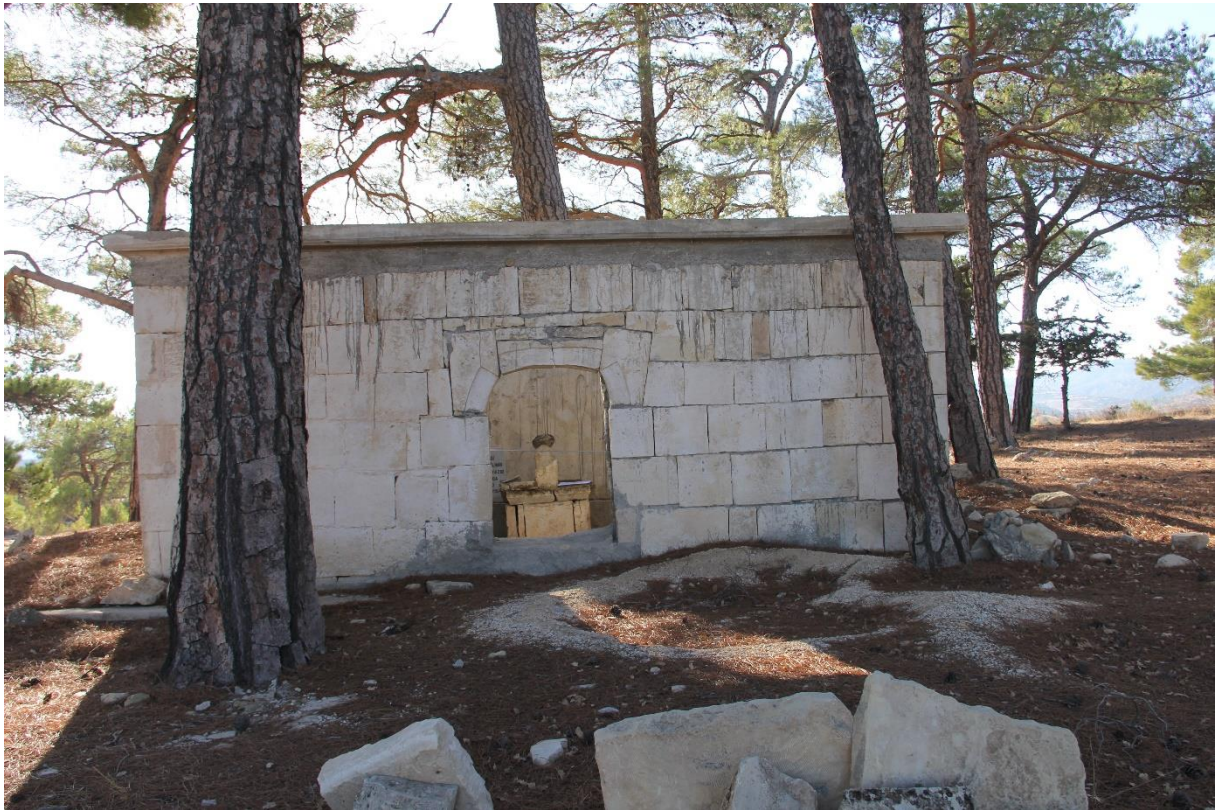
Görsel 131: Şeyh Abdi Türbesi Doğu Cephesi
