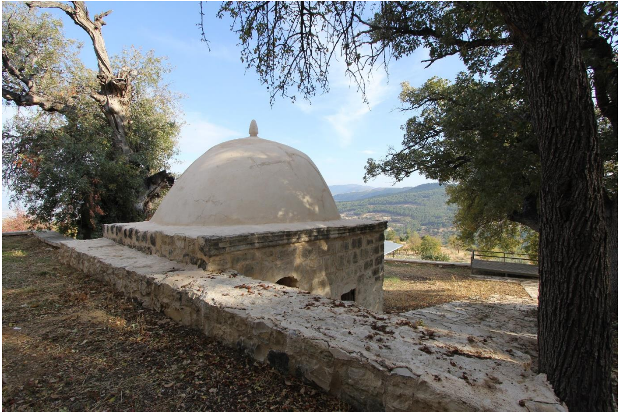
Görsel 139: Bozca Şeyh Türbesi Kuzey Cephe
