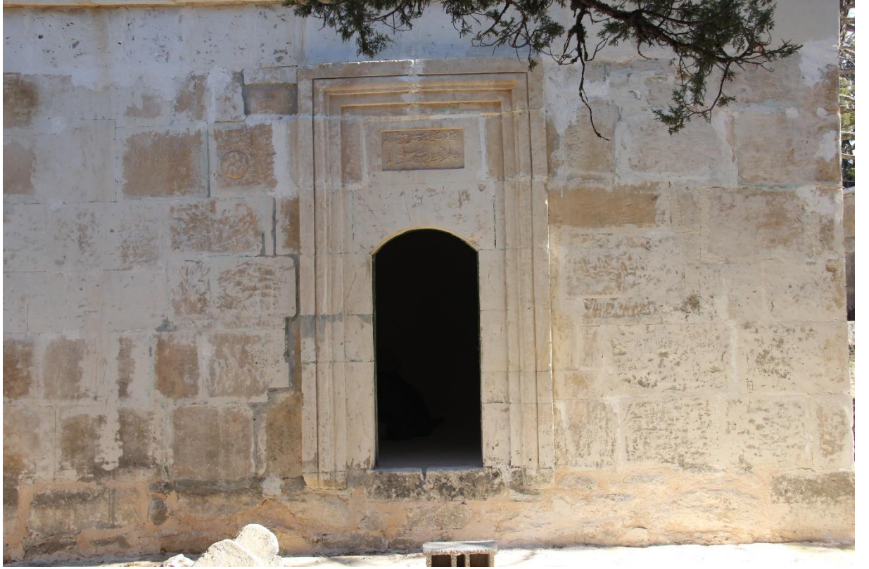
Görsel 108: Şeyh Ahmet Türbesi Batı Cephe Giriş Kapısı
