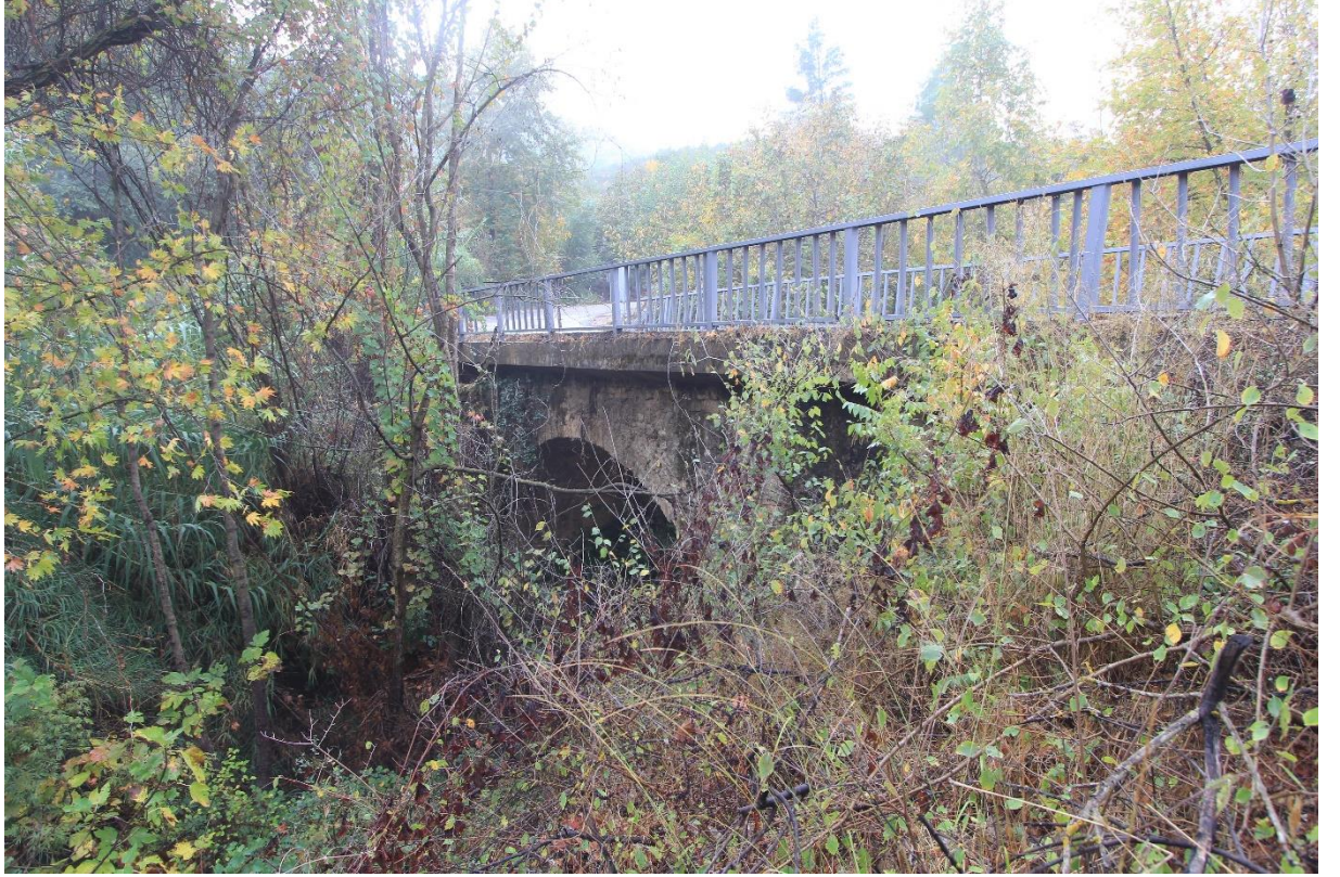
Görsel 197: İlice 1 Köprüsü Mansap Görünümü
