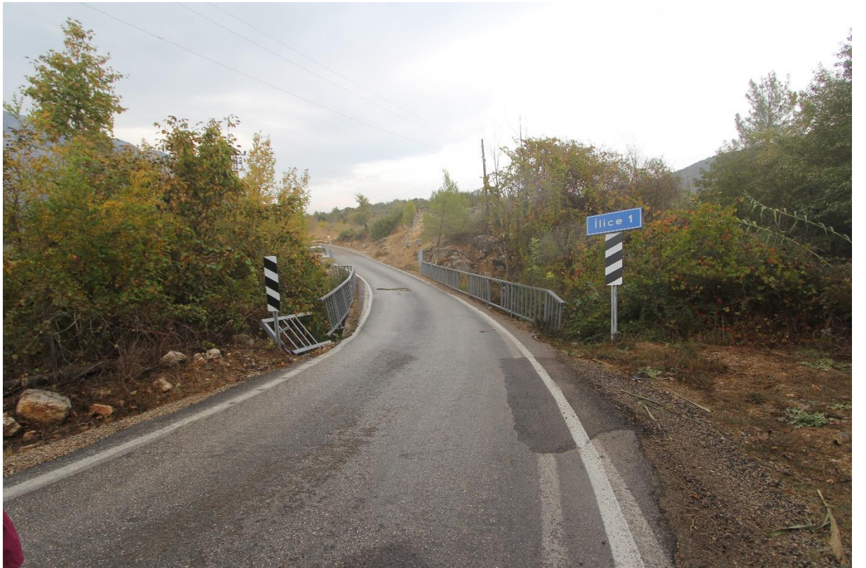
Görsel 198: İlice 1 Köprüsü Tabliye Görünümü
