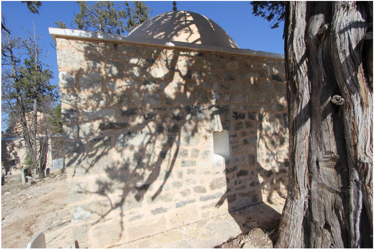
Görsel 87: Şeyh Yakup Türbesi Güney Cephe
