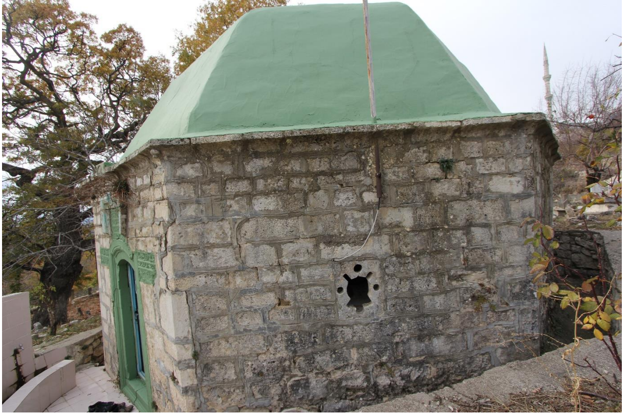
Görsel 116: Şeyh Ömer Türbesi Kuzey Cephe
