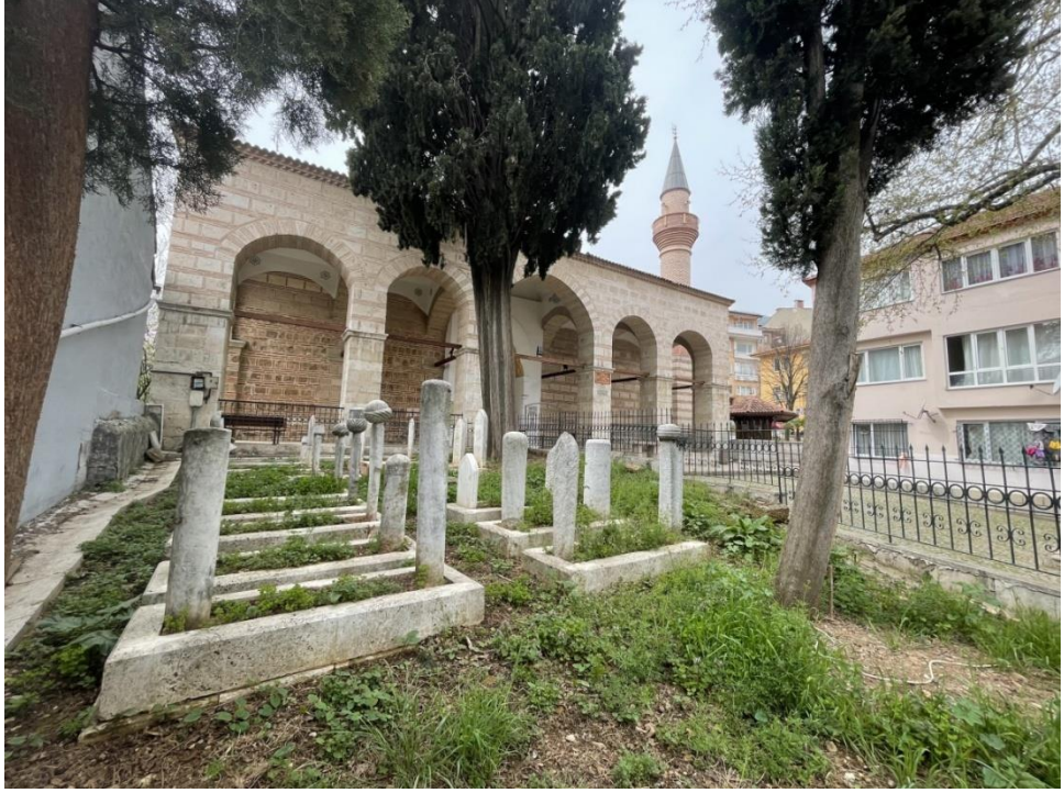
Görsel 41: Çandarlı Ali Paşa Cami Ön Cepheden Görünümü
