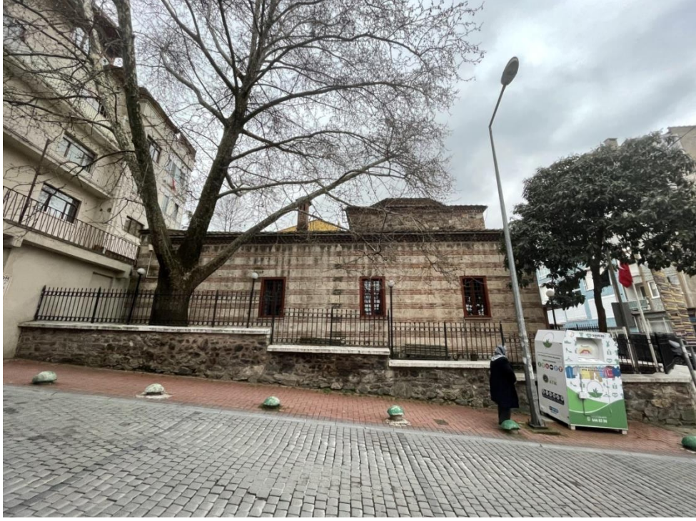
Görsel 62: Lala Şahin Paşa Medresesi Sol Cepheden Görünümü
