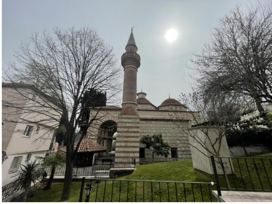
Görsel 39: Çandarlı Ali Paşa Cami Sol Cephe Görünümü
