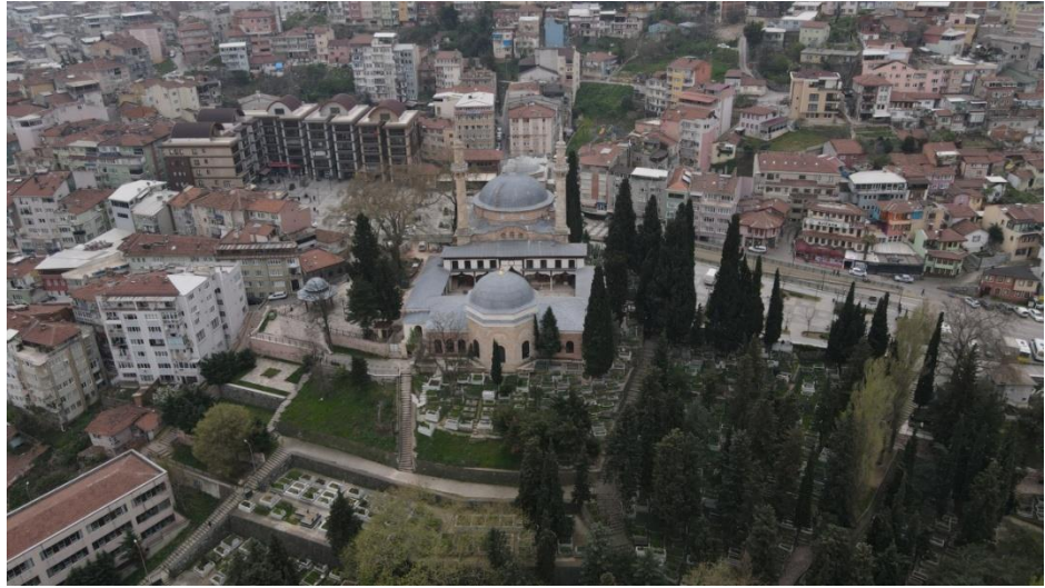
Görsel 50: Emir Sultan Cami Arka Cepheden Hava Görünümü
