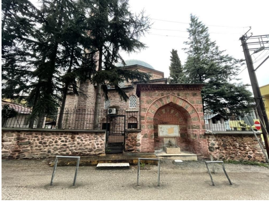
Görsel 45: Hafsa Hatun (Bedreddin) Cami Ön Cepheden Görünümü
