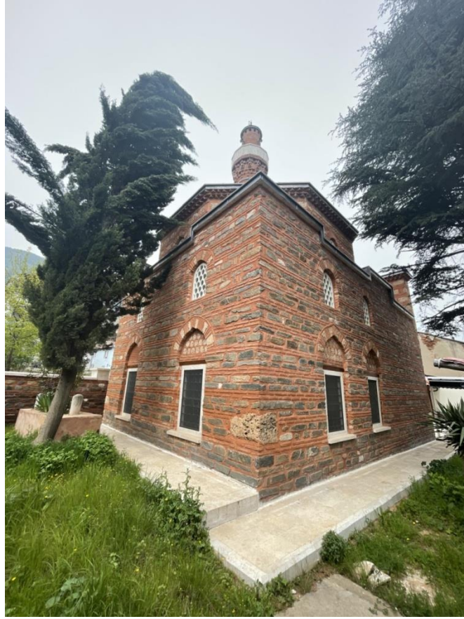
Görsel 54: Koca Naib Cami Arka Cepheden Görünümü
