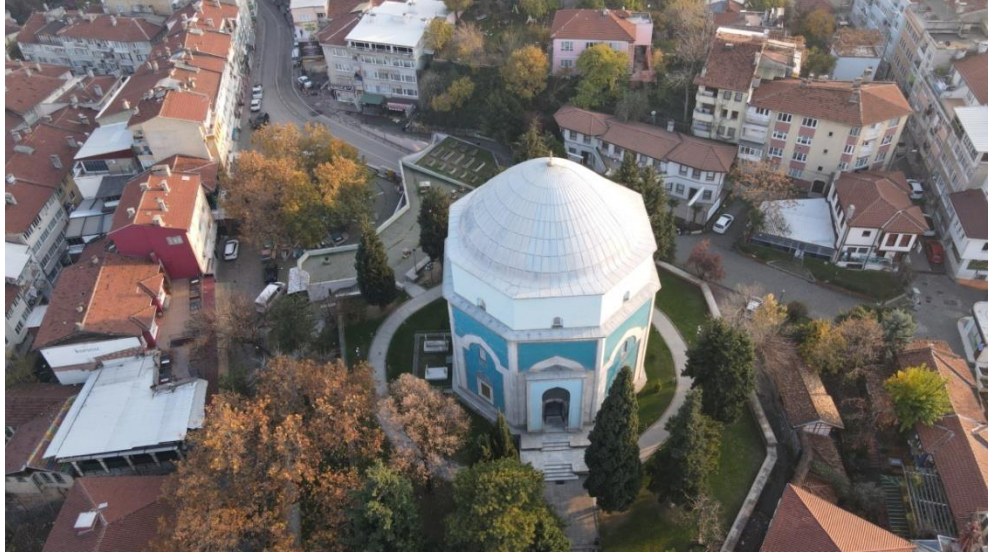
Görsel 26: Çelebi Mehmed Türbesi (Yeşil Türbe) Havadan Görünümü
