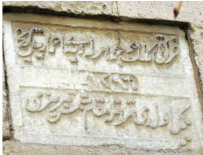
Görsel 35: Niğde Kesikbaş Türbesi'nin Kuzey Cephesi Üzerindeki Onarım Kitabesi ( https://nigde.ktb.gov.tr/ E.T. 01.04.2021)
