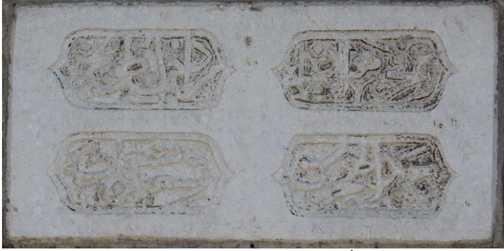
Görsel 189: Kayseri Oduncu Çeşmesi'nin İnşa Kitabesi
