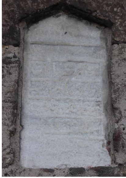
Görsel 192: Kayseri Kabasakal Müftü Çeşmesi'nin Onarım Kitabesi
