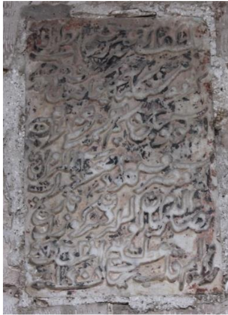
Görsel 205: Hacı Kasım Çeşmesi'nin İnşa Kitabesi
