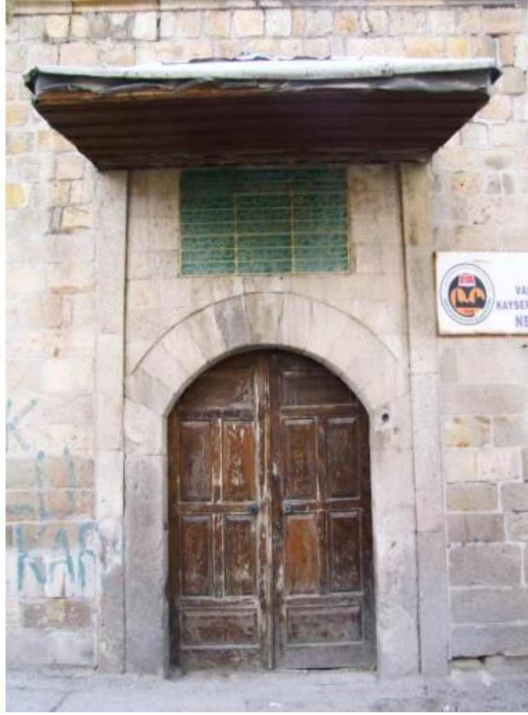
Görsel 173: Nevşehir Damad Bîrahim Paşa İmaretî, Doğu Giriş Kapısı (Allak, 2017)
