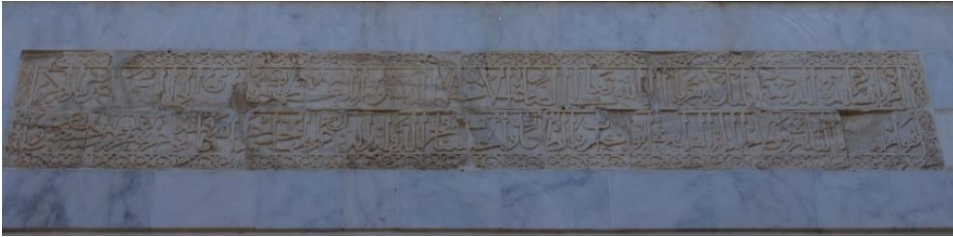
Görsel 46: Sivas Gök Medresesi, Ana Eyvanın Üzerinde Yer Alan İnşa Kitabesi
