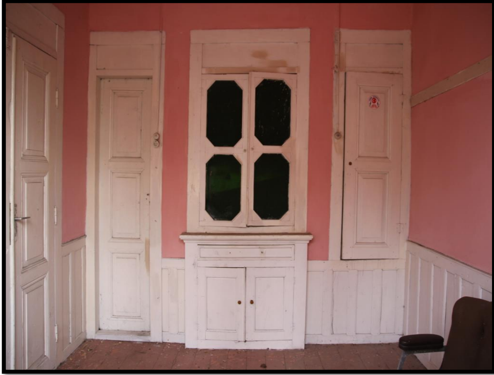
Görsel 147. Tescilli Ev 1, Birinci Kat Oda Görünüşü (Trabzon Rölöve ve Anıtlar Müdürlüğü Sokak Sağlıklaştırma Projesinden)
