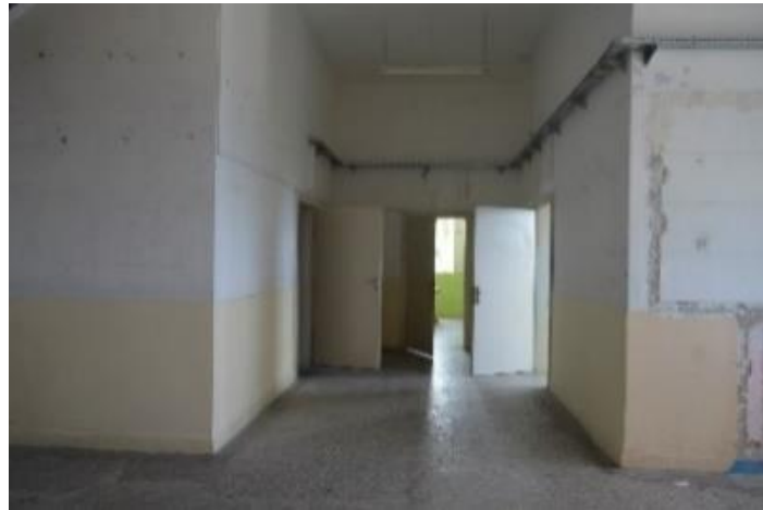
Görsel 71. Tirebolu Lisesi Birinci Katta Ana Mekanın Doğu Kolu
