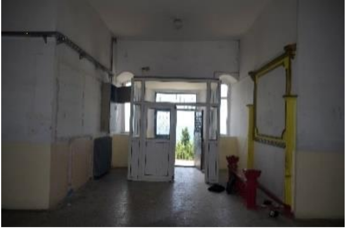
Görsel 68. Tirebolu Lisesi Birinci Kata Giriş ve Ana Mekanın Kuzey Kolu
