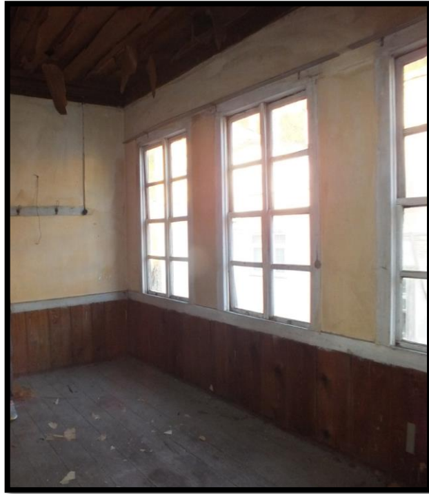
Görsel 206. Tescilli Ev 4,, İkinci Kat Oda Görünüşü (Trabzon Rölöve ve Anıtlar Müdürlüğü Sokak Sağlıklaştırma Projesinden)
