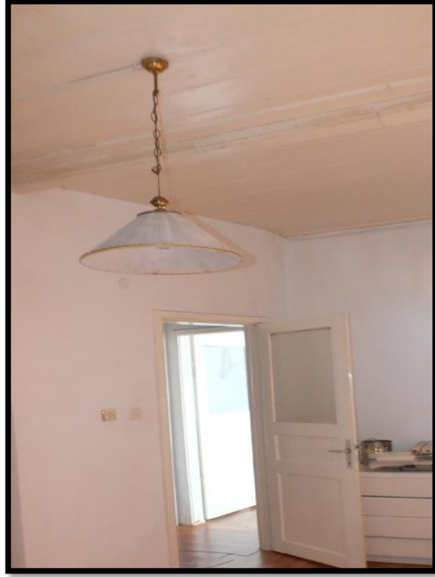
Görsel 389. Tescilli Ev 12, Birinci Kat İç Sofanın Açıldığı Odalar (Trabzon Rölöve ve Anıtlar Müdürlüğü Sokak Sağlıklaştırma Projesinden)
