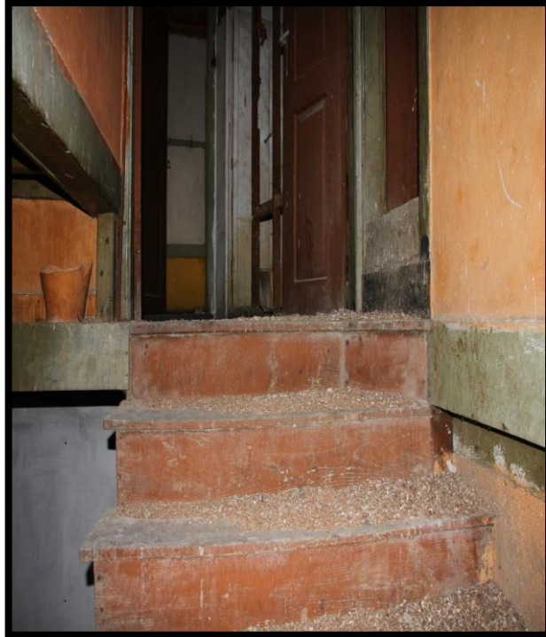
Görsel 186. Tescilli Ev 3, İkinci Kattan Bir Görünüş (Trabzon Rölöve ve Anıtlar Müdürlüğü Sokak Sağlıklaştırma Projesinden)
