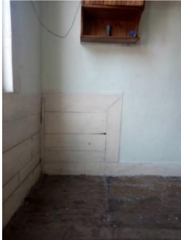
Görsel 168. Tescilli Ev 2, Pencere Altlarında Ve Alt Seviyede Devam Eden Ahşap Şeritler (Trabzon Rölöve ve Anıtlar Müdürlüğü Sokak Sağıklaştırma Projesinden)
