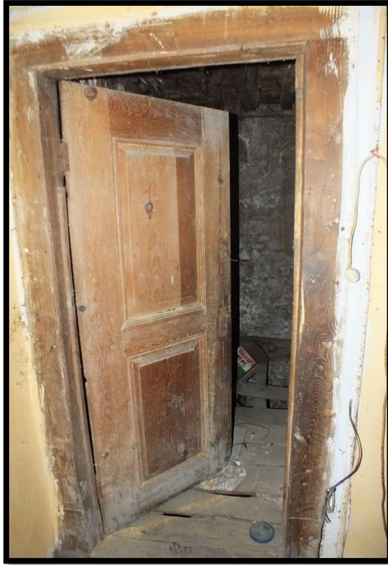
Görsel 192. Tescilli Ev 4, Zemin Kat Görünüşü (Trabzon Rölöve ve Anıtlar Müdürlüğü Sokak Sağlıklaştırma Projesinden)
