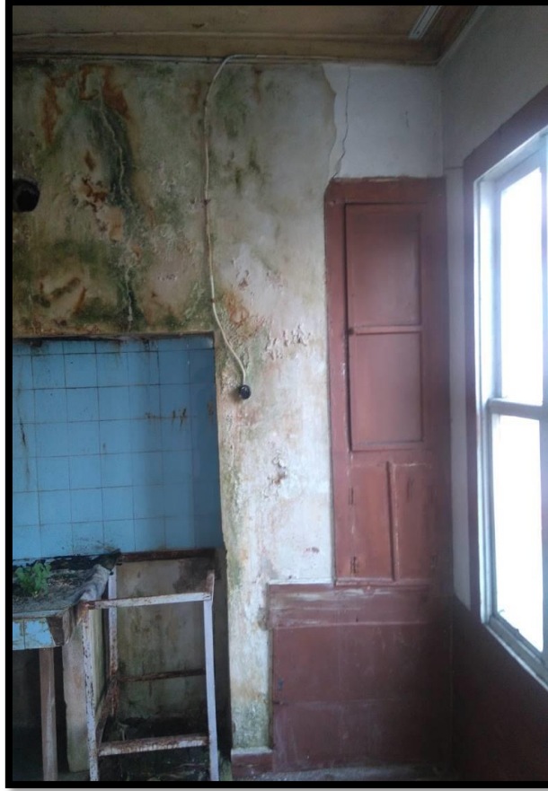
Görsel 361. Tescilli Ev 11, Birinci Kat Mutfak Görünüşü (Trabzon Rölöve ve Anıtlar Müdürlüğü Sokak Sağlıklaştırma Projesinden)
