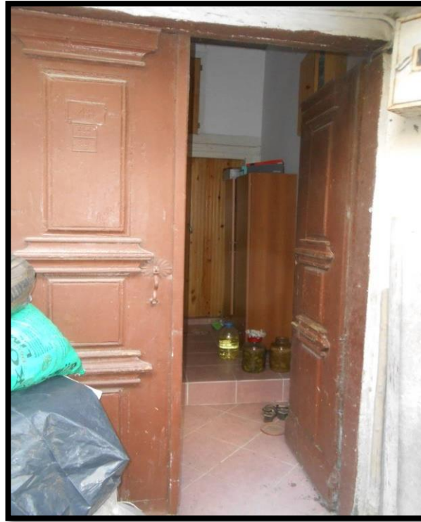
Görsel 266. Tescilli Ev 7, Zemin Kat Görünüşü (Trabzon Rölöve ve Anıtlar Müdürlüğü Sokak Sağlıklaştırma Projesinden)
