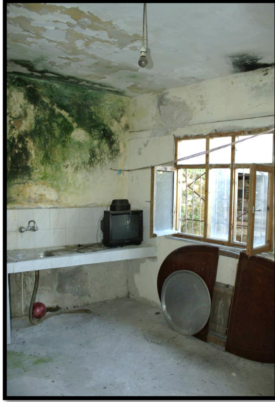
Görsel 215. Tescilli Ev 5, Bodrum Katından Görünüş (Trabzon Rölöve ve Anıtlar Müdürlüğü Sokak Sağlıklaştırma Projesinden)
