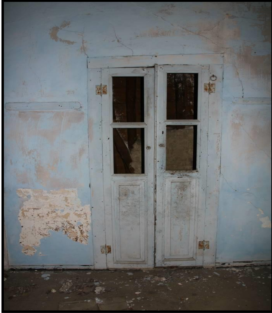
Görsel 180. Tescilli Ev 3, Birinci Kattaki Odadan Görünüş (Trabzon Rölöve ve Anıtlar Müdürlüğü Sokak Sağlıklaştırma Projesinden)
