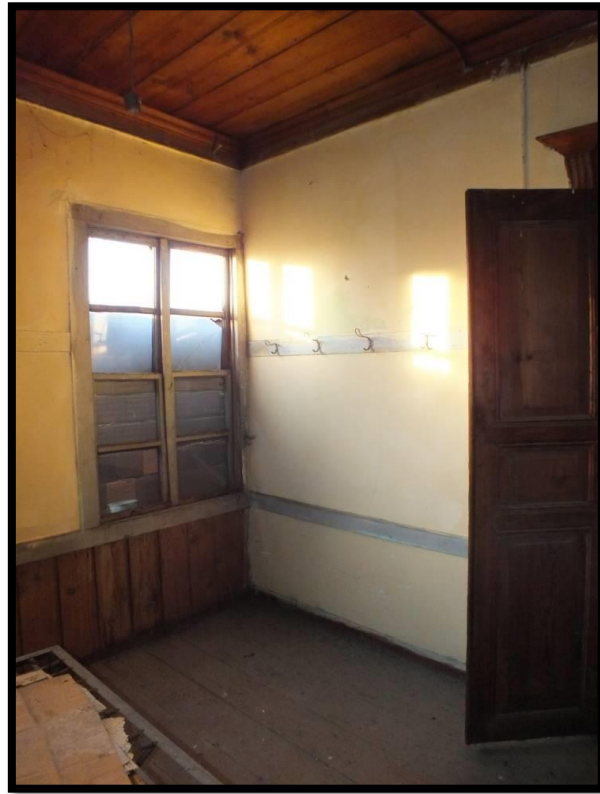
Görsel 202. Tescilli Ev 4, İkinci Kat Oda Görünüşü (Trabzon Rölöve ve Anıtlar Müdürlüğü Sokak Sağlıklaştırma Projesinden)
