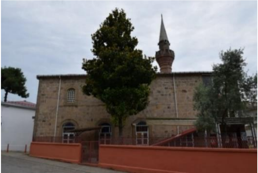
Görsel 83. Yeniköy Camii Genel Görünüm
