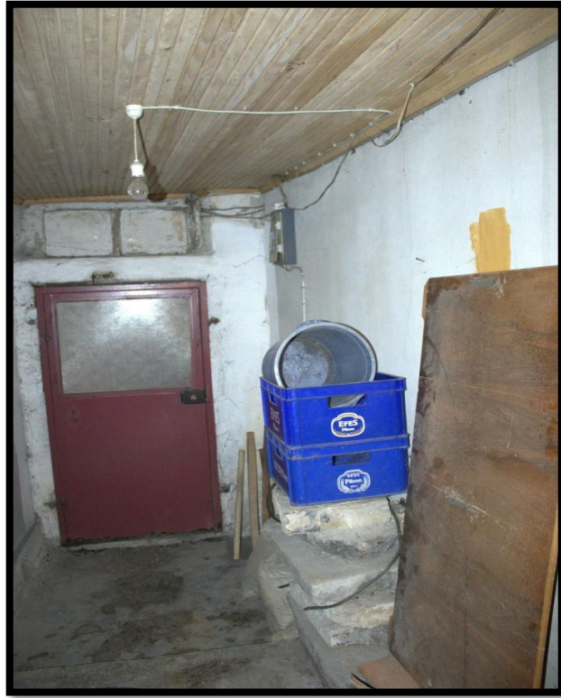
Görsel 214. Tescilli Ev 5, Bodrum Katından Görünüş (Trabzon Rölöve ve Anıtlar Müdürlüğü Sokak Sağlıklaştırma Projesinden)
