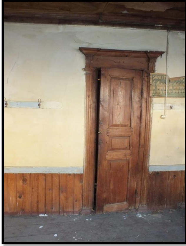
Görsel 205. Tescilli Ev 4, İkinci Kat Oda Görünüşü (Trabzon Rölöve ve Anıtlar Müdürlüğü Sokak Sağlıklaştırma Projesinden)
