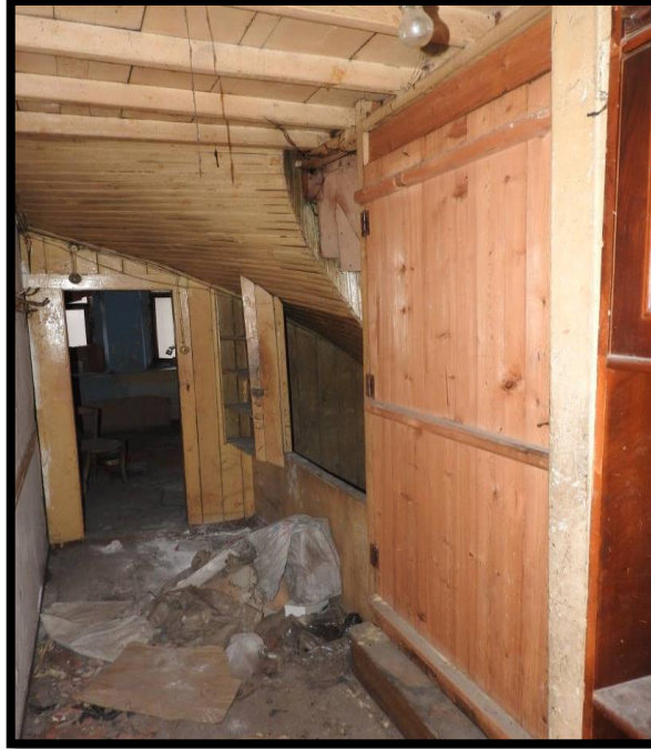
Görsel 240. Tescilli Ev 6, Zemin Kat Odadan Görünüş (Trabzon Rölöve ve Anıtlar Müdürlüğü Sokak Sağlıklaştırma Projesinden)
