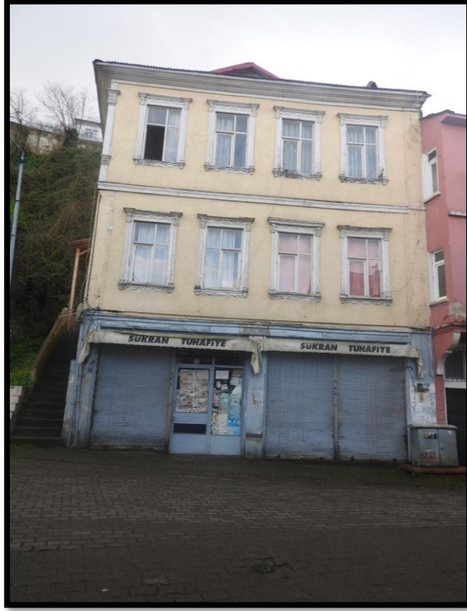
Görsel 315. Tescilli Ev 9, Güney Cephesi Görünüşü (Trabzon Rölöve ve Anıtlar Müdürlüğü Sokak Sağıklaştırma Projesinden)
