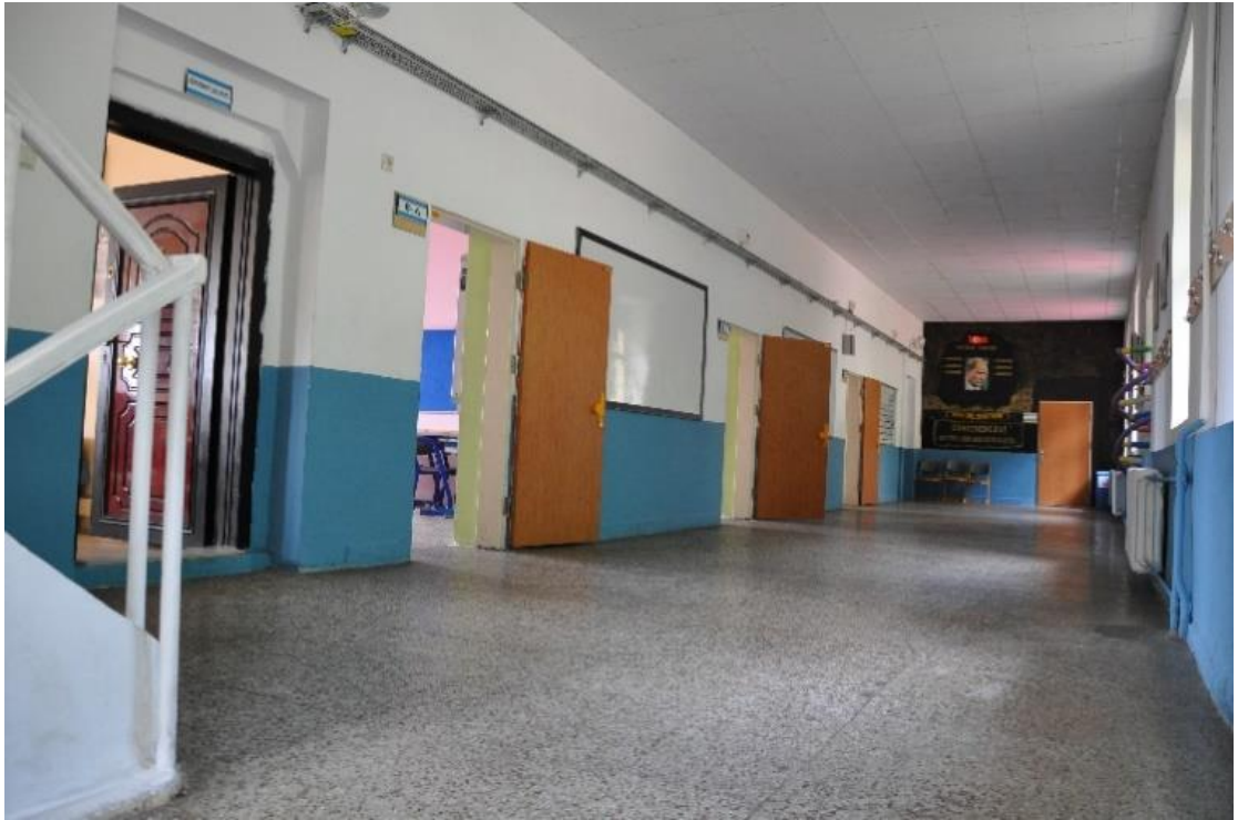
Görsel 57. Kazım Karabekir Ortaokulu Birinci Kattaki Dış Sofadan Görünüş
