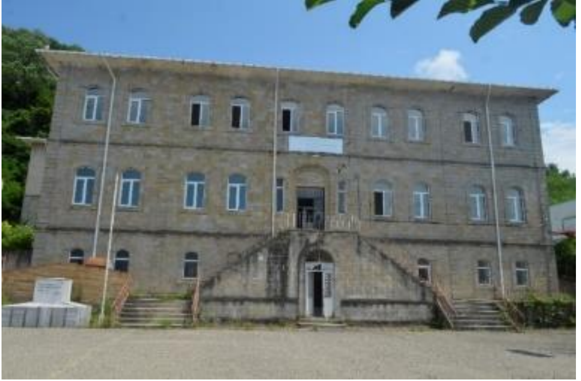
Görsel 60. Tirebolu Lisesi Kuzey Cephe Genel Görünüşü
