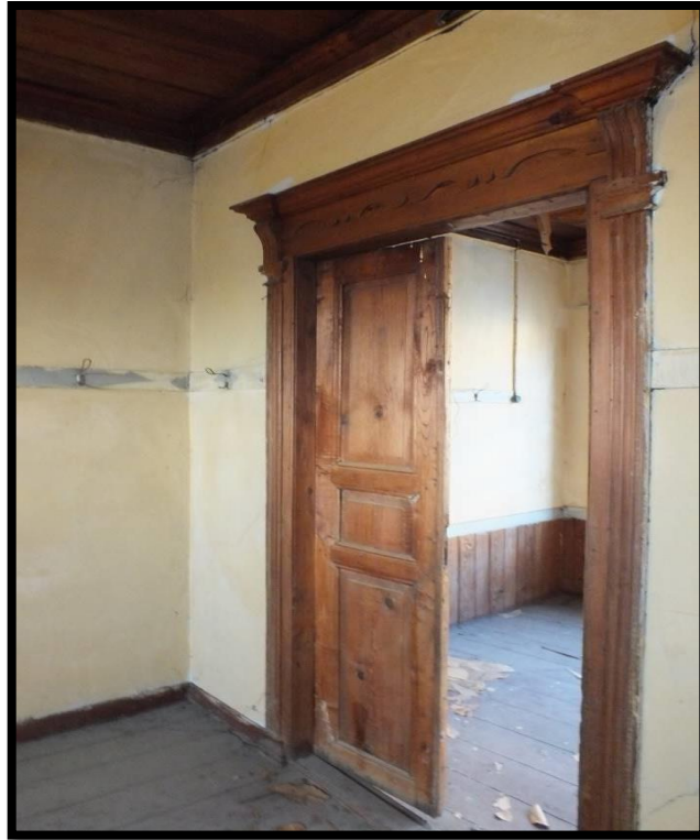
Görsel 204. Tescilli Ev 4, İkinci Kat Oda Görünüşü (Trabzon Rölöve ve Anıtlar Müdürlüğü Sokak Sağlıklaştırma Projesinden)
