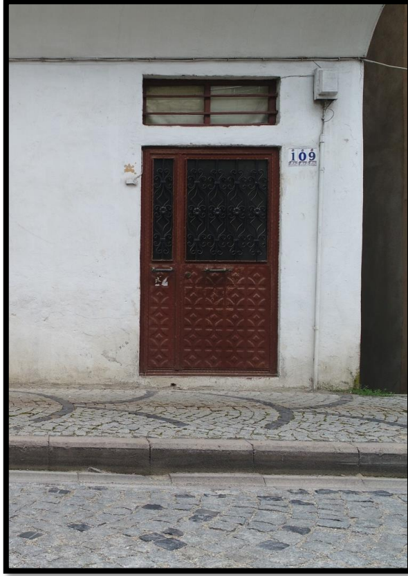
Görsel 381. Tescilli Ev 12, Zemin Kat Görünüşü (Trabzon Rölöve ve Anıtlar Müdürlüğü Sokak Sağlıklaştırma Projesinden)
