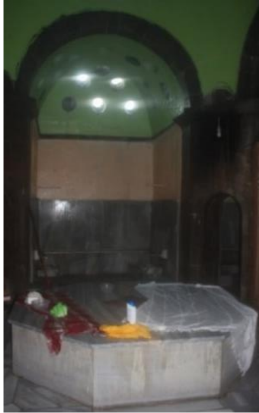
Görsel 39. Tirebolu Hamamı Sıcaklık Bölümü Yıkama Yerleri, Göbek Taşı ve Eyvan
