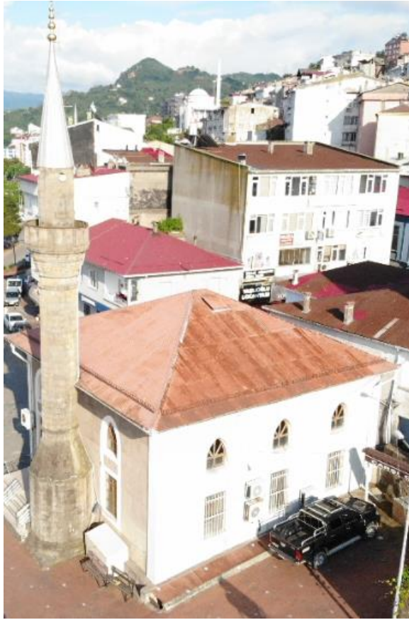
Görsel 119. Çarşı Cami Doğu Cephe Görünüşü
