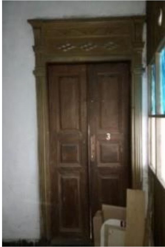
Görsel 164. Tescilli Ev 2, Birinci Kat Ahşap Kapı Tipleri (Trabzon Rölöve ve Anıtlar Müdürlüğü Sokak Sağlıklaştırma Projesinden)
