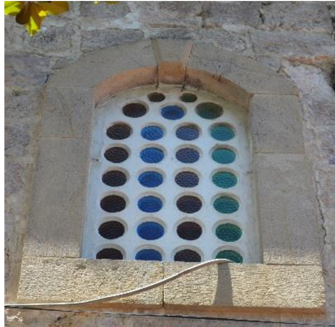
Görsel 95. Yeniköy Cami Batı Cephe Üst Seviye Pencere Düzeni Detay
