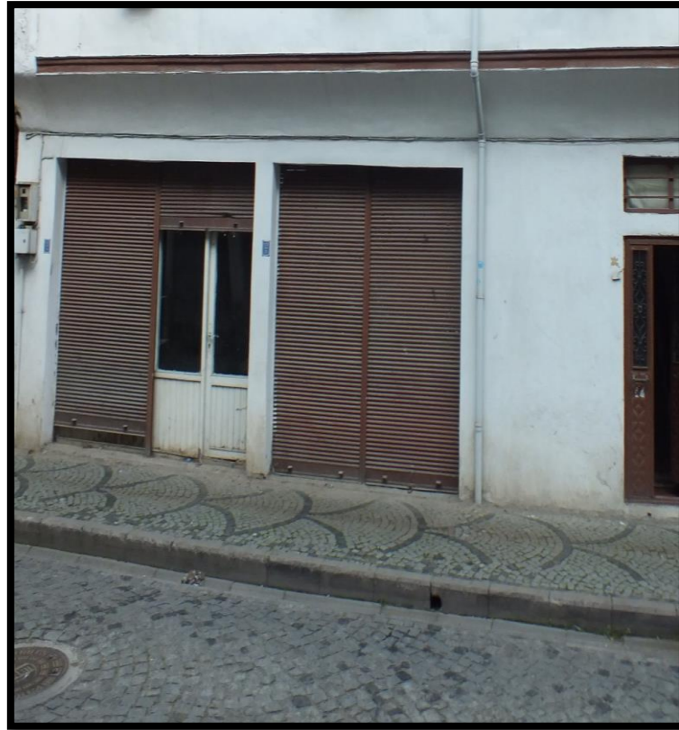
Görsel 378. Tescilli Ev 12, Zemin Kat Dükkân Görünüşü (Trabzon Rölöve ve Anıtlar Müdürlüğü Sokak Sağlıklaştırma Projesinden)
