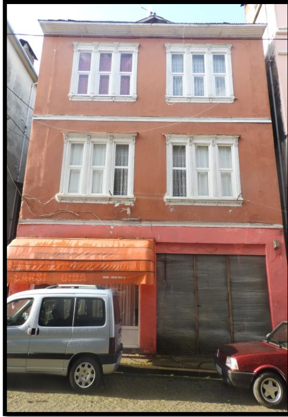
Görsel 402. Tescilli Ev 13, Güney Cephesi Görünüşü (Trabzon Rölöve ve Anıtlar Müdürlüğü Sokak Sağlıklaştırma Projesinden)
