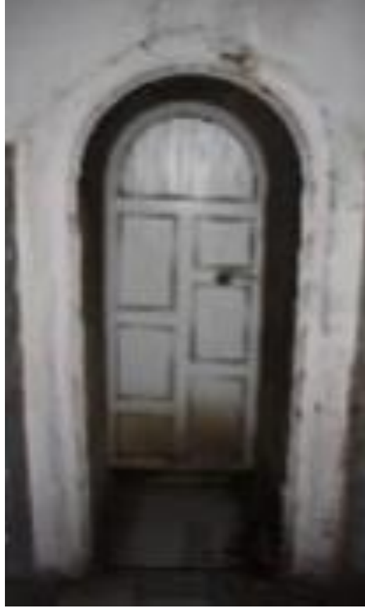
Görsel 38. Tirebolu Hamamı Sıcaklık Bölümü Giriş Kapısı
