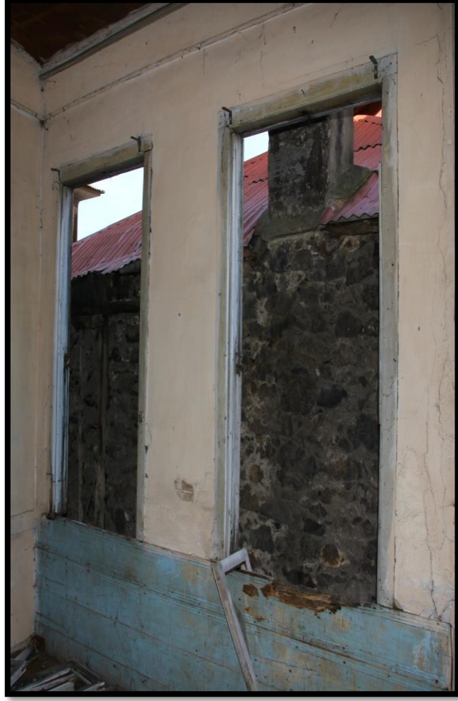
Görsel 183. Tescilli Ev 3, Birinci Kat Mutfaktan Bir Görünüş (Trabzon Rölöve ve Anıtlar Müdürlüğü Sokak Sağlıklaştırma Projesinden)
