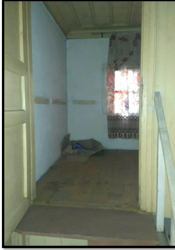
Görsel 367. Tescilli Ev 11, İkinci Kat Oda Görünüşü (Trabzon Rölöve ve Anıtlar Müdürlüğü Sokak Sağlıklaştırma Projesinden)
