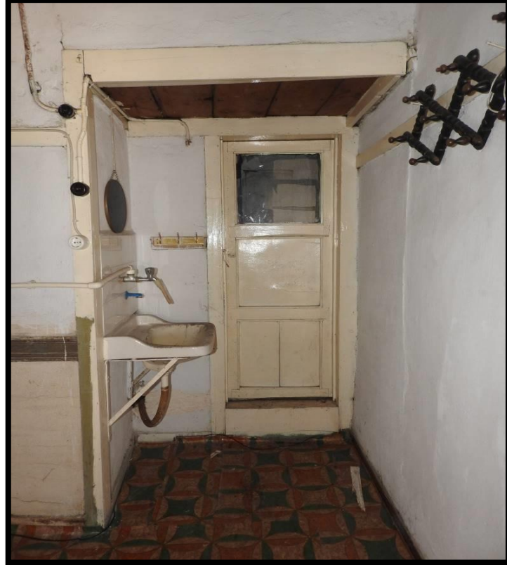
Görsel 306. Tescilli Ev 8, İkinci Kat Tuvalete Kapısı (Trabzon Rölöve ve Anıtlar Müdürlüğü Sokak Sağlıklaştırma Projesinden)
