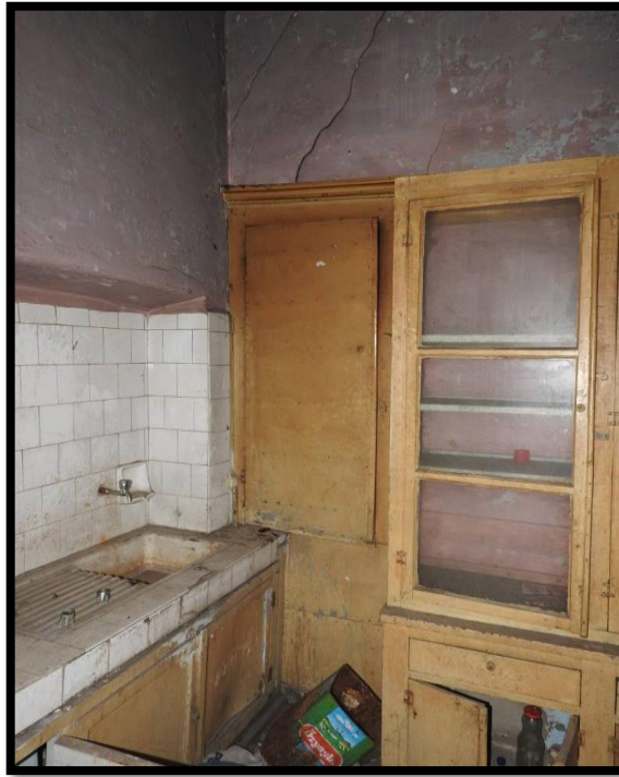
Görsel 242. Tescilli Ev 6, Zemin Kat Görünüşü (Trabzon Rölöve ve Anıtlar Müdürlüğü Sokak Sağlıklaştırma Projesinden)
