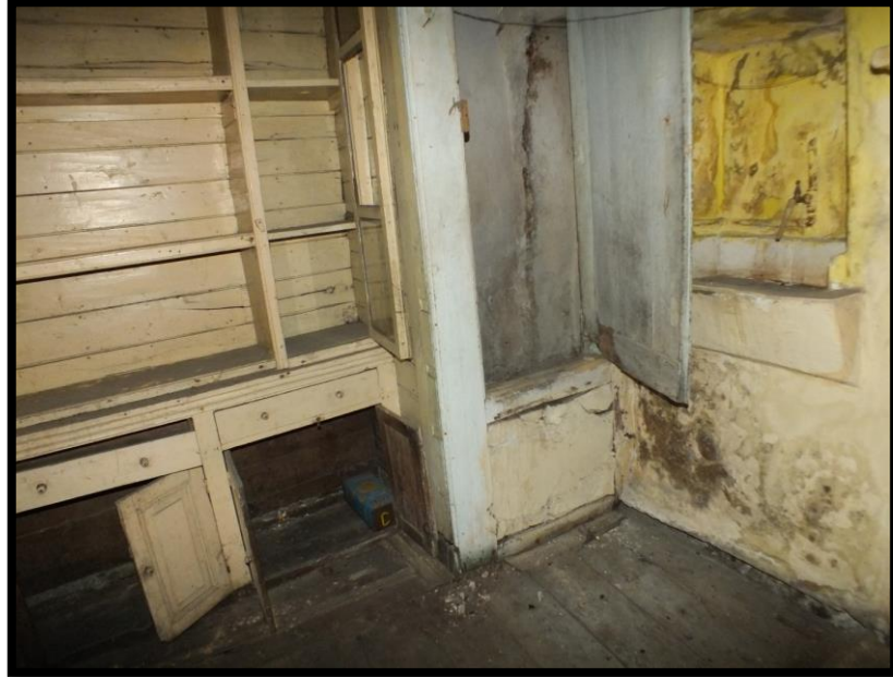
Görsel 196. Tescilli Ev 4, Birinci Kat Oda Görünüşü (Trabzon Rölöve ve Anıtlar Müdürlüğü Sokak Sağlıklaştırma Projesinden)
