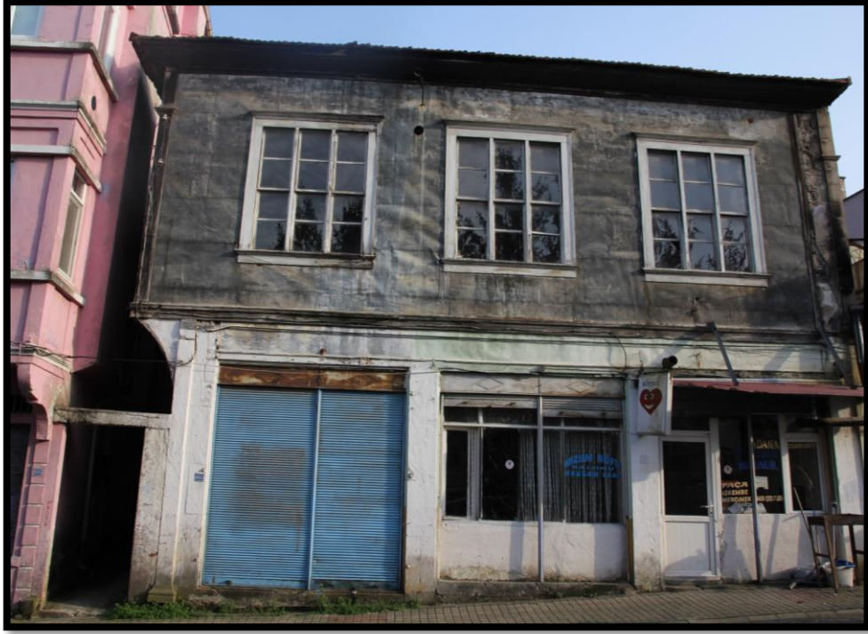
Görsel 133. Tescilli Ev 1, Kuzey Cephe Görünüşü (Trabzon Rölöve ve Anıtlar Müdürlüğü Sokak Sağlıklaştırma Projesinden)
