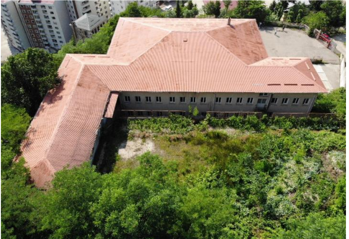
Görsel 61. Tirebolu Lisesi Bugünkü Güney Cephe Genel Görünüş
