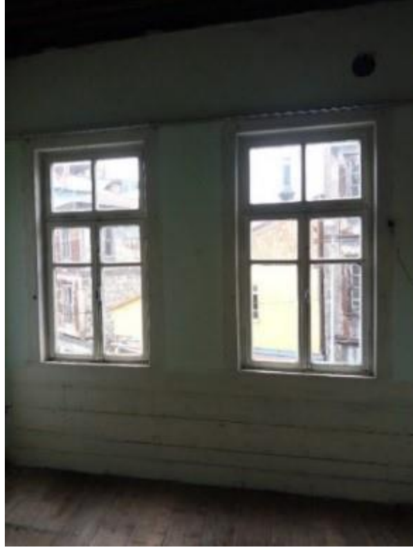
Görsel 167. Tescilli Ev 2, Pencere Altlarında Ve Alt Seviyede Devam Eden Ahşap Şeritler (Trabzon Rölöve ve Anıtlar Müdürlüğü Sokak Sağıklaştırma Projesinden)
