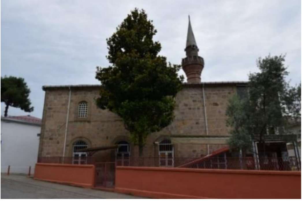
Görsel 92. Yeniköy Cami Batı Cephe Genel Görünüm
