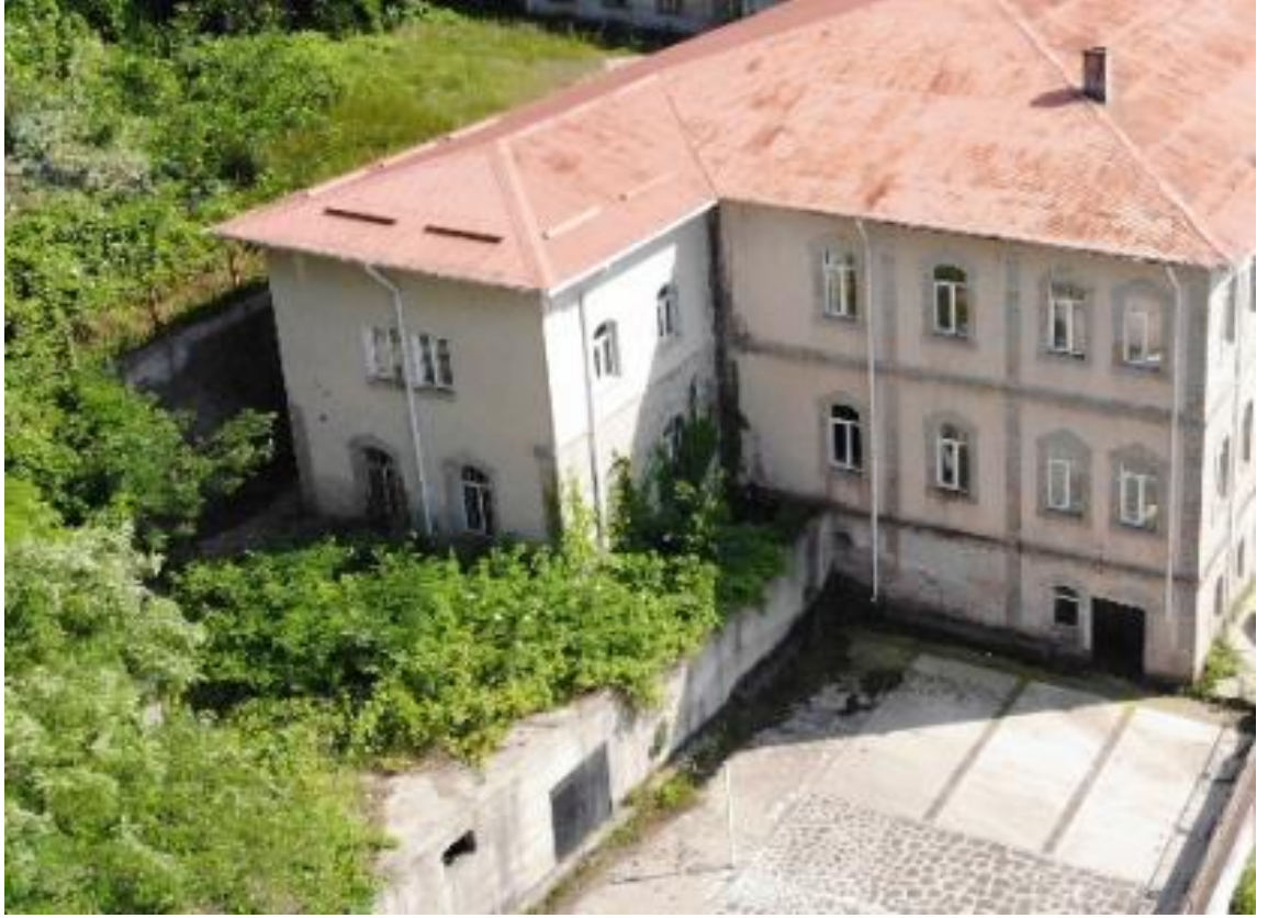
Görsel 64. Tirebolu Lisesi Doğu Cephe Genel Görünüş
