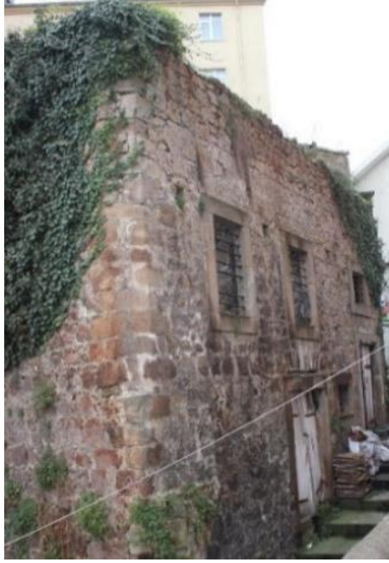
Görsel 42. Tirebolu Hamamı Müştemilatına Geçiş Sağlayan Kapı
