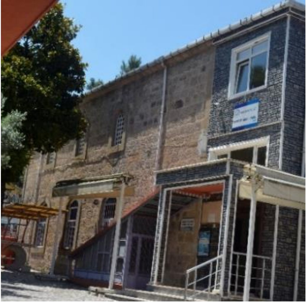
Görsel 93. Yeniköy Cami Batı Cephe Genel Görünüm
