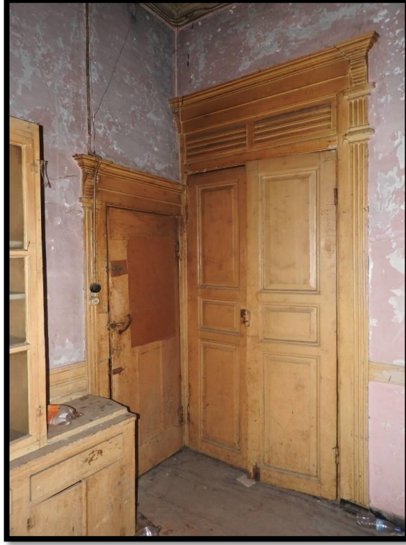
Görsel 243. Tescilli Ev 6, Zemin Kat Görünüşü (Trabzon Rölöve ve Anıtlar Müdürlüğü Sokak Sağlıklaştırma Projesinden)
