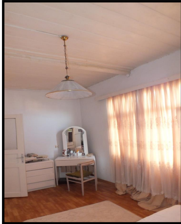
Görsel 390. Tescilli Ev 12, Birinci Kat İç Sofanın Açıldığı Odalar (Trabzon Rölöve ve Anıtlar Müdürlüğü Sokak Sağlıklaştırma Projesinden)
