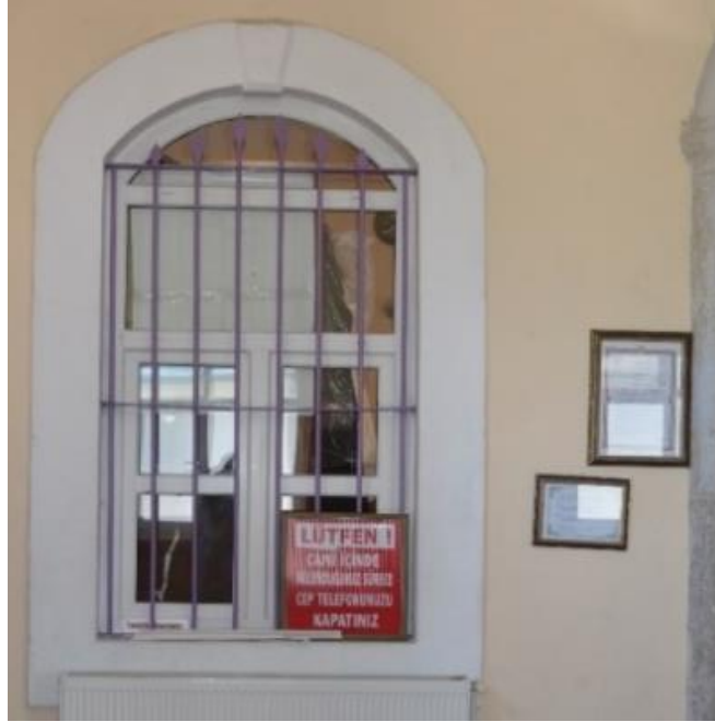
Görsel 87. Yeniköy Cami Kuzey Cephe Ana Giriş Kapısı
