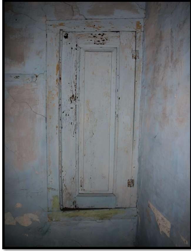
Görsel 181. Tescilli Ev 3, Birinci Kattaki Odadan Görünüş (Trabzon Rölöve ve Anıtlar Müdürlüğü Sokak Sağlıklaştırma Projesinden)
