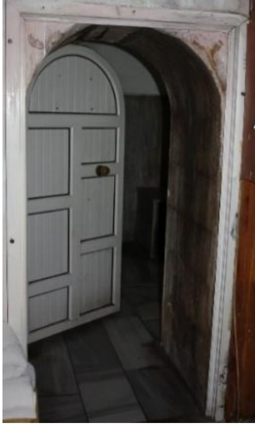
Görsel 34. Tirebolu Hamamı Soğukluk Bölümüne Geçiş Sağlayan Kapı
