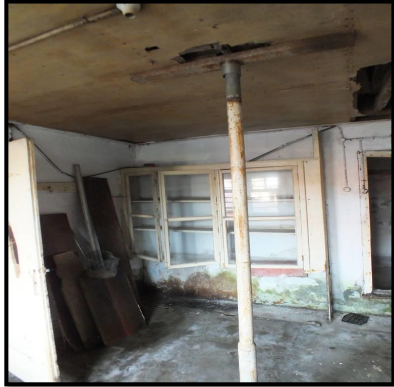
Görsel 434. Tescilli Ev 14, Zemin Kat Giriş Görünüşü (Trabzon Rölöve ve Anıtlar Müdürlüğü Sokak Sağlıklaştırma Projesinden)
