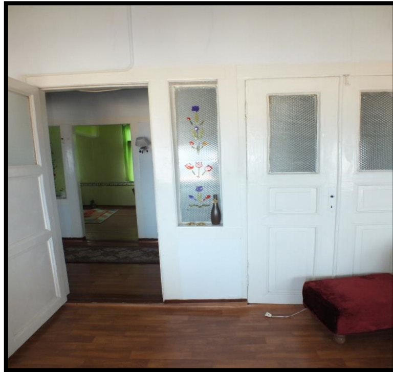
Görsel 394. Tescilli Ev 12, Birinci Kattaki Odadan Görünüşü (Trabzon Rölöve ve Anıtlar Müdürlüğü Sokak Sağlıklaştırma Projesinden)
