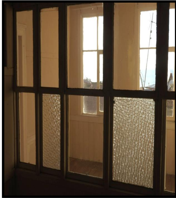
Görsel 292. Tescilli Ev 8, Birinci Kat Odadan Görünüş (Trabzon Rölöve ve Anıtlar Müdürlüğü Sokak Sağlıklaştırma Projesinden)
