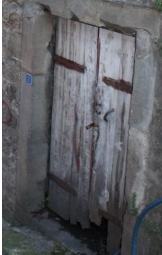
Görsel 45. Tirebolu Hamamı Külhanın Ateşlik Kısımına Geçiş Sağlayan Kapı
