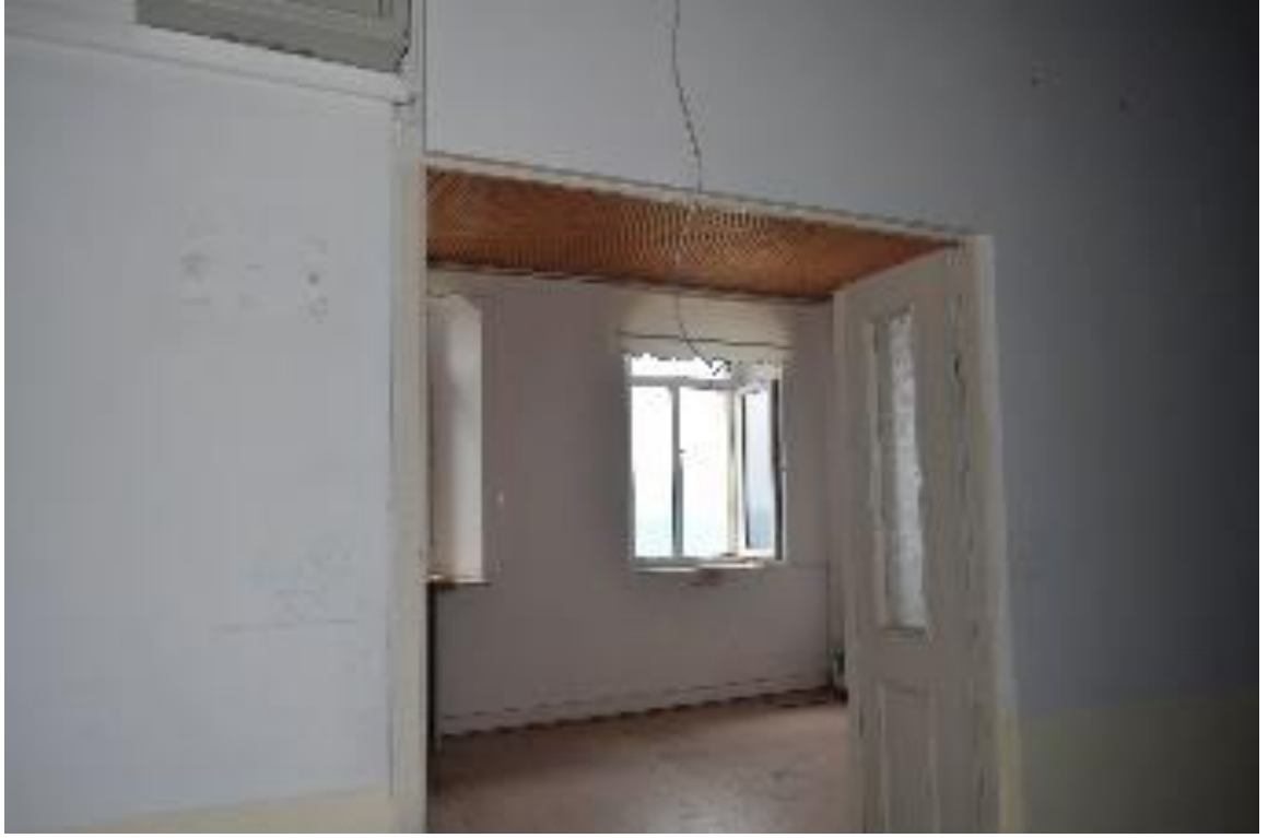
Görsel 74. Tirebolu Lisesi İkinci Katta Kuzey Kolda Sonradan Eklendiği Düşünülen Mekan
