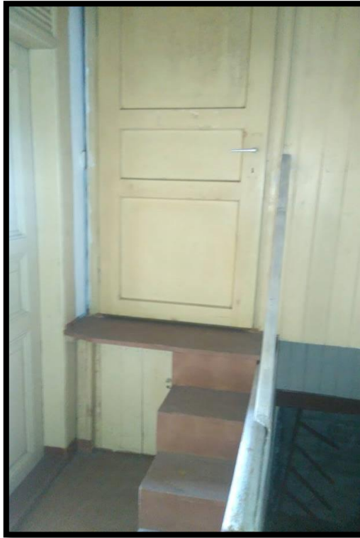
Görsel 366. Tescilli Ev 11, İkinci Kat Oda Görünüşü (Trabzon Rölöve ve Anıtlar Müdürlüğü Sokak Sağlıklaştırma Projesinden)
