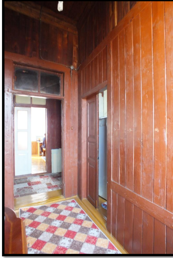
Görsel 223. Tescilli Ev 5, Birinci Kattan Görünüş (Trabzon Rölöve ve Anıtlar Müdürlüğü Sokak Sağlıklaştırma Projesinden)
