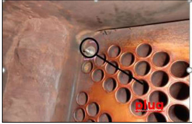
Şekil 4.5 Kondenser Su Haznesi'nde düşen plug
