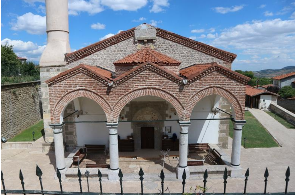
Görsel 19. Batı Cephe
