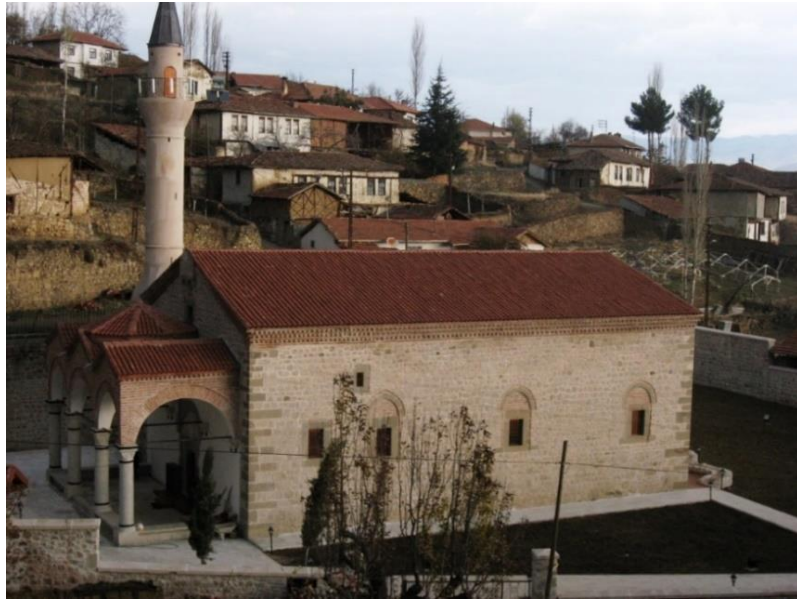
Görüş 59. Güney Cephe, Restorasyon Sonrası (Tokat VBM Arşivi)
