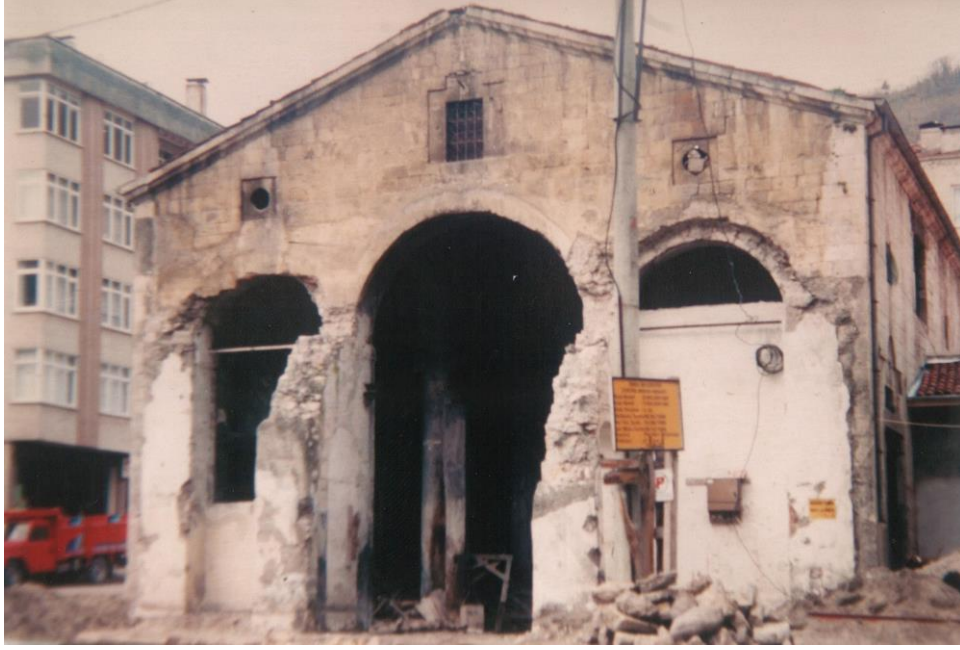
Görsel 82. Ordu Düz Mahalle Kilisesi, Restorasyon Öncesi Doğu Cephe
