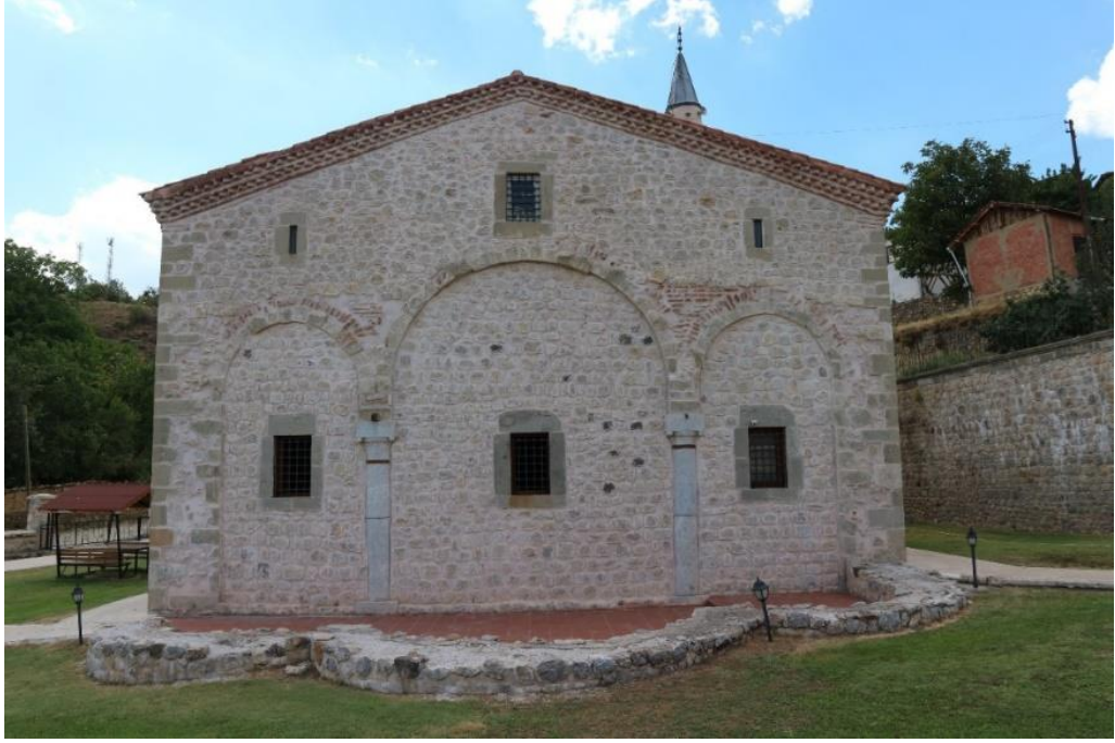
Görsel 65. Doğu Cephe, Restorasyon Sonrası
