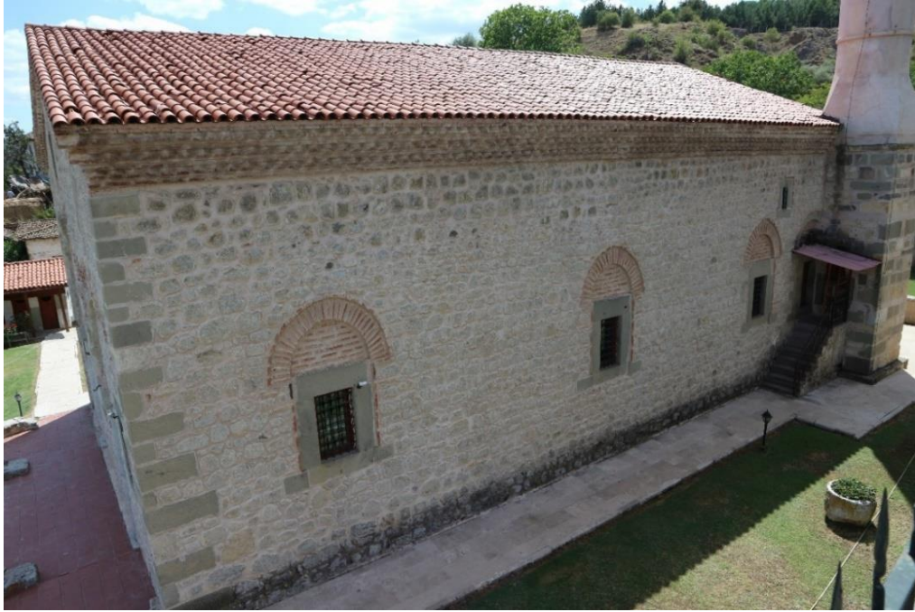
Görsel 21. Kuzey Cephe
