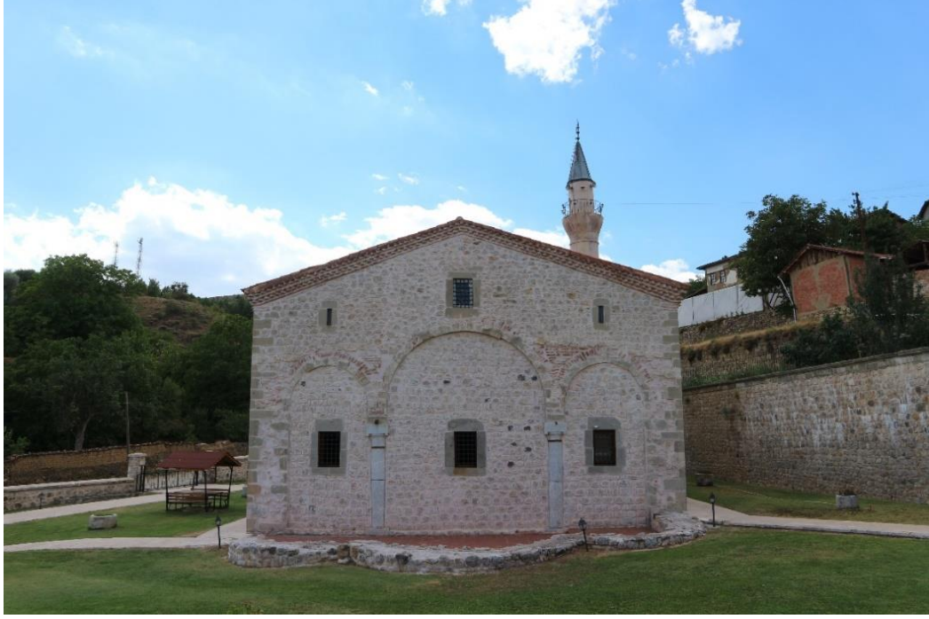
Görsel 22. Doğu Cephe ve Avlunun Genel Görünüşü
