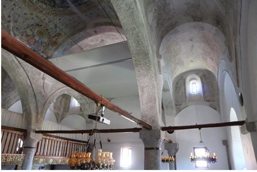
Görsel 10. Batıdan Doğuya Örtü Sistemine Bakış
