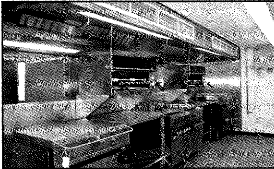
Şekil 10.108 Kuzine lokal CO 2 uygulama sistemi.
