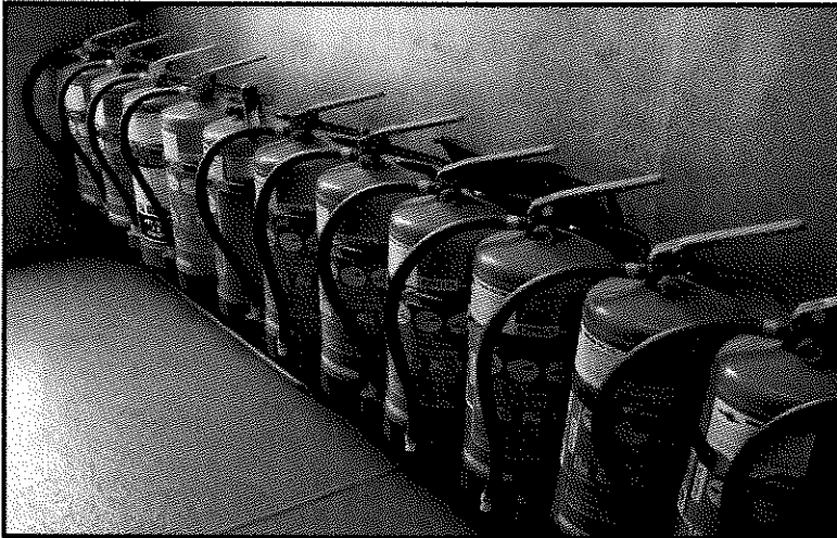
Şekil 10.61 Gemide bulunan taşınabilir söndürücülerin korozif etkilerden korunması.
