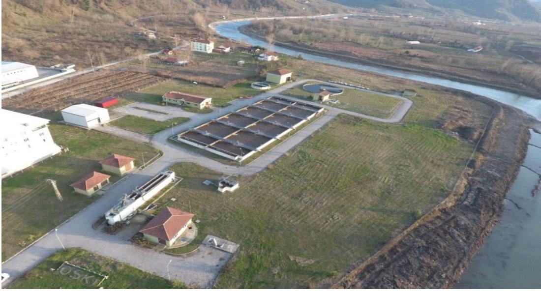
Şekil 1.19 Ordu İli Ünye İlçesi Batı Atıksu Arıtma Tesisi
