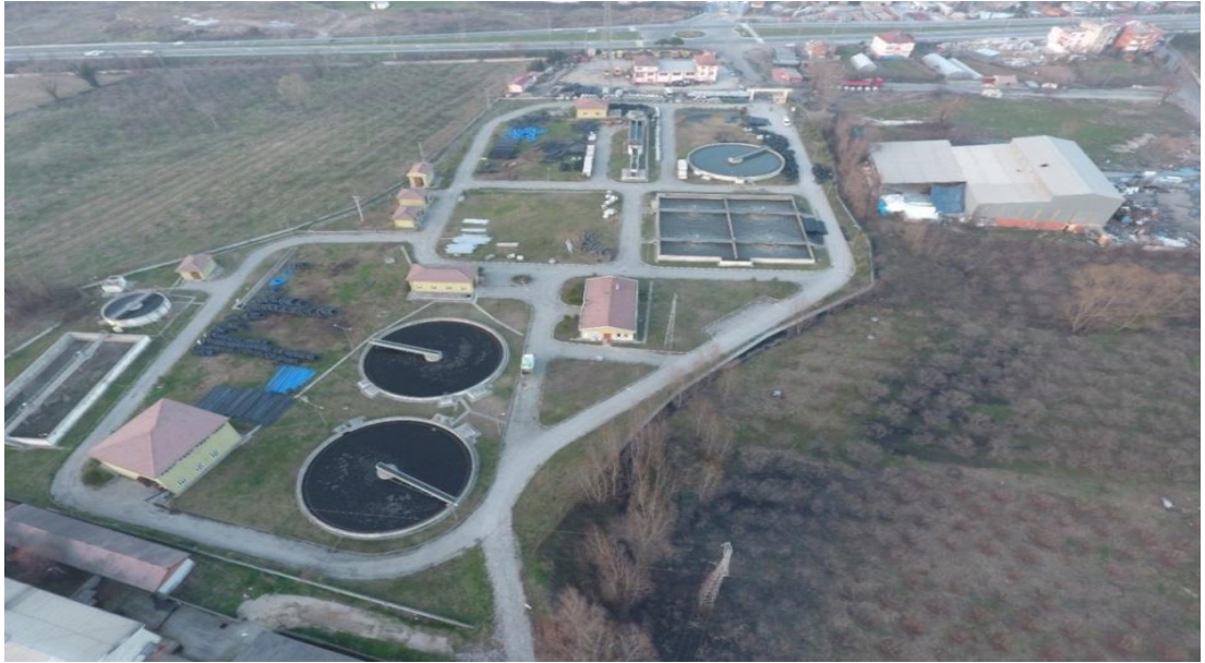
Şekil 1.18 Ordu İli Ünye İlçesi Doğu Atıksu Arıtma Tesisi
