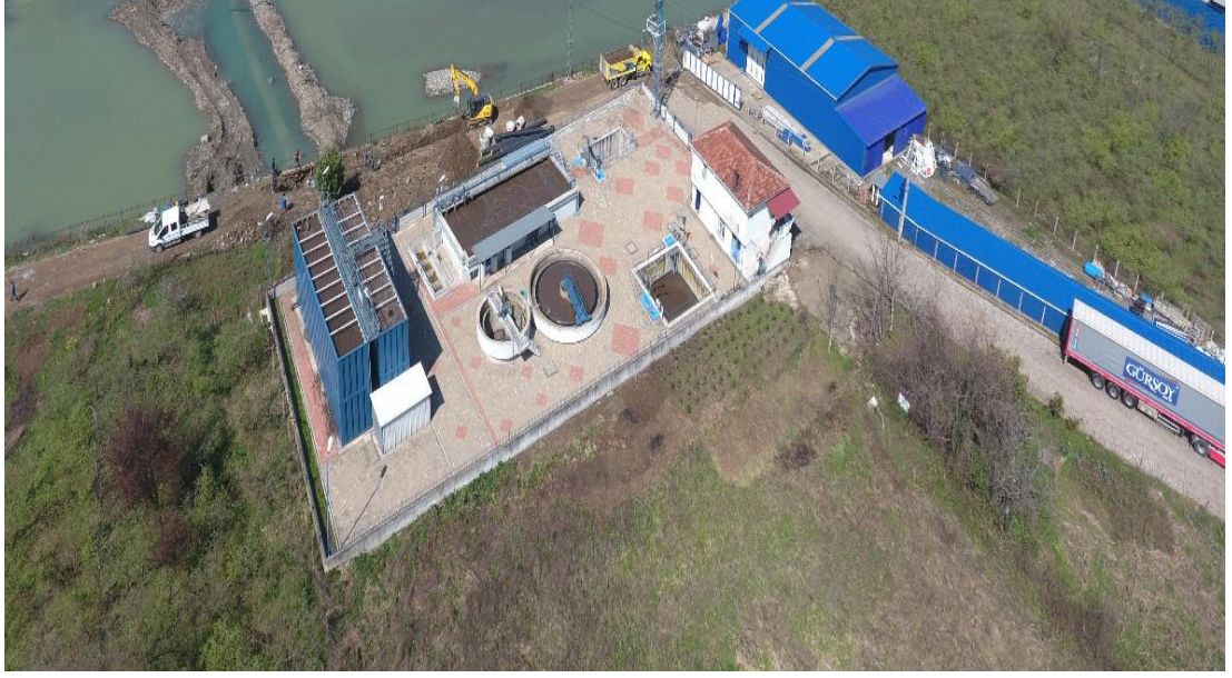
Şekil 1.10 Ordu İli Altınordu İlçesi – Kumbaşı Atıksu Arıtma Tesisi
