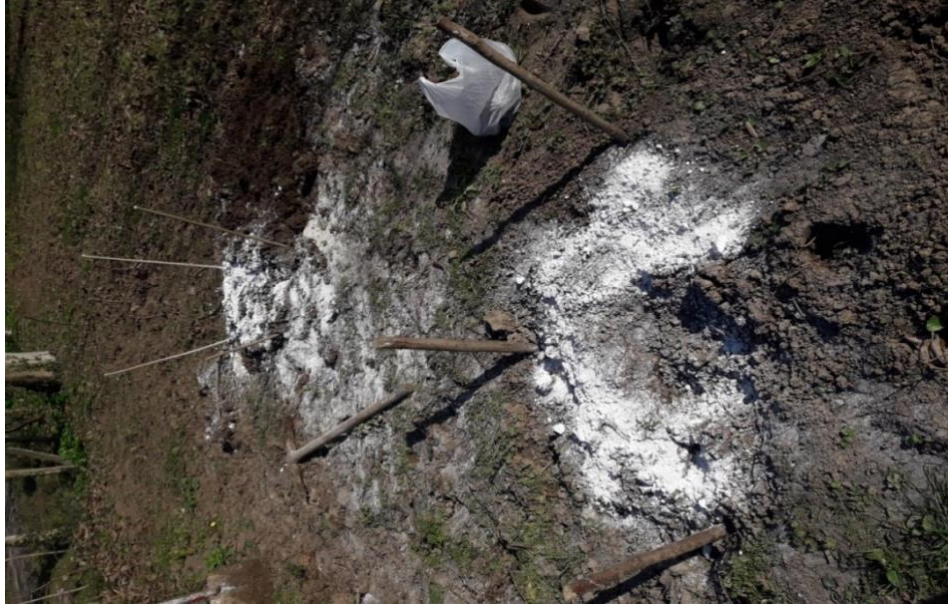
Şekil 3.5 Balık Atıklarıyla Doldurulan Çukurun Kapatılması
