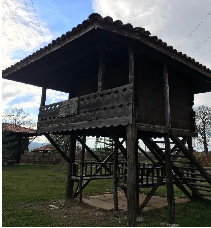
Görsel 21: Saray Mahallesi Tevfik Yapıcı Ambarı/Serenderi Detay Görünümü
