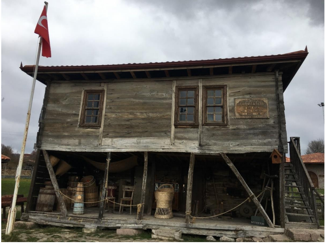
Görsel 7: Soğanlı Mahallesi Köy Mektebi Genel Görünümü
