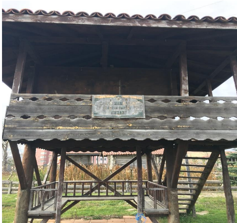
Görsel 20: Saray Mahallesi Tevfik Yapıcı Ambarı/Serenderi Detay Görünümü
