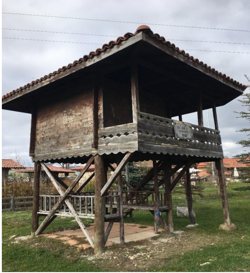
Görsel 19: Saray Mahallesi Tevfik Yapıcı Ambarı/Serenderi Genel Görünümü
