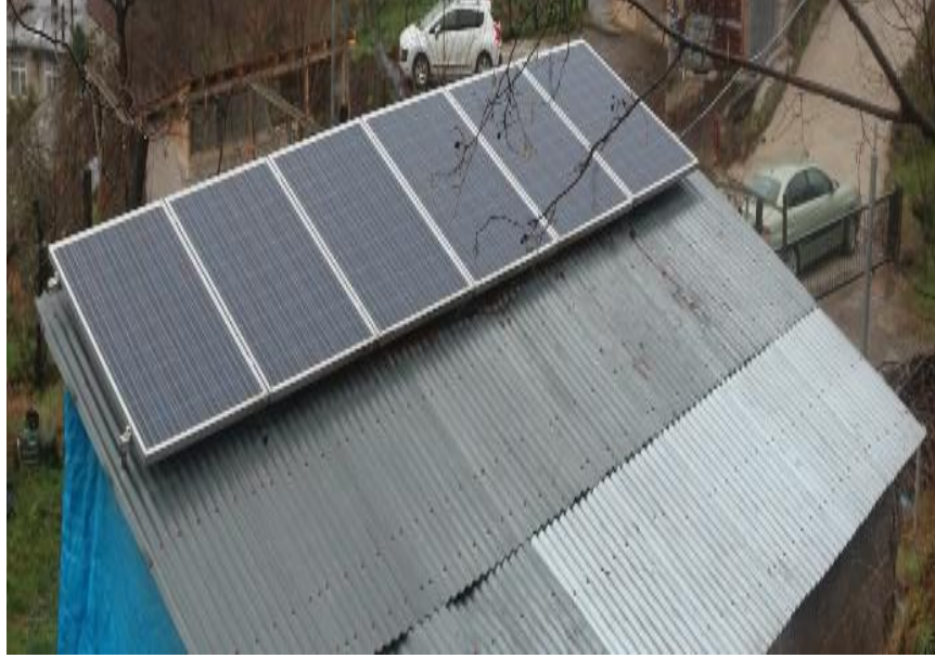
Şekil 3.3 Sulama amaçlı kurulan PV sistemin fotovoltaiik panelleri
