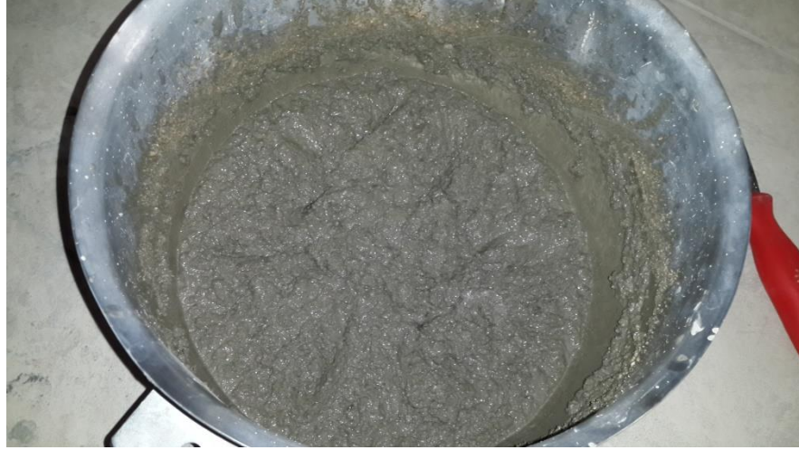
Şekil 3.15. Çimento mikserinde harcın üretimi
