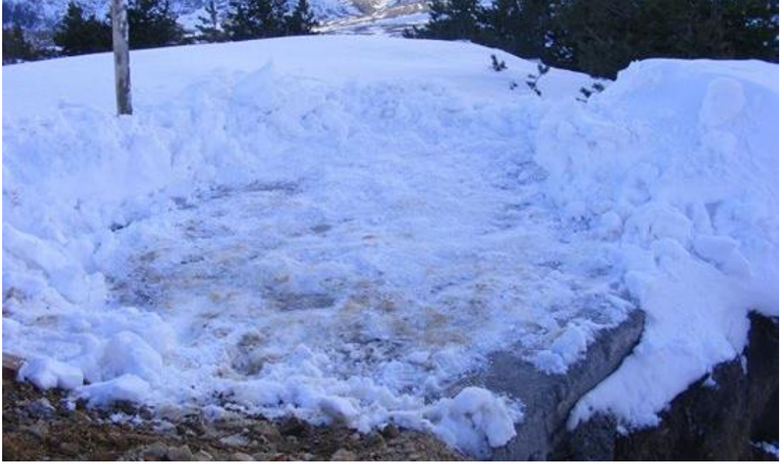
Şekil 3.34. PV panel ankraj ve betonlama işlemi
