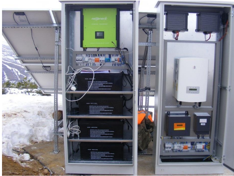
Şekil 3.41. Hibrit sistem diğer malzemeler ve gerekli bağlantılar
