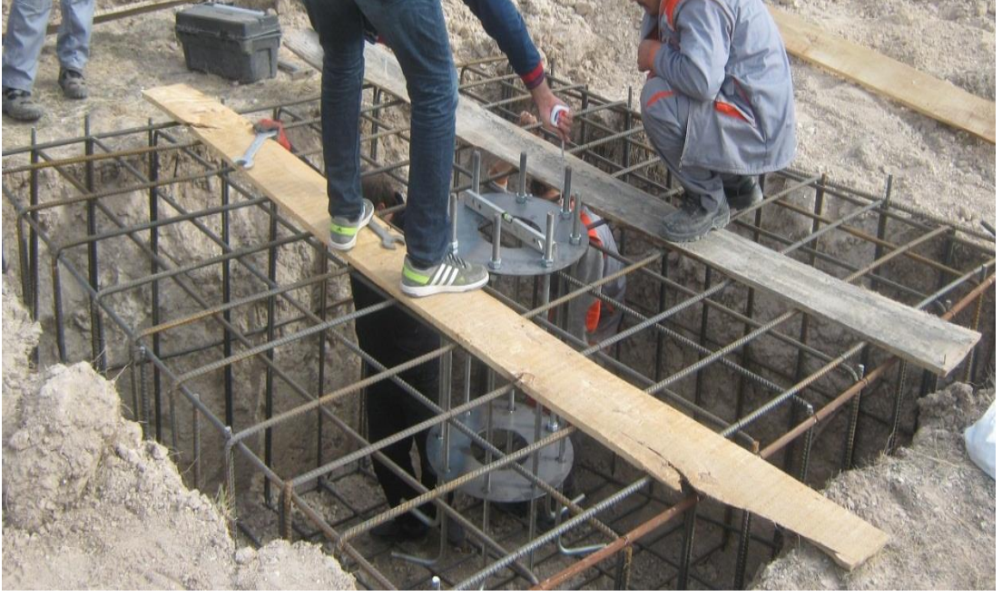
Şekil 3.37. Rüzgâr türbini direği flanşının demirlere bağlanması
