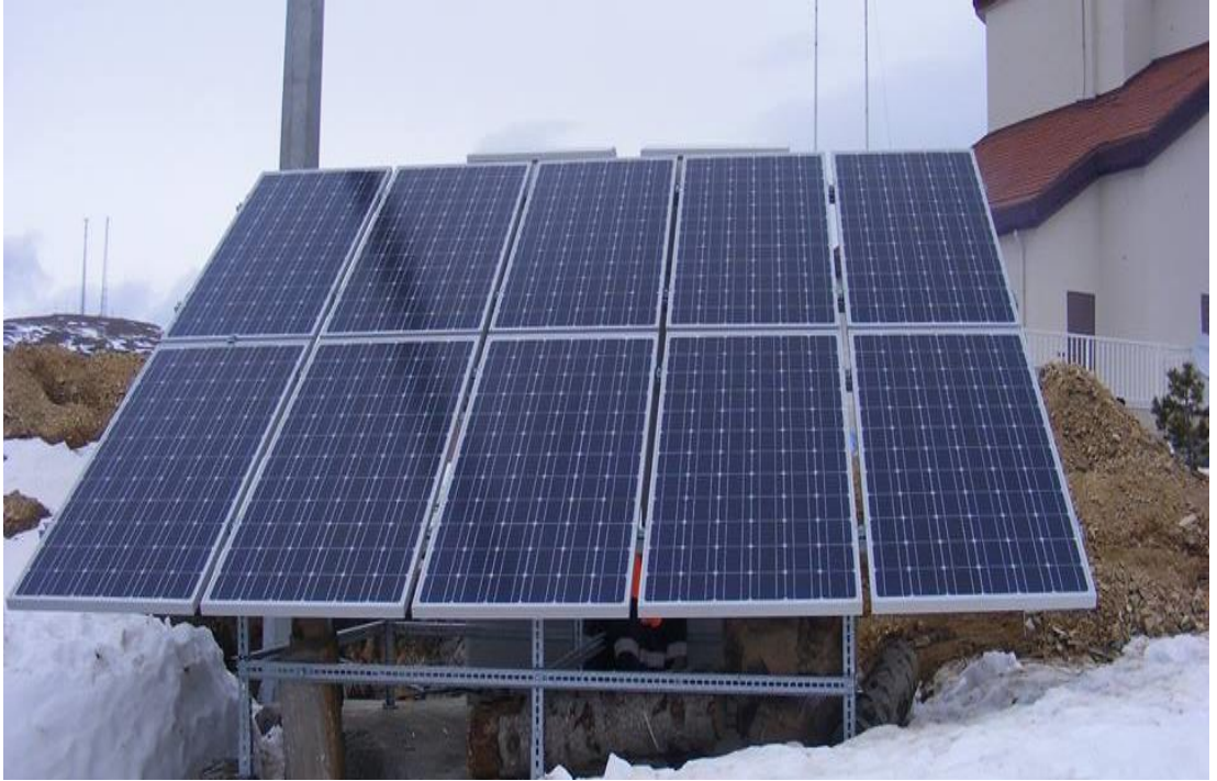
Şekil 3.35. PV panellerin montajı
