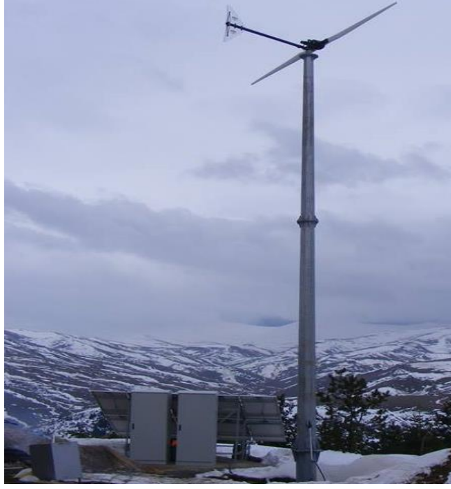
Şekil 3.40. Direk ve türbin montajının tamamlanması
