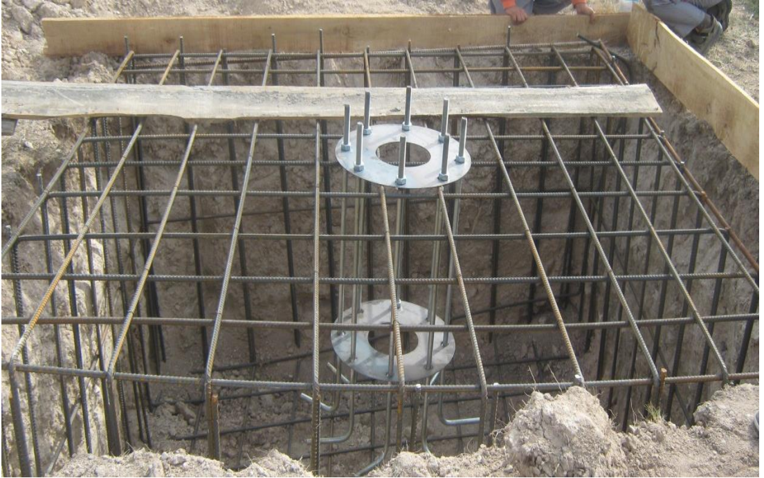
Şekil 3.38. Rüzgâr türbini direği betonlama hazırlıkları
