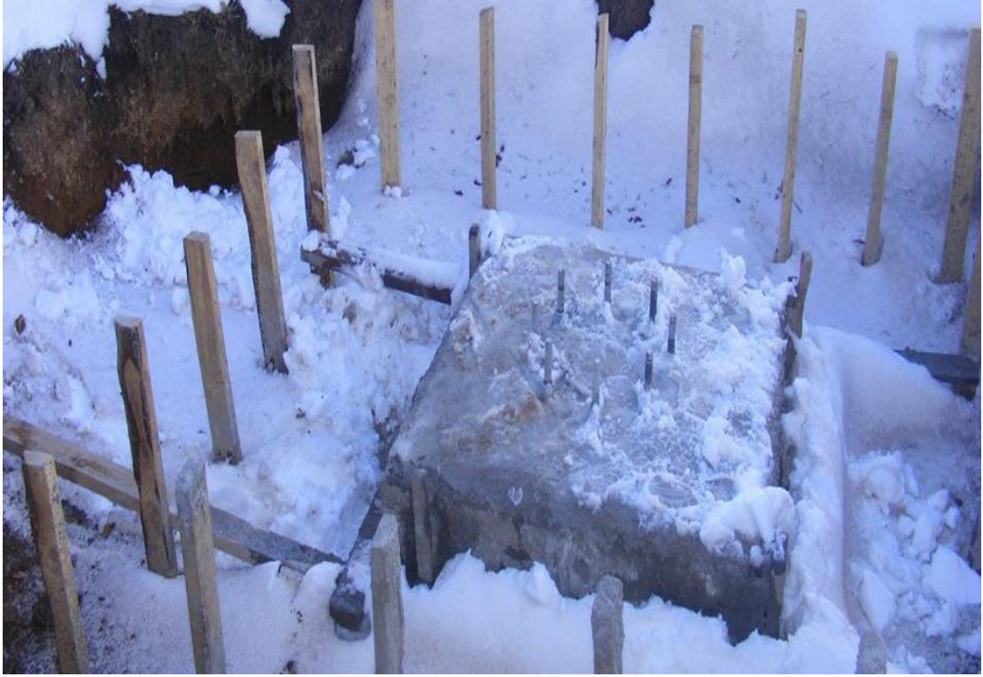
Şekil 3.39. Rüzgâr türbini direği betonlamasının tamamlanması
