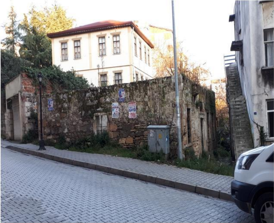
Görsel 124. Batı Cephe Zemin Kat.
