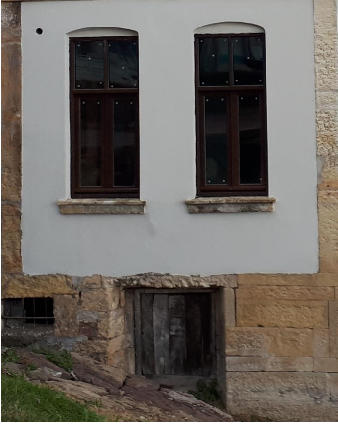
Görsel 435. Doğu Cephedeki Bodrum Kat Giriş Kapısı.
