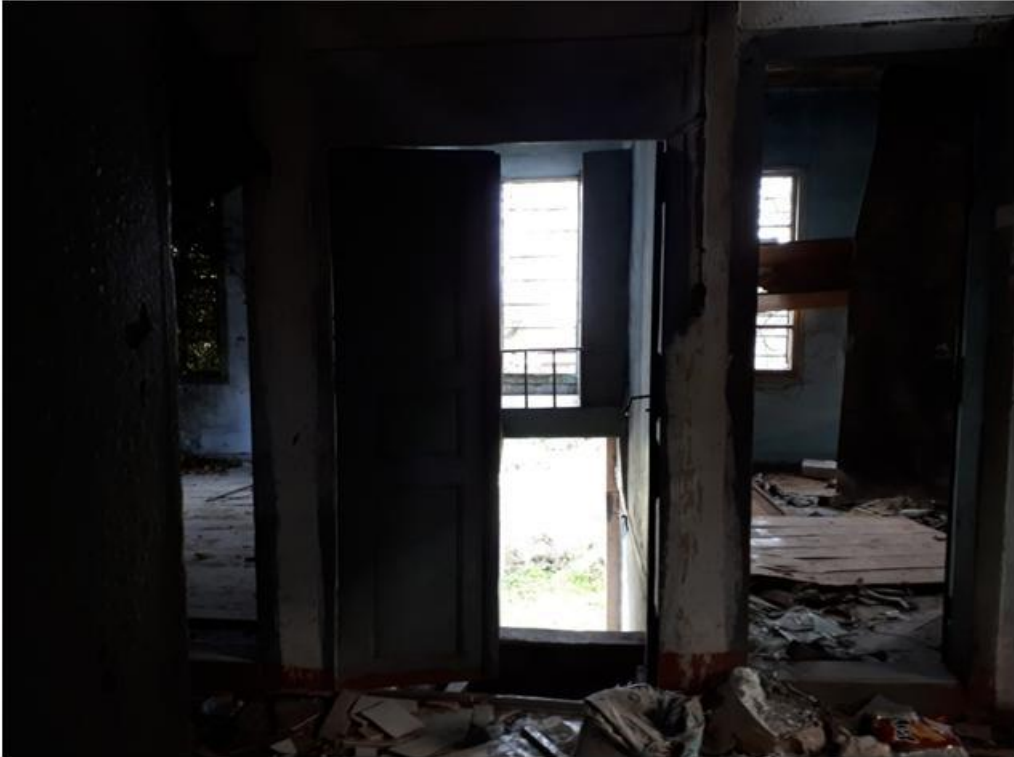
Görsel 300. Zemin Kat Sofanın Doğu Duvarı.
