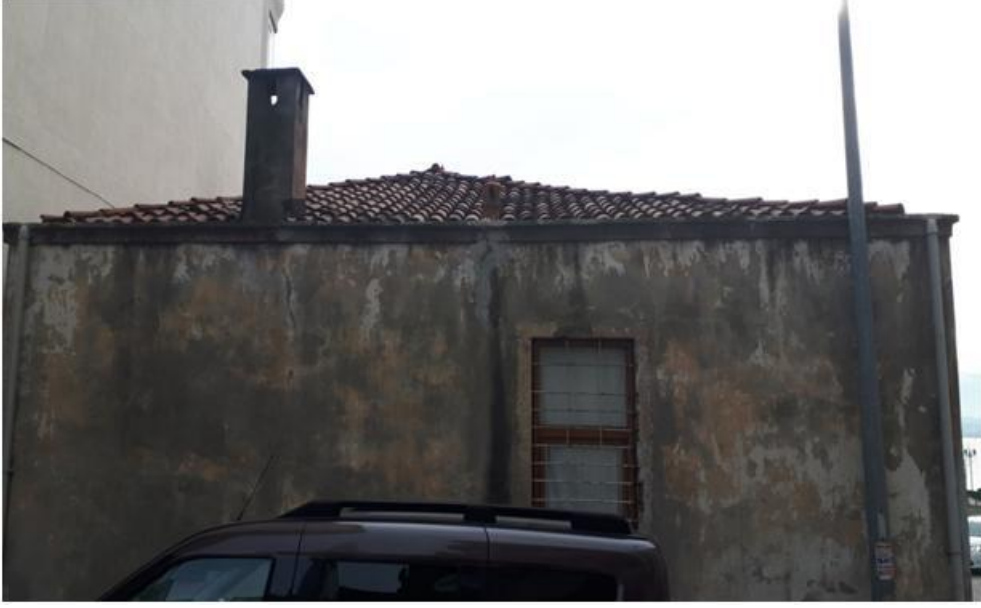
Görsel 347. Konutun Batı Cephesinden Çatı ve Baca.
