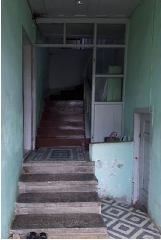
Görsel 197. Bodrum Katın Giriş Kapısı (Sağdaki).
