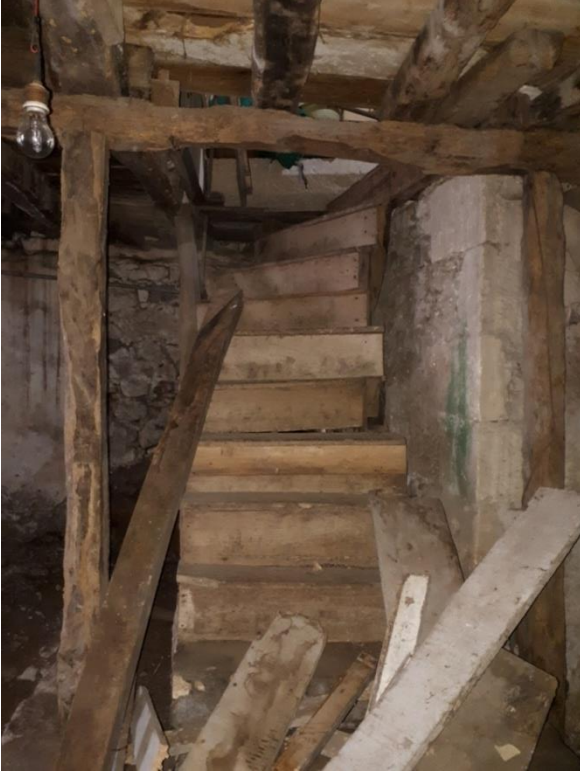
Görsel 39. Bodrum Kat, Zemin Kata Çıkan Ahşap Merdiven.
