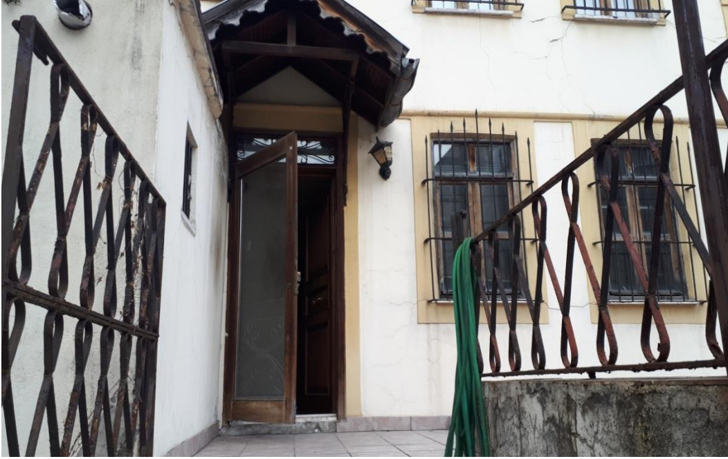
Görsel 178. Batı Cephe Zemin Kat Bahçe Kapısı.
