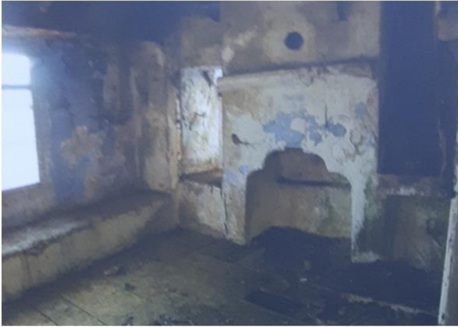
Görsel 336. Zemin Kat Güneybatıda Köşedeki Mutfak (S. K.V. K. B. K Arşivi).
