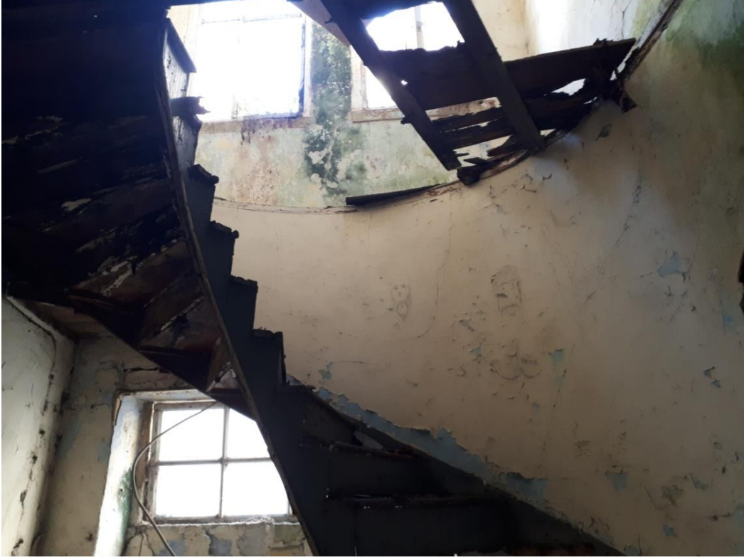
Görsel 73. Birinci Kata Çıkan Ahşap Merdiven.
