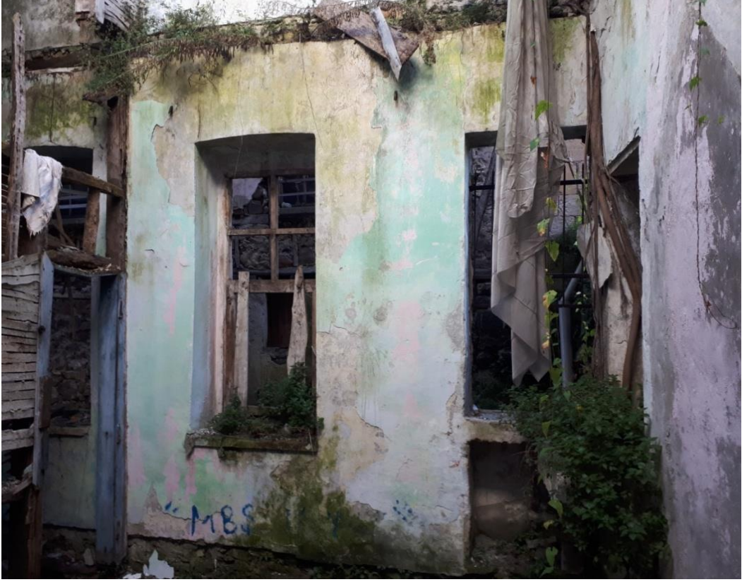
Görsel 83. Zemin Kat Güney Bölüm, Güneybatı Oda.
