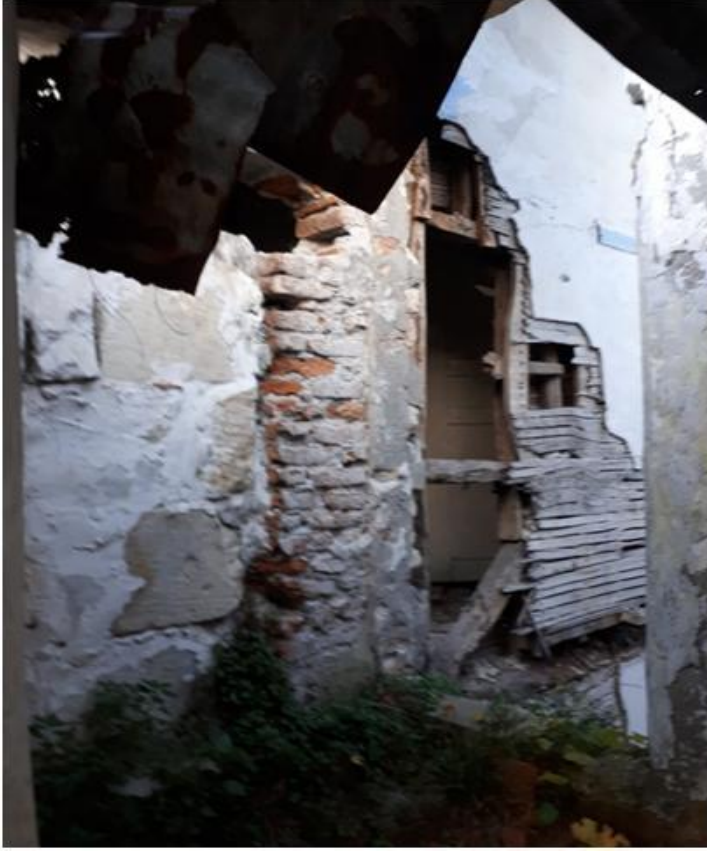
Görsel 65. Birinci Kat Batı Cephe Güney Bölümün Girişi.
