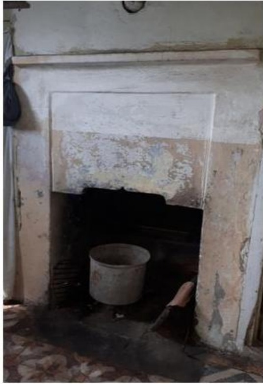
Görsel 208. Zemin Katın Güney Tarafındaki Ocak.
