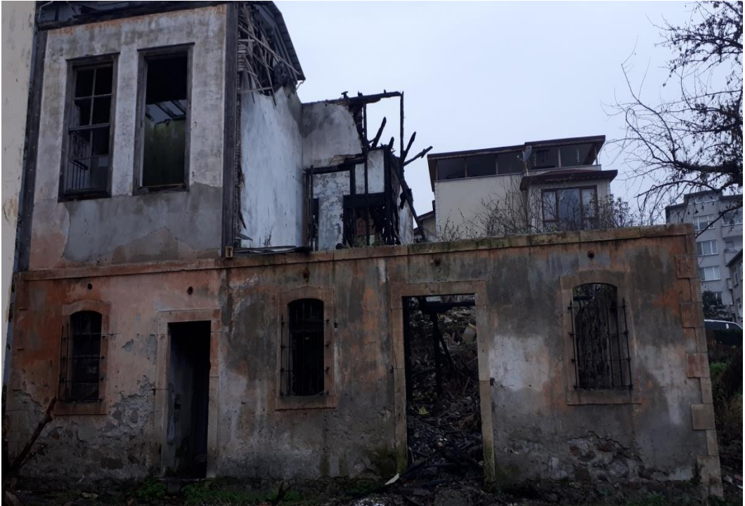
Görsel 104. Doğu Cephe Zemin Kat.
