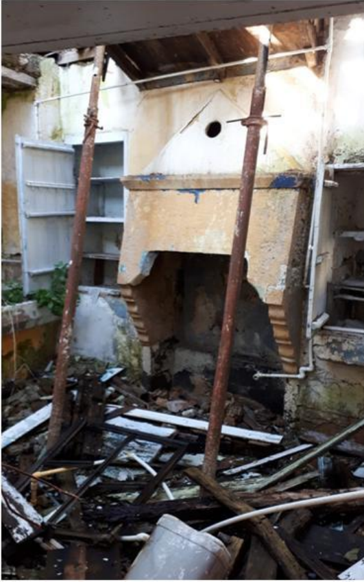
Görsel 320. Zemin Kat Odasının Kuzey Duvarındaki Ocak.
