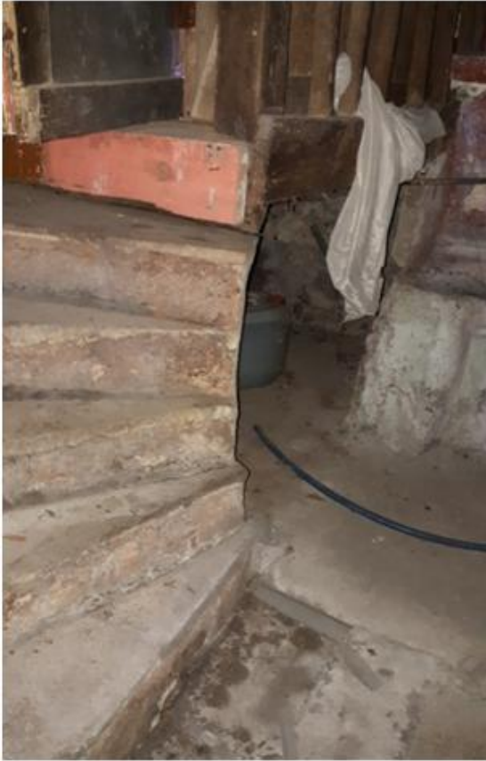
Görsel 204. Bodrum Kat Merdiveni.
