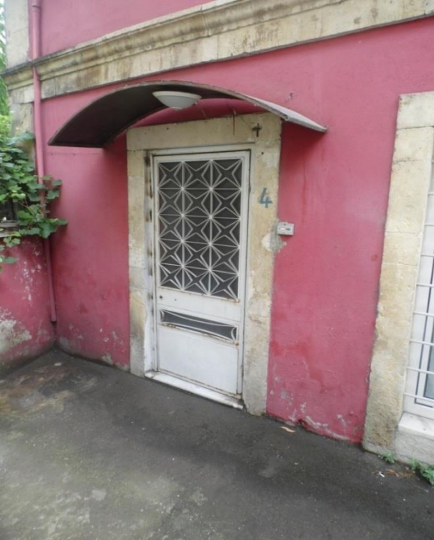
Görsel 248. Kuzey Cephe Zemin Kat Girişi.
