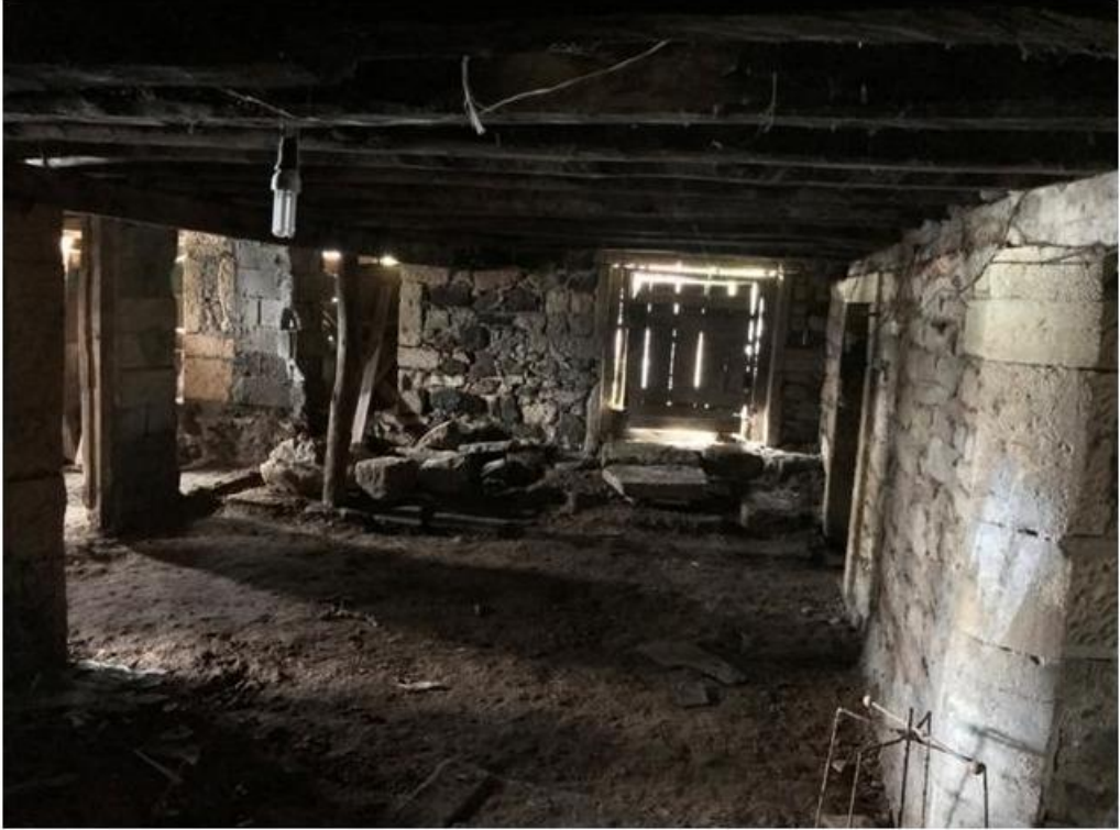
Görsel 446. Bodrum Kat Sofası Doğu Duvarı (Melike Ünlü 'den).
