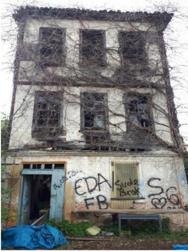
Görsel 249. Tolun Konutunun Doğu Cephesi (2018).
