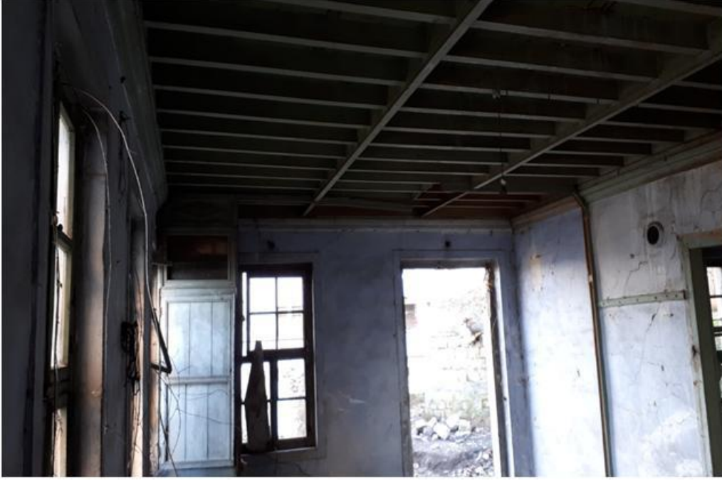
Görsel 373. Zemin Kat Sofası Güney Duvarı.
