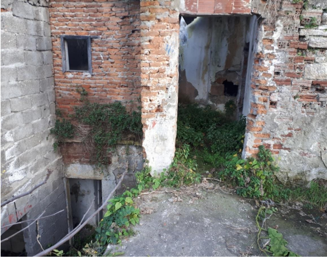
Görsel 92. Batı Cephe Birinci Kat Güney Bölümüm Muhdes Kısımdan Girişi.
