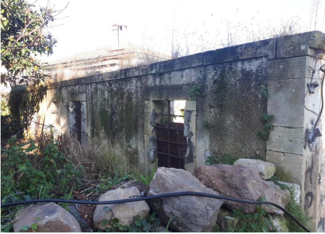
Görsel 163. Batı Cephe Zemin Kat.
