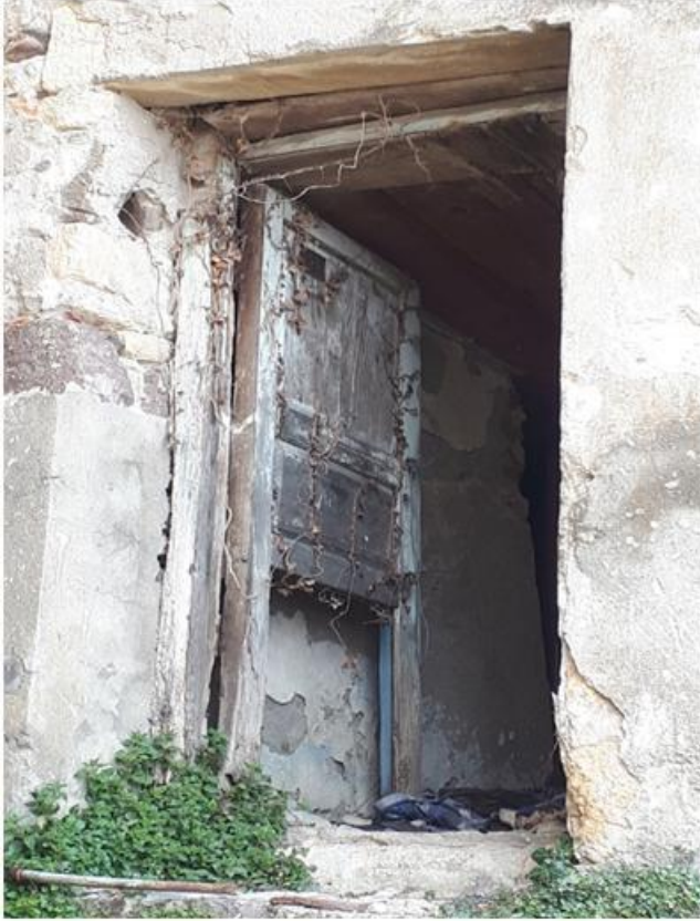
Görsel 418. Zemin Kat Girişi.
