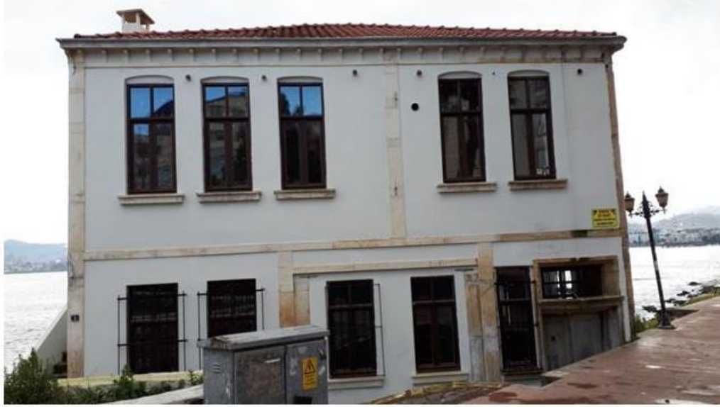
Görsel 430. Yılmaz Konutunun Kuzey Cephesi.
