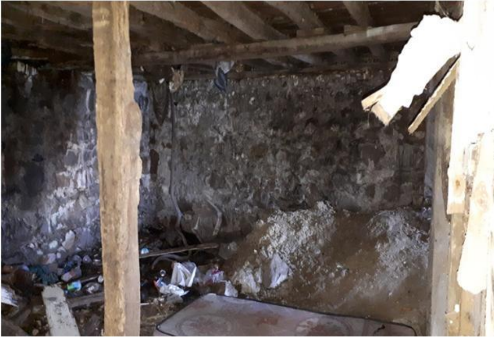
Görsel 370. Bodrum Kat Kuzeybatı Köşedeki Odanın Kuzey ve Batı Duvarı.
