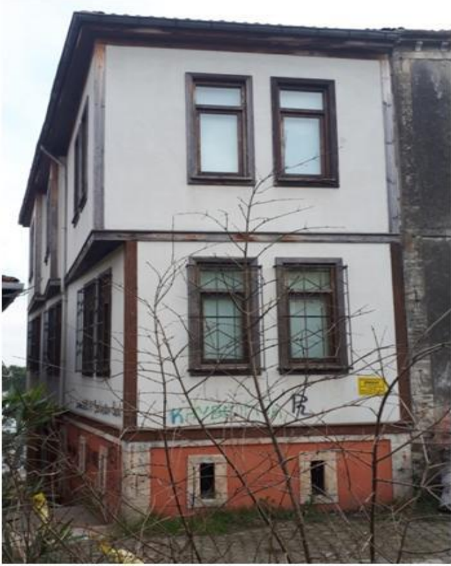
Görsel 6. Konutun Batısından Kuzey Cephesi.
