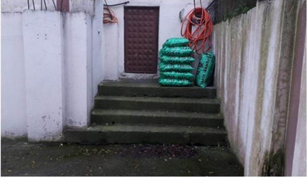
Görsel 139. Kuzey Cephe Zemin Kat Kapısı.
