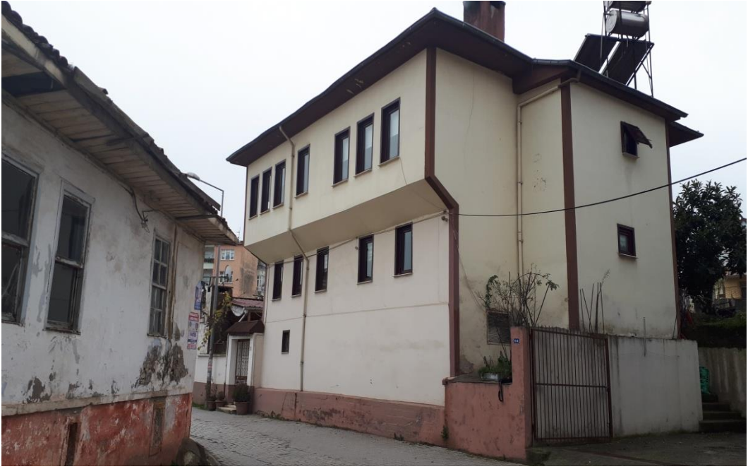
Görsel 136. Kuzey Cephe.
