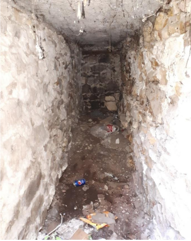
Görsel 69. Bodrum Kat Kuzey Yöndeki Sarnıç Duvarı.
