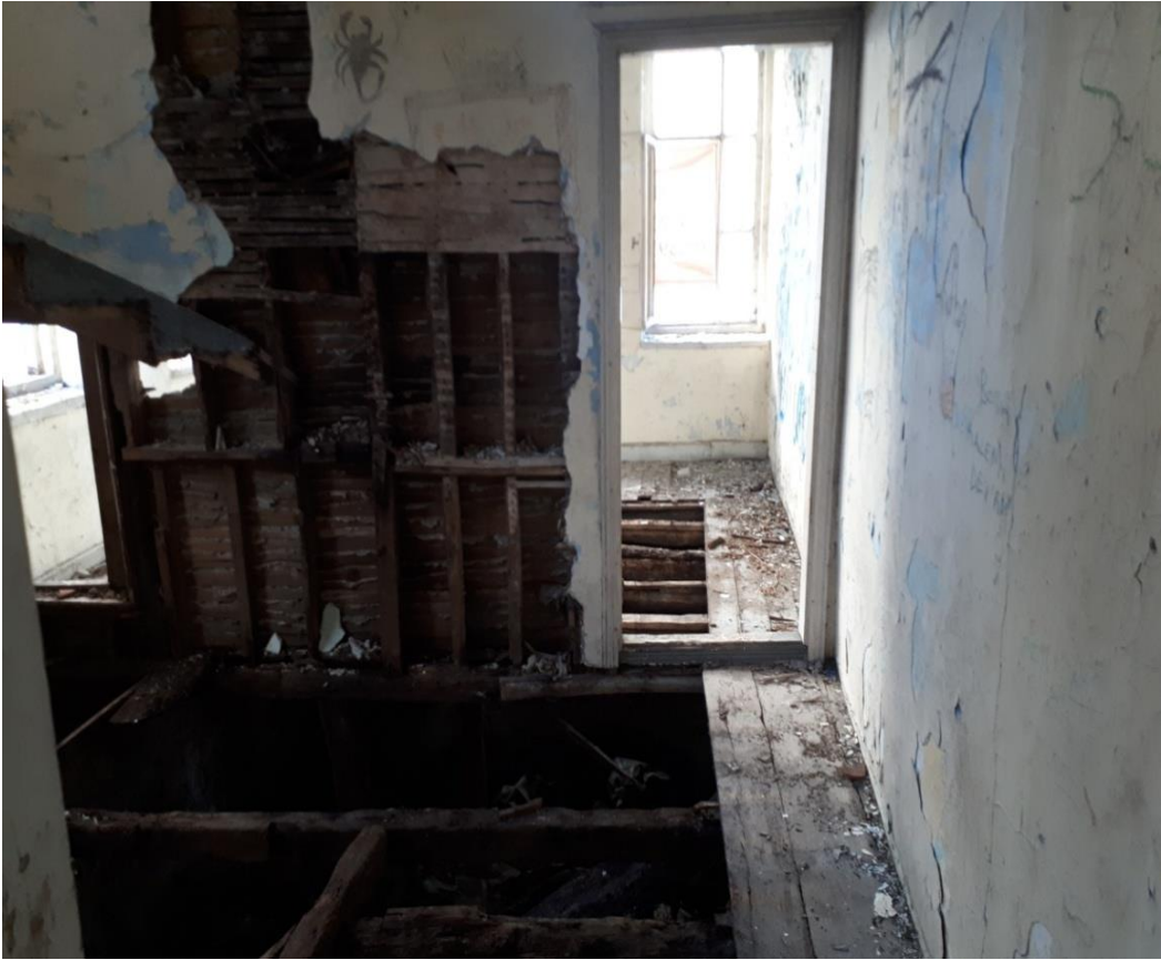
Görsel 74. Zemin Kat Merdiven Dairesinin Doğu Duvarı.
