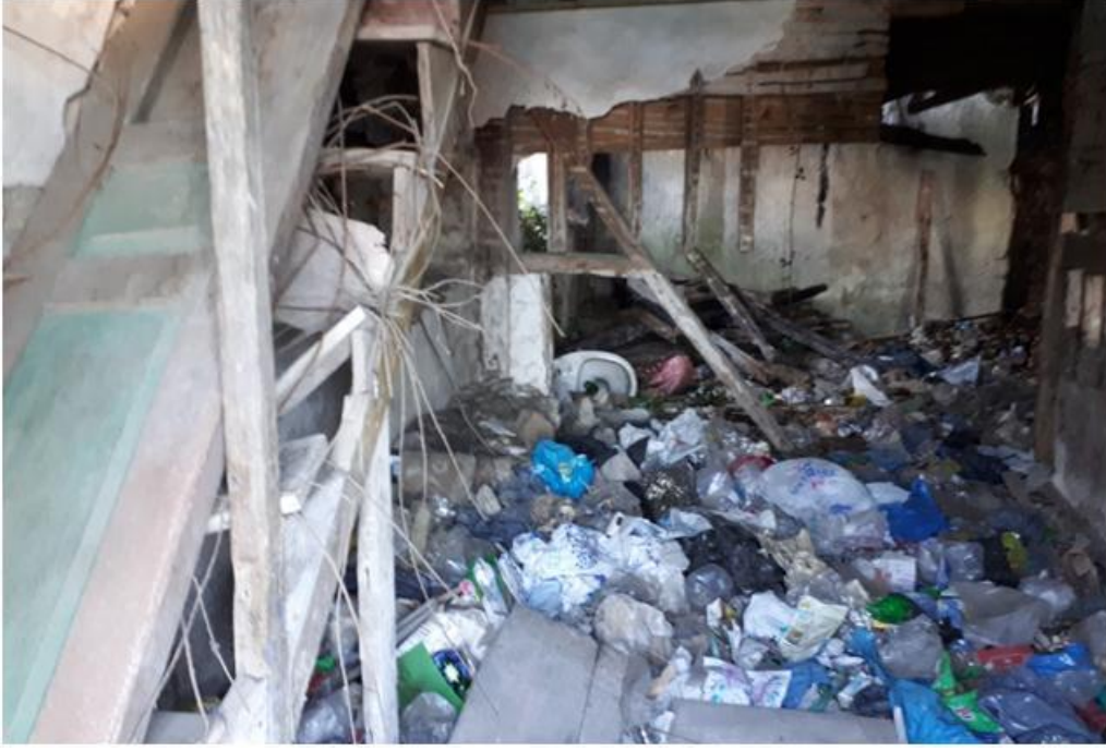
Görsel 369. Bodrum Kat Giriş Holü ve Zemin Kata Çıkan Merdiven.
