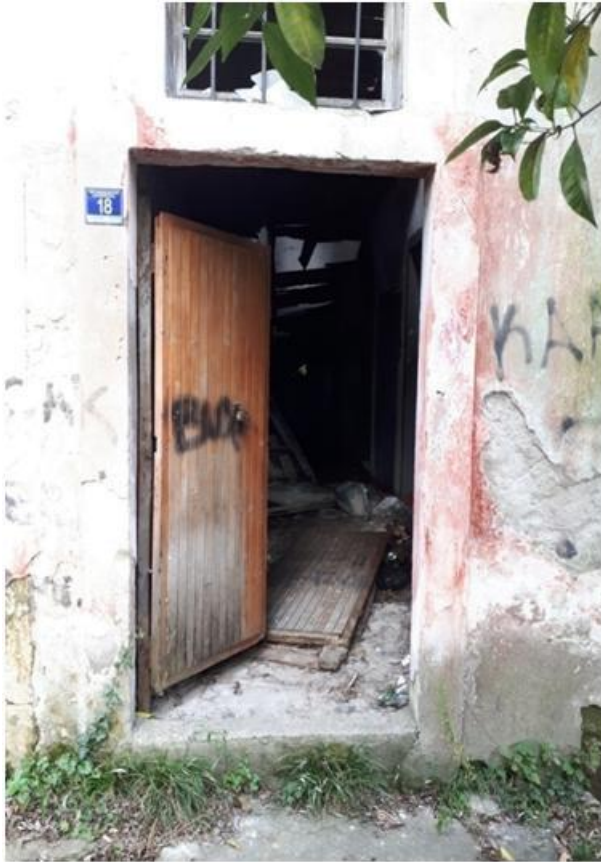
Görsel 290. Güney Cephe, Zemin Kat Giriş Kapısı.
