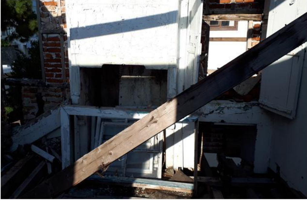
Görsel 323. Birinci Kat Ocaklı Odanın Kuzey Duvarı.
