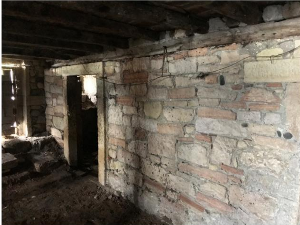
Görsel 442. Bodrum Kat Kuzeydoğu Köşedeki Odanın Girişi (Melike Ünlü 'den).
