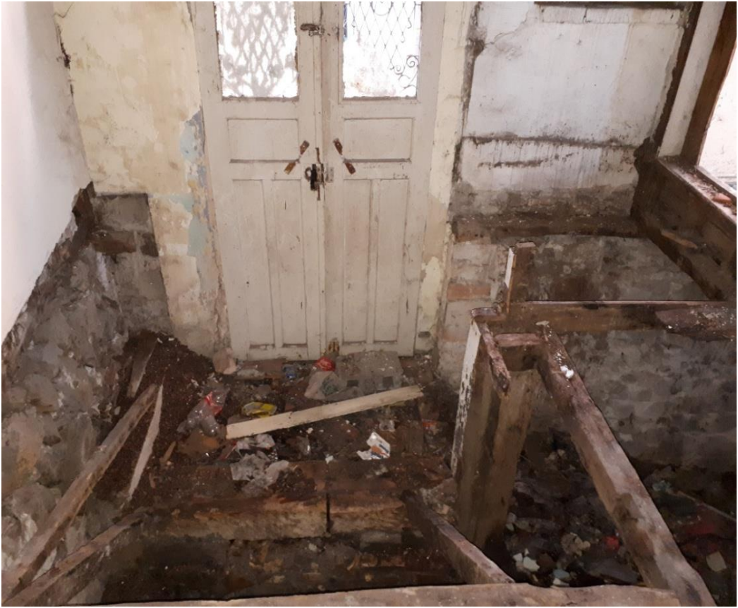
Görsel 72. Kuzey Cephe Zemin Katın Merdivenleri.
