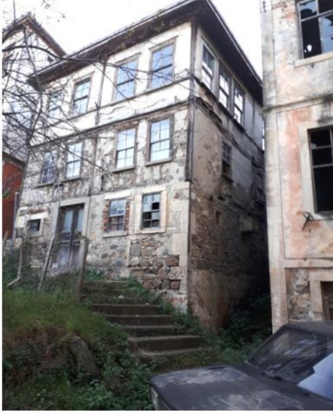
Görsel 31. Çakmakçı Konutunun Doğu Cephesi.
