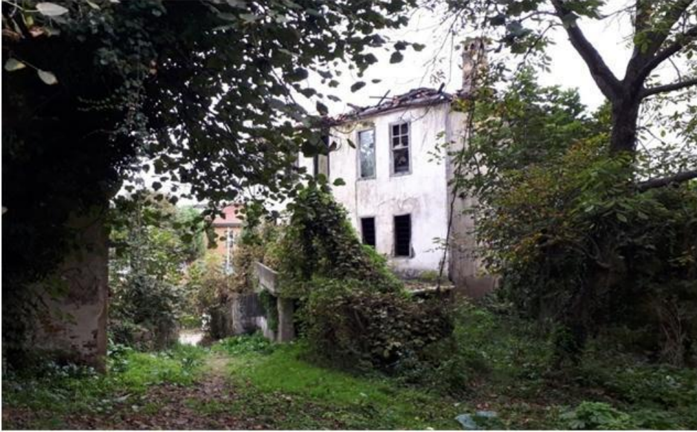
Görsel 388. Kuzey Cephe.
