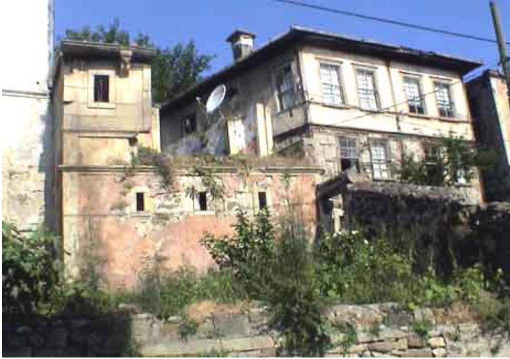
Görsel 3. Arslan Konutunun Doğu Cephesi 2004 (A. Derya Varilci 'den).
