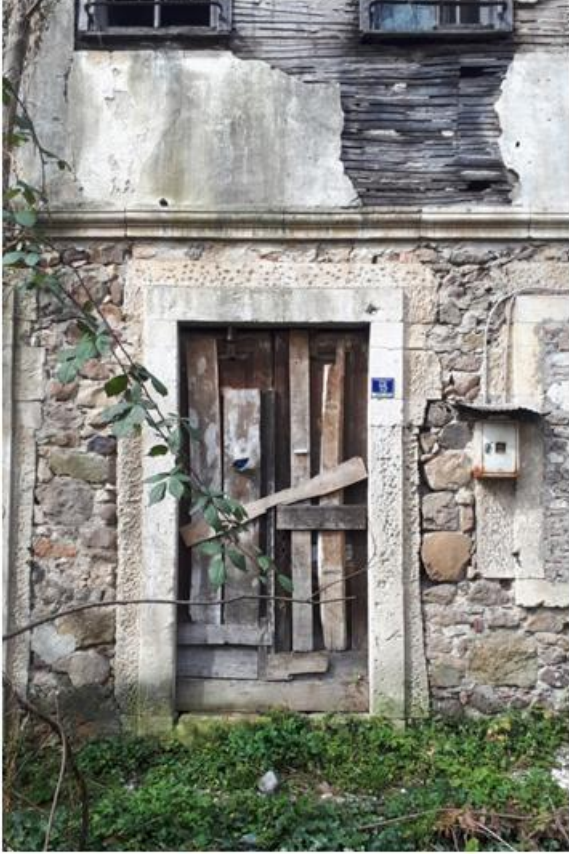
Görsel 222. Zemin Kat, Kuzey Bölüm Giriş Kapısı.
