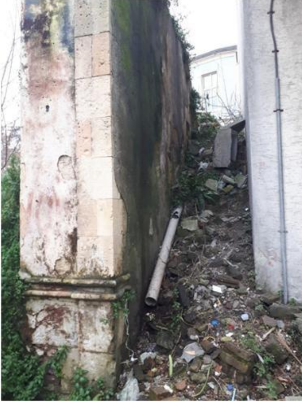
Görsel 183. Kuzeybatı Cephe Birinci Kat Duvarı.
