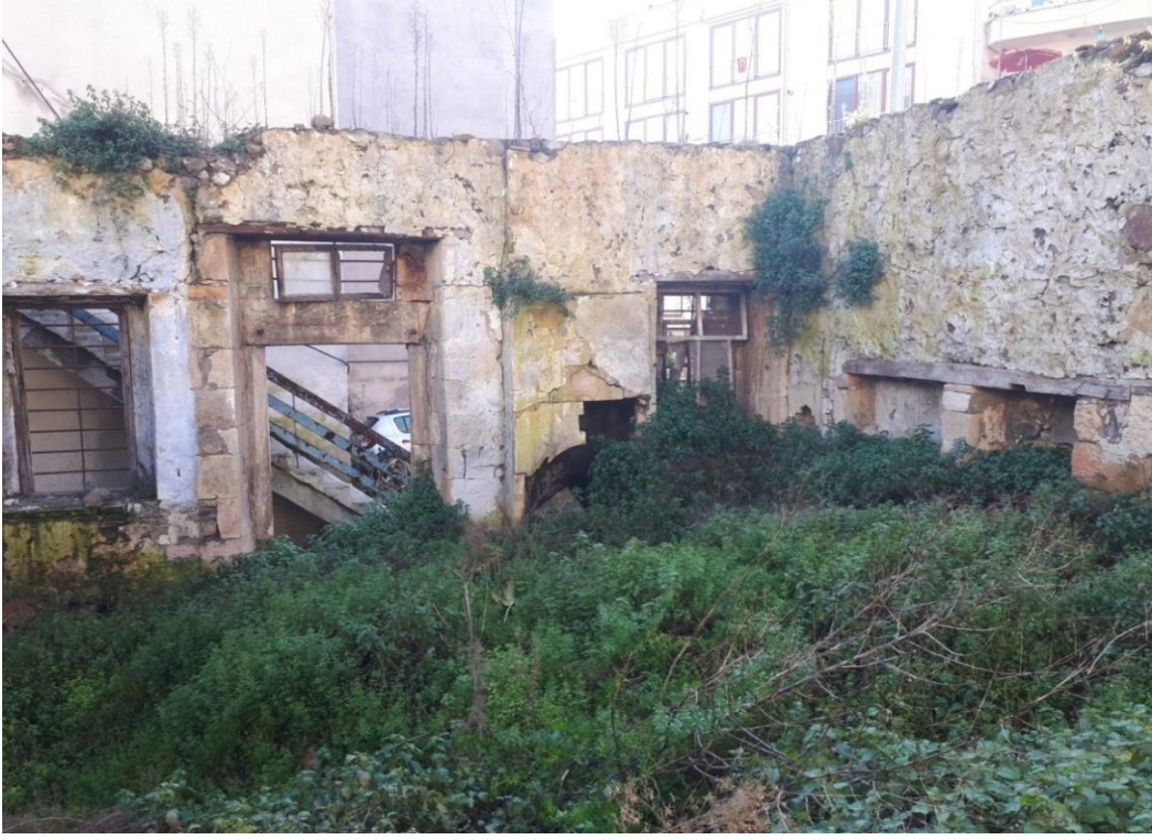
Görsel 127. Sofanın Güney Duvarı.
