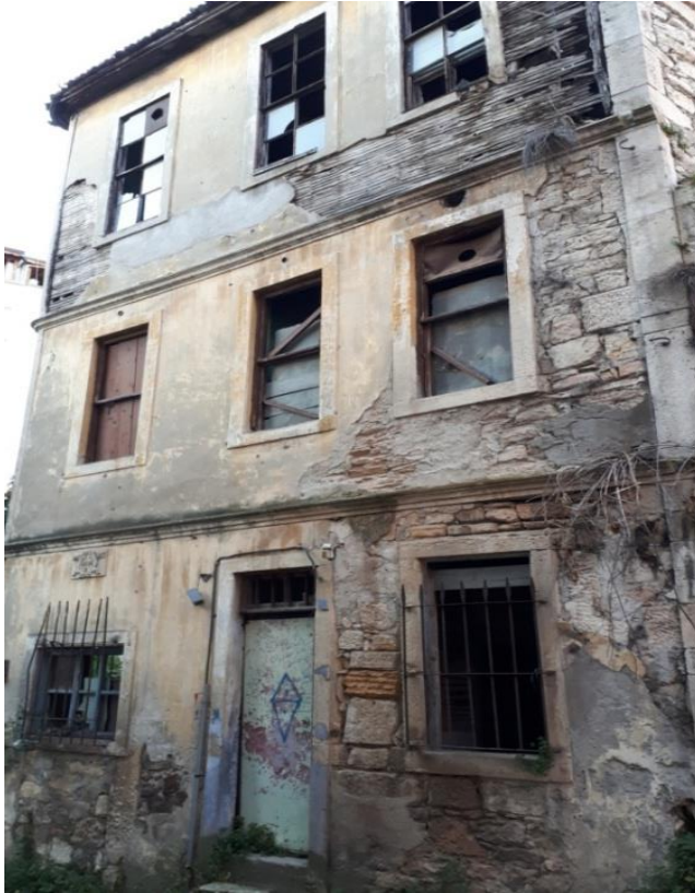
Görsel 10. Ay Konutunun Güney Cephesi.
