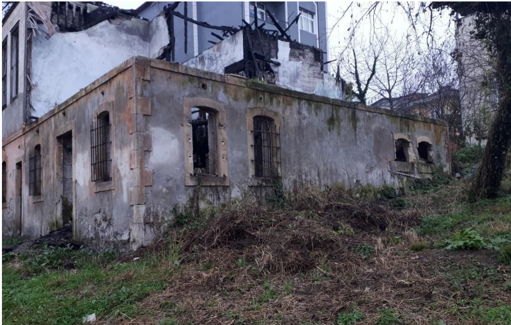
Görsel 106. Kuzey Cephe Zemin Kat.
