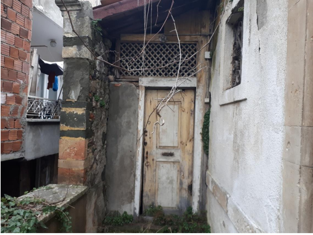
Görsel 267. Deponun Giriş Kapısı.
