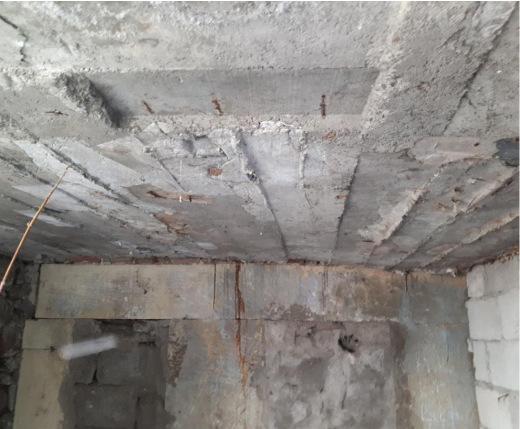
Görsel 80. Batı Cephe Zemin Kat Odunluk Doğu Duvarı.
