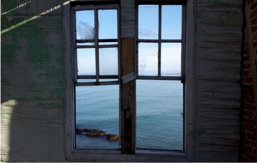
Görsel 322. Birinci Kat Güney Duvarındaki Pencere.
