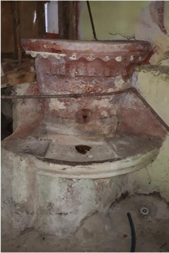
Görsel 202. Bodrum Katta Bulunan Çeşme.
