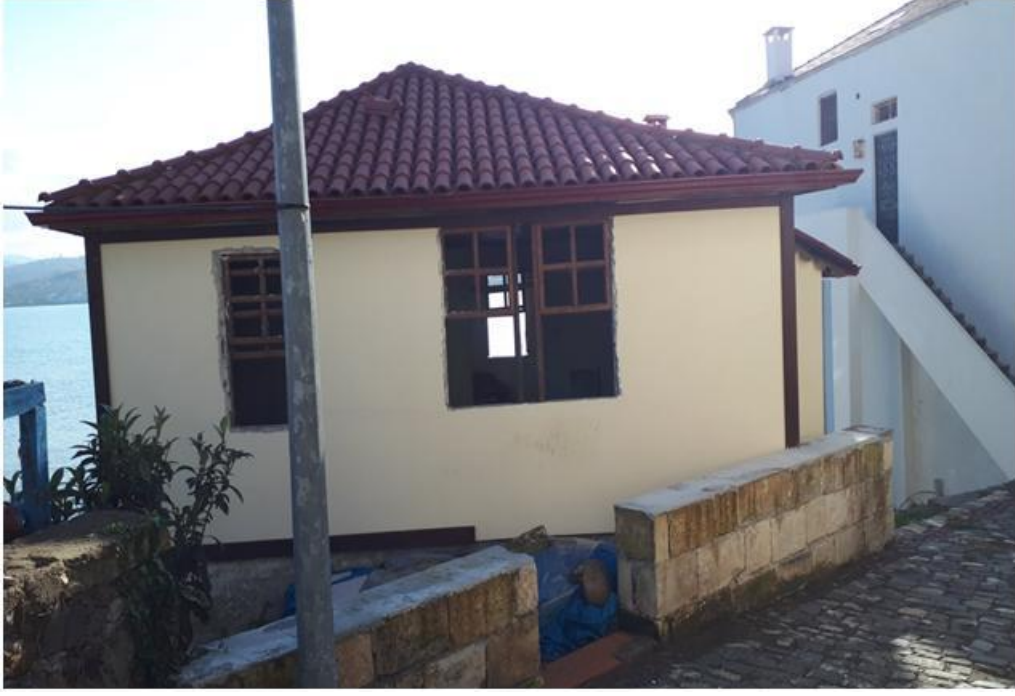
Görsel 351. Kuzey Cephe.
