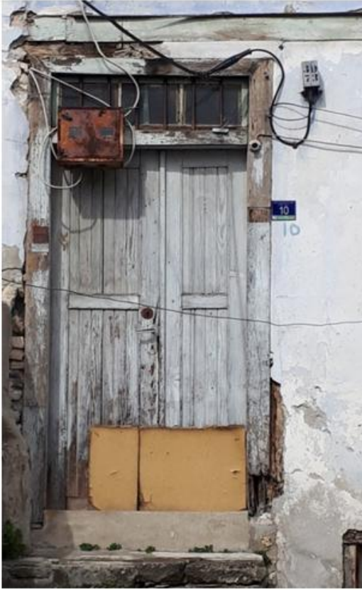
Görsel 196. Güney Cephedeki Giriş Kapısı.
