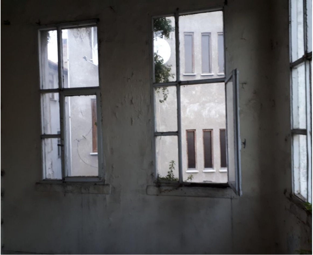
Görsel 88. Birinci Kat Kuzeydoğu Köşe Oda.
