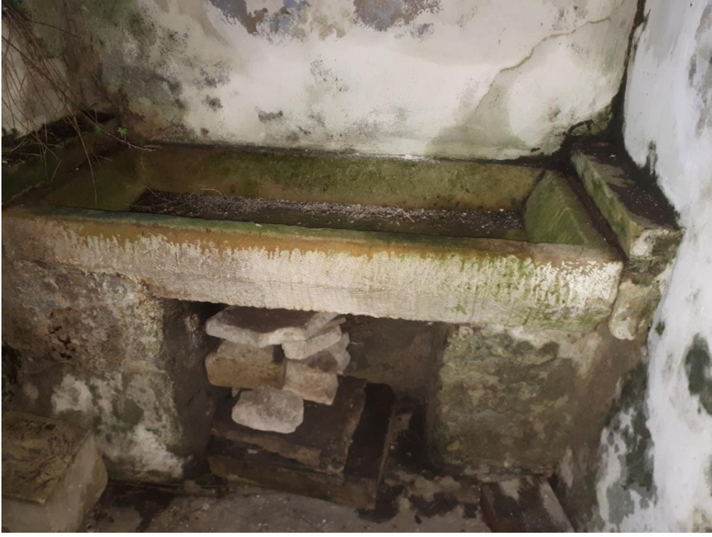
Görsel 271. Çamaşırhanenin Güney Duvarındaki Oyma Tekne.
