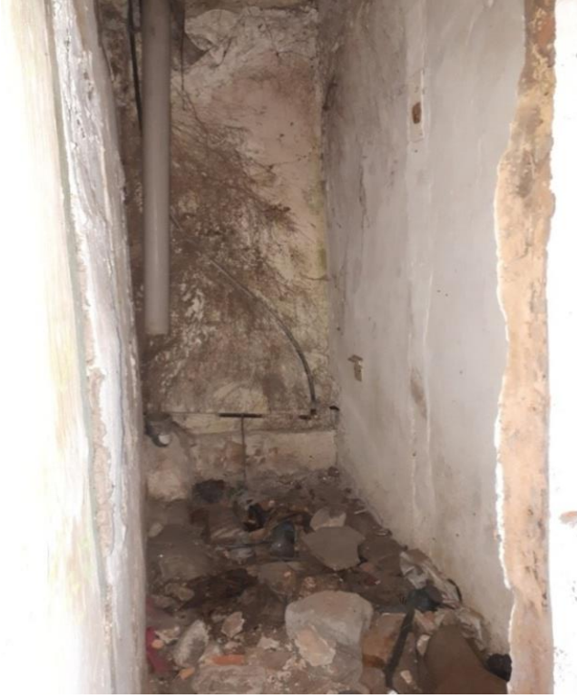
Görsel 79. Zemin Kat Ocaklı Odanın Batısındaki Tuvalet.
