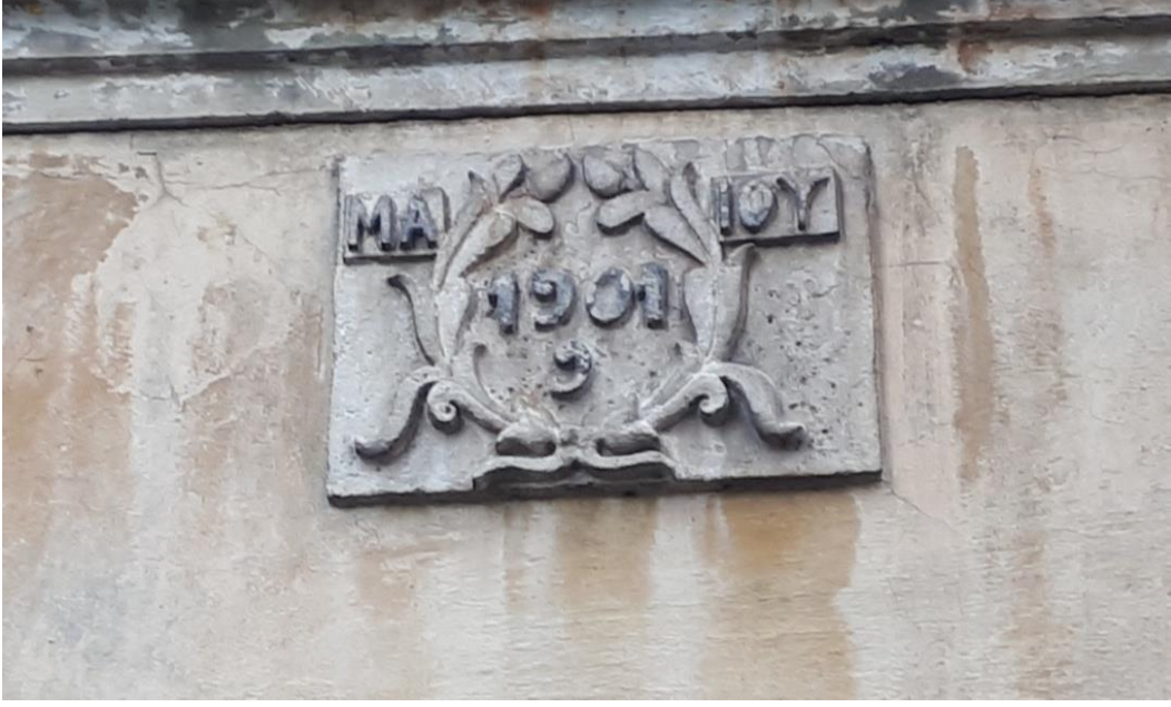
Görsel 11. Konutun Güney Cephesindeki Kitabe.
