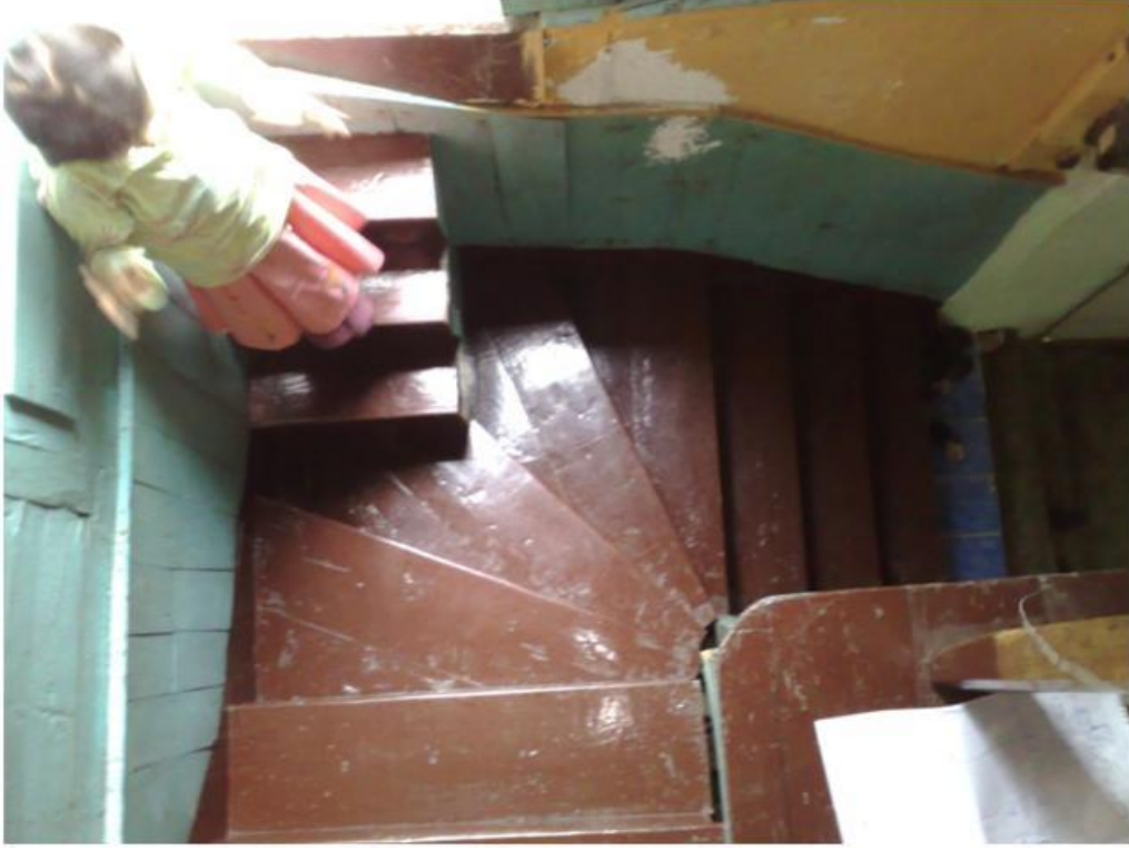
Görsel 401. Birinci Kata Çıkan Ahşap Merdiven (Melike Ünlü 'den).
