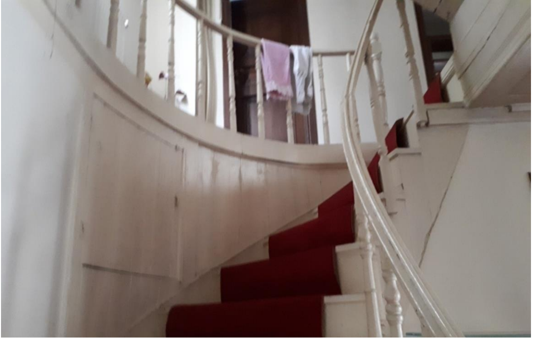
Görsel 172. Zemin Kattan Birinci Kata Çıkan Merdiven.
