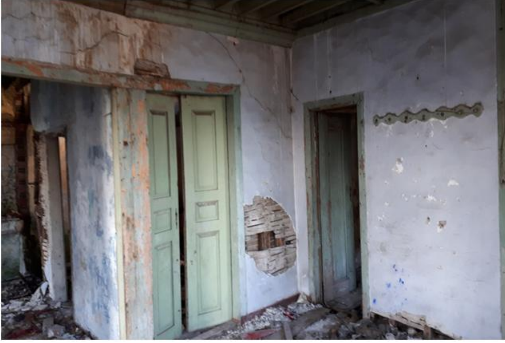
Görsel 377. Zemin Kat Sofanın Kuzeybatı Köşesi.
