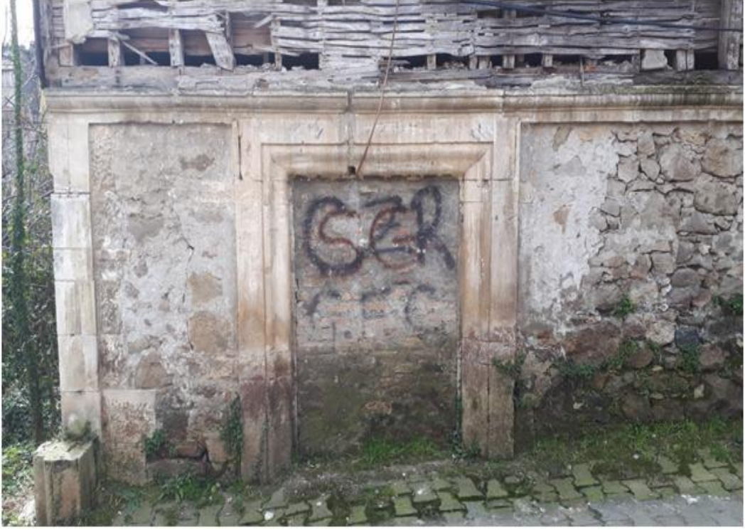
Görsel 223. Zemin Kat, Kuzey Cephe Giriş Kapısı.
