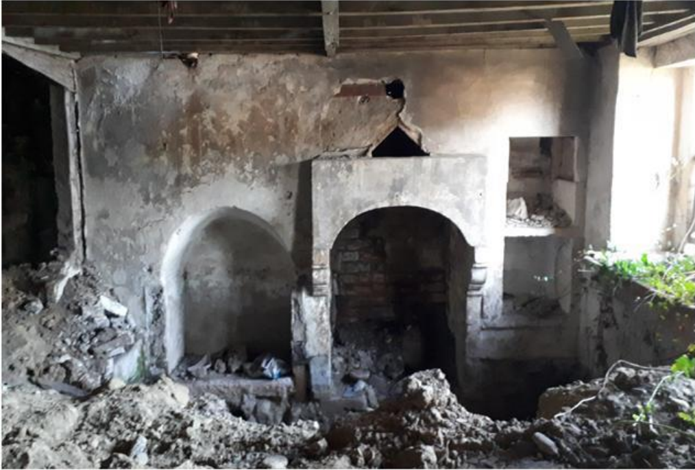
Görsel 372. Bodrum Kat Kuzeydoğu Köşedeki Odanın Kuzey Duvarı.
