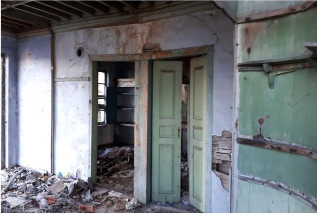
Görsel 374. Zemin Kat Sofası Batı Duvarı.
