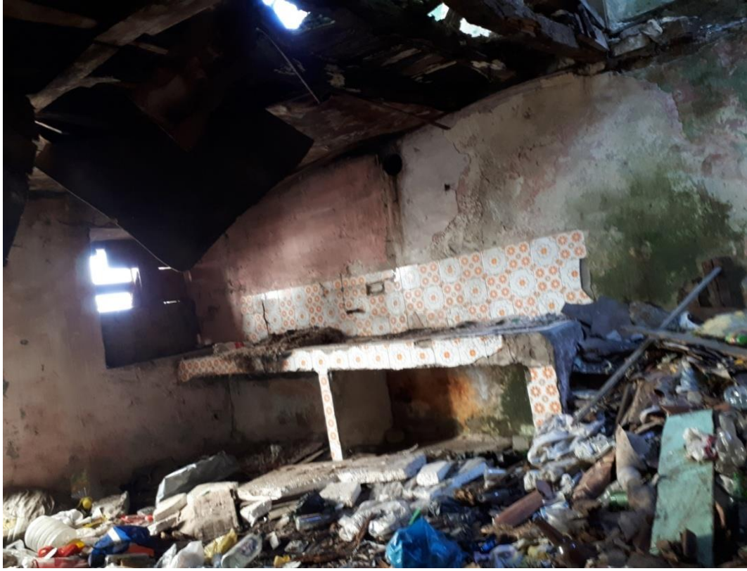
Görsel 66. Bodrum Kat Güneydoğu Köşedeki Mutfak.
