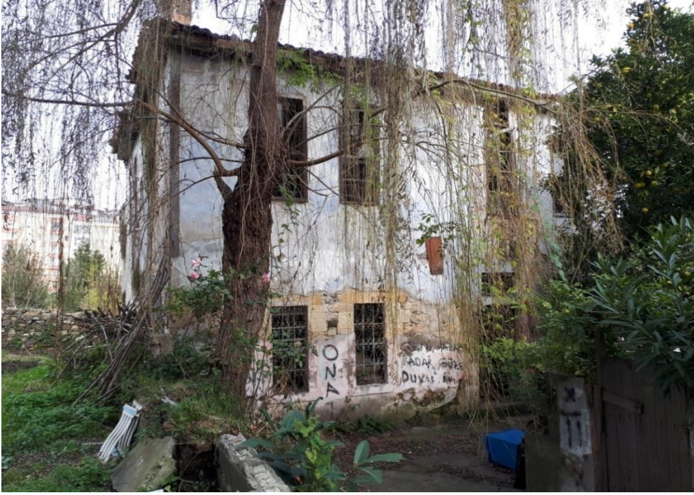
Görsel 285. Yılmaz Konutunun Güney Cephesi.
