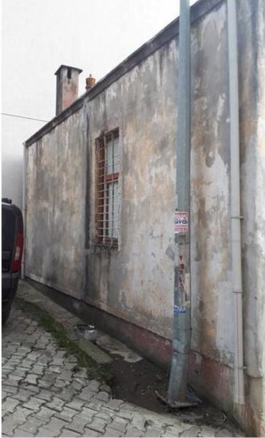
Görsel 344. Konutun Batı Cephesi.
