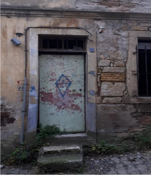
Görsel 15. Güney Cephe Bodrum Kat Girişi.
