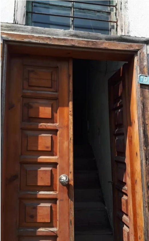
Görsel 206. Zemin Kat Girişi.
