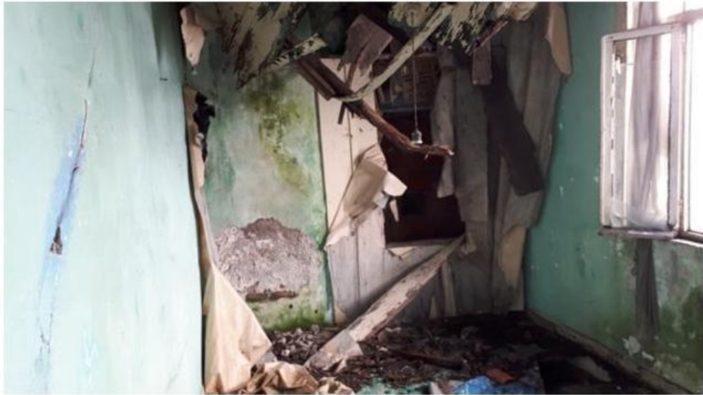
Görsel 428. İkinci Kat Sofanın Kuzeybatısındaki Oda.
