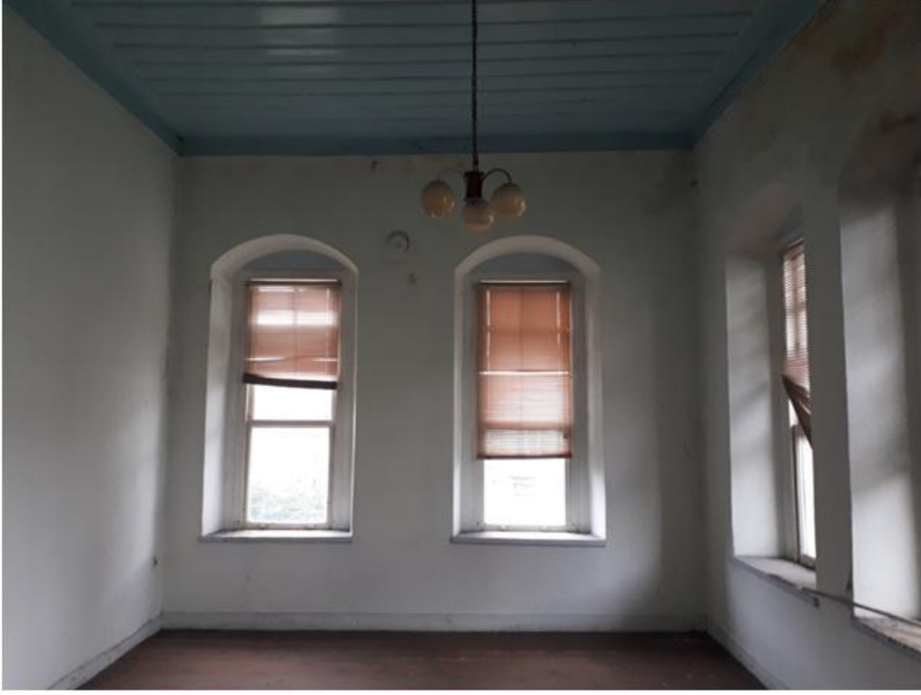
Görsel 279. Birinci Kat Kuzeydoğu Köşe Oda.
