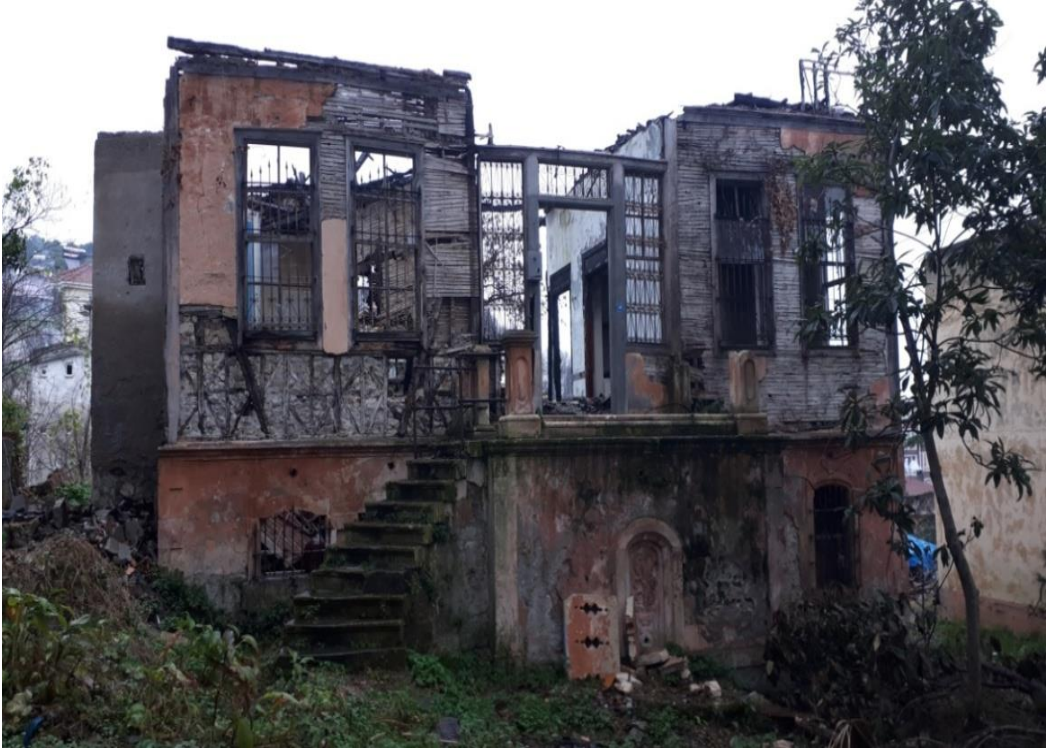
Görsel 97. Dönmez Konutunun Güney Cephesi.
