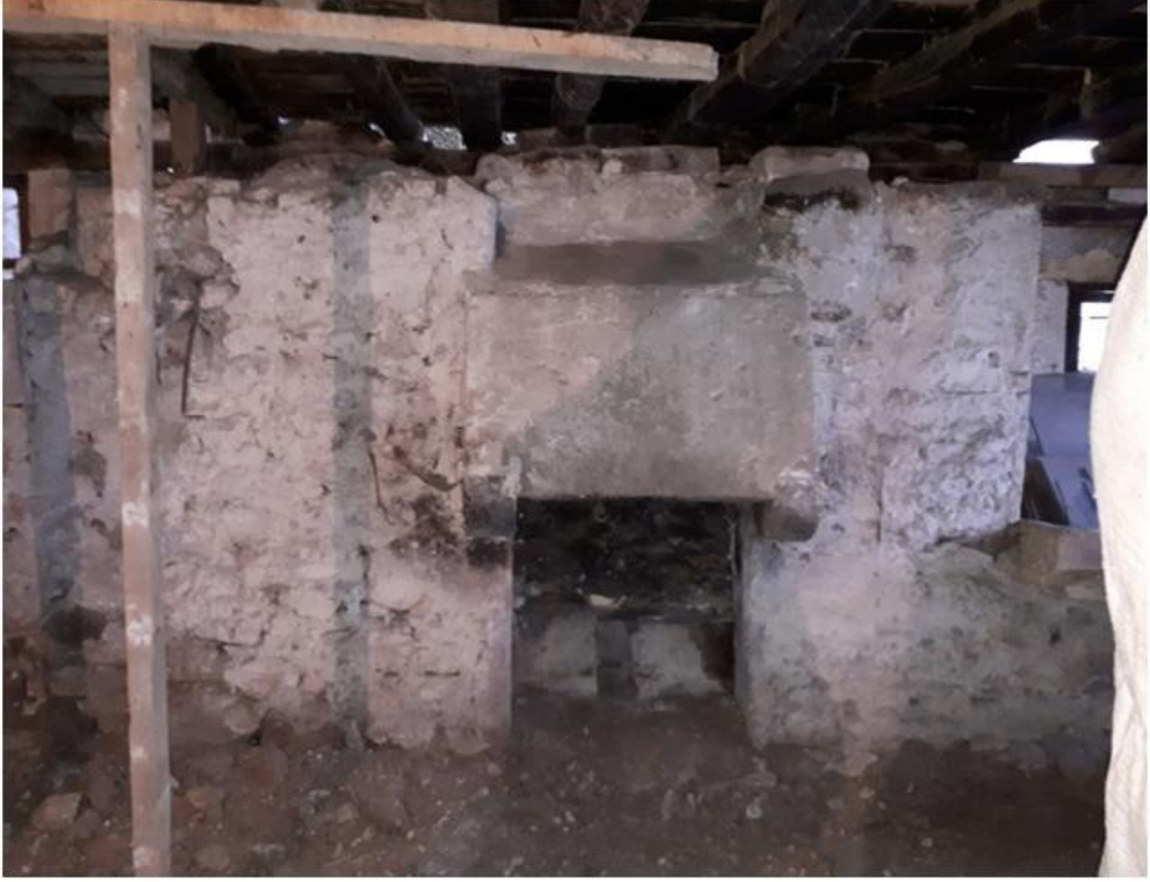
Görsel 41. Bodrum Kat, Kuzey Duvarı ve Ocak.
