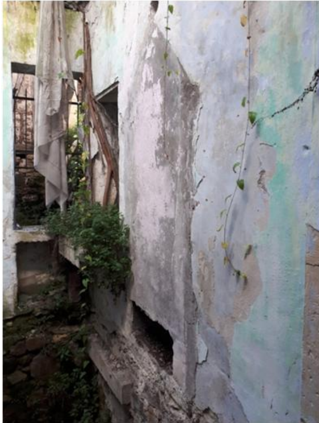
Görsel 84. Zemin Kat Güneybatı Odanın Batı Duvarı.
