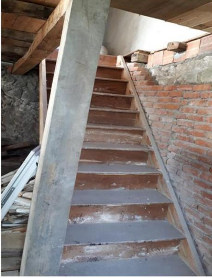
Görsel 357. Bodrum Kat, Kuzey Duvarındaki Ahşap Merdiven.
