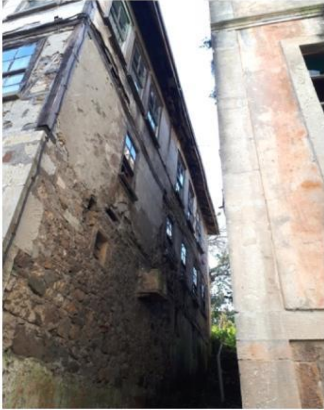
Görsel 32. Kuzey Cephe.
