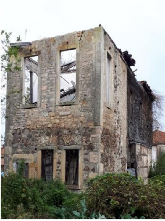
Görsel 253. Batı Cepheden Güney Cepheye Görünüm.
