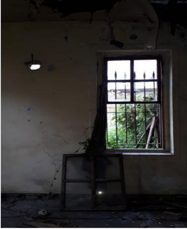
Görsel 27. Zemin Katın Kuzeybatı Köşesindeki Oda.
