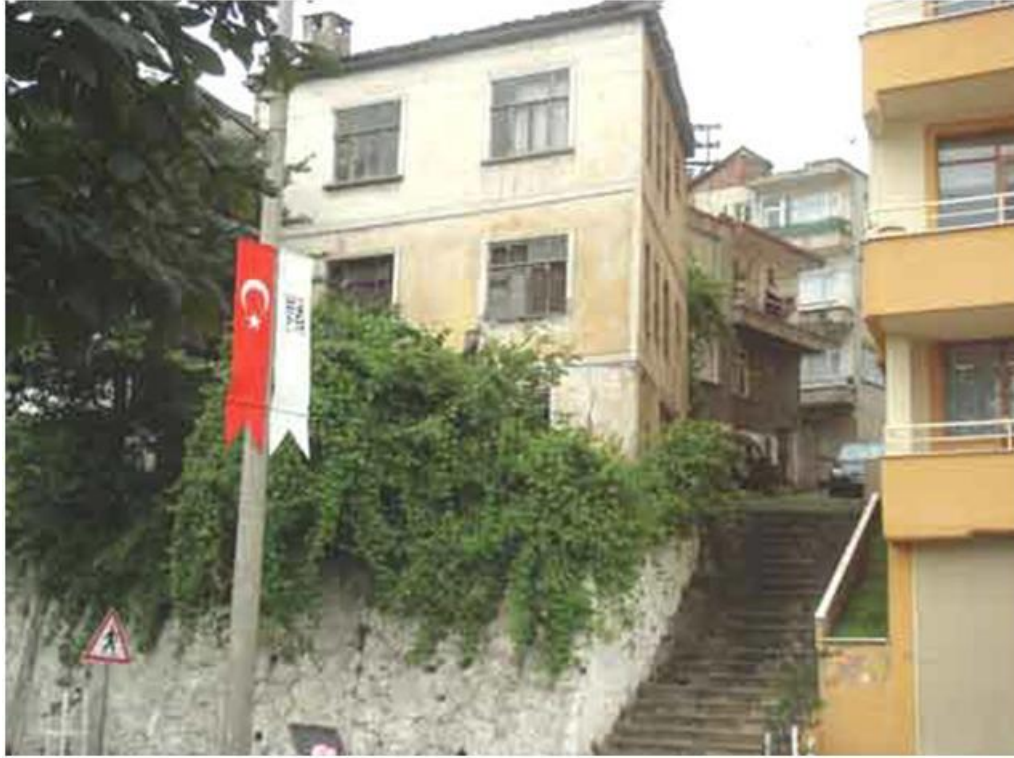
Görsel 326. Doğu cephe (Belediye Arşivinden).
