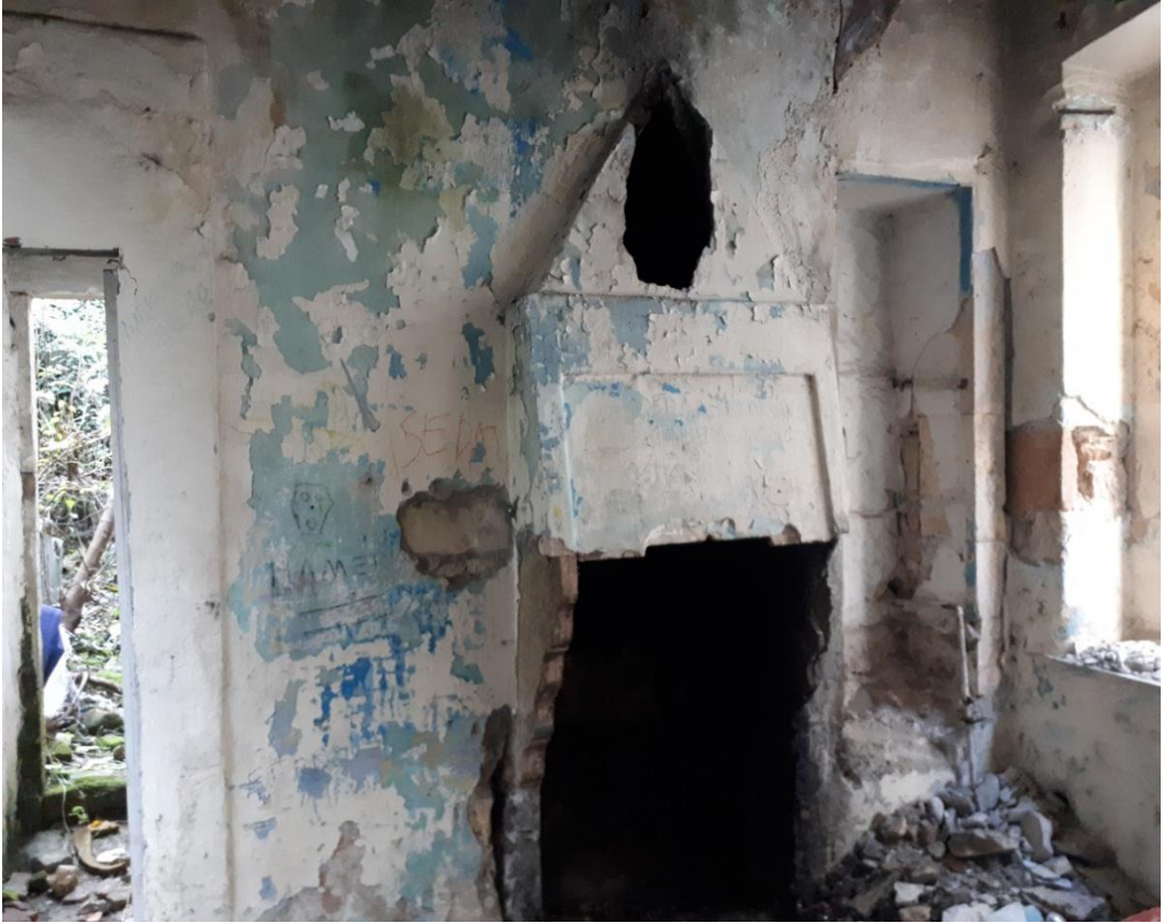
Görsel 76. Zemin Kat Kuzeybatı Köşe Odanın Batı Duvarı.
