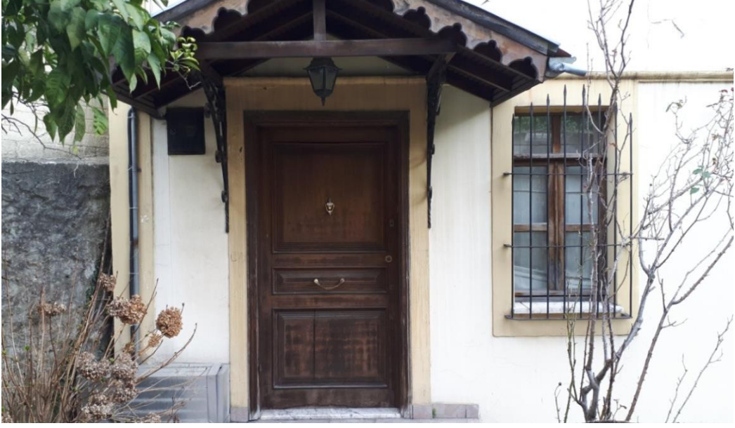
Görsel 177. Kuzey Cephe Zemin Kat Kapısı.
