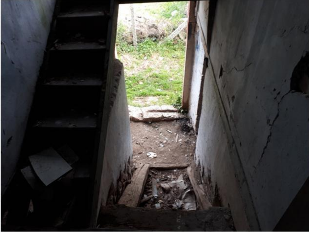
Görsel 292. Bodrum Kattan Zemin Kata Çıkan Merdiven.
