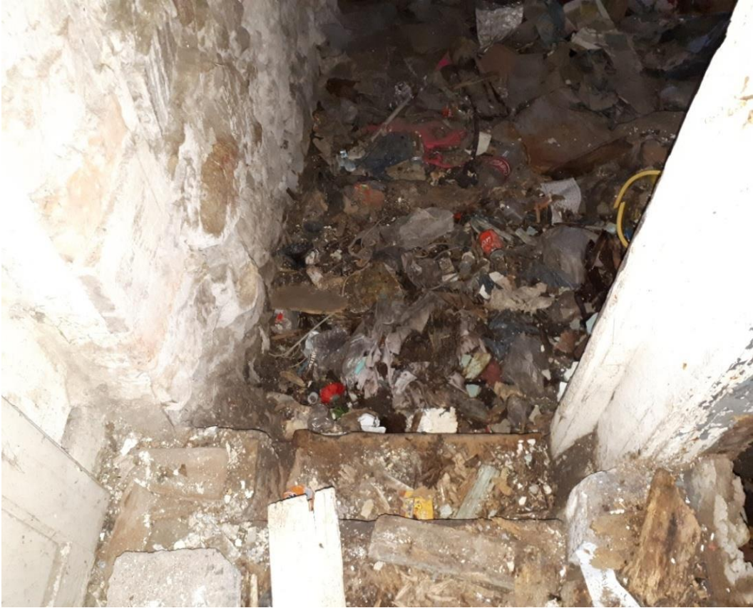
Görsel 70. Kuzey Cephe Bodrum Kat Girişi.
