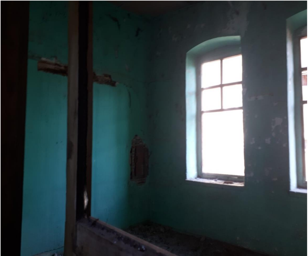
Görsel 82. Zemin Kat Güney Bölüm Güneydoğu Oda.
