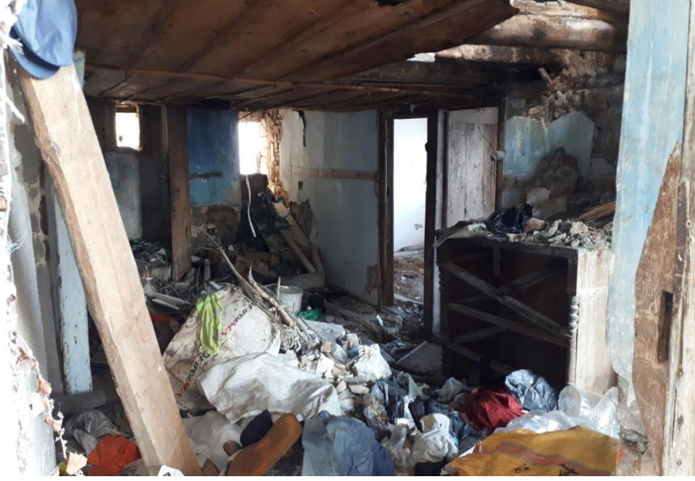
Görsel 421. Zemin Kat Sofası.
