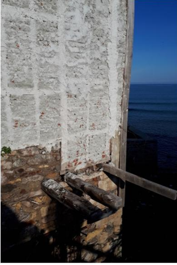
Görsel 311. Güney Cephesindeki Tuvalet Çıkmasının Kirişleri.
