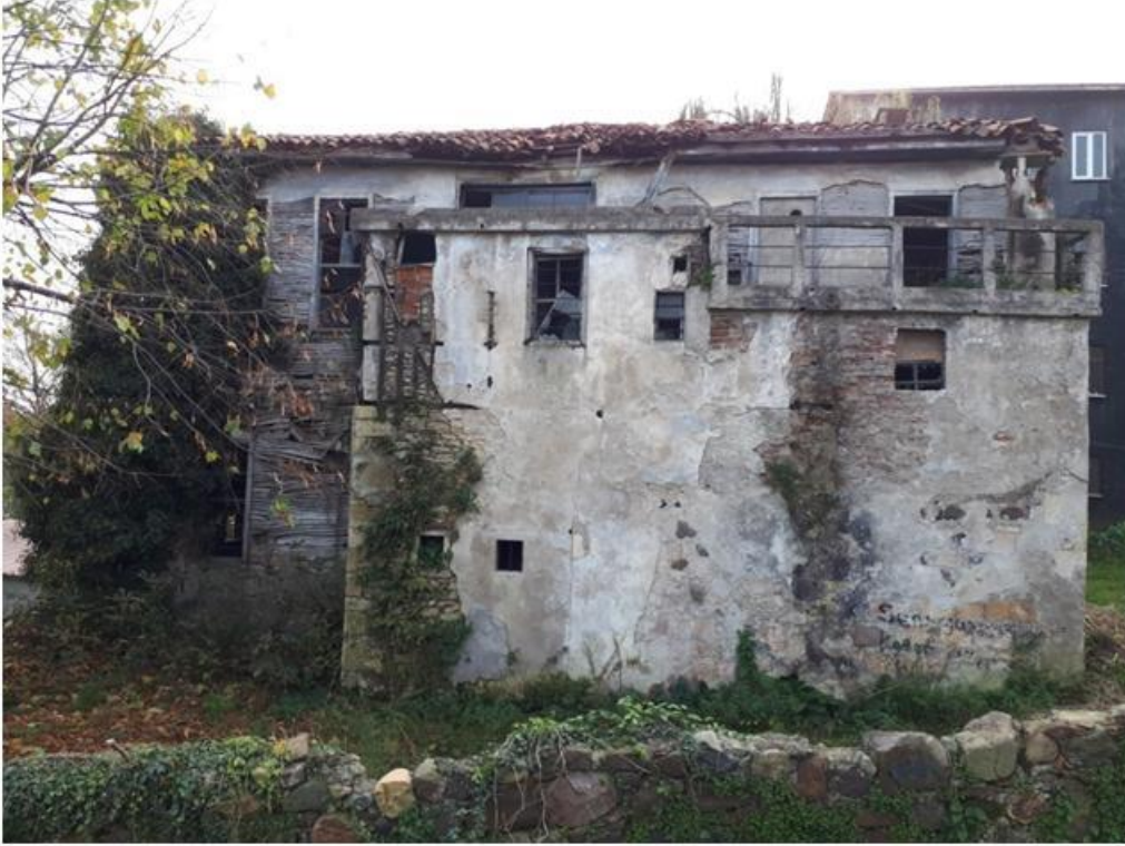
Görsel 288. Kuzey Cephe.
