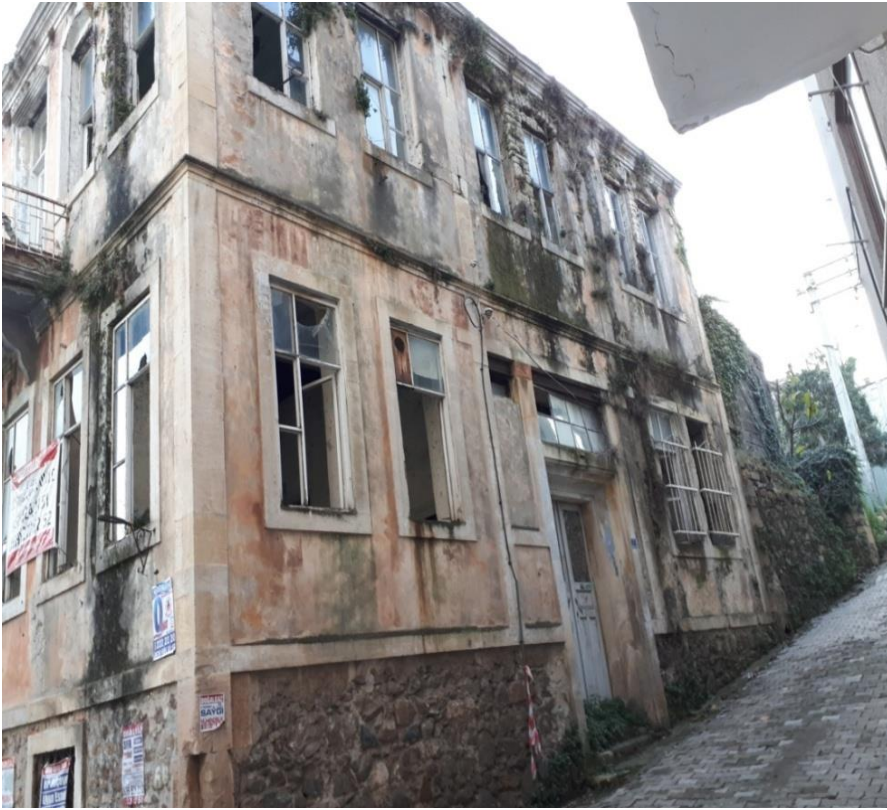
Görsel 58. Kuzey Cephe.
