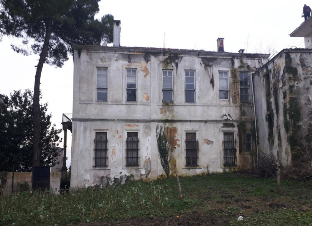
Görsel 260. Kuzey Cephe.
