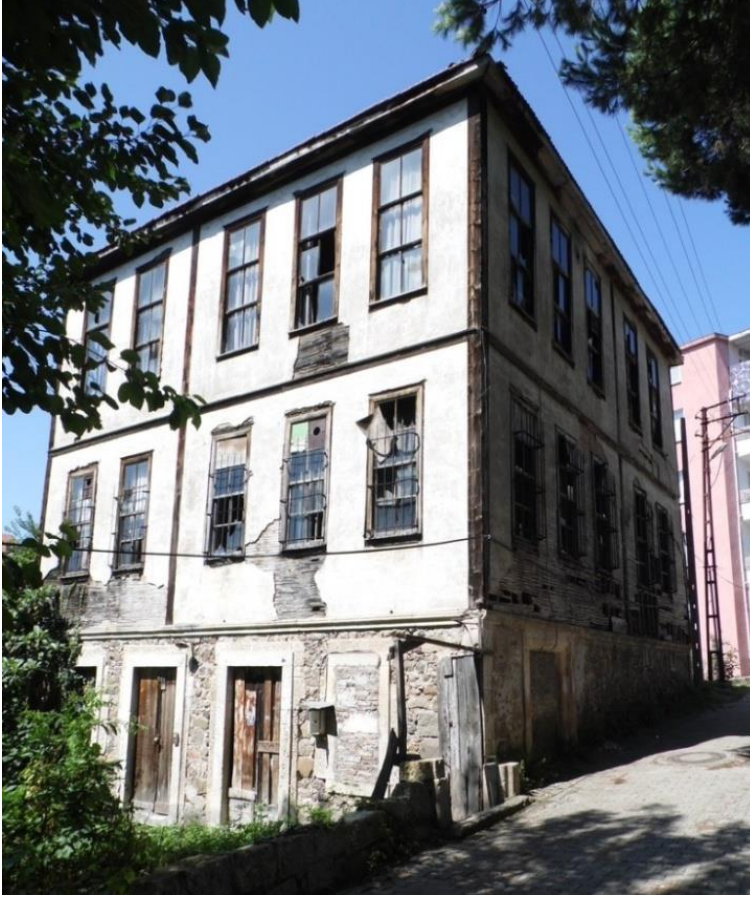
Görsel 215. Pelit Konutunun Kuzeydoğu Cephesi.
