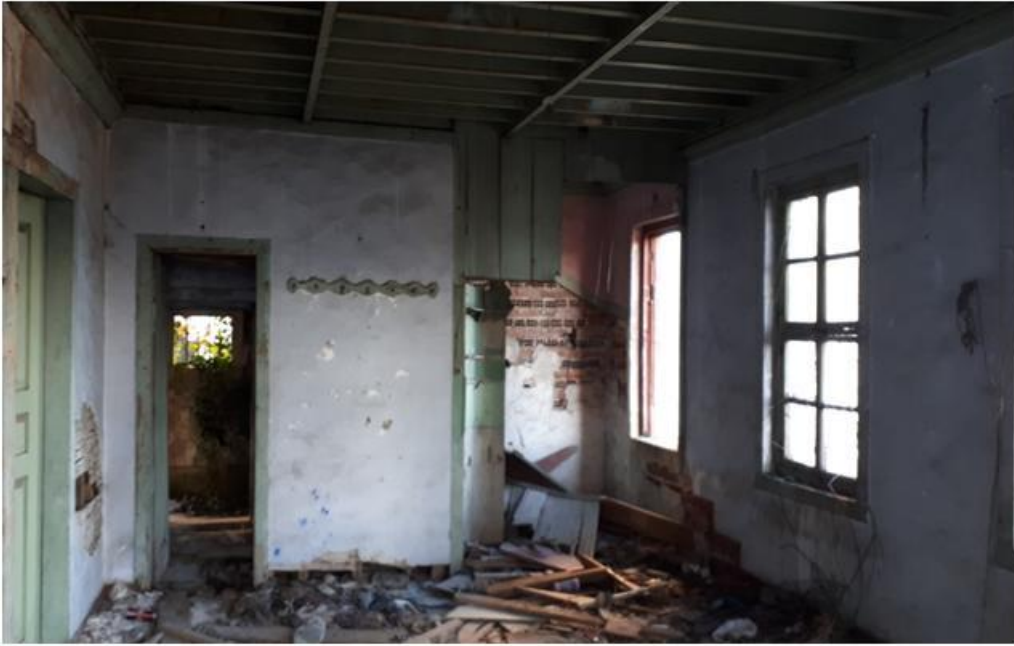
Görsel 378. Zemin Kat Sofası Kuzey Duvarı.
