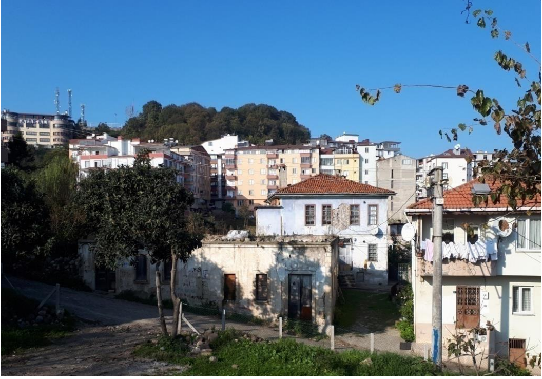
Görsel 193. Güney Cepheden Görünüm.
