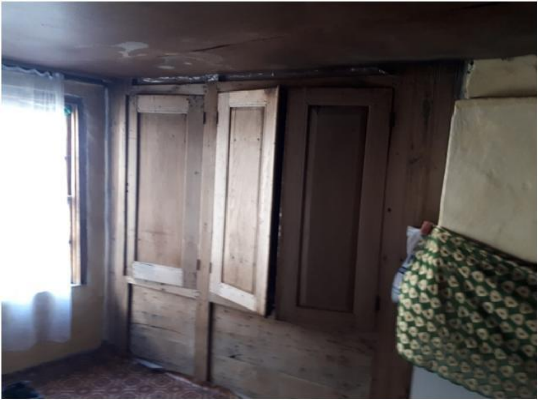
Görsel 46. Zemin Kat, Güneydoğu Oda.
