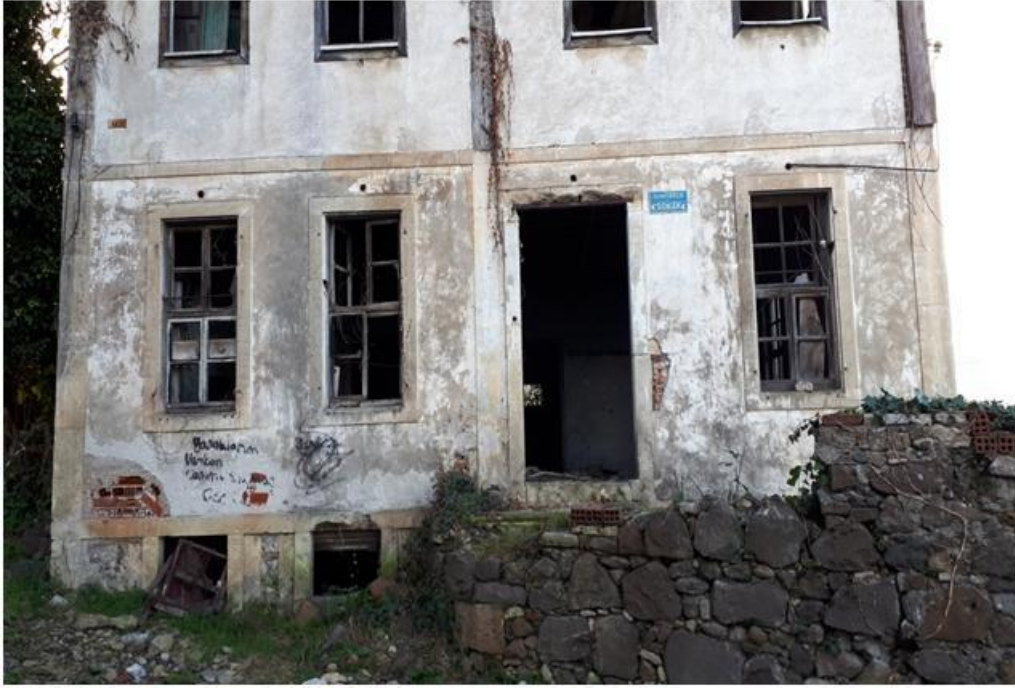
Görsel 367. Zemin Kat Güney Girişi.
