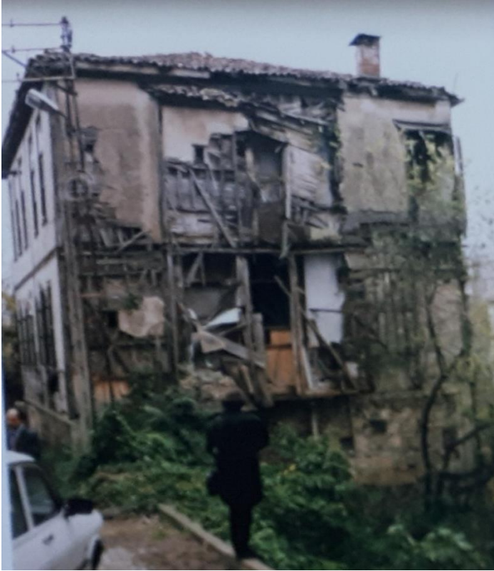
Görsel 218. Batı Cepheden Görünüm (S. K.V. K. K Arşivinden).
