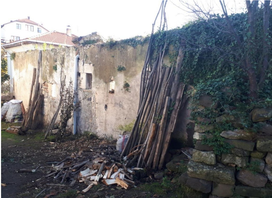
Görsel 162. Kuzey Cephe Zemin Kat.
