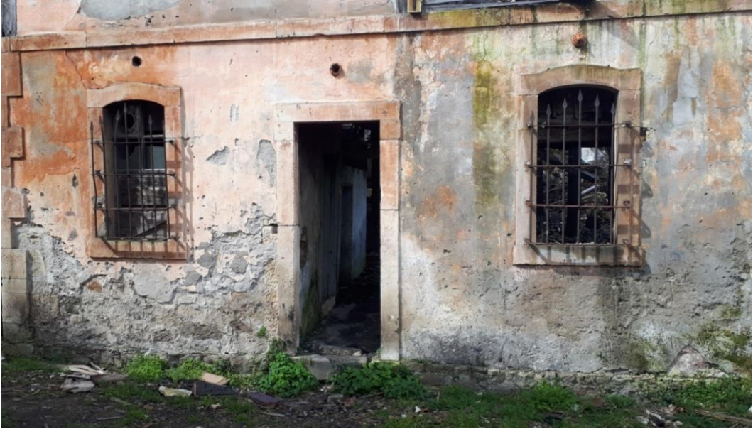
Görsel 110. Doğu Cephe Zemin Kat, Güney Bölüme Açılan Kapı Açıklığı.
