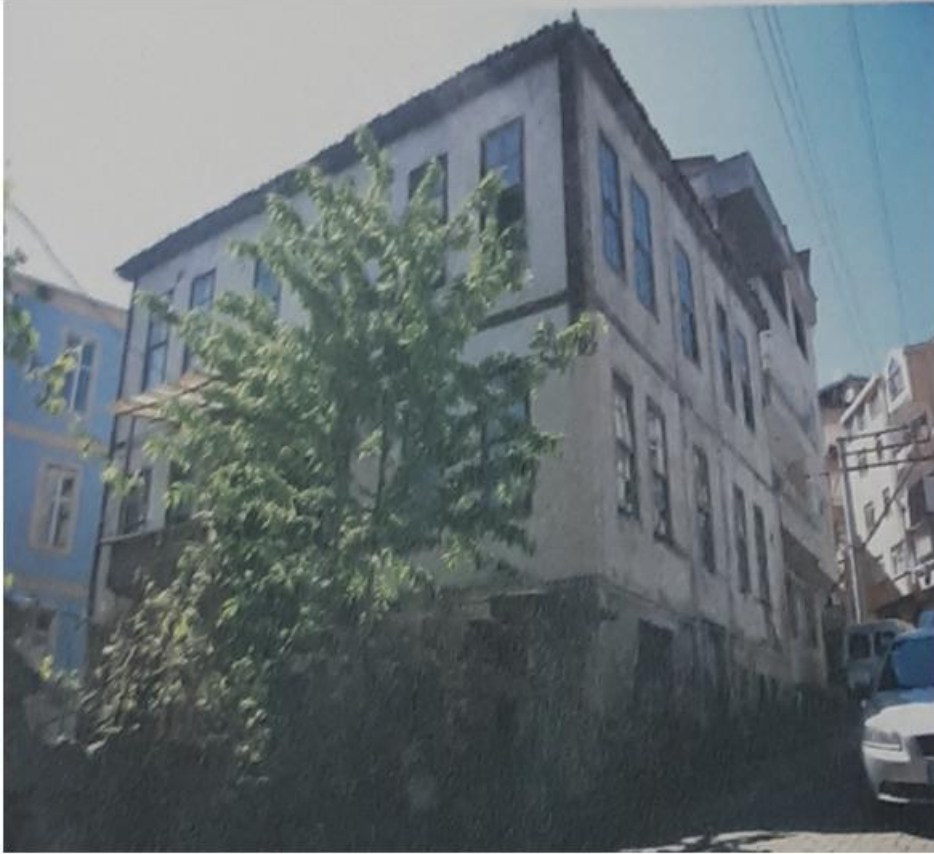
Görsel 182. Güneydoğu Cepheden Kuzeydoğu Cephe (Melike Ünlü'den).
