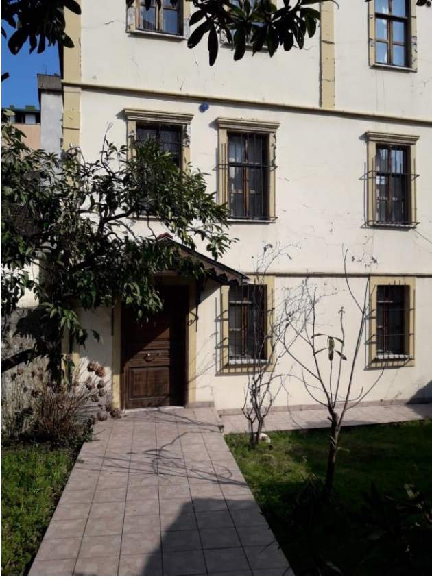
Görsel 173. Kuzey Cephe.
