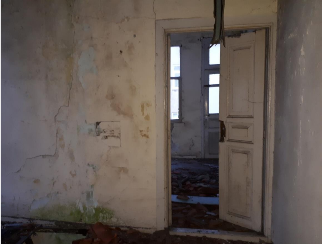
Görsel 87. Birinci Kat Merdiven Dairesinin Doğu Duvarı.
