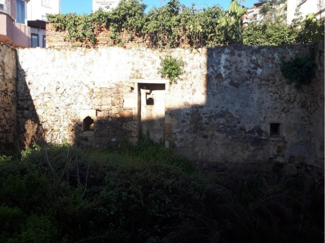
Görsel 130. Zemin Katın Kuzey Duvarı.
