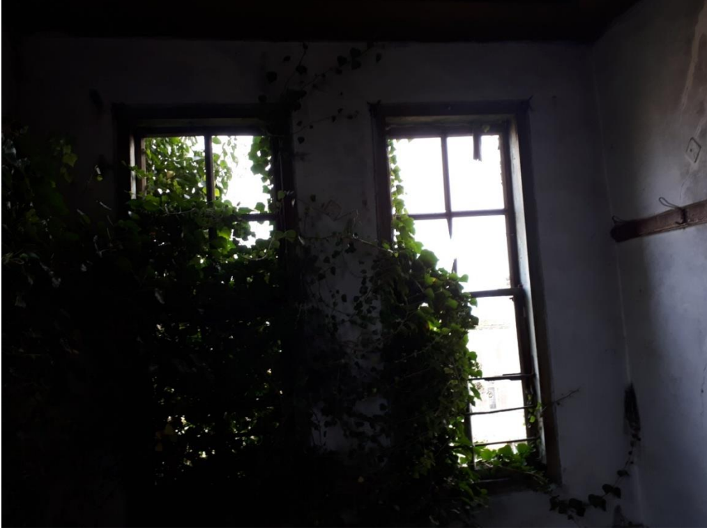
Görsel 303. Birinci Kat Kuzeydoğu Oda.
