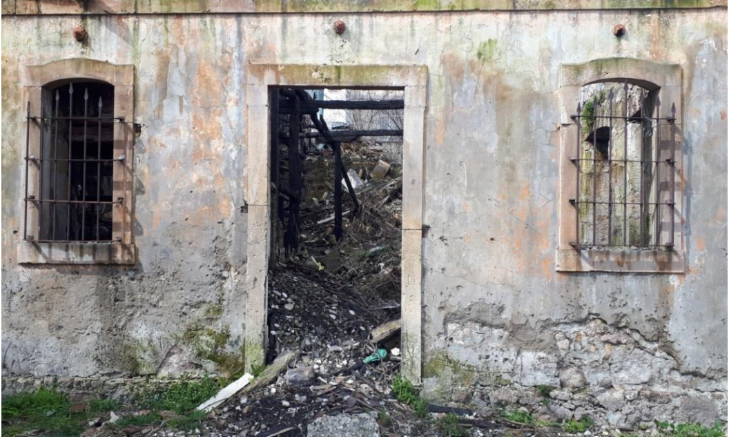
Görsel 111. Doğu Cephe Zemin Kat, Kuzey Bölüme Açılan Kapı Açıklığı.
