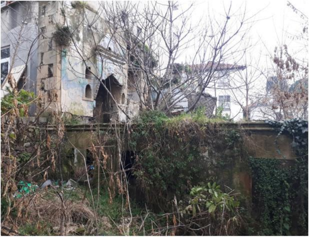
Görsel 184. Güneybatı Cephe Zemin Kat.
