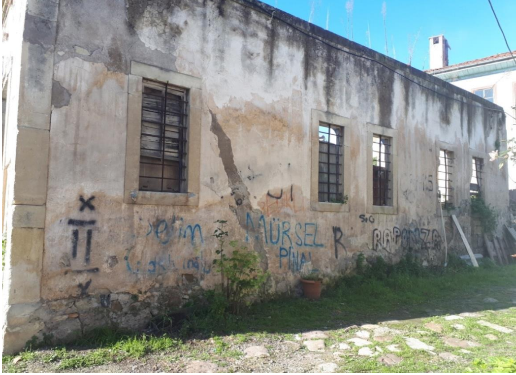
Görsel 161. Doğu Cephe Zemin Kat.
