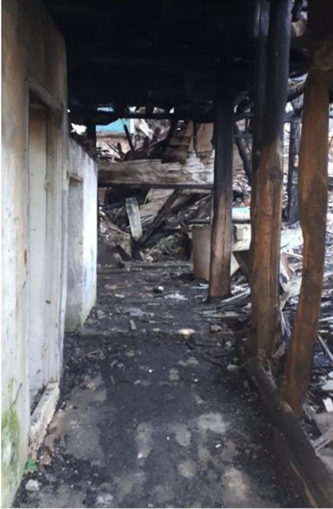
Görsel 112. Zemin Kat Güney Bölümdeki Koridor.
