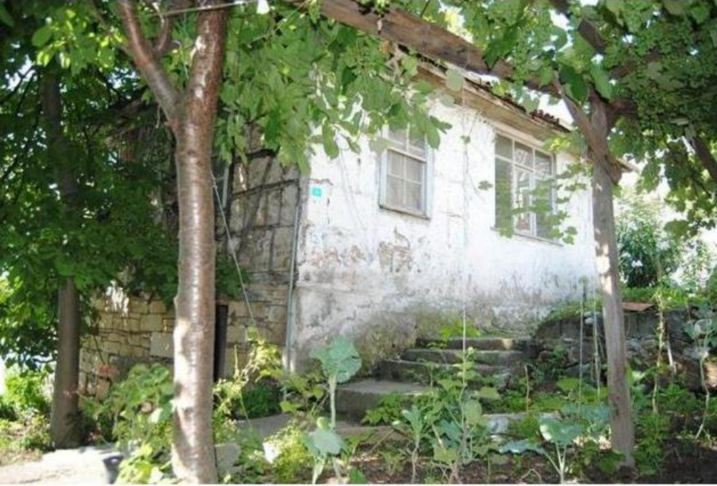
Görsel 352. Kuzeybatı Köşeden Görünüm ( http://keos.unye.bel.tr (11.11.2019)).
