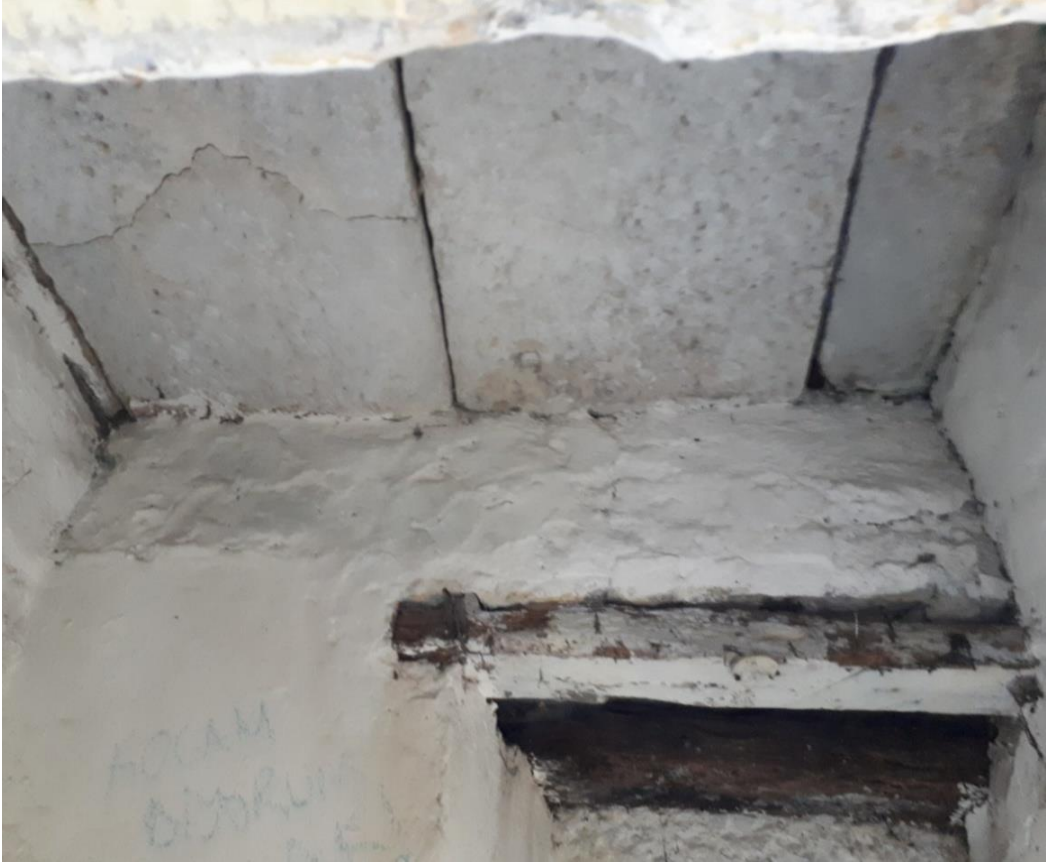
Görsel 78. Zemin Kat Batı Cephesi Giriş Holünün Tavanı.
