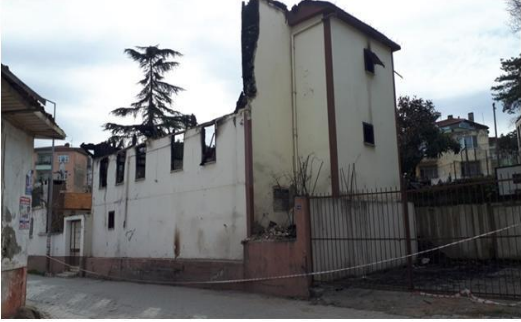
Görsel 133. Güney Konutu Yangından Sonra (11. 02. 2020).
