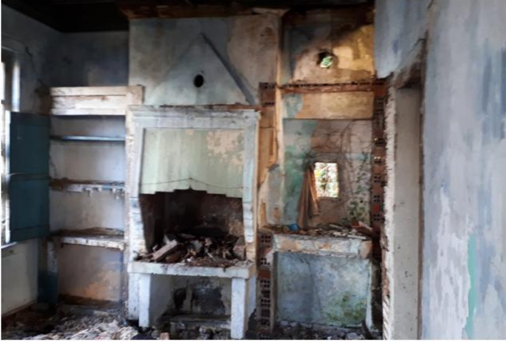
Görsel 375. Zemin Kat Güneybatı Köşe Odası.
