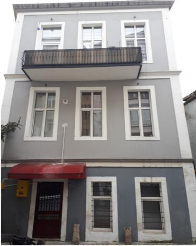
Görsel 244. Kuzey Cephe.
