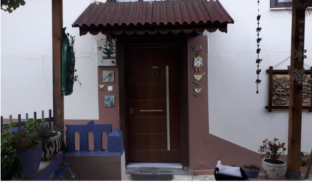
Görsel 138. Güney Cephe Zemin Kat Kapısı.
