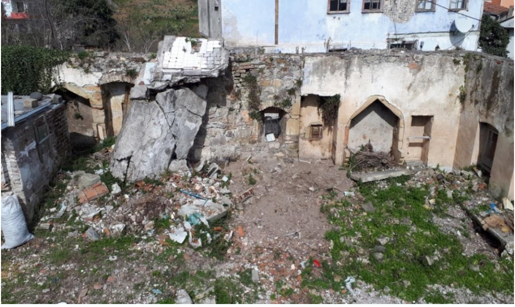
Görsel 167. Zemin Kat Kuzey Duvarı.
