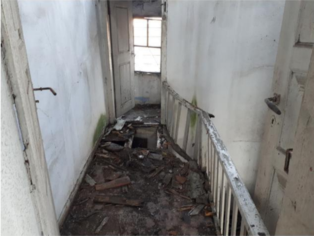
Görsel 306. Birinci Kat,Kuzeydeki Muhdes Bölüme Geçiş Holü.
