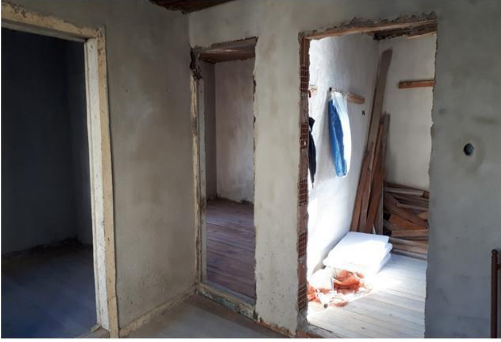
Görsel 361. Zemin Kat, Günümüzdeki Sofanın Güneybatı Duvarı.
