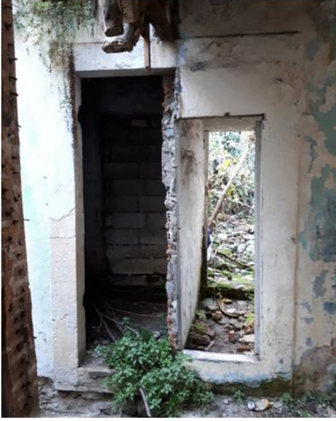
Görsel 63. Batı Cephesi İçten Zemin Kat Kapı Açıklığı.
