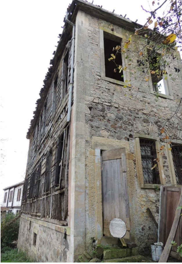
Görsel 251. Batı Cepheden Kuzey Cephe Görünüm (Melike Ünlü'den-2012).
