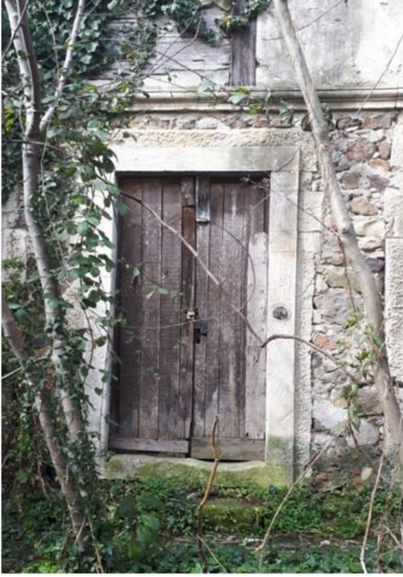
Görsel 221. Zemin Kat, Güney Bölüm Giriş Kapısı.
