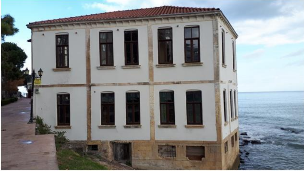
Görsel 431. Doğu Cephe Görünüm.
