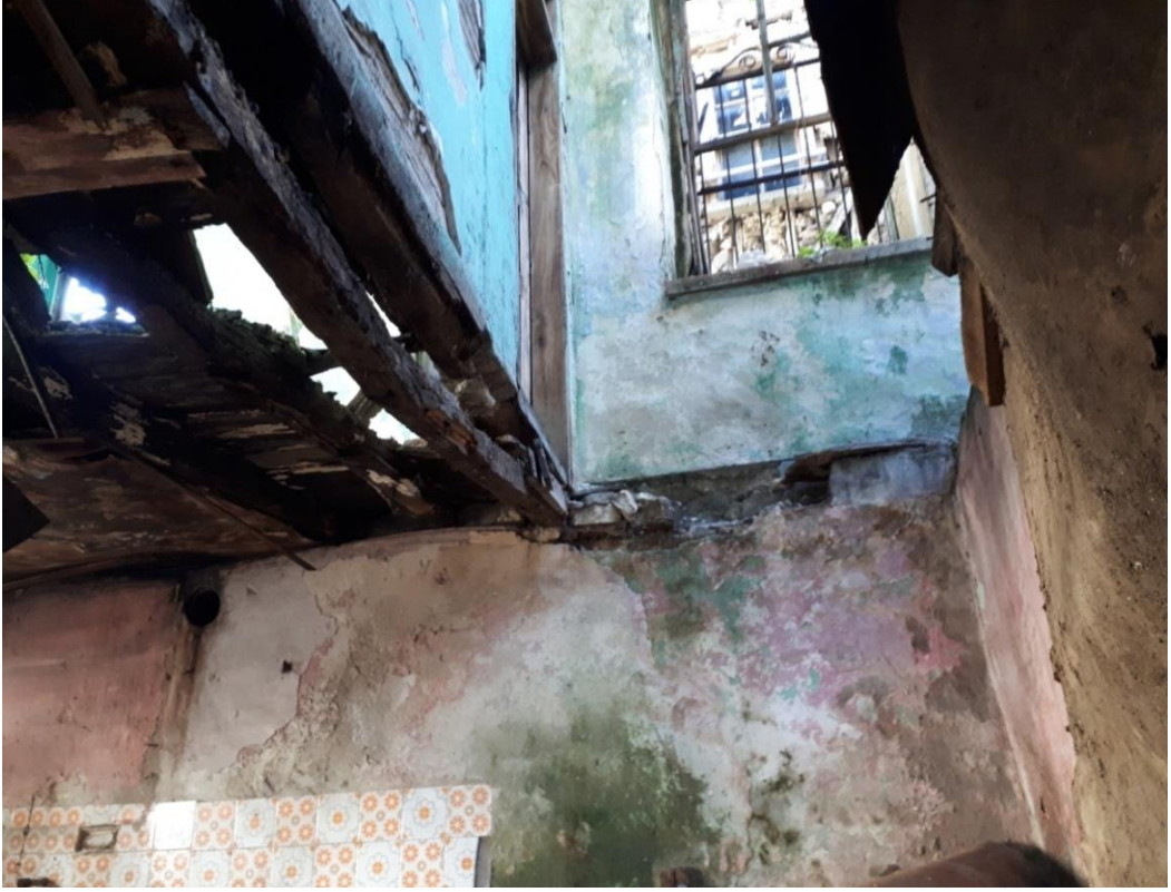
Görsel 81. Bodrum Kattan Zemin Kata Çıkan Merdiven Boşluğu.
