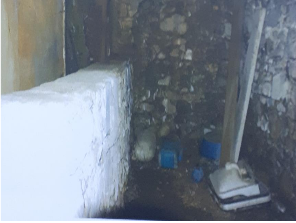
Görsel 333. Zemin Kat Batı Kısım (S. K.V. K. B. K Arşivinden).
