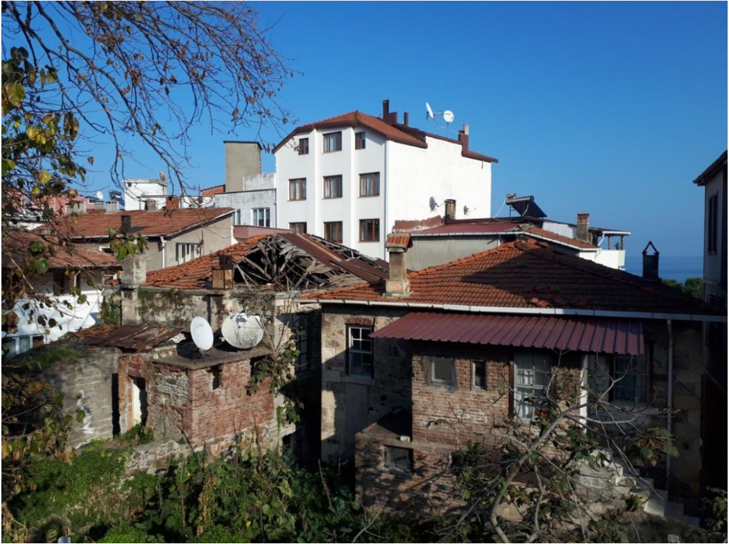
Görsel 56. Batı Cepheden Çatının Görünümü.
