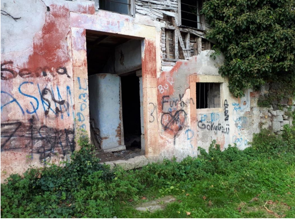
Görsel 291. Doğu Cephe, Bodrum Kat Giriş Kapısı.
