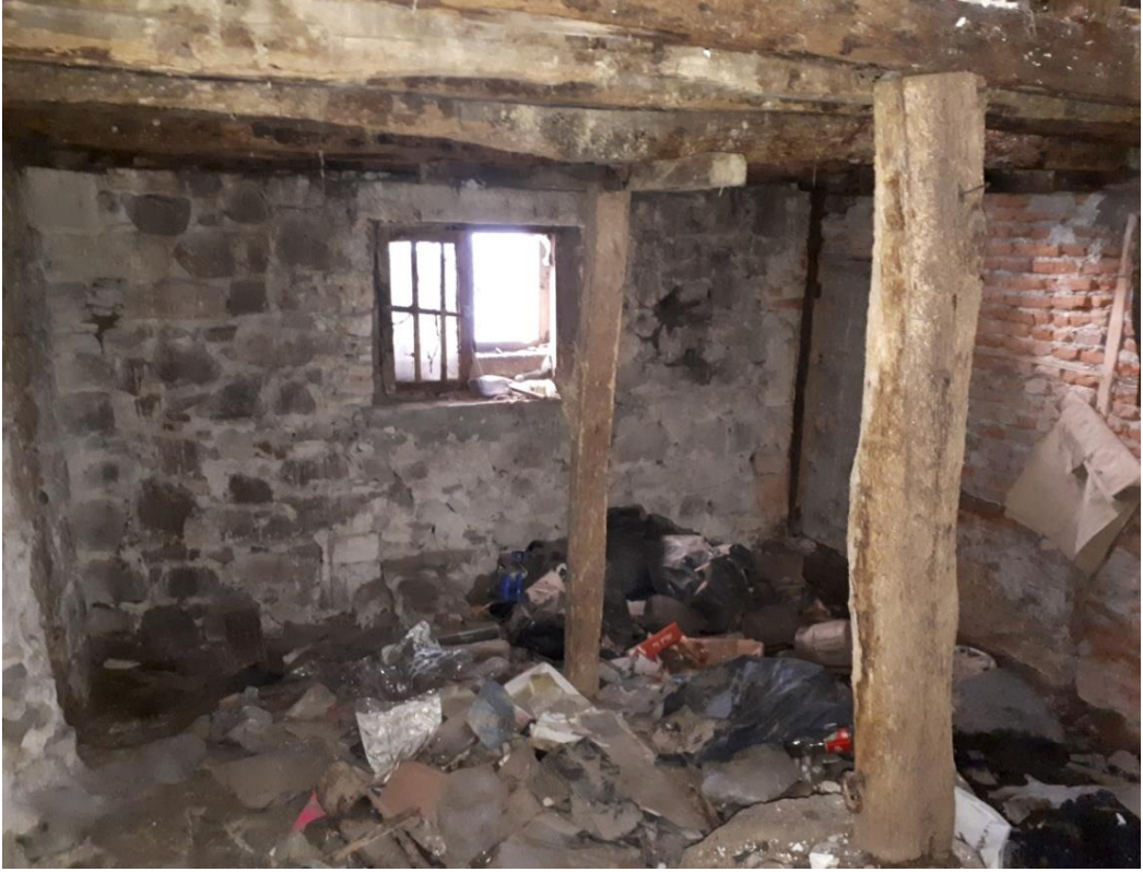
Görsel 71. Bodrum Kat Kuzeydoğu Köşe.
