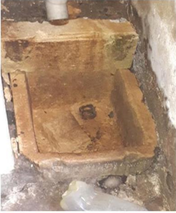
Görsel 273. Çamaşırhanenin Kuzey Duvarındaki Evye.
