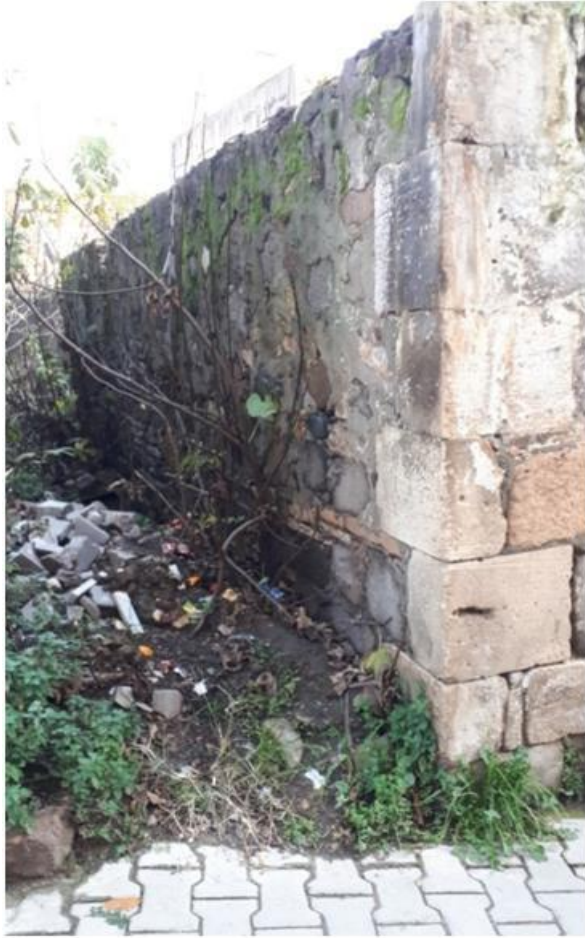
Görsel 122. Kuzey Cephe Zemin Kat.
