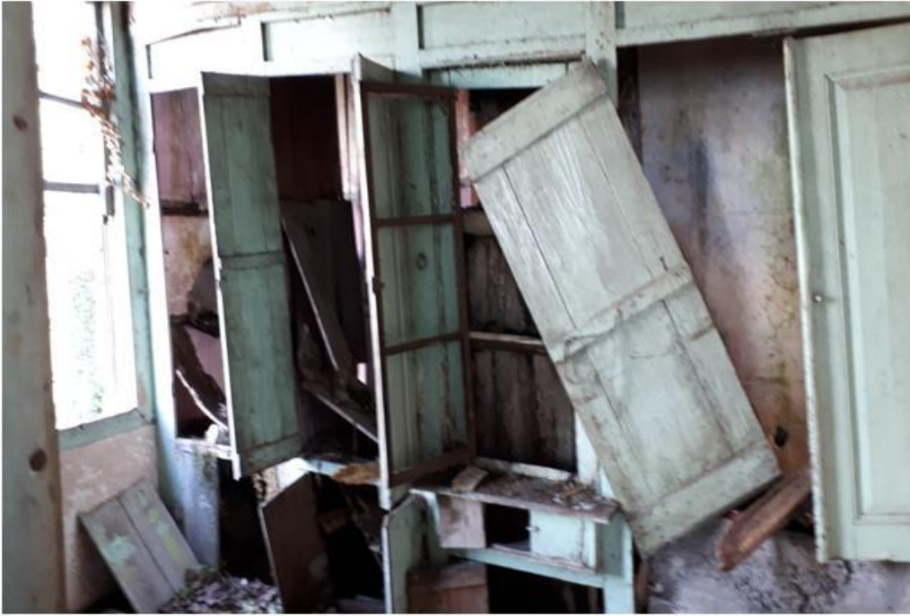
Görsel 384. Birinci Kat Güneybatı Köşe Odasının Kuzey Duvarı.
