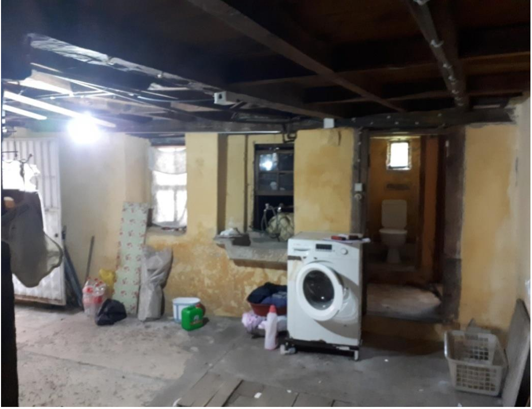
Görsel 43. Zemin Kat Sofası Batı Duvarı.
