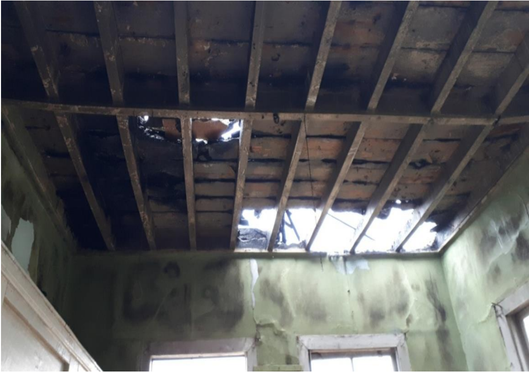
Görsel 118. Birinci Kat Güneydoğu Köşe Odası.
