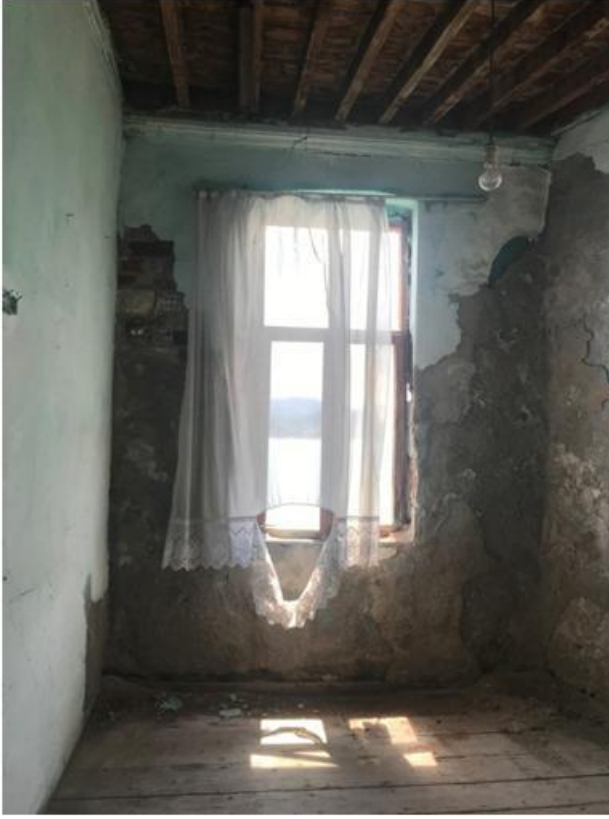
Görsel 453. Zemin Kat Güney Doğu Köşedeki Oda (Melike Ünlü 'den).
