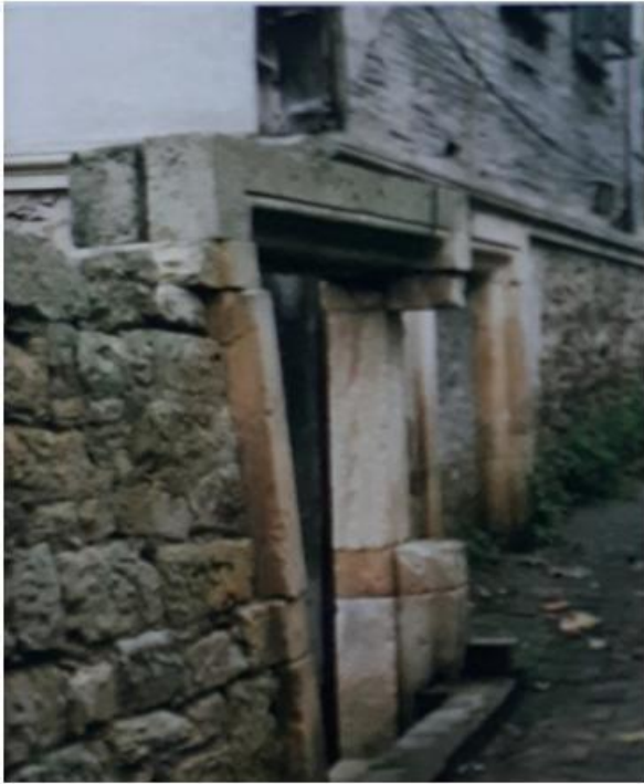
Görsel 220. Bahçe Kapısı (S. K.V. K. K Arşivinden).
