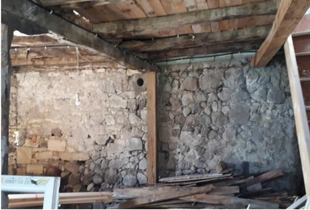
Görsel 356. Bodrum Kat Doğu Duvarı.
