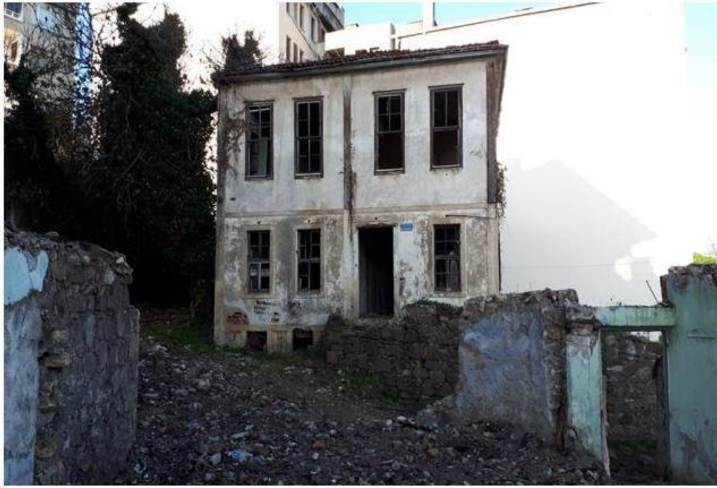
Görsel 362. Tobay Konutunun Güney Cephesi.
