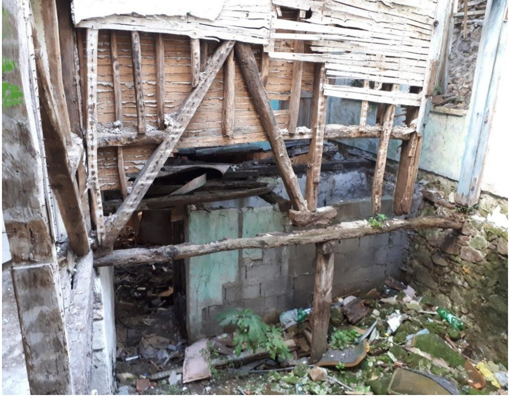
Görsel 68. Bodrum Kat Güneybatı Köşedeki Oda.
