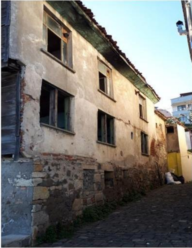
Görsel 416. Kuzey Cephe.
