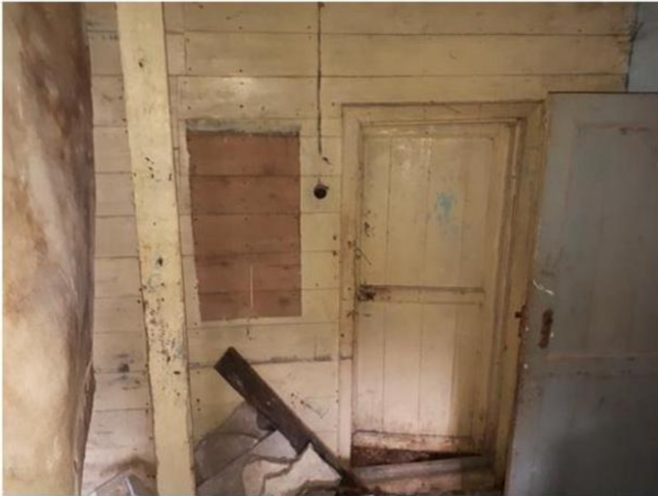
Görsel 296. Zemin Kat Mutfak Kuzey Duvarındaki Banyo Girişi.
