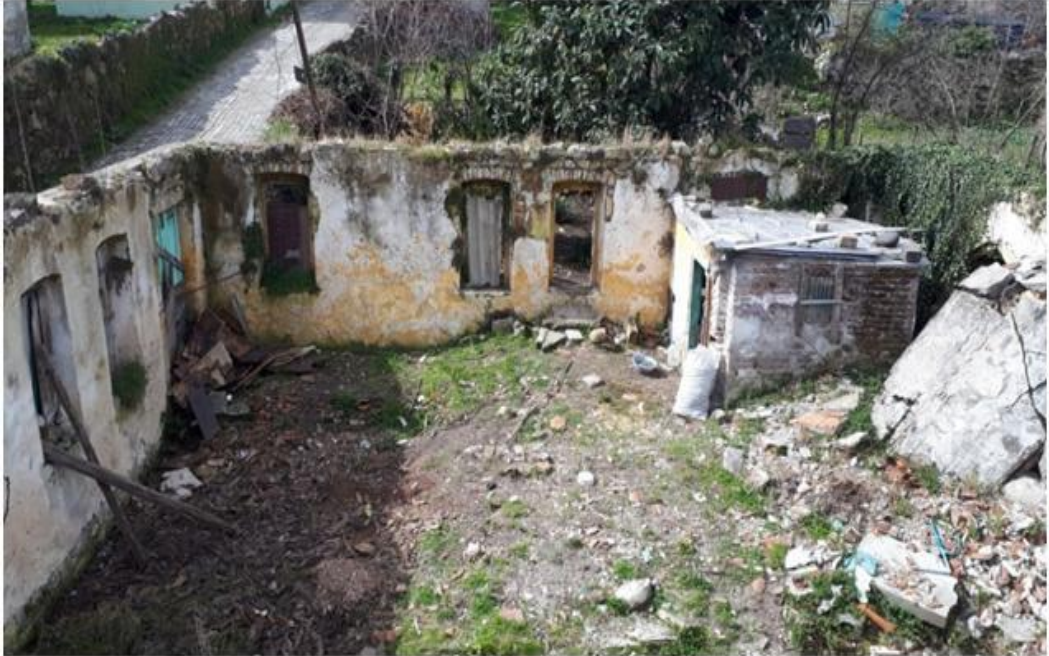
Görsel 166. Zemin Kat Batı Duvarı.
