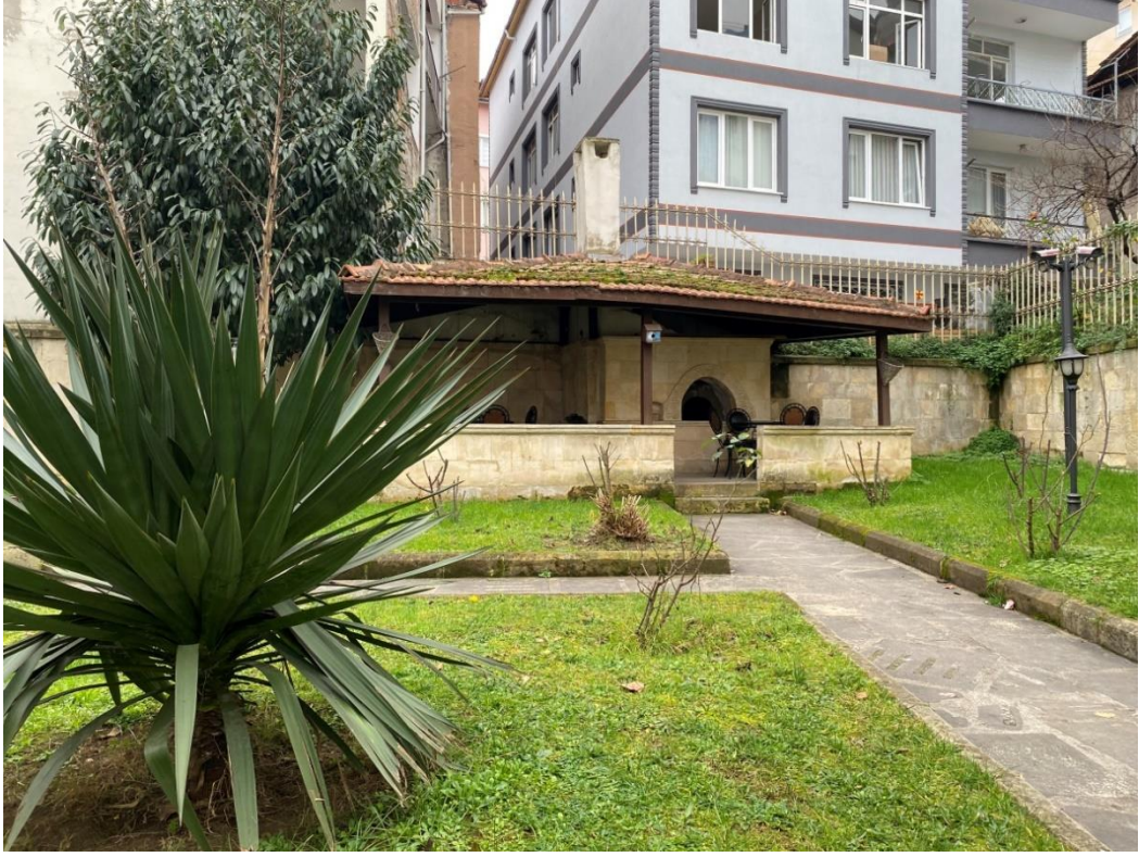
Görsel 51. Paşaoğlu Konağı Bahçede Bulunan Ahşap Çatılı Kiremit Kaplı Fırın (Sibel Güngör)
