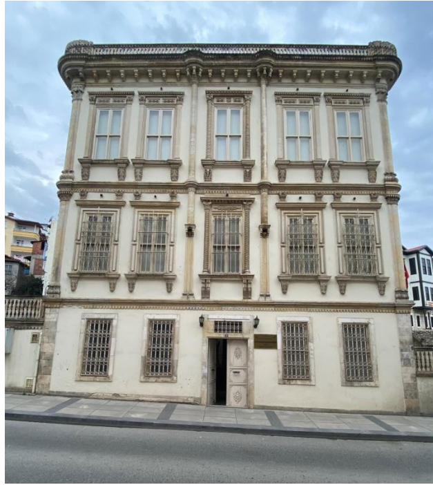
Görsel 38. Paşaoğlu Konağı Doğu Cephesi (Sibel Güngör)
