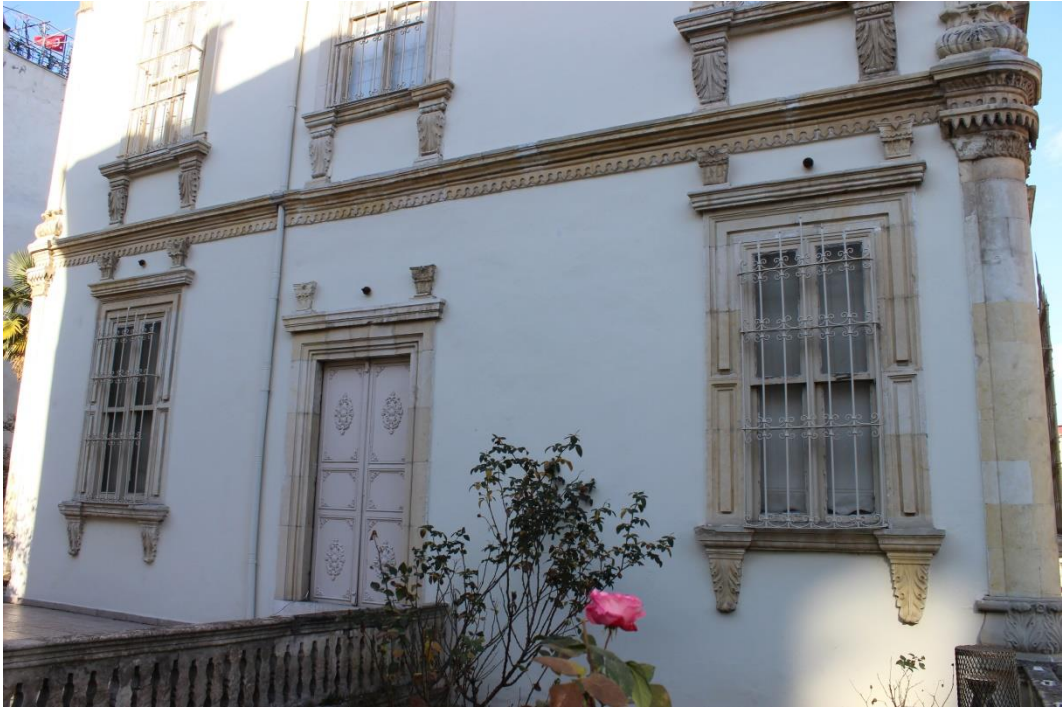
Görsel 35. Paşaoğlu Konağı Güney Cephe Pencereleri (Sibel Güngör)
