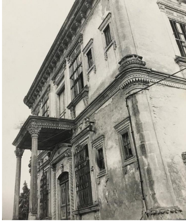
Görsel 26.Paşaoğlu Konağı Kuzey Cephesi Eski Görüntüsü (Güven Bayar, 1.02.2022)
