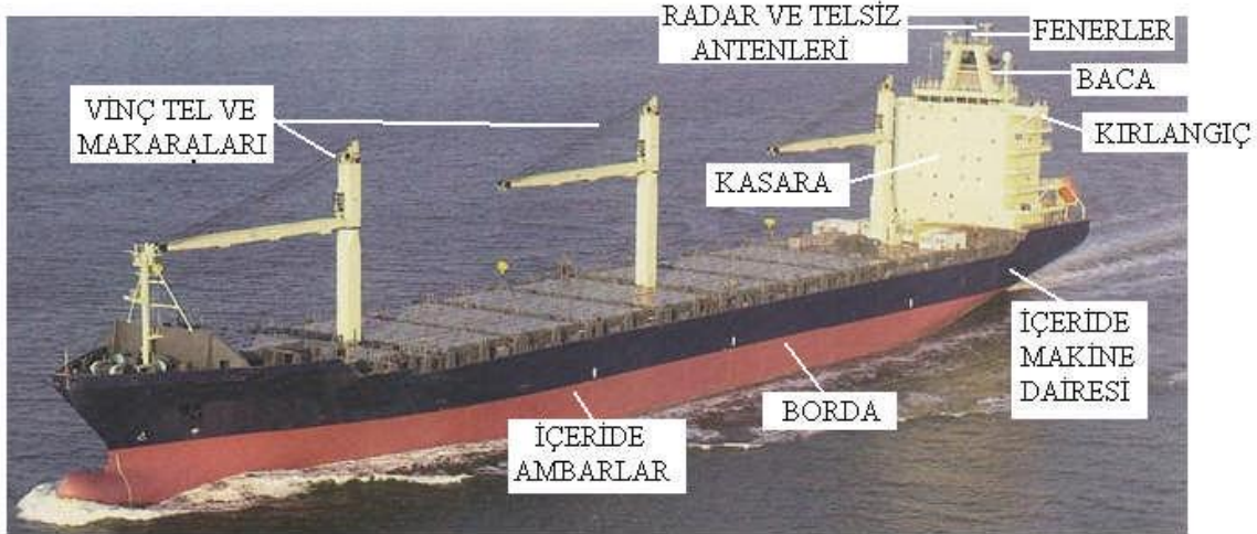
Resim 3:-Yüksekte çalışma yapılan yerler
