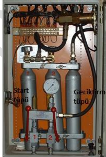
Resim 2.9: Sabit söndürme sisteminde start ve geciktirme tüpü
