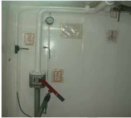
Resim 27.11: Sabit söndürme sisteminde ambar ve boyalığa giden valf
