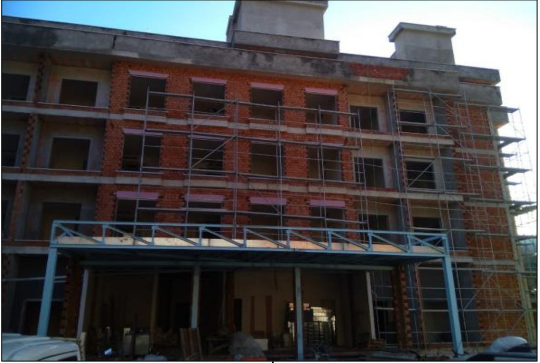
Şekil 4.2.a Sarmaşık Kaplıca Termal Otel İnşaatı
