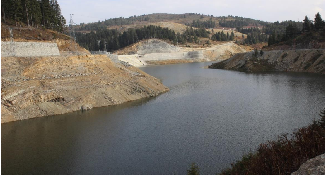
Şekil 3.3 Darıca 2 HES Çambaşı Barajı.
