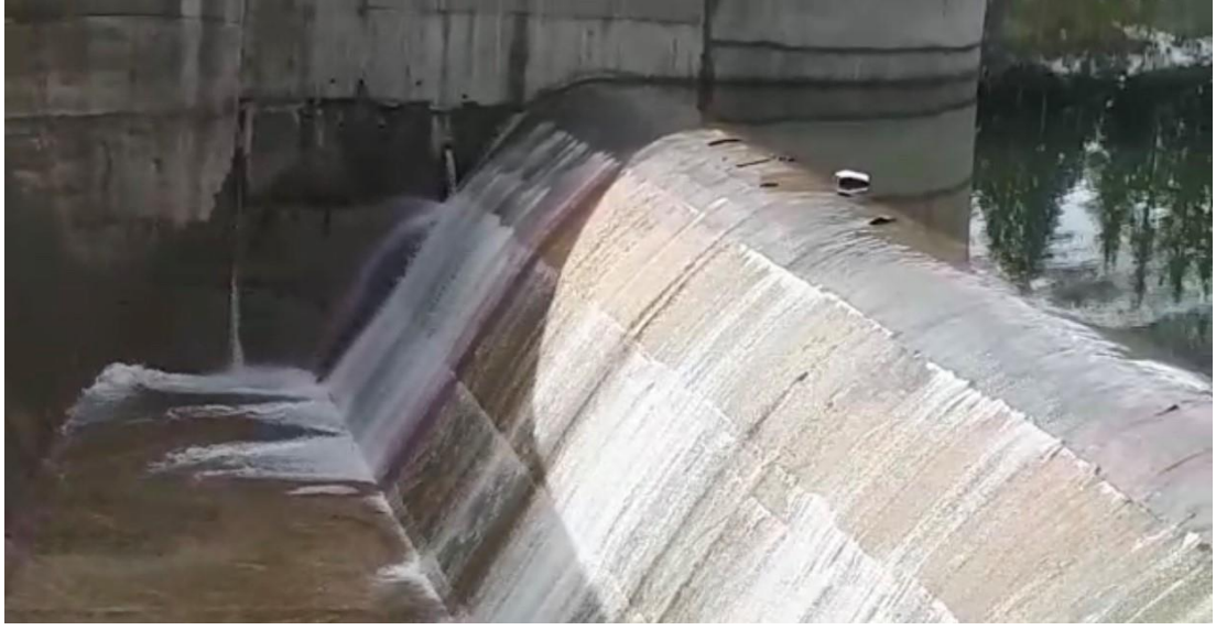
Şekil 2.3 Baraj dolusavağında atılan su.
