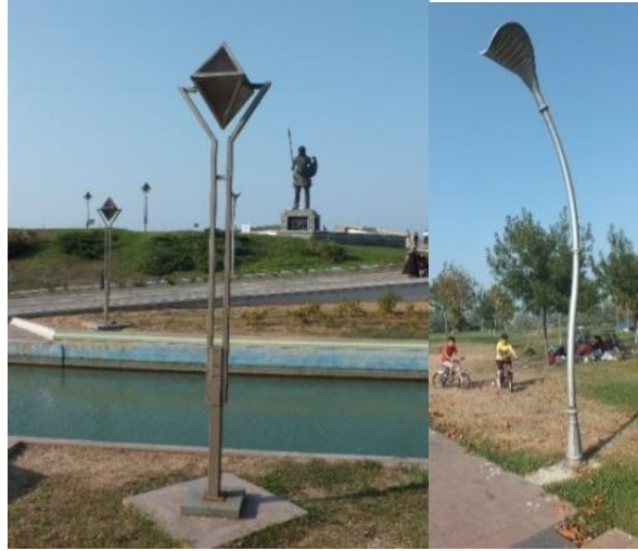
Şekil 4.9 Park İçerisinde Kullanılan Tasarım Aydınlatma Elemanları
