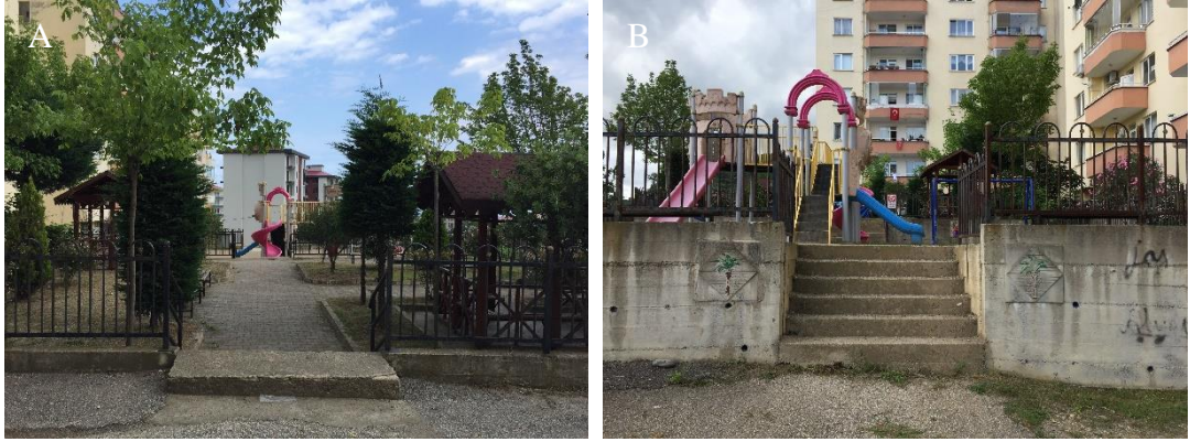
Şekil 4.68. Parkın kuzey ve güney girişleri (A: Güney giriş; B: Kuzey giriş)
