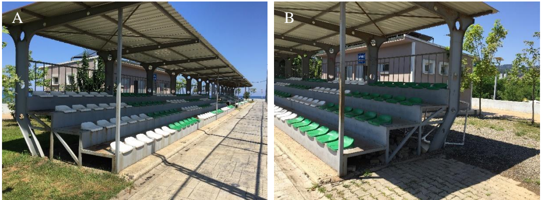
Şekil 4.60. Büyük futbol sahası tribünü (A: ; B: )
