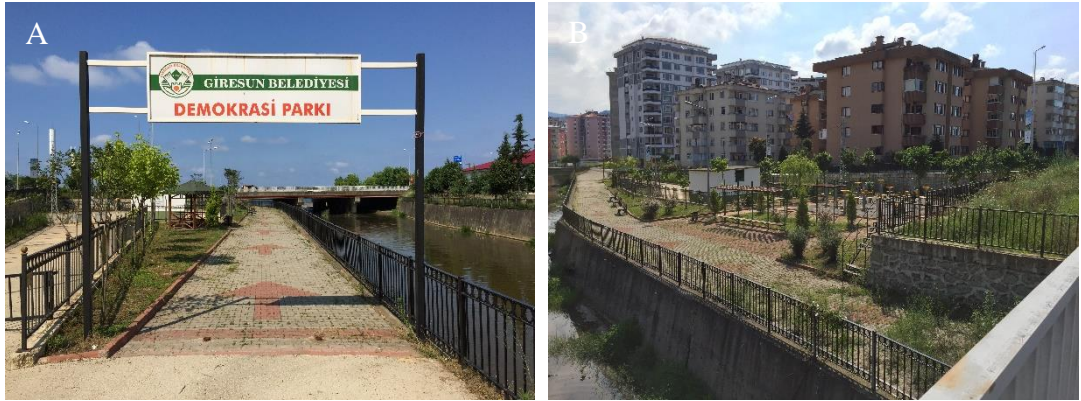
Şekil 4.22. Parkın güney girişi ve kuzeyden görünüm (A: Güney giriş; B: Kuzey görünüm)
