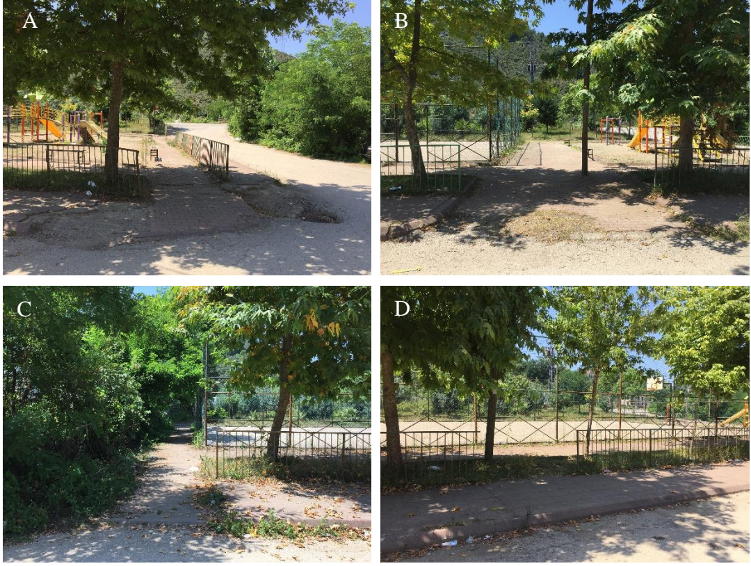
Şekil 4.75. Parkın giriş noktaları ve hasar verilen ferforje (A, B, C: Doğu giriş; D: Hasarlı ferforje)
