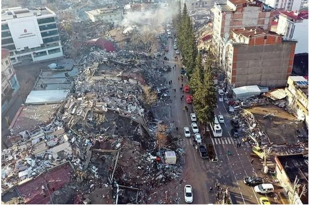
Şekil 3.14 06.02.2023 Kahramanmaraş Depremi'nde hasar gören veya yıkılan yapılardan bazıları (Anonim, 2023)
