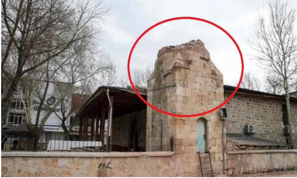
Şekil 4.13 06.02.2023 M_w 7.7 Kahramanmaraş Depremi'nde yıkılan Elbistan'daki tarihi Atik Camisi'nin minaresi (Soyluk ve Demircan, 2023)
