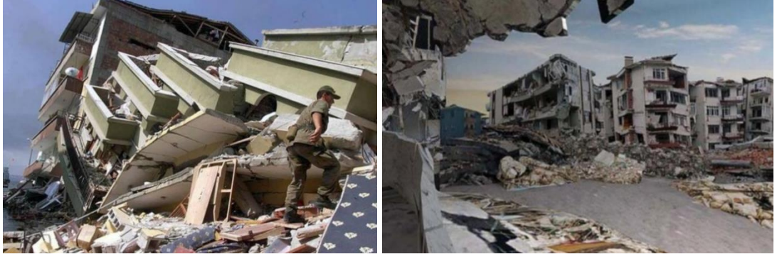
Şekil 3.9 12.11.1999 Mw 7.2 Düzce (Kaynaşlı) Depremi'nde hasar gören veya yıkılan yapılardan bazıları (Cebeci, 2022)
