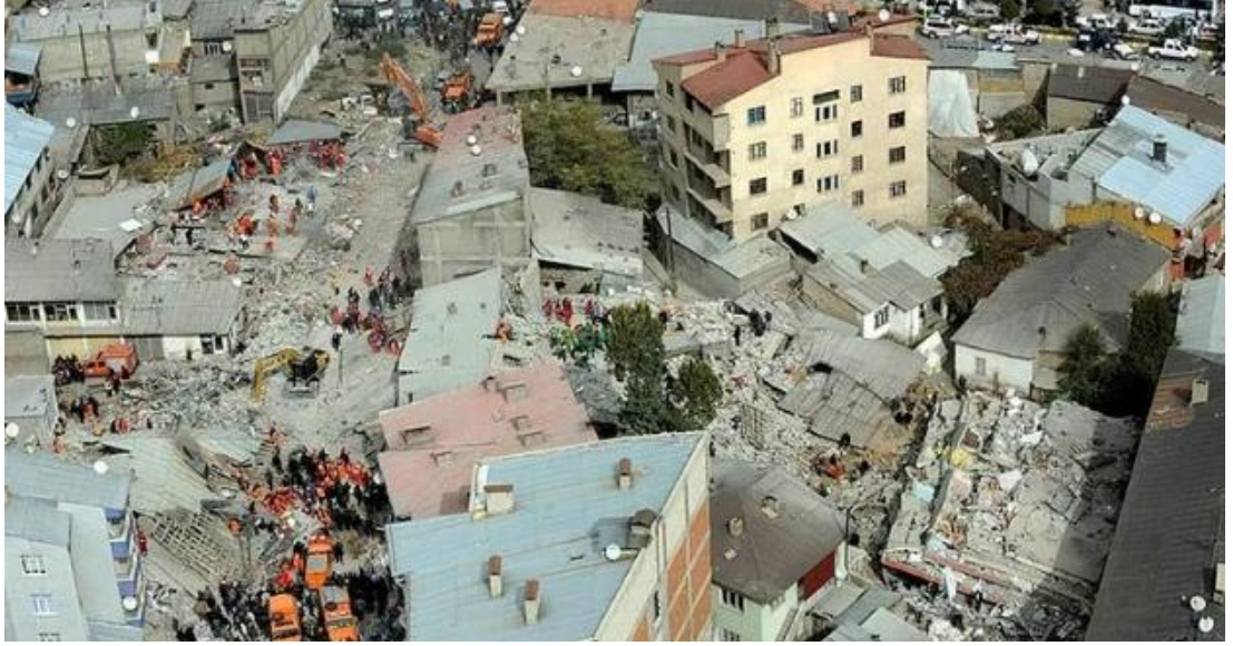
Şekil 3.11 23.10.2011 Van-Erciř Depremi'nde hasar gören veya yıkılan yapılardan bazıları (Anonim, 2020)
