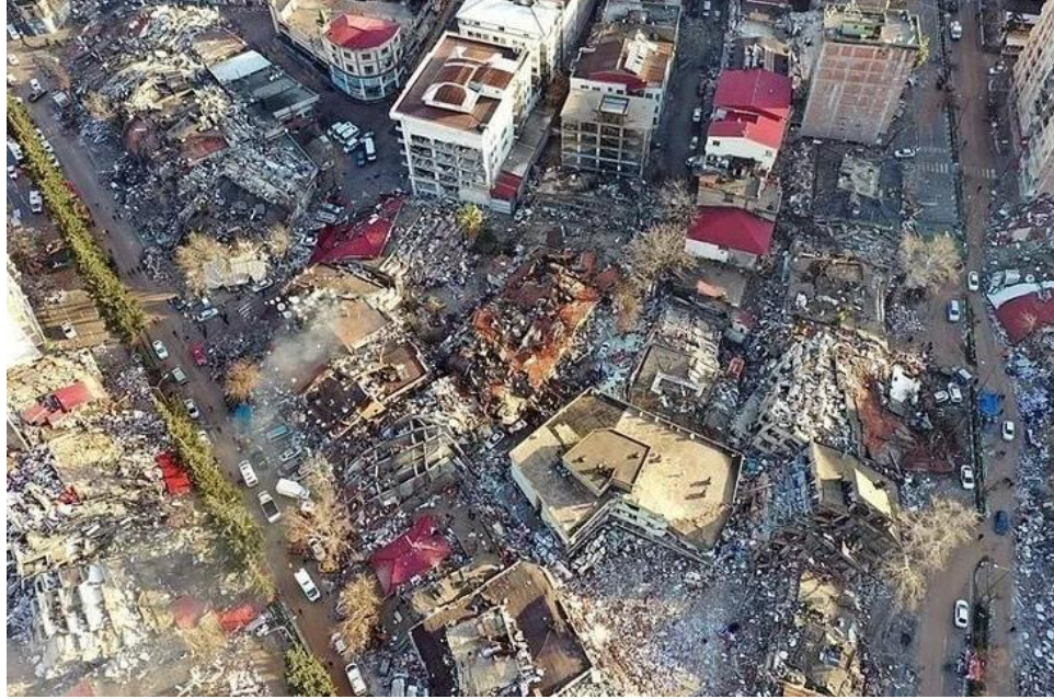
Şekil 3.13 06.02.2023 Kahramanmaraş Depremi'nde hasar gören veya yıkılan yapılardan bazıları (Anonim, 2023)
