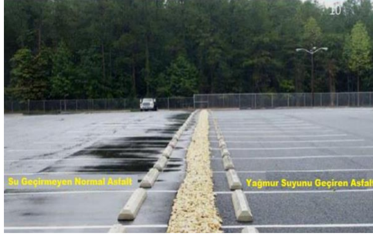
Şekil 2. 4 Geçirgen Asfalt Uygulanmayan ve Uygulanan Alan (Öztürk, 2020)
