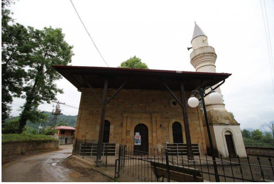
Görsel 56: Bulancak Ahmetli Köyü Cami Giriş Kapısı Görünüm
