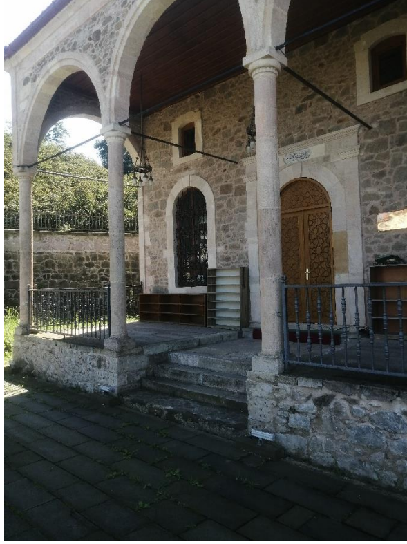
Görsel 42: Bulancak Şemsettin Köyü Cami Kuzey Cephe Görünüm
