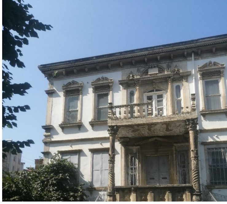
Görsel 110: Piraziz Tiralizade Hasan Bey Konađı Güney Cephe Birinci Katı Görünüm
