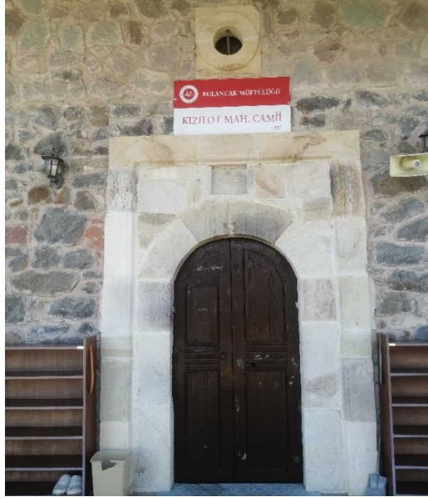
Görsel 27: Bulancak Kızılot Köyü Cami Kuzey Cephe Giriş Kapısı Görünüm
