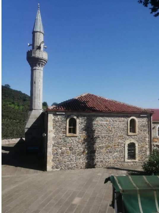
Görsel 30: Bulancak Kızılot Köyü Cami Güney Cephe Görünüm
