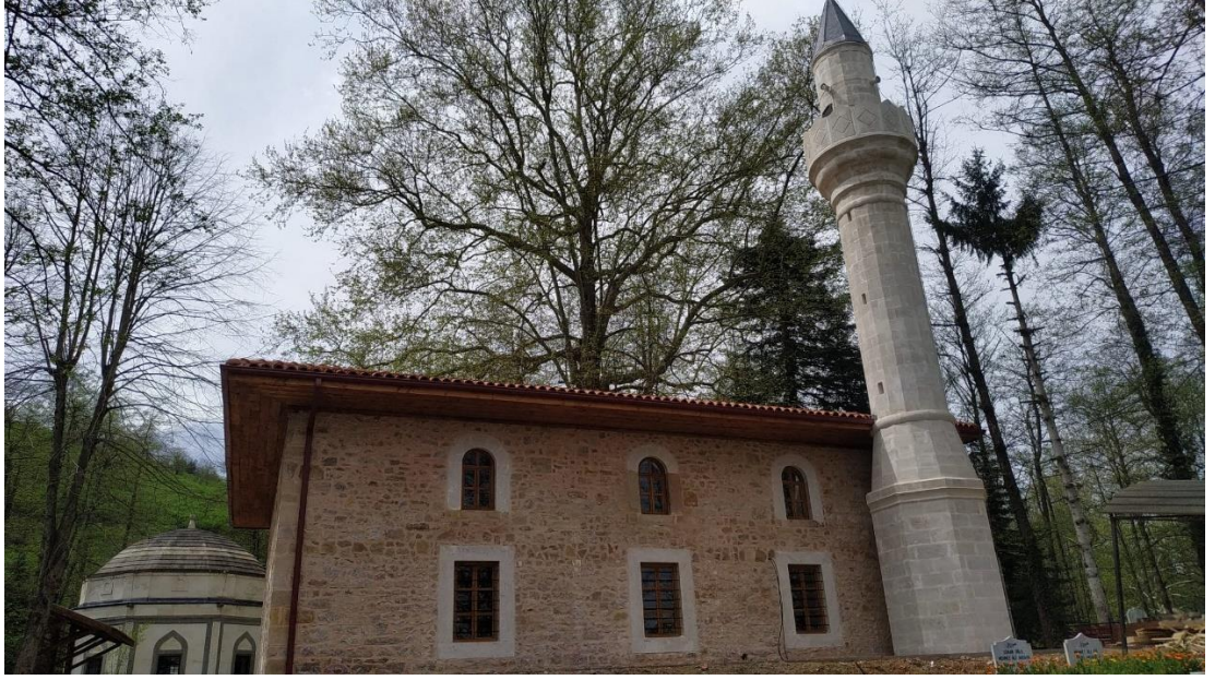
Görsel 98: Piraziz Şeyh İdris Cami Batı Cephe Görünüm
