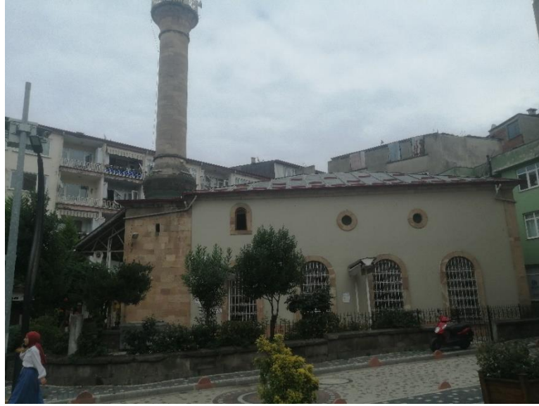
Görsel 8: Bulancak Eski Cami Güney Cephesi Genel Görünüm
