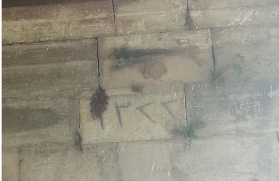
Görsel 81: Piraziz Gedikalizade Maden Cami Kuzey Cephe Minare Duvarının Üst Köşesindeki Yapım Tarihi Görünüm
