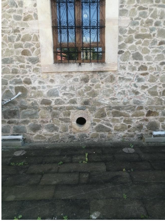
Görsel 46: Bulancak Şemsettin Köyü Cami Batı Cephe Bodrum Kat Pencere Düzeni Görünüm
