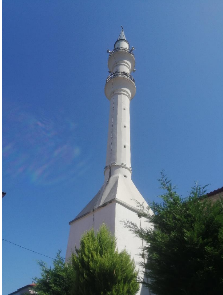
Görsel 53: Bulancak Şemsettin Köyü Cami Minare Görünüm
