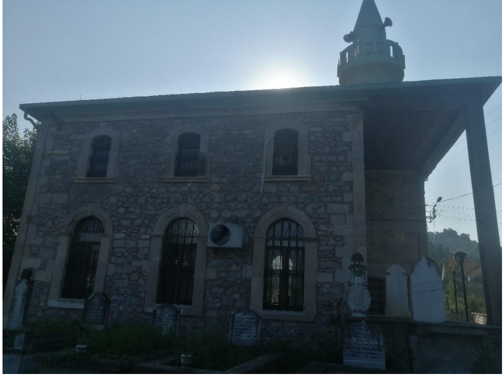
Görsel 82: Piraziz Gedikalizade Maden Cami Doğu Cephe Görünüm
