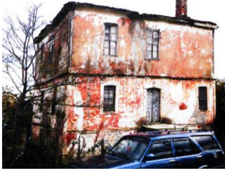
Görsel 132: Piraziz Tiralizade Emin Bey Konağı Güney Cephe Görünüm (İltar,2014:250)
