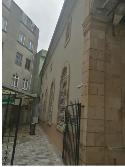
Görsel 7: Bulancak Eski Cami Doğu Cephesi Genel Görünüm
