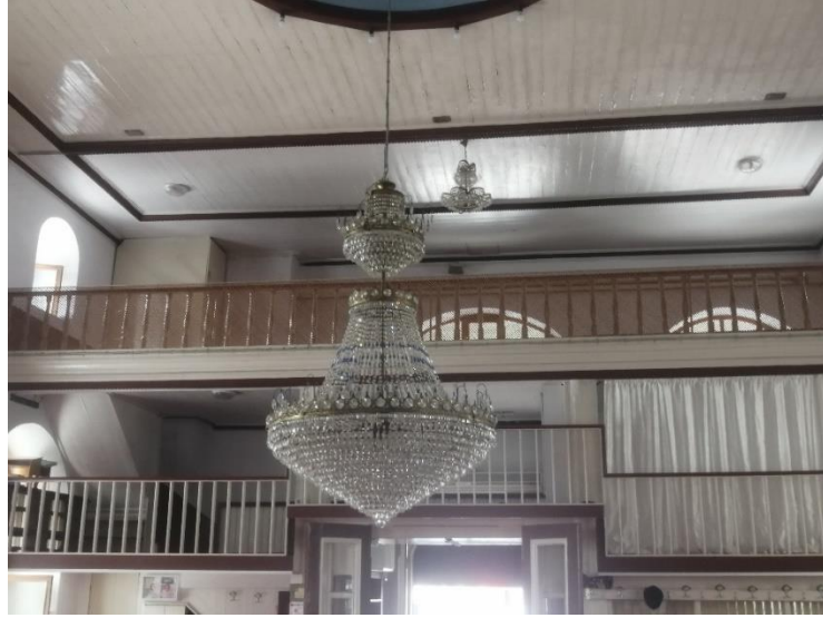
Görsel 9: Bulancak Eski Cami Mahfil Görünüm
