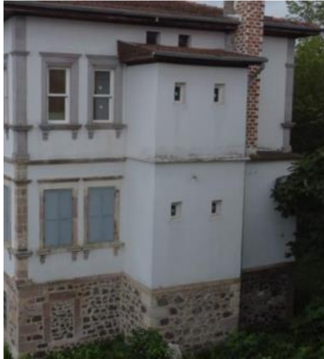
Görsele 117: Piraziz Tiralizade Hüseyin Bey Konağı'nın Batı Cephe Görünümü (Bayhan,2021:547)
