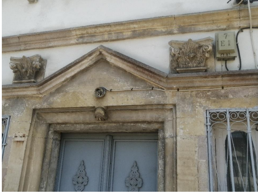
Görsel 115: Piraziz Tiralizade Hasan Bey Konağı Kuzey Cephe Birinci Arka Giriş Demir Kapısı Üzeri Süsleme Detayından Görünüm
