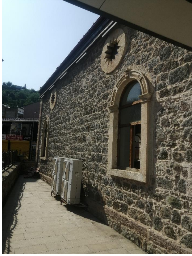
Görsel 70: Piraziz Eren Cami Güney Cephe Görünüm
