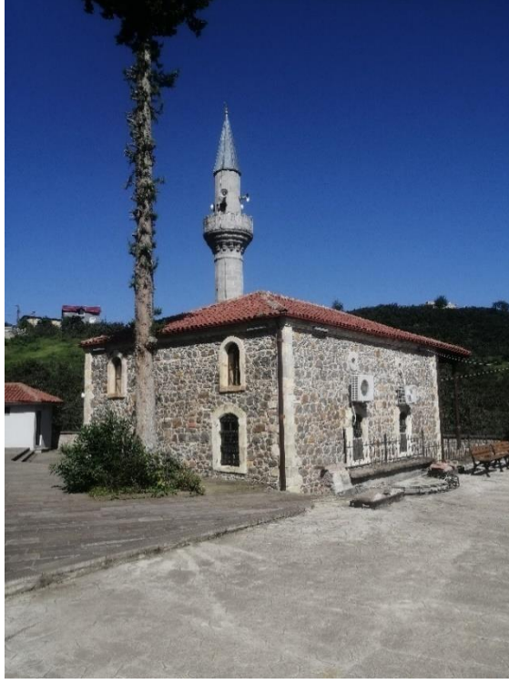
Görsel 25: Bulancak Kızılot Köyü Cami Genel Görünüm
