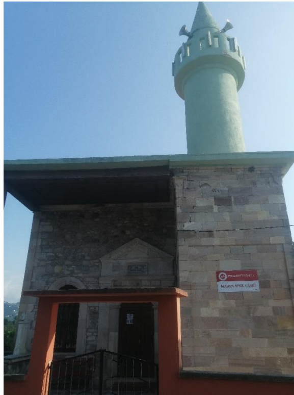
Görsel 79: Piraziz Gedikalizade Maden Cami Kuzey Cephe Görünüm
