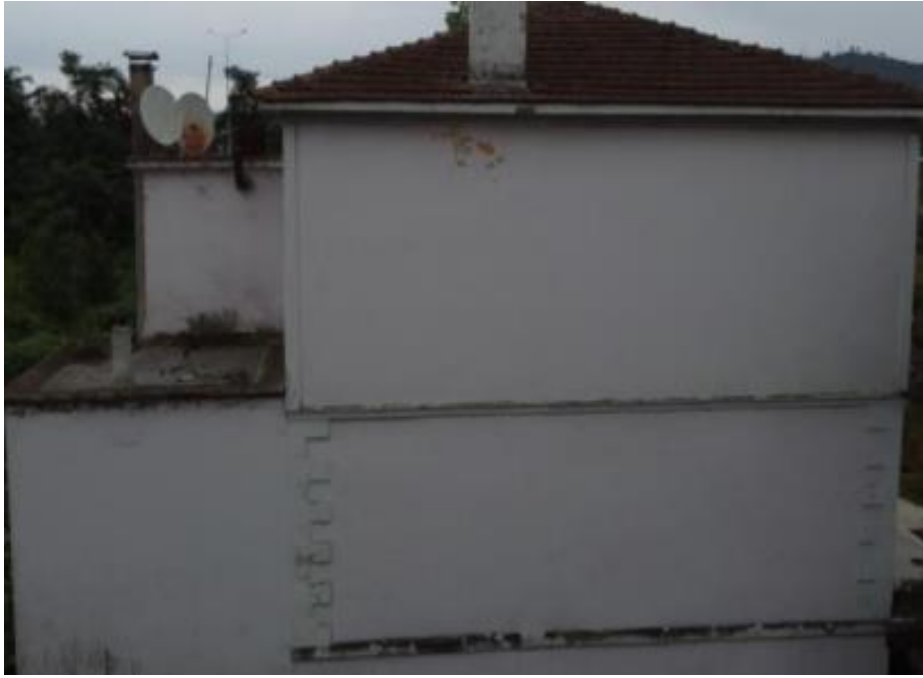
Görsel 123: Piraziz Tiralizade Osman Bey Konađı Batı Cephe Görünüm (Bayhan,2021:549)
