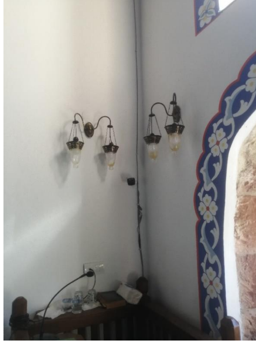
Görsel 33: Bulancak Kızılot Köyü Cami Doğu-Batı Cephe Pencere Kenarlarını Dolaşan Kalemisi Şeritten Görünüm
