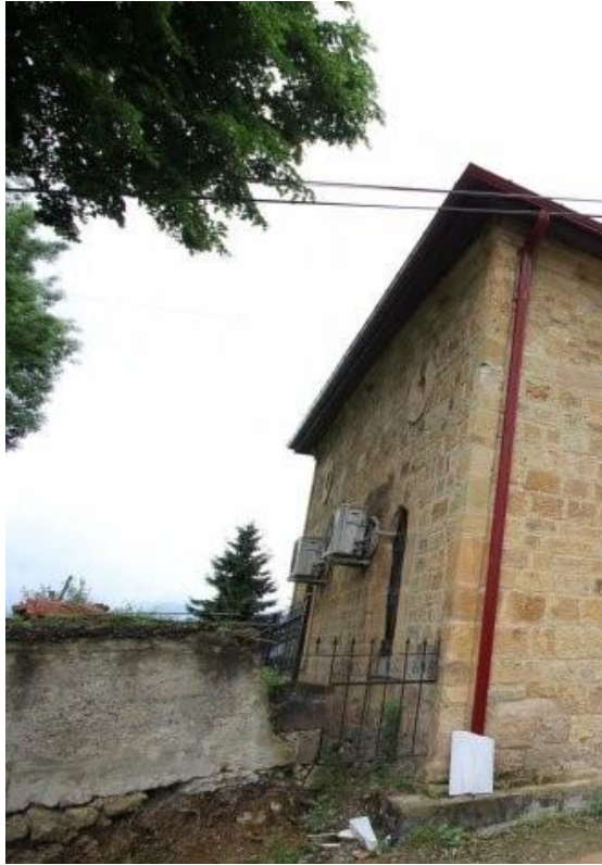
Görsel 59: Bulancak Ahmetli Köyü Cami Doğu Cephe Görünüm
