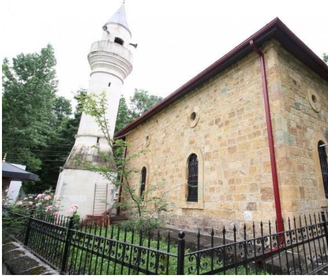
Görsel 58: Bulancak Ahmetli Köyü Cami Batı Cephe Görünüm
