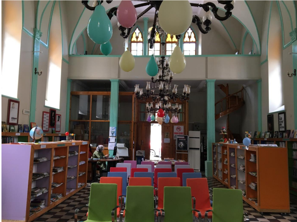
Görsel 131. Giresun Eski Katolik Kilisesi İç Mekan Güneyden Kuzeye Bakış
