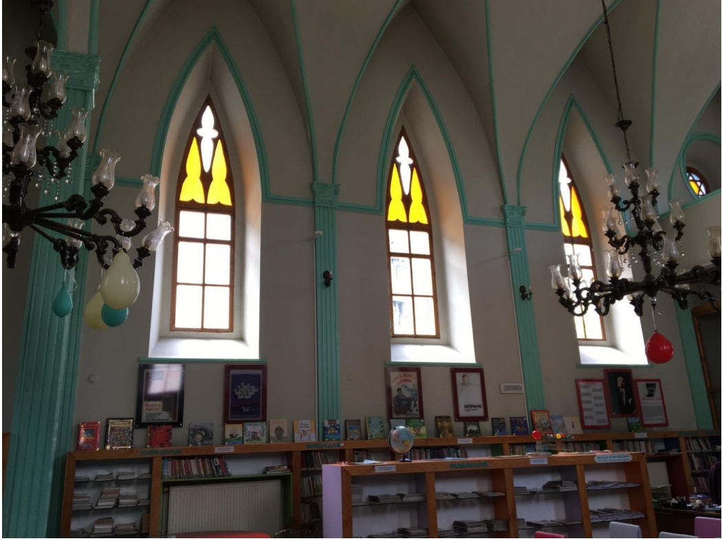
Görsel 140. Giresun Eski Katolik Kilisesi Pencereleri
