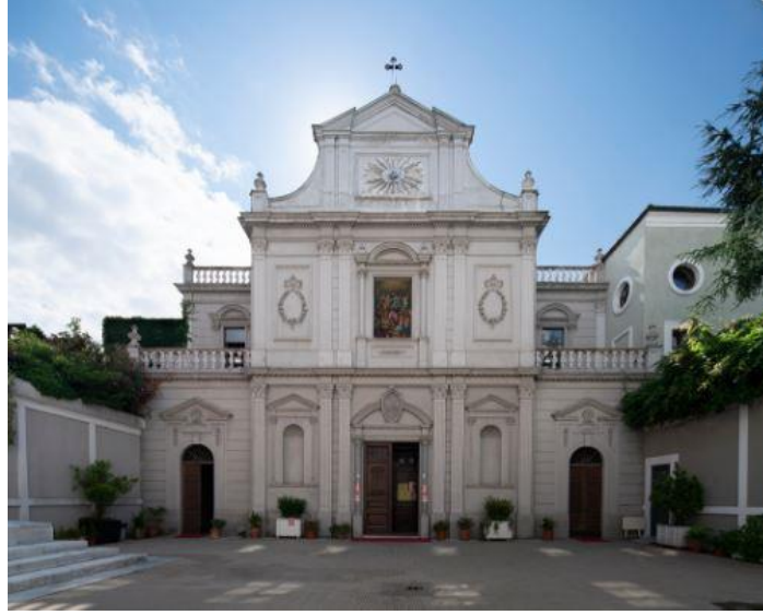
Görsel 179. İstanbul (Pangaltı) Saint Esprit Kilisesi (1846-1913)
