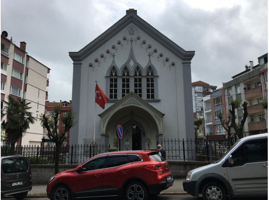
Görsel 129. Giresun Eski Katolik Kilisesi Kuzey Cephe
