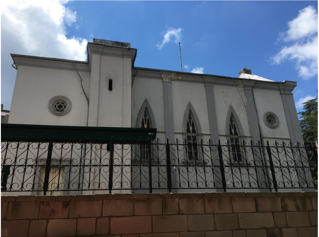
Görsel 125. Giresun Eski Katolik Kilisesi Doğu Cephe
