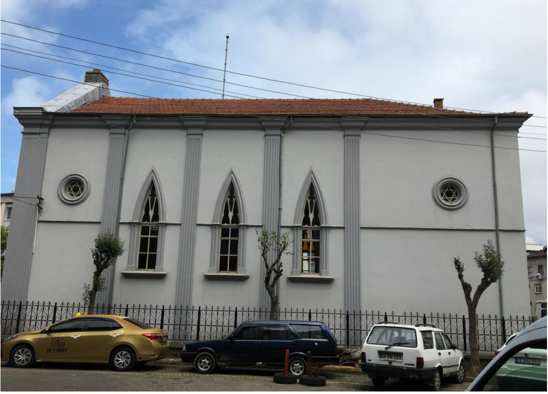
Görsel 124. Giresun Eski Katolik Kilisesi Batı Cephe
