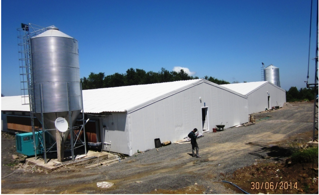
Şekil 4.7. Kumesin dıştan görünüşü
