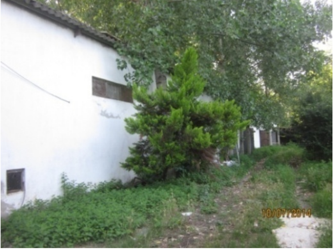
Şekil 4.74. Kumesin dıştan görünüşü
