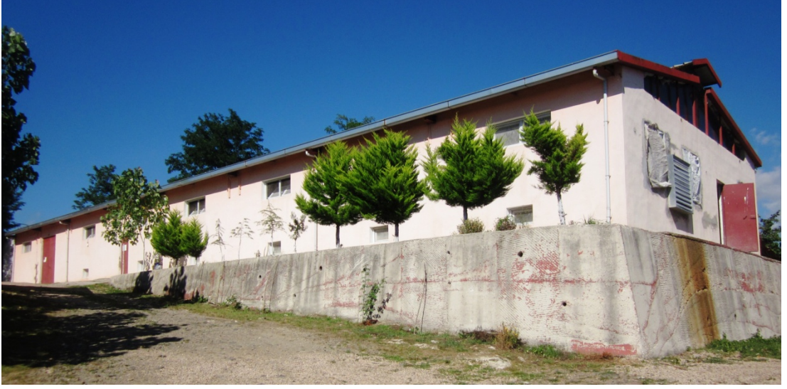
Şekil 4.10. Kumesin dıştan görünüşü
