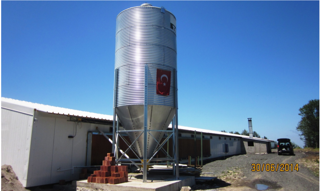
Şekil 4.8. Kumesin dıştan görünüşü
