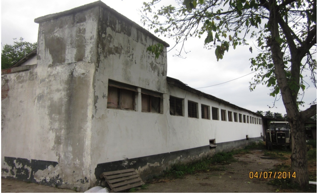
Şekil 4.48. Kumesin dıştan görünüşü
