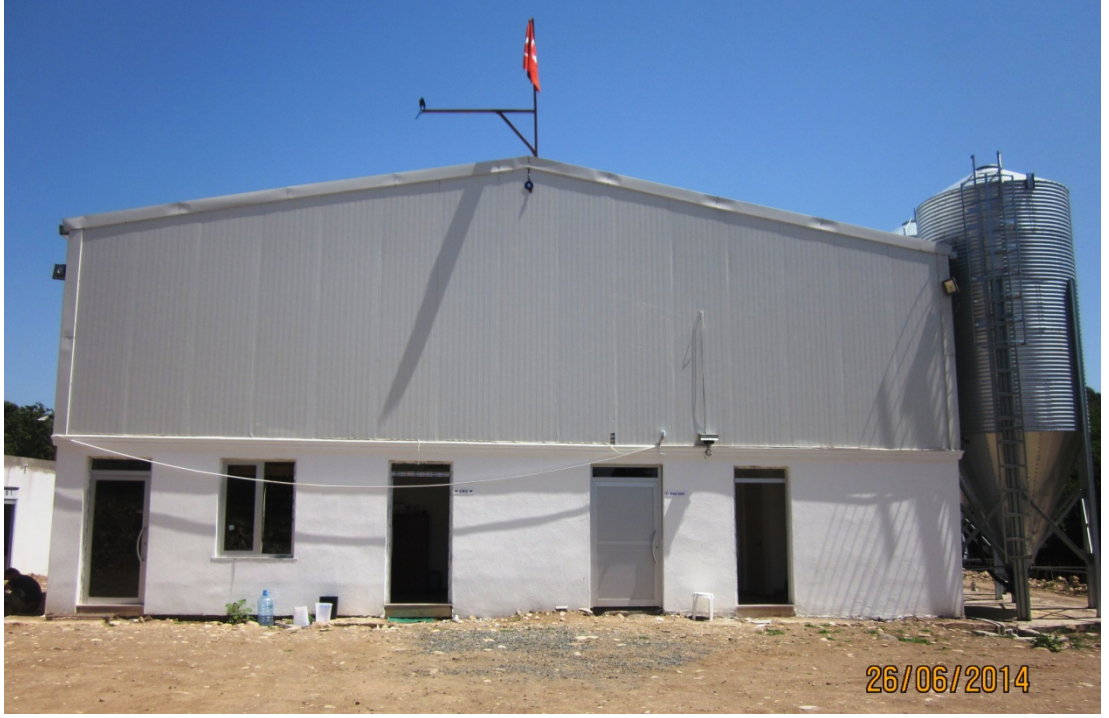
Şekil 4.1. Kumesin dıştan görünüşü
