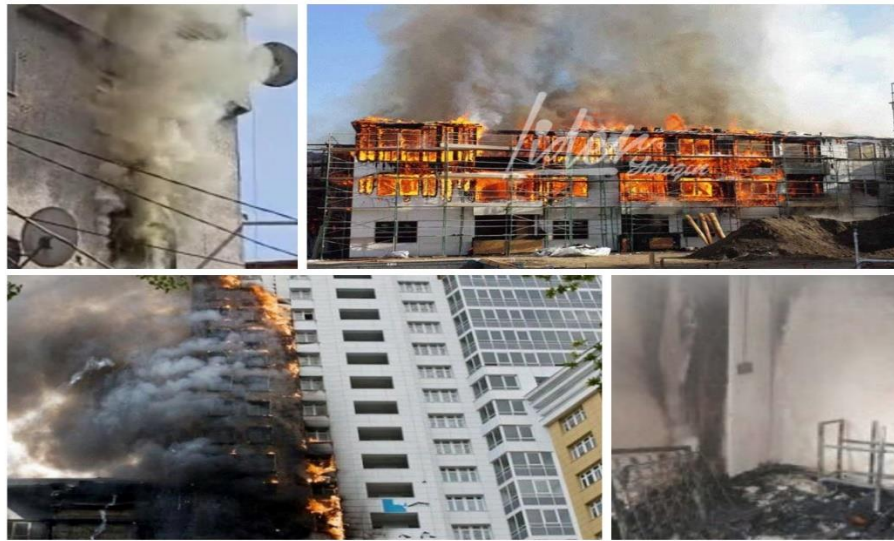
Şekil 1.1 Yangın Sonrası Hasar Gören Yapılara Ait Görünümler
