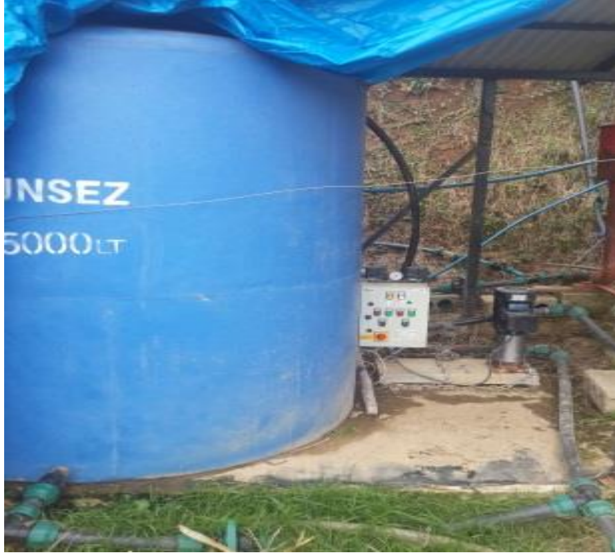
Şekil 3.4. Polietilen tank ve dikey pompa sistemi
