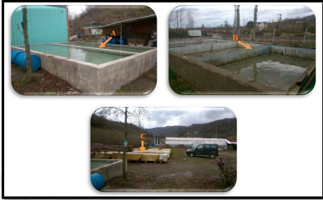
Şekil 4.9. Açık alanda bulunan havuzlar a)-b) beton havuzlar c) buzdolabı (tank tipi) kasalı havuzlar
