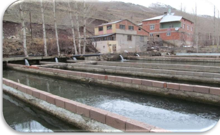
Şekil 4.17. Karada beton havuzlarda üretim yapan bir işletme
