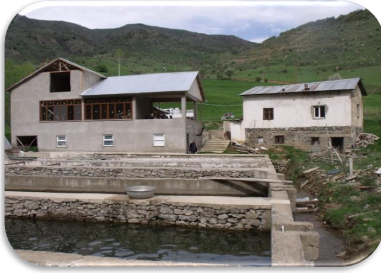
Şekil 4.24. Beton taş karışımı ile yapılmış havuz
