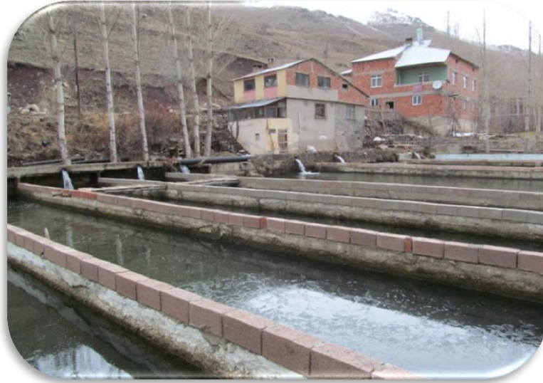
Şekil 4.25. Karada beton havuzlarda üretim yapan bir işletme
