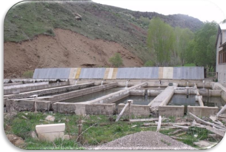
Şekil 4.15. Karada beton havuzlarda üretim yapan bir işletme
