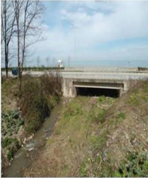
Keşap giriş köprüsü
