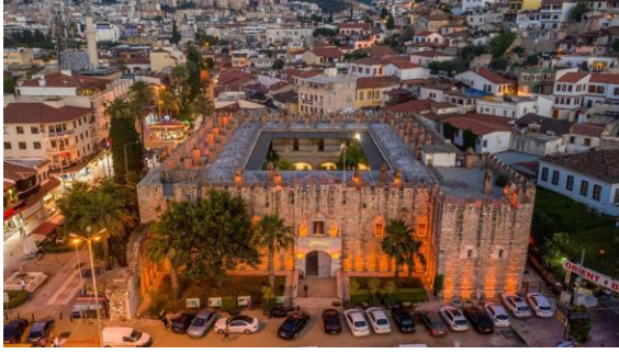
Şekil 44: Öküz Mehmet Paşa Kervansarayı
