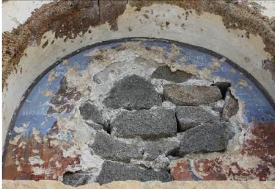
Görsel 32. Kıpçular Mahallesi Kilisesi, Giriş Lentosu Üzerinde Yer Alan Aziz Teheodoros Tasviri Kalıntısı (Okuyucu,2013, s.773)
