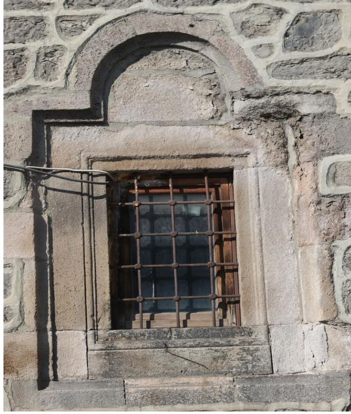
Görsel 23. Güney Cephe, Batıdan Birinci Sıradaki Pencere
