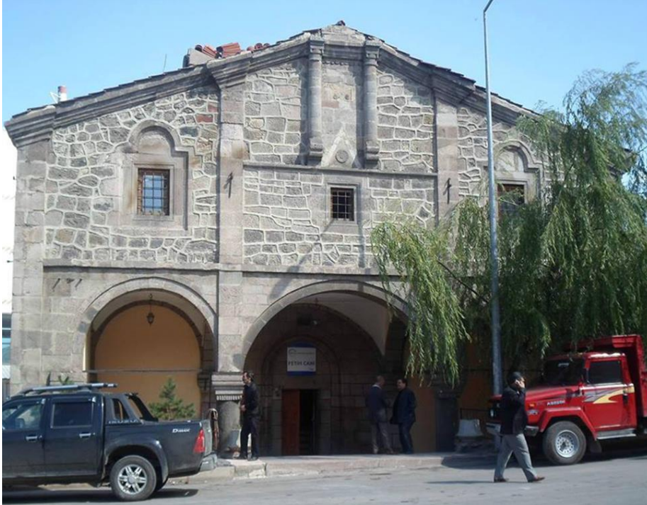
Görsel 4. Batı Cephe
