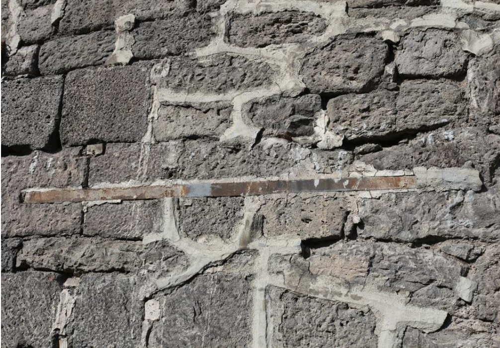
Görsel 22. Demirciler Kilisesinde Kullanılan Malzeme ve Teknik (Demir Malzeme Ayrıntısı)
