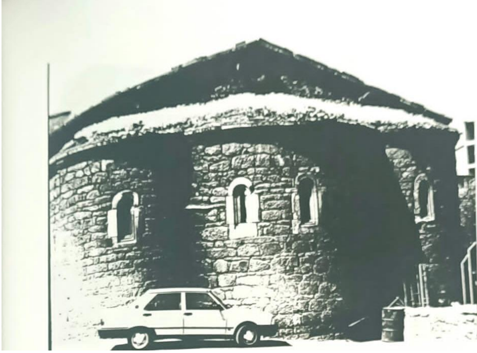
Görsel 21. Doğu Cephesi Genel Görünüşü (Haldun Özkan)
