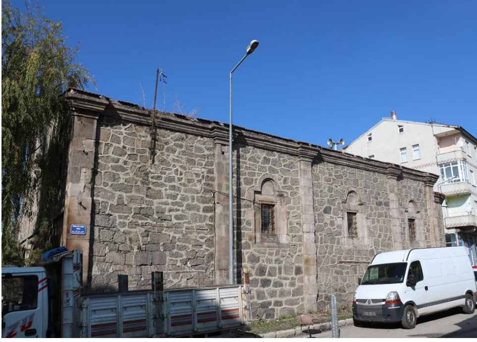
Görsel 17. Güney Cephe Genel Görünüşü
