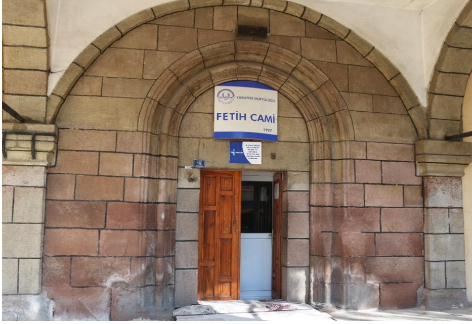
Görsel 7. Naosa Girişi Sağlayan Kapı
