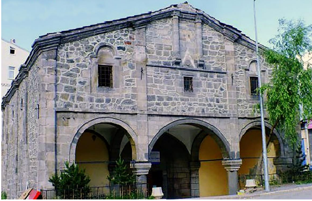
Görsel 15. Batı Cephe Genel Görünüşü
