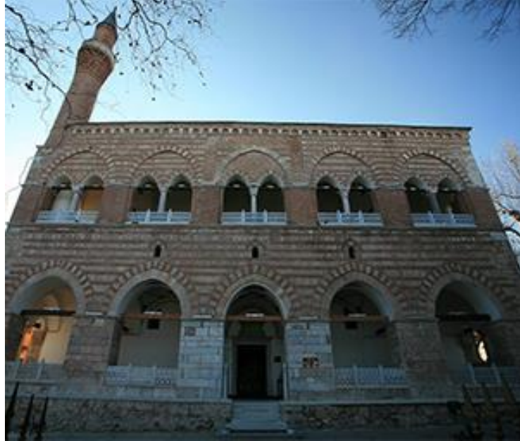
Görsel 42. Hüdavendigâr Camii Kuzey Cephesi, 14. Yüzyıl (Kültür Envanteri)
