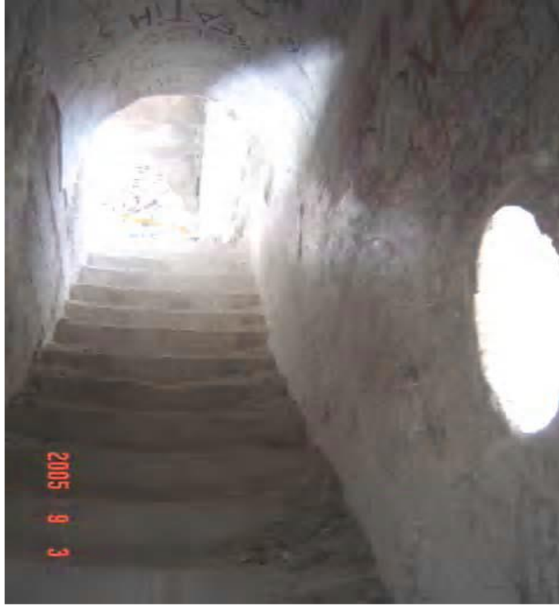
Görsel 43. Yanartaş Kilisesi Duvar İçerisinde Yer Alan Merdiven (Açıkgöz,2007, s.300)
