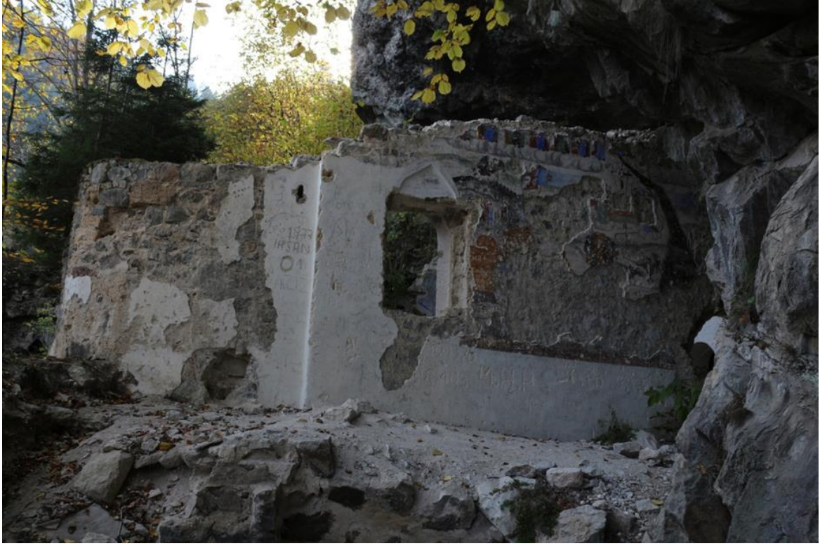
Görsel 7: Vazelon Manastır kilisesi kuzey cephe dıştan görünümü
