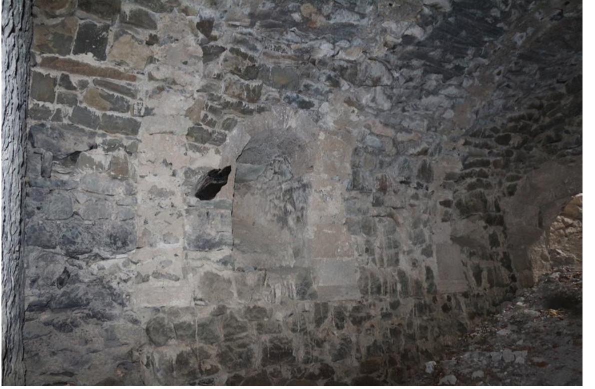
Görsel 100: Vazelon Manastırı idari binası zemin kat doğu cephe
