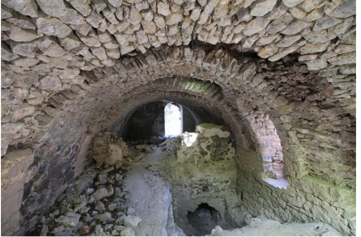
Görsel 103: Vazelon Manastırı idari binası 1. kat içten görünüm (Kültür Envanter)
