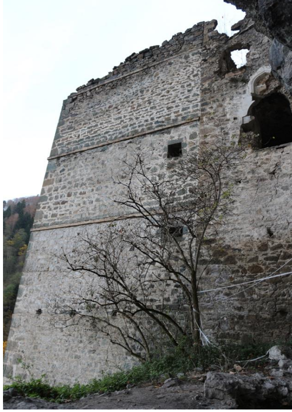
Görsel 80: Vazelon Manastırı kuzey cepheden görünüm
