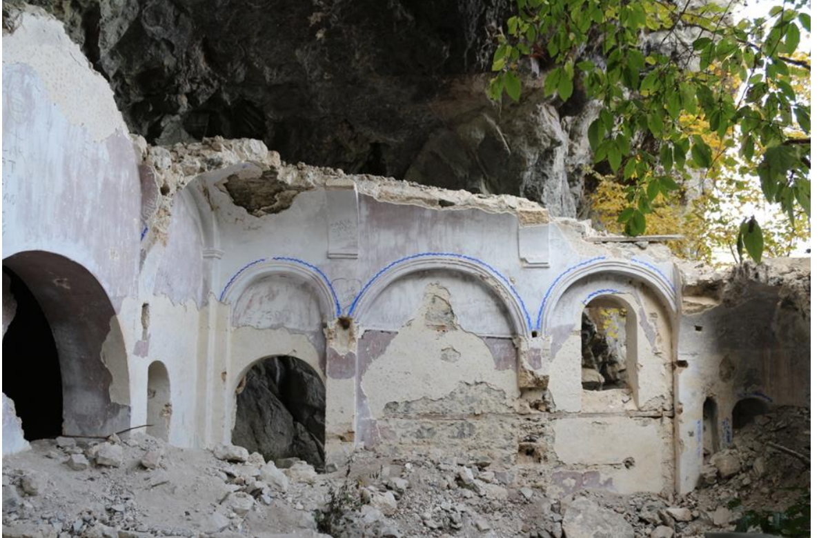
Görsel 8: Vazelon Manastır kilisesi kuzey cephe içten görünüm
