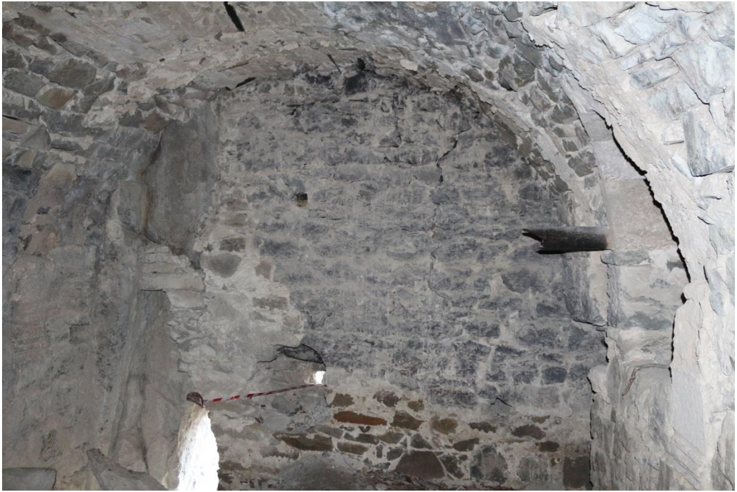
Görsel 99: Vazelon Manastırı idari binası zemin kat kuzey cephe
