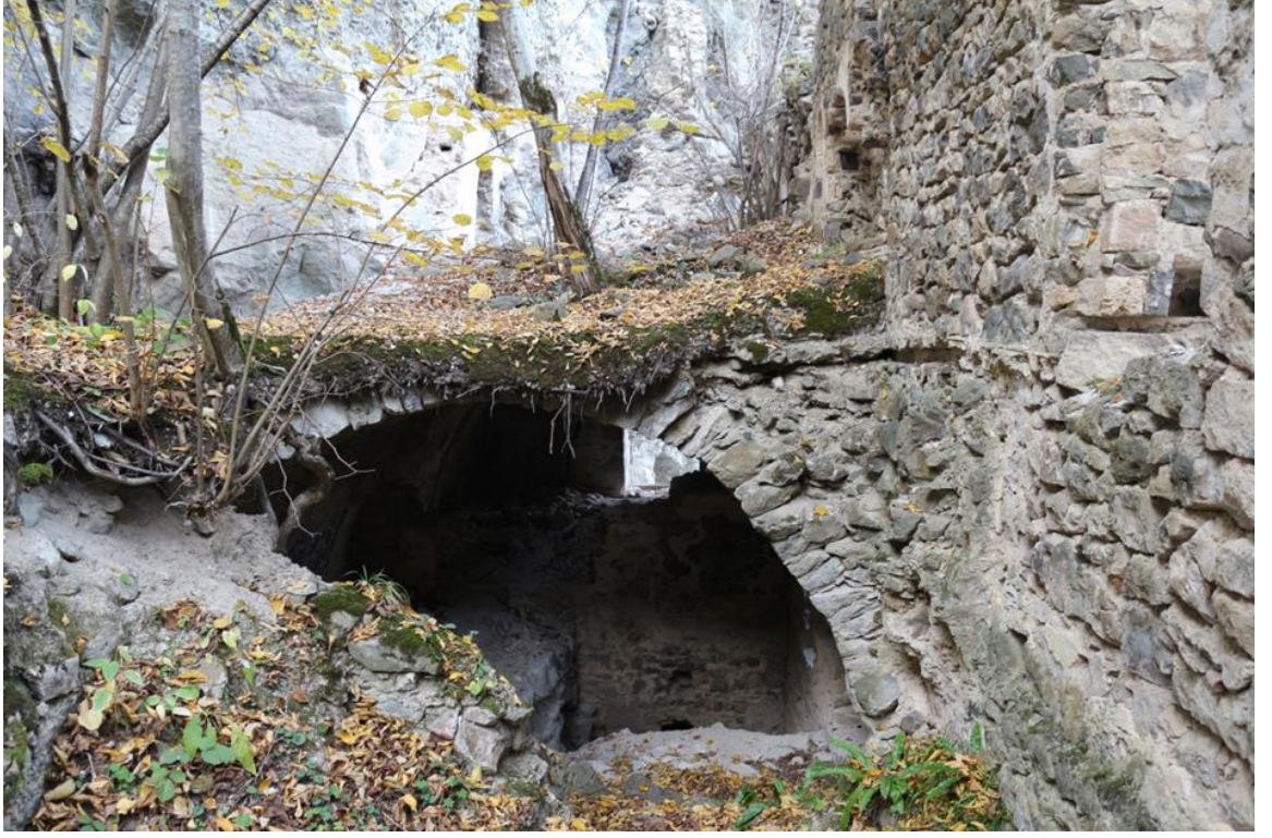
Görsel 102: Vazelon Manastırı idari binası 1. kat dıştan görünüm
