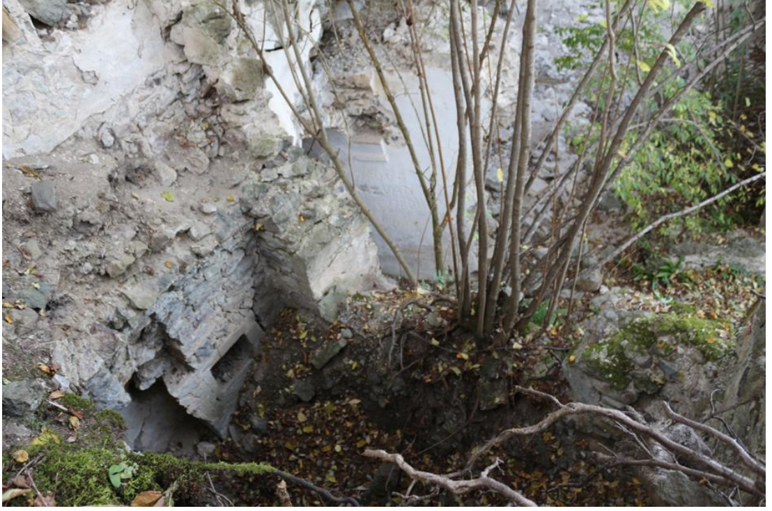
Görsel 108: Vazelon Manastırı güney kısımdaki konutun ocağı
