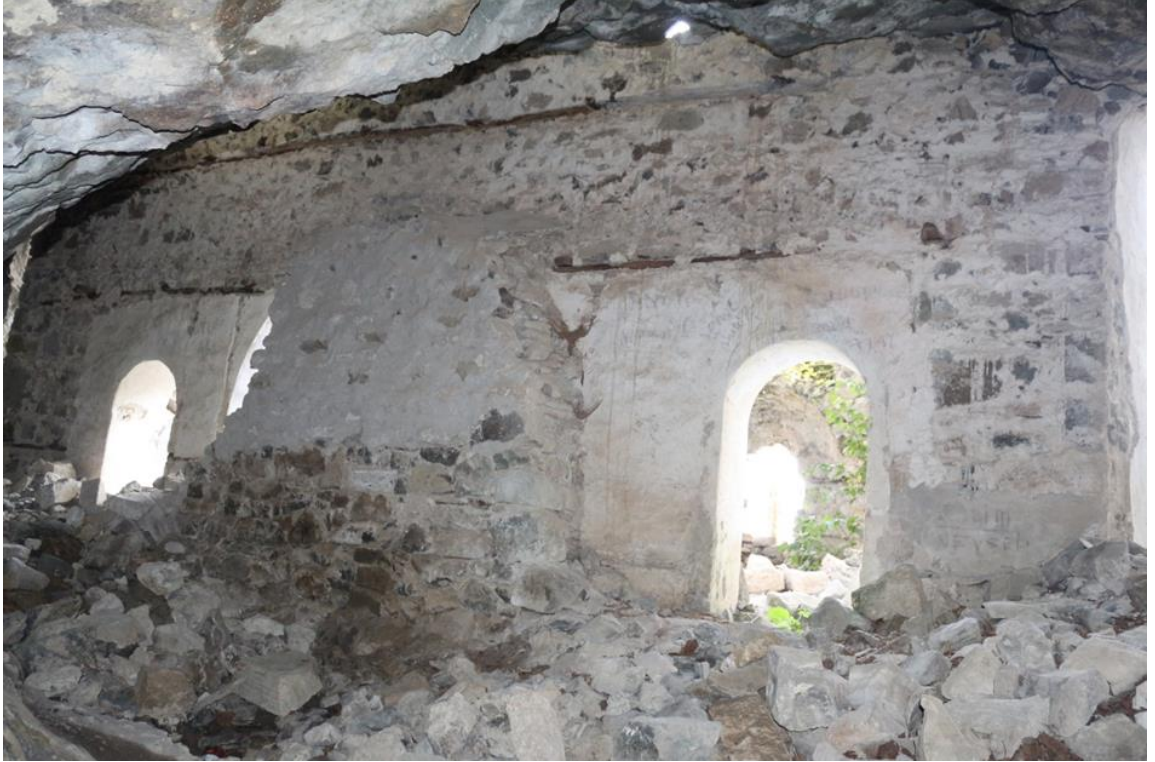
Görsel 12: Vazelon Manastır kilisesi batı cephe dıştan görünüm
