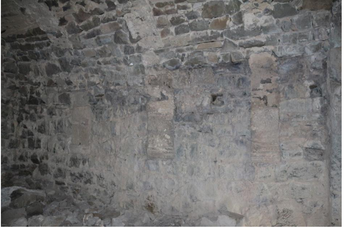
Görsel 101: Vazelon Manastırı idari binası zemin kat batı cephe
