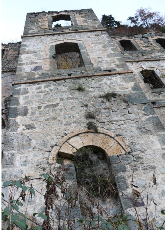
Görsel 85: Vazelon Manastırı doğu cephe kuleden görünüm
