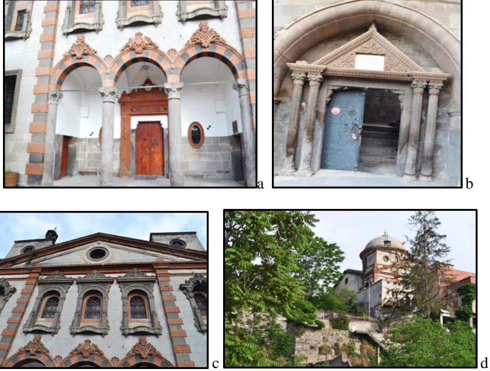
Şekil 4.9 a,b,c,d: Yaman Dede Camii (Eski Panaya Kilisesi)
