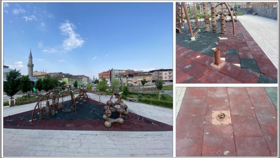
Şekil 4.25 Risk Oluşturabilecek Ankraj Kalıntı Malzeme (Orijinal 2024)
