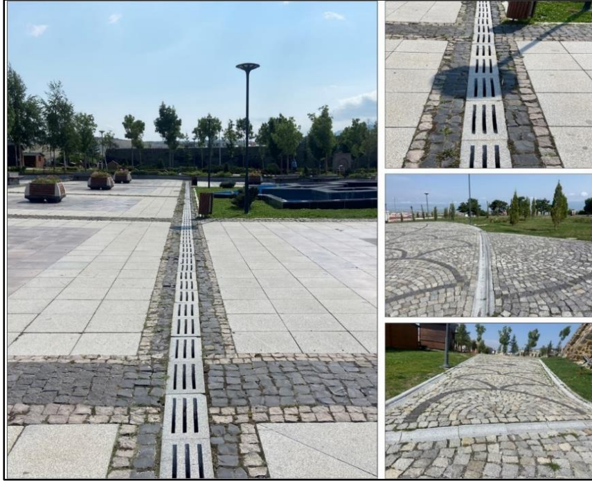
Şekil 4.9 Erzurum Kale Çevresi Kültür Yolu Parkı Yol Geçişlerinde Izgara ve Yağmur Oluğu (Orijinal 2024)
