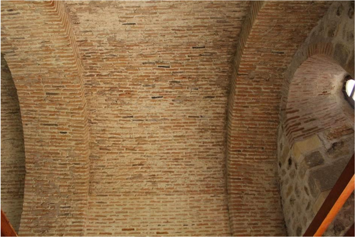
Görsel 17: Doğu Cephesi İç Görünüm
