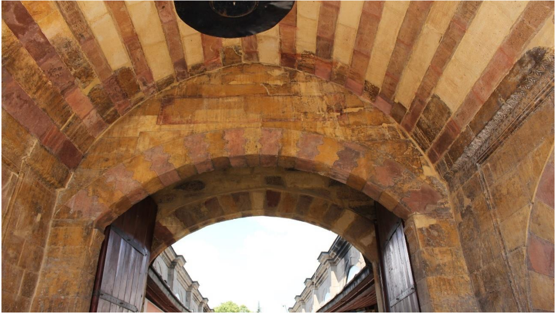
Görsel 118: Gümüşhacıköy Doğu Cephesi Giriş Kapısı Detay
