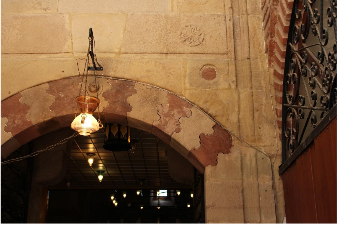
Görsel 105: Merzifon Bedesteni Güney Cephesi Kapı Detayı
