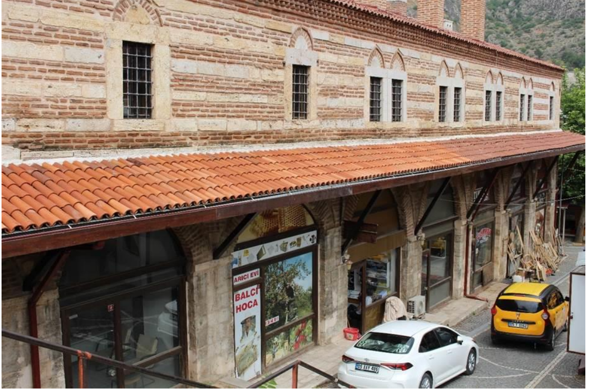
Görsel 33: Amasya Taşhan Kuzey Cephesi Dükkan Detay
