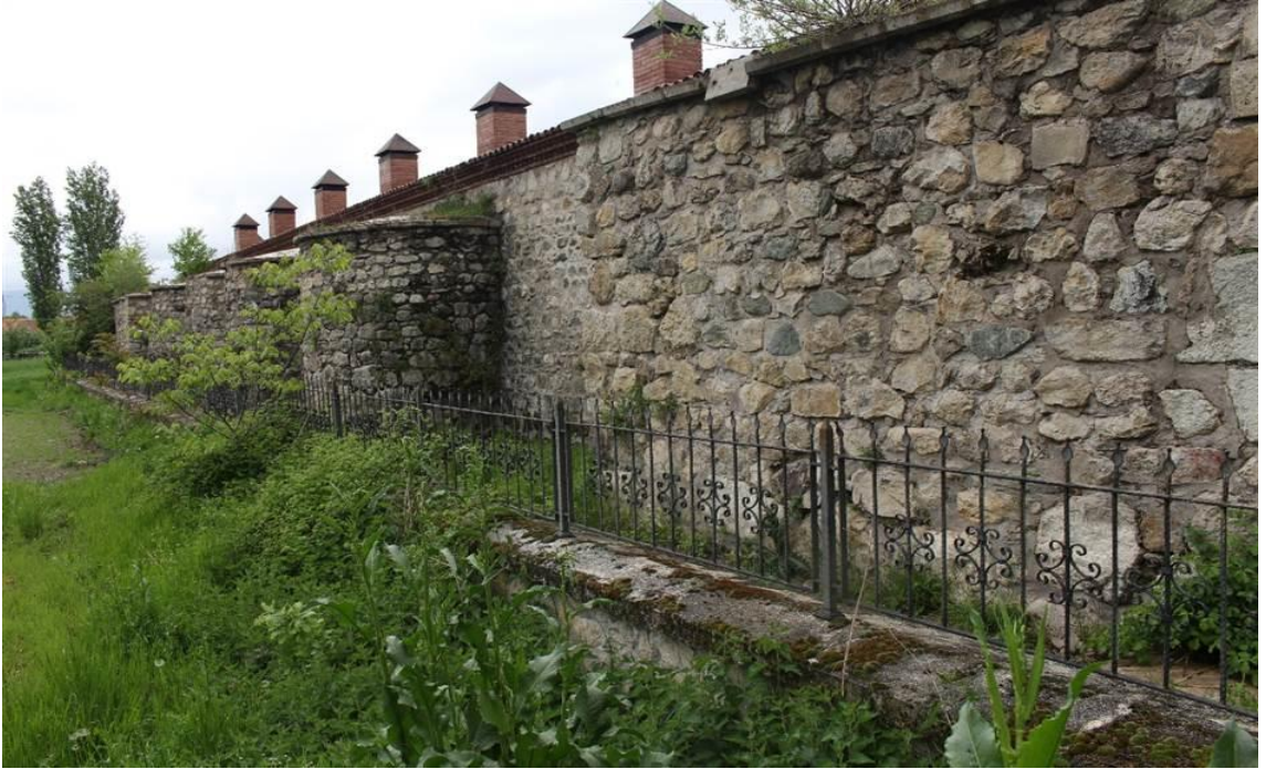
Görsel 7: Güney Cephesi Genel Görünüm
