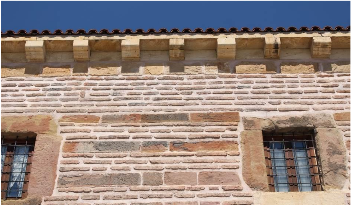
Görsel 76: Merzifon Taşhan Batı Cephesi Detay
