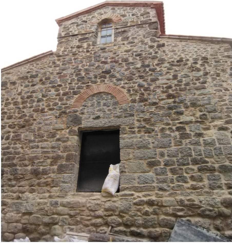
Görsel 13. Batı cephesi pencere (günümüzde kapı) açıklığı
