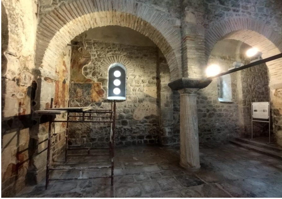
Görsel 33. İç mekan kuzey cephe genel görünüm
