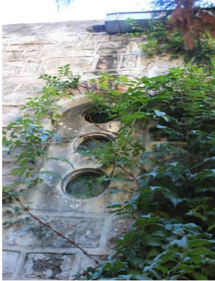
Görsel 8. Kuzey cephe üst kat pencerenin yakından görünümü (Zan Mimarlık'tan)
