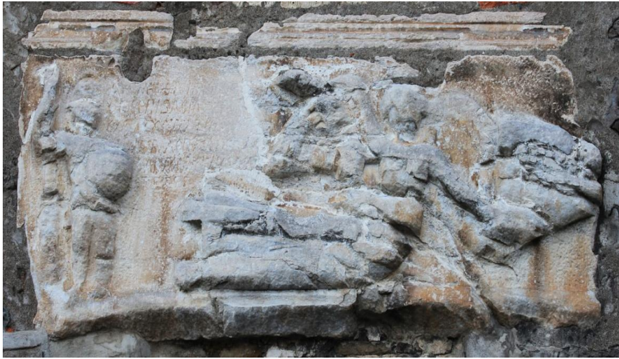
Görsel 14. Giriş kapısı üzerindeki devşirme panonun restorasyon öncesi hali (Zan Mimarlık'tan)
