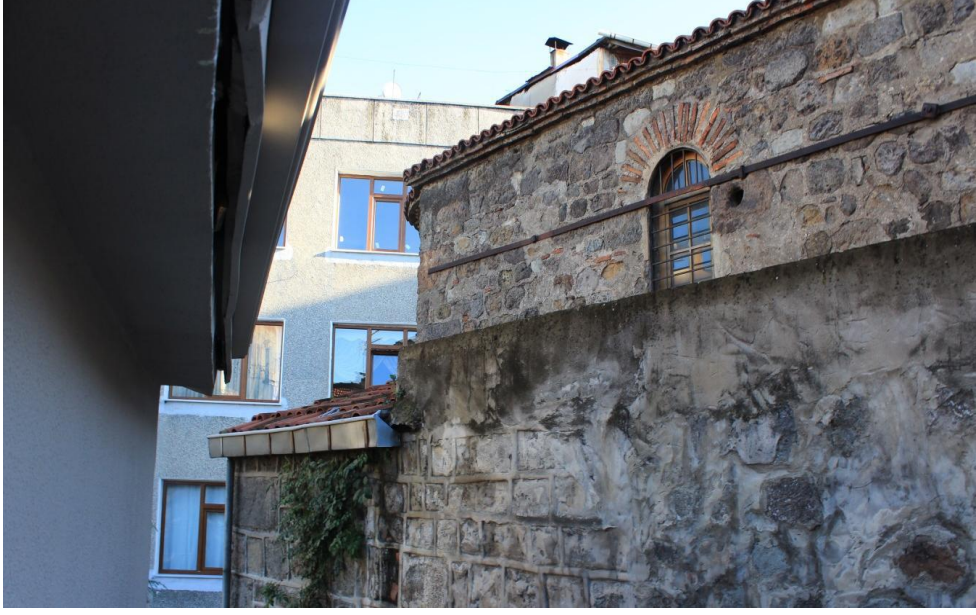
Görsel 9. Kuzey cephenin zemin seviyesindeki görünümü (Zan Mimarlık'tan)
