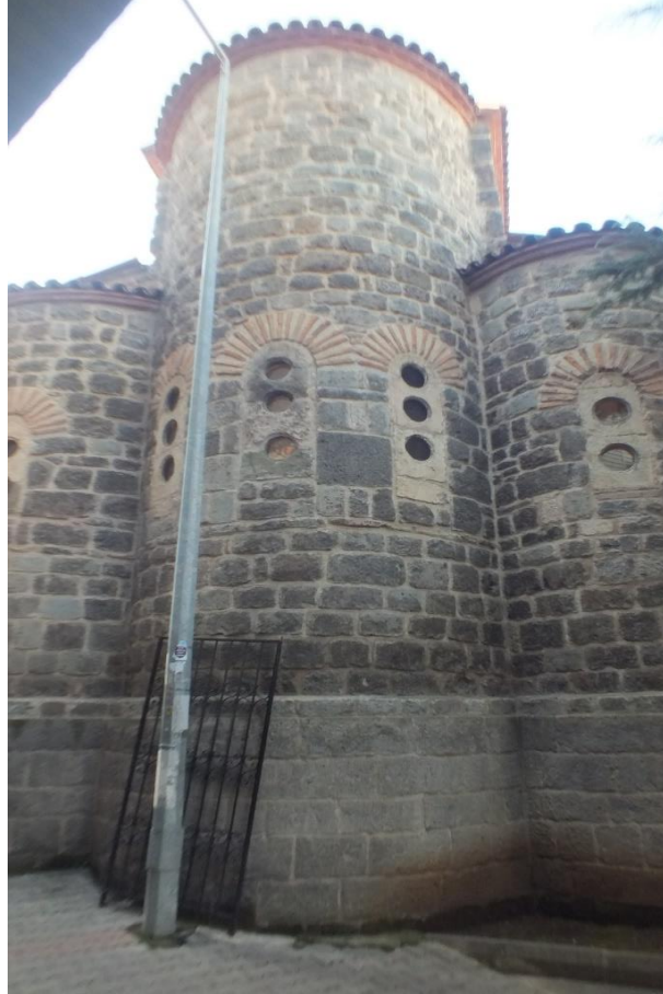
Görsel 10. Doğu cephe genel görünüm
