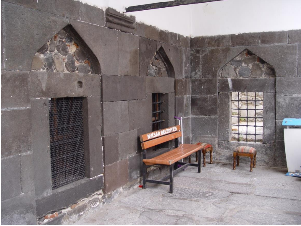
Görsel 111: Niksar Taş Mektep Binası Giriş Kısımında Sağda Yer Alan Pencereler
