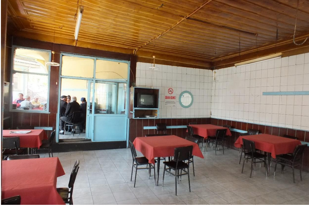
Görsel 65: Yüksek Kahve Binası 2016-2017 Yılı Restorasyonu Öncesi Zemin Kat
