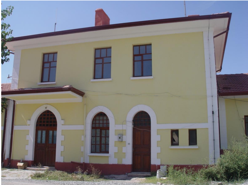
Görsel 139: Turhal Tren İstasyon Binası Arka Cephe Görünümü
