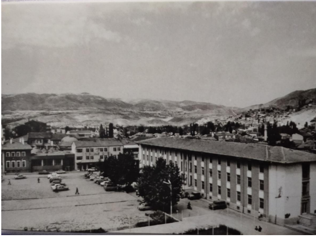
Görsel 44: Tokat Valilik Binası 1960'lı Yıllar (Hasan Erdem Arşivi)
