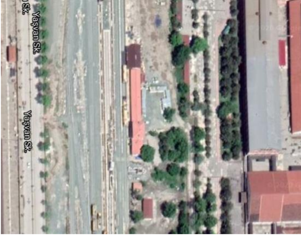
Görsel 136: Turhal Tren İstasyon Binası Görünümü (Tapu ve Kadastro Genel Müdürlüğü)
