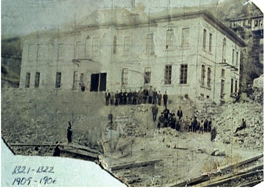
Görsel 88: Niksar Hükümet Konağı'nın İnşaat Hali (Niksar Belediyesi Arşivi)
