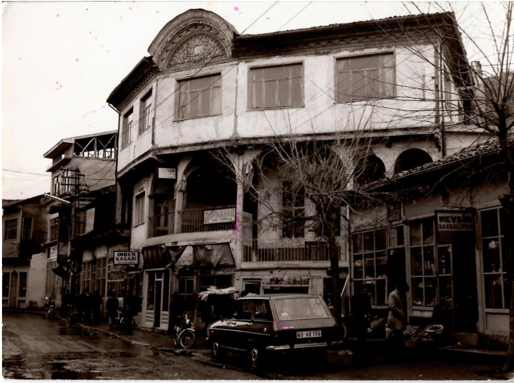
Görsel 64: Yüksek Kahve Binası Restorasyon Öncesi (Hasan Erdem Arşivi)
