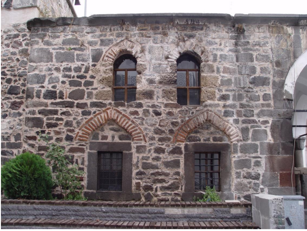
Görsel 109: Niksar Taş Mektep Binası Batı Cephe
