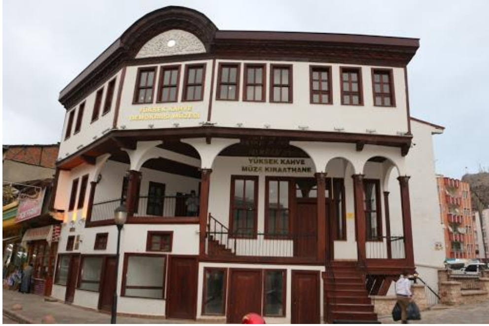
Görsel 84: Yüksek Kahve Binası Ön Cephe Görünümü
