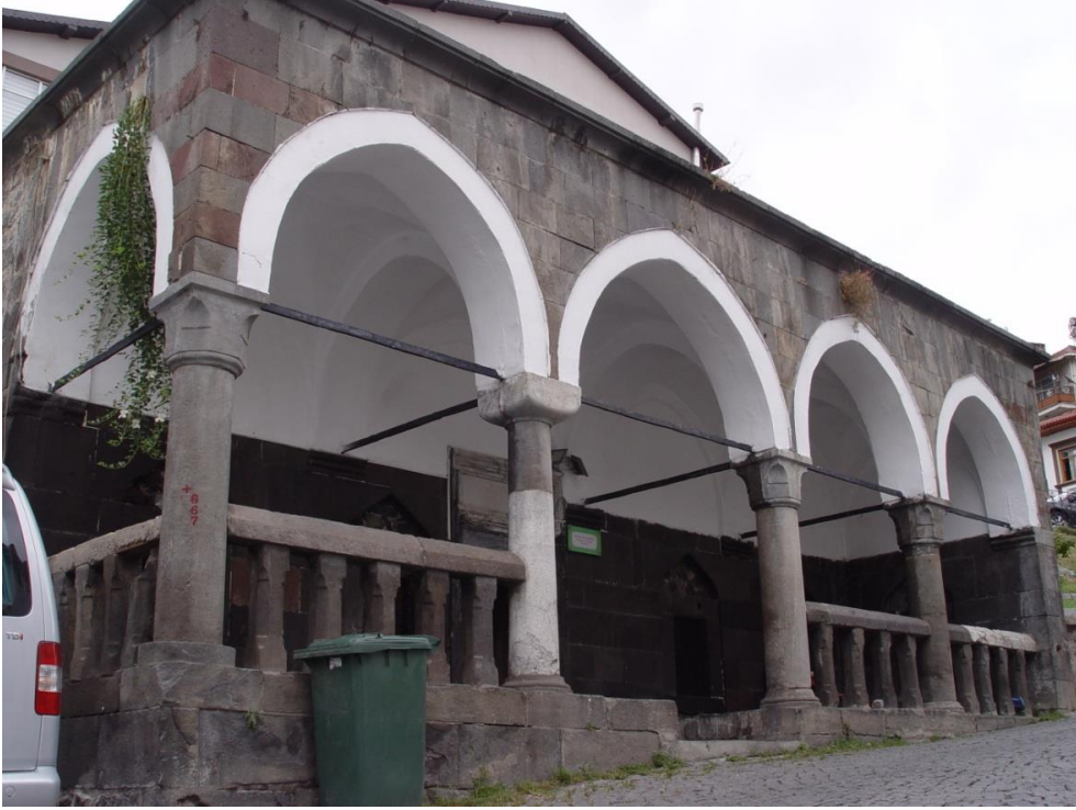
Görsel 104: Niksar Taş Mektep Binası Ön Cephe
