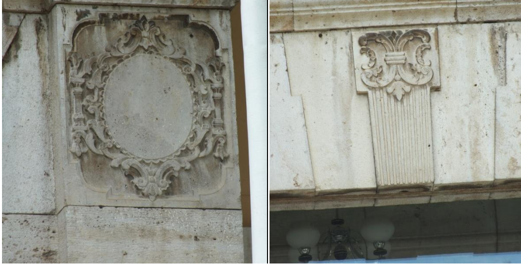
Görsel 39-40: Tokat Belediye Binası Doğu Giriş Üzerinde Yer Alan Süslemeler
