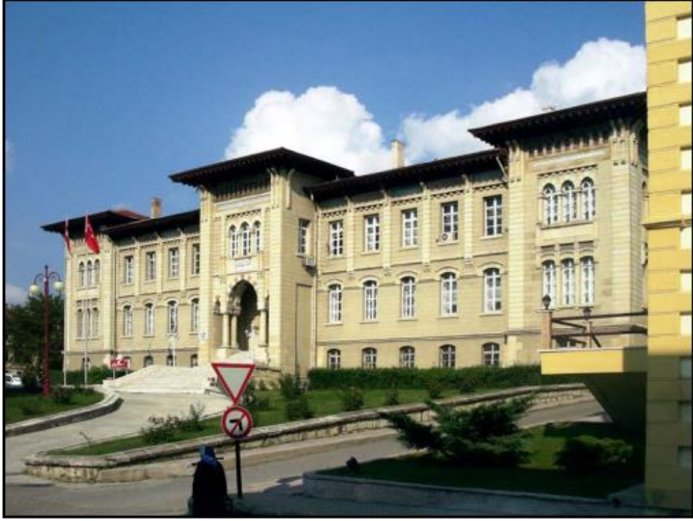
Görsel 147: Kastamonu Hükümet Konağı Cephe Düzeni (Kastamonu İl Kültür Turizm Müdürlüğü)
