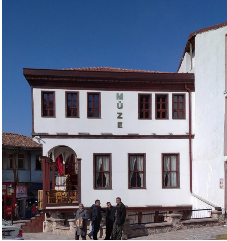
Görsel 86: Yüksek Kahve Binası Doğu Cephe Görünümü
