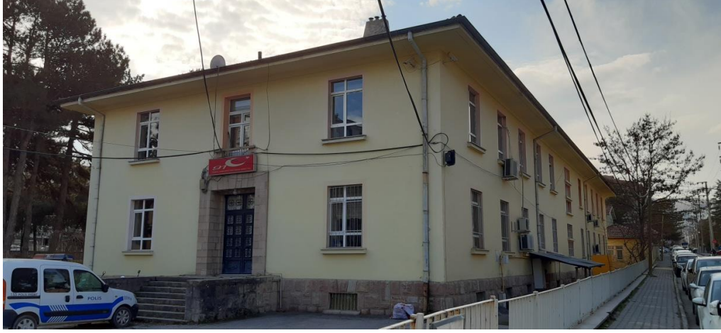
Görse 129: Turhal Hükümet Konağı Doğu Cephesi
