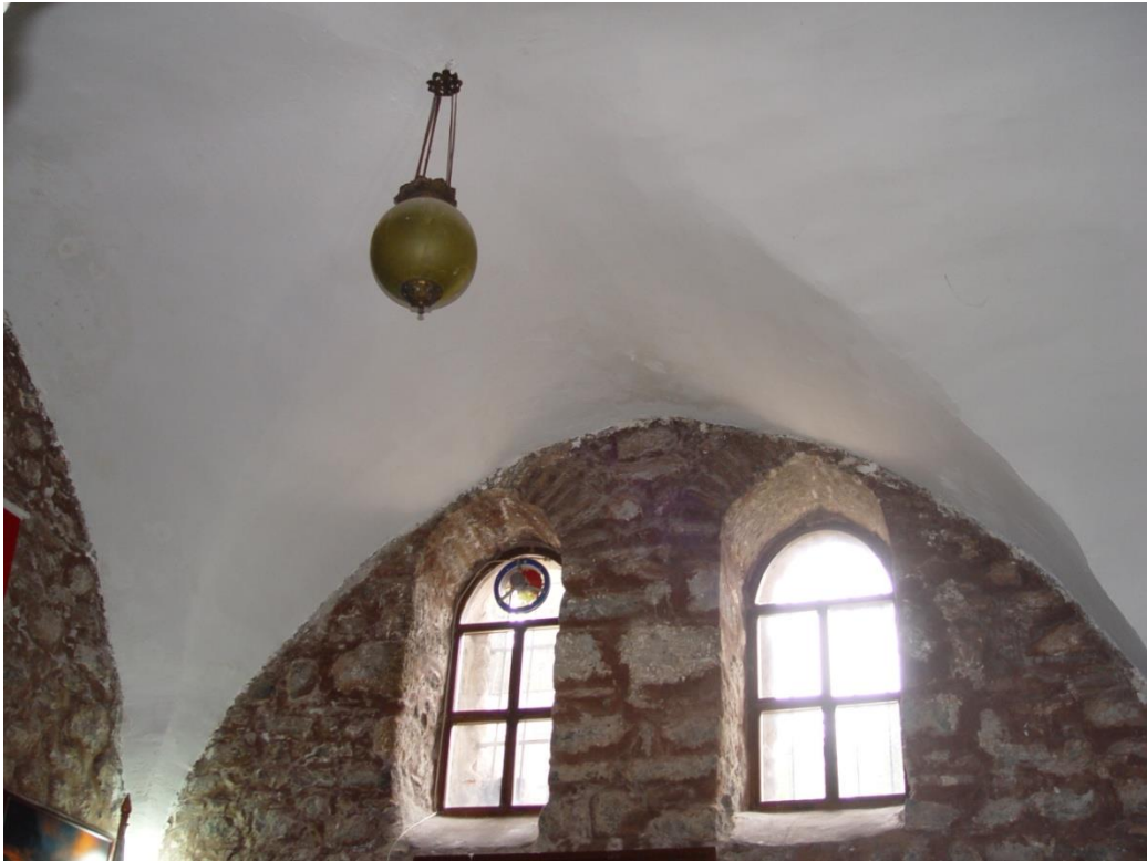
Görsel 108: Niksar Taş Mektep Binası Örtü Sistemi
