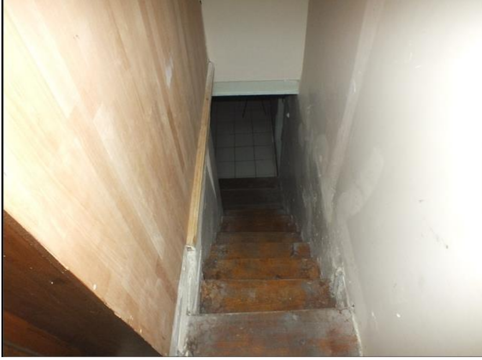
Görsel 19: Tokat Belediye Binası Bodrum Kata İniş Sağlayan Merdiven
