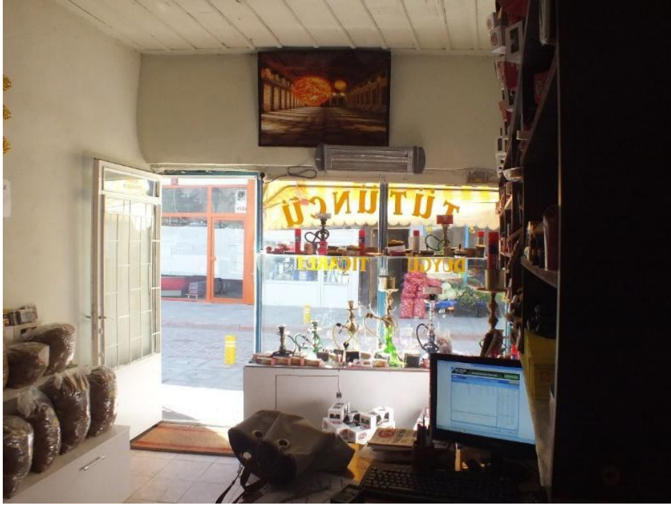
Görsel 66: Yüksek Kahve Binası 2016-2017 Yılı Restorasyonu Öncesi Zemin Kat
