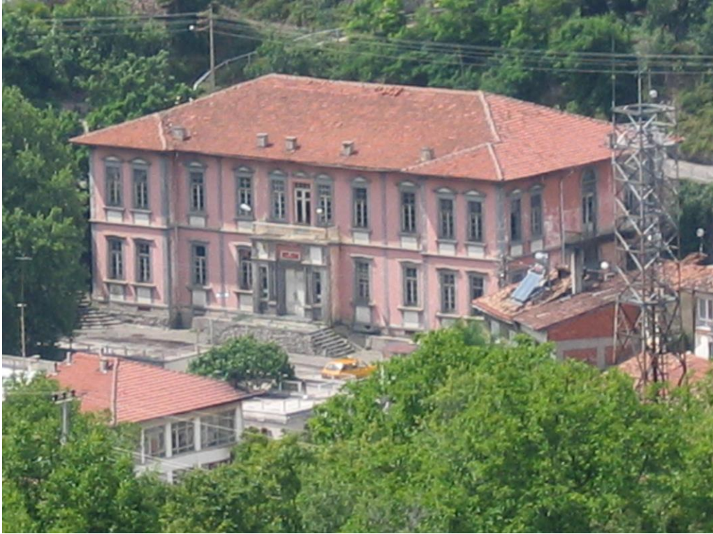
Görsel 91: Niksar Hükümet Konağı 1942 Depreminden Sonraki Hali
