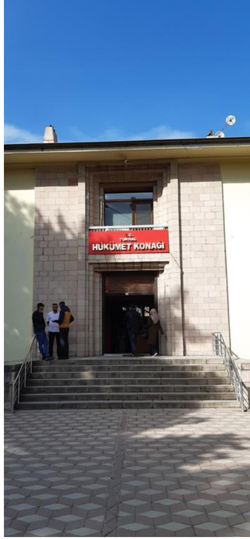
Görsel 127: Turhal Hükümet Konağı Güney Giriş Cephesi
