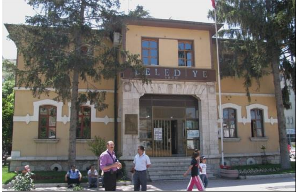
Görsel 34: Tokat Belediye Binası Ön (doğu) Cephe Genel Görünümü
