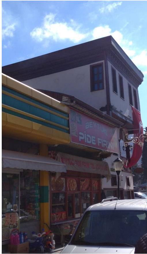
Görsel 87: Yüksek Kahve Binası Batı Cephe Görünümü
