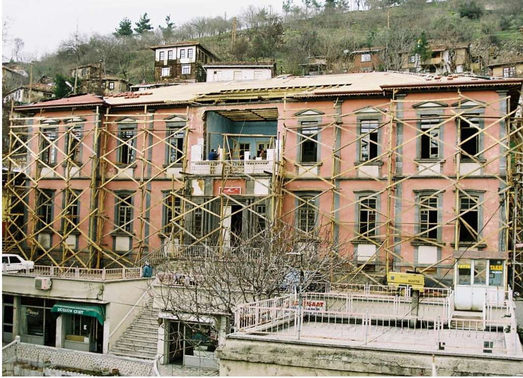
Görsel 92: Niksar Hükümet Konağı 2005 Yılında Başlatılan Restorasyonundan Görüntü
