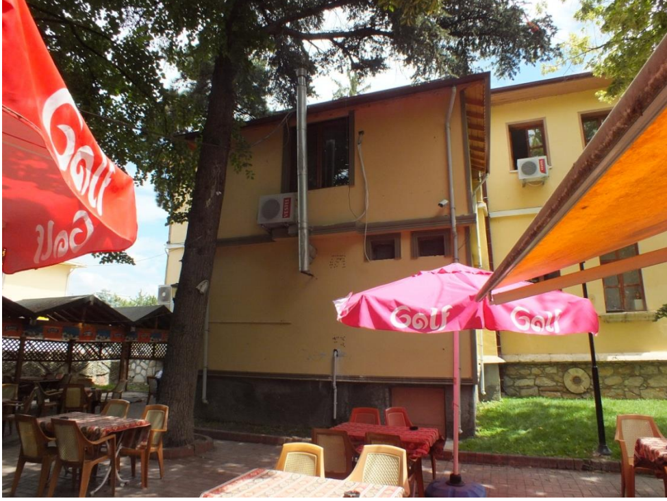
Görsel 35: Tokat Belediye Binası Arka (batı) Cephesi
