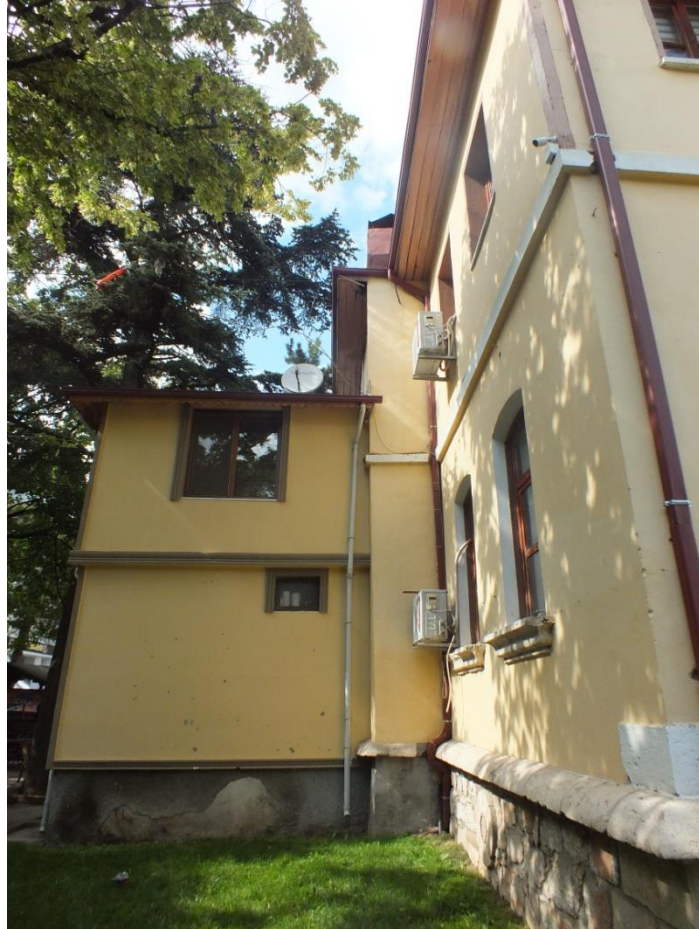
Görsel 36: Tokat Belediye Binası Arka (batı) Cephesi
