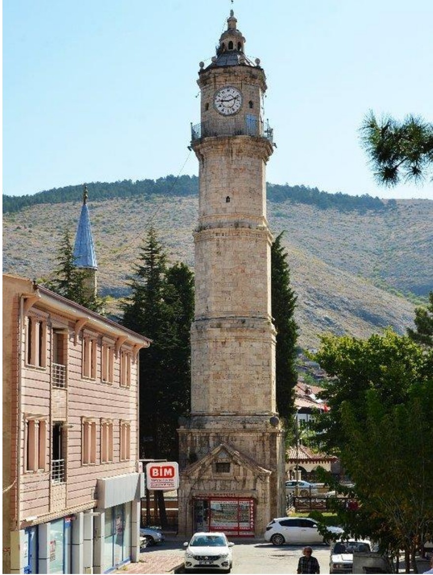
Görsel 52: Tokat Saat Kulesi Kaide Kısımında Yer Alan Muvakkithane Bölümü
