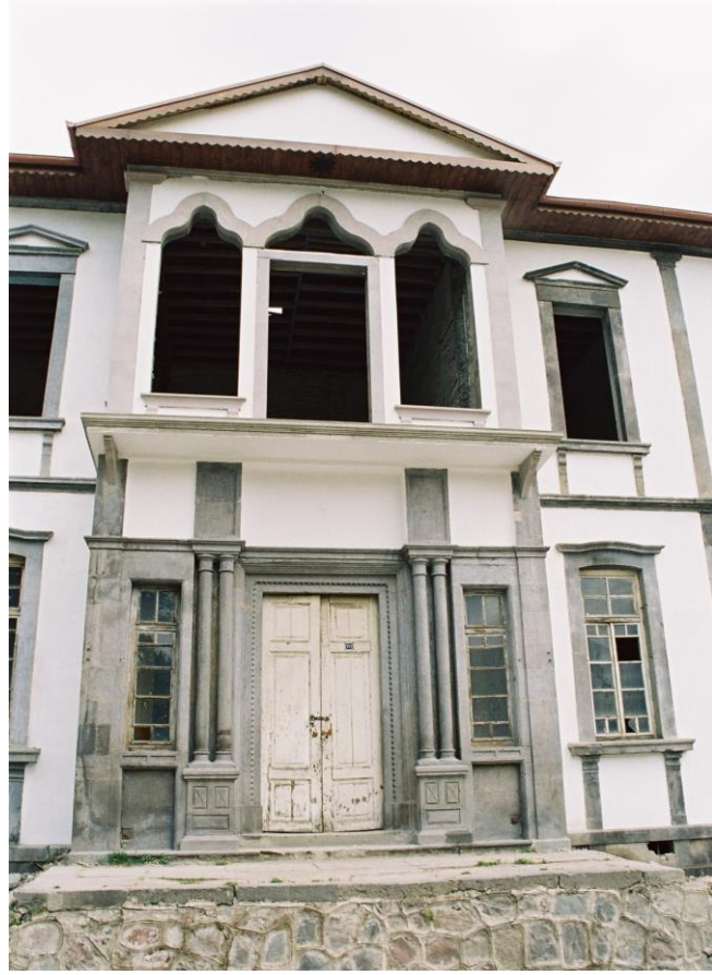
Görsel 100: Niksar Hükümet Konağı Güneyde Yer Alan Sütunlu Giriş (Niksar Belediyesi)
