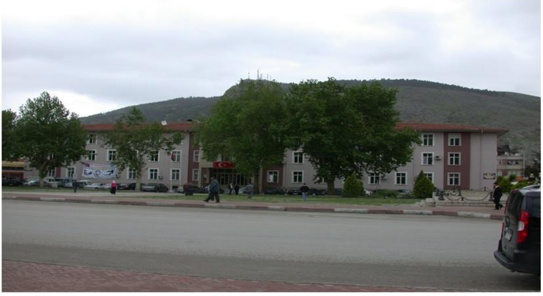
Görsel 42: Tokat Valilik Binası Ön Cephe Genel Görünümü
