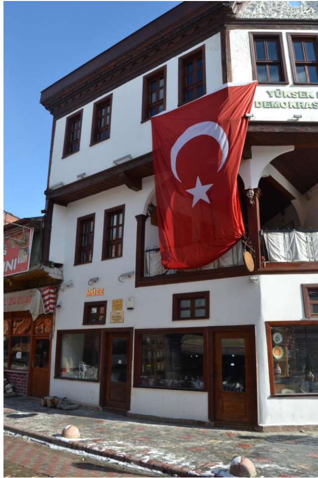
Görsel 85: Yüksek Kahve Binası Güneybatı Cephe Görünümü
