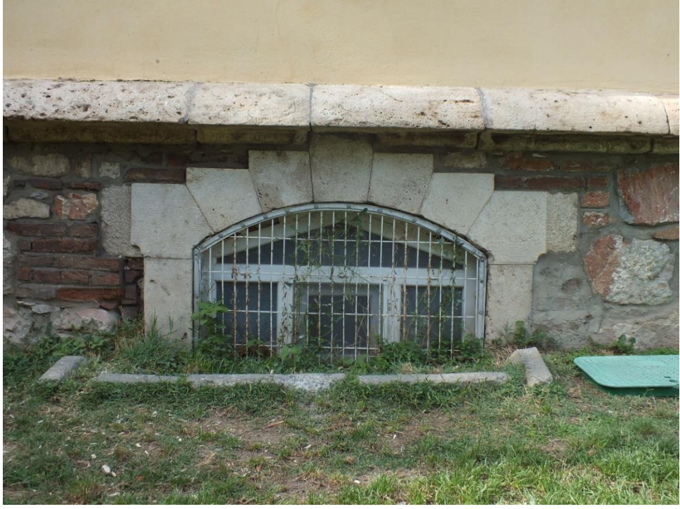
Görsel 25: Tokat Belediye Binası Bodrum Kat Güneydeki Mescit Mekânının Penceresinin Dışarı Yansıması
