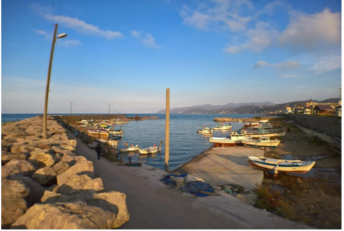
Şekil 4.31 Keşap Çekkek Yeri Genel Görünüş
