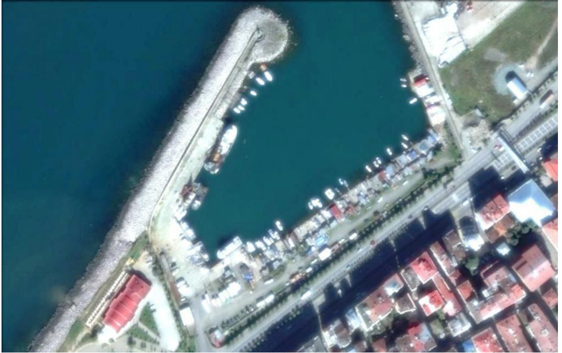
Şekil 4.4 Giresun Merkez Balıkçı Limanı Uydu Görüntüsü (Google Earth)
