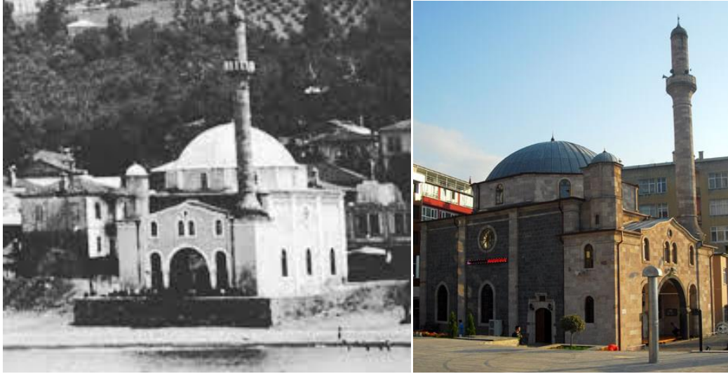
Şekil 3. 92 Hacı Miktad Cami Eski Hali. Solda (Kaynak: GRÜ Kent Arşivi).
