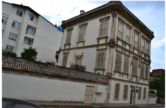
Resim 155- Altınordu Paşaoğlu Konağı Doğu Cepheden Görünüşü
