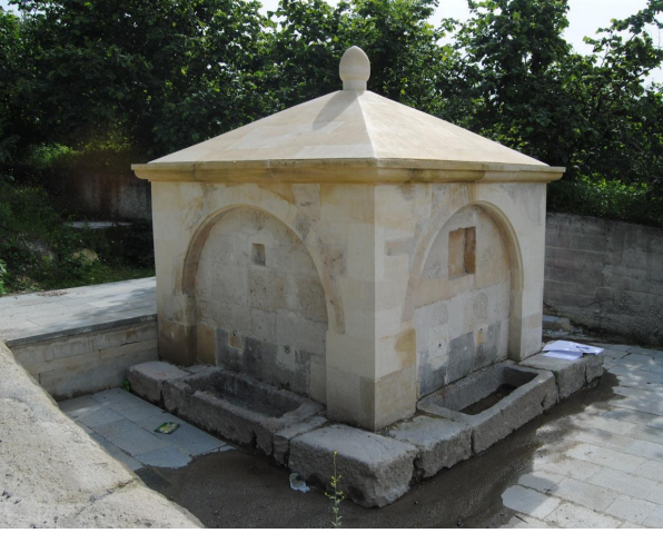
Resim 143- Ulubey Akpınar Mahallesi Beşluk Çeşmesi
