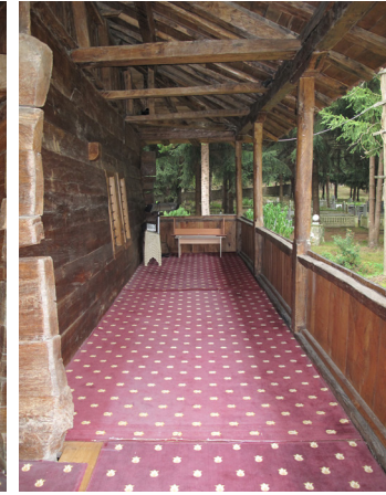
Resim 86- İkiizce Laleli (Eski) Camii Batı Revaki
