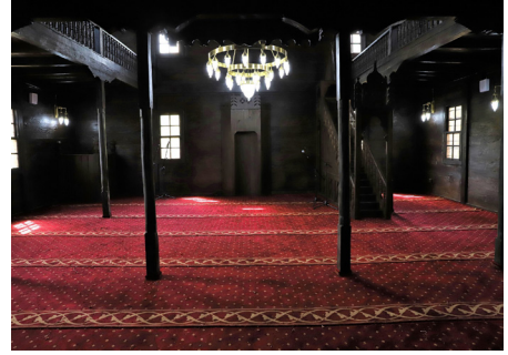
Resim 104- Çaybaşı Çayır Camii Harimi Restorasyon Sonrası Görünümü
