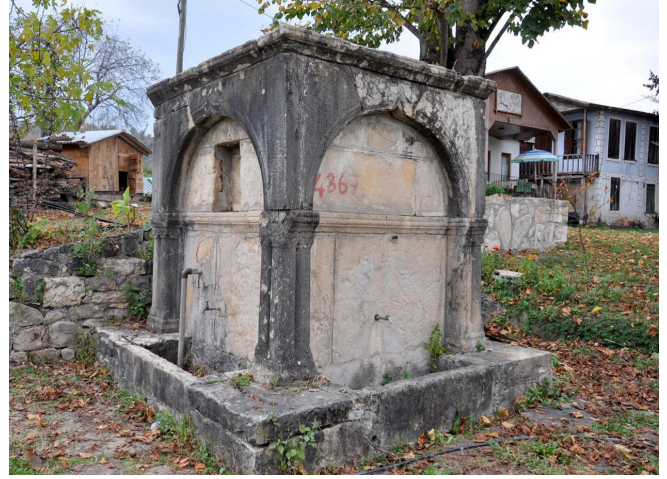
Resim 144- Ulubey Kıryağmur Mahallesi Konak Yanı Çeşmesi
