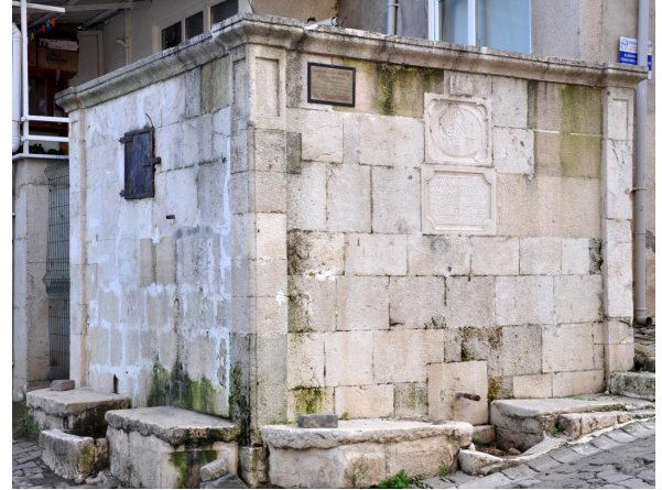
Resim 142- Altınordu Saray Mahallesi Ali Katip Çeşmesi
