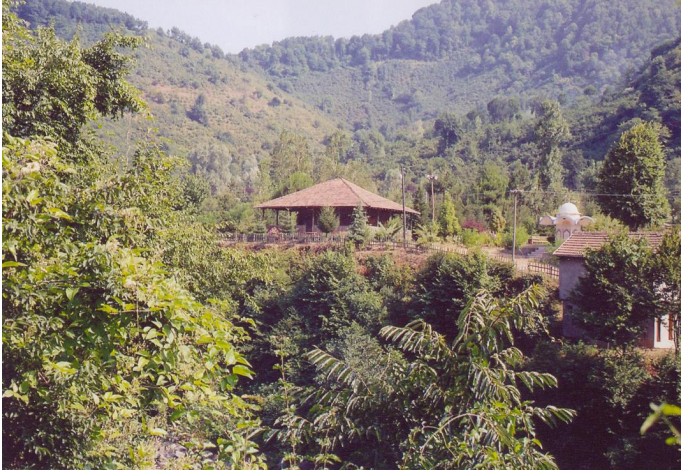
Resim 69- İkizce Laleli (Eski) Camii Genel Görünüşü
