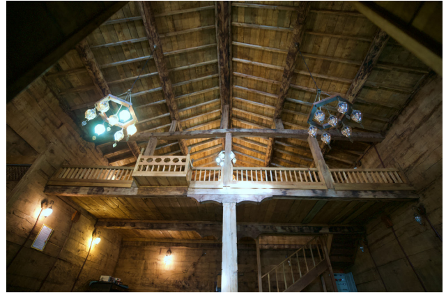
Resim 97- Gökçöy Dereçayır Mahallesi Emirler Camii Üst Örtüsü
