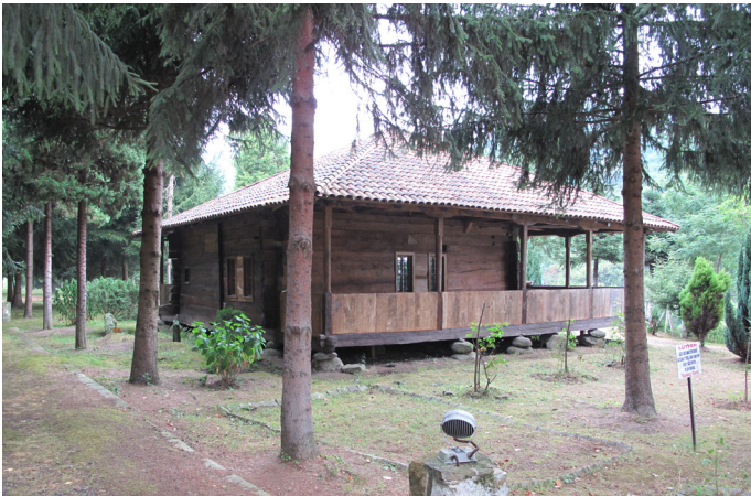
Resim 70- İkizce Laleli (Eski) Camii Onarım Sonrası Genel Görünüşü
