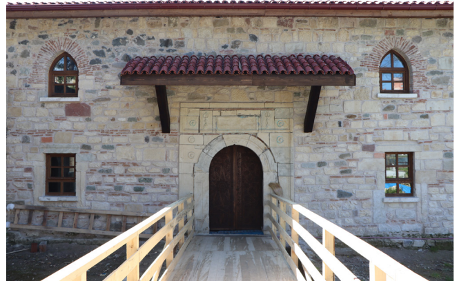
Resim 42- Eskipazar Camii Restorasyon Sonrası (2023) Kuzey Cephenin Görünüşü
