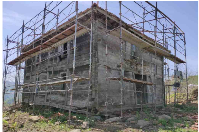
Resim 114- Gürgentepe Eskiköy Camii Restorasyon Esnasında
