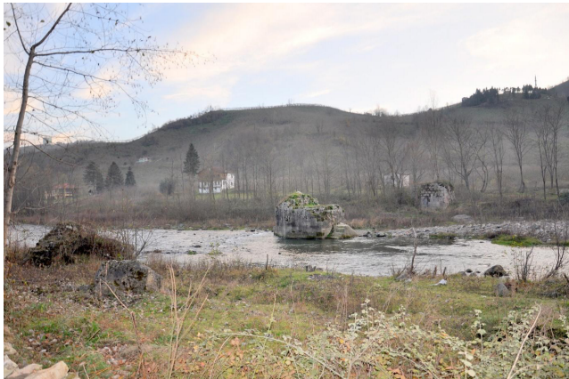
Resim 152- Ulubey Kiranyağmur Köprüsü
