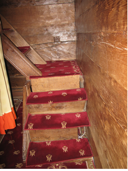
Resim 90- Laleli (Eski) Camii Mahfil Merdiveni
