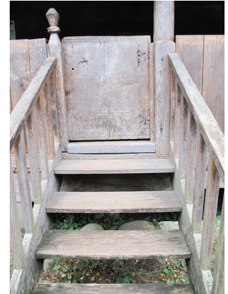
Resim 83- İkizce Laleli (Eski) Camii Kuzeydeki Merdiven
