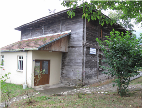
Resim 100- Çaybaşı Çayır Camii Kuzeybatıdan Görünüş
