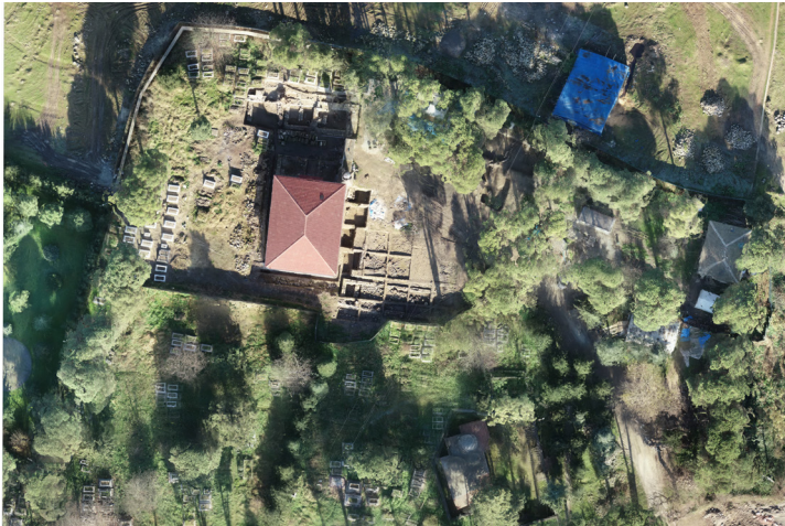
Resim 40- Eskipazar Camii Restorasyon Sonrası Havadan Görünümü (2023)
