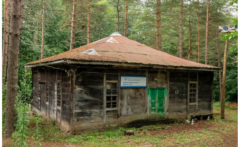
Resim 130- Akkuş Ambargürgen Mahallesi Merkez Camii Genel Görünüşü
