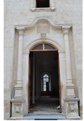
Resim 58- Altınordu Atik İbrahim Paşa (Orta) Camii Doğu Kapısı
