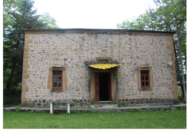
Resim 63- Çamaş Edirli Külekçi Camii Giriş Cephesi
