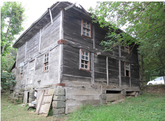
Resim 108- Fatsa Oluklu Mahallesi Sarnıç Camii Kuzeybatıdan Görünüş
