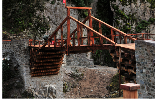
Resim 151- Kabadüz Başkotana Köprüsü Restorasyon Sonrası Görünümü
