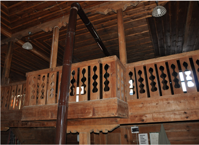
Resim 122- Şenyurt Mahallesi Eski Camii Kadınlar Mahfili
