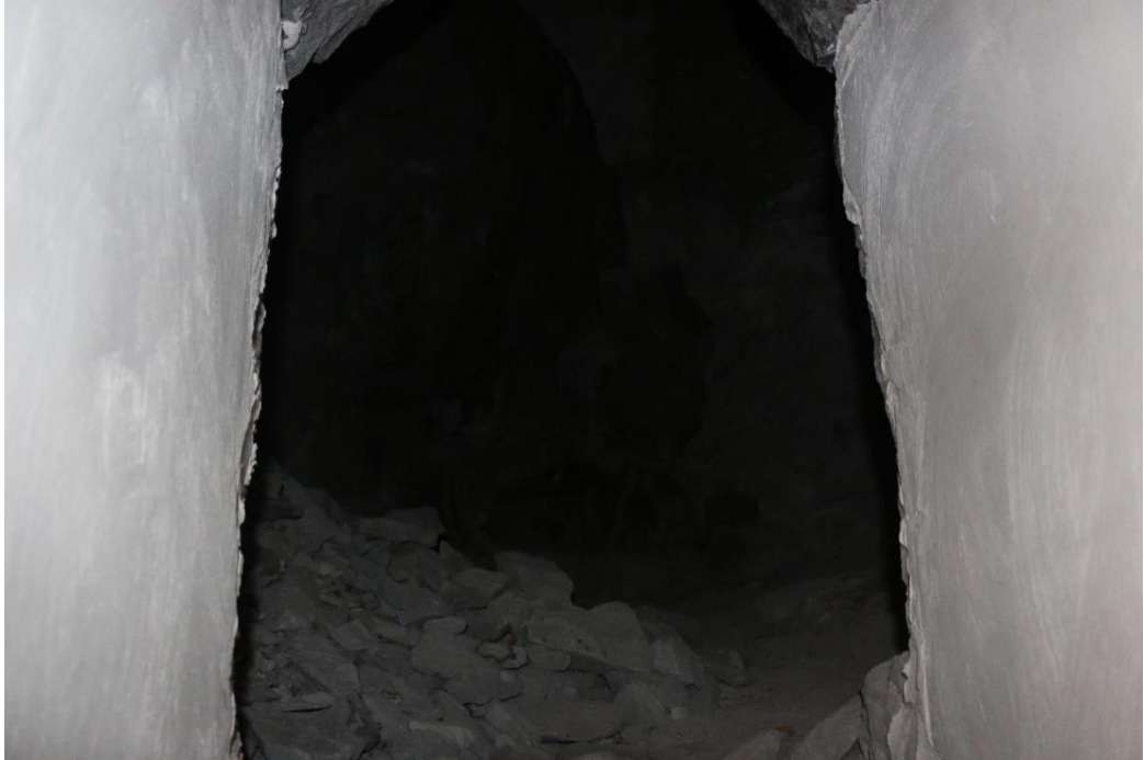
Görsel 32. Restorasyon Sonrası İkinci Kademenin Kuzeyindeki Odanın Kuzey Duvarı Depo
