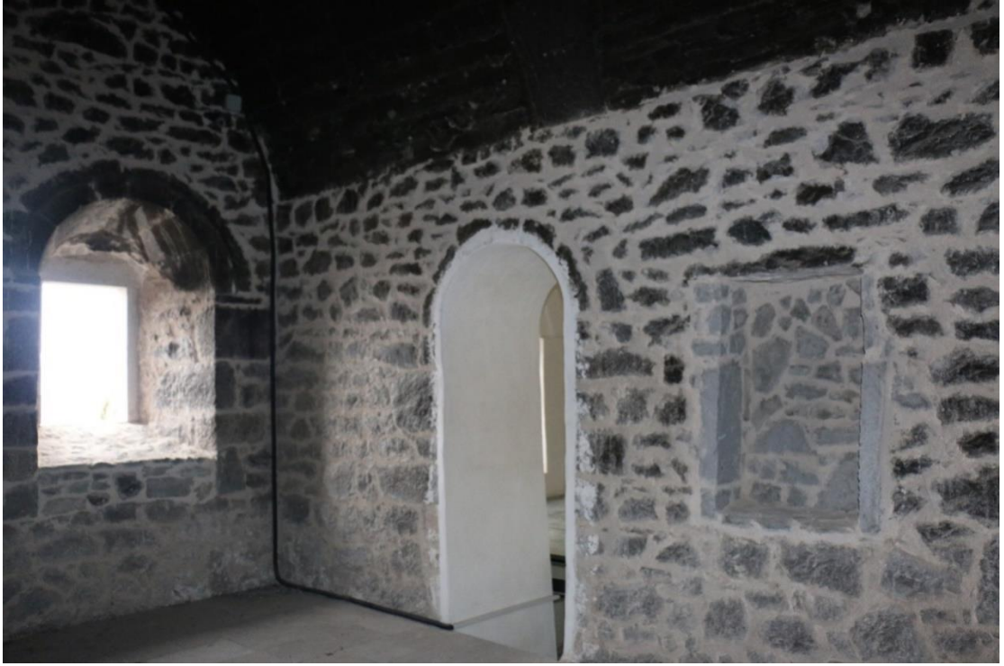
Görsel 44. Restorasyon Sonrası İkinci Kademedeki Mutfak Kuzey Duvarındaki Yemek Salonuna Geçiş
