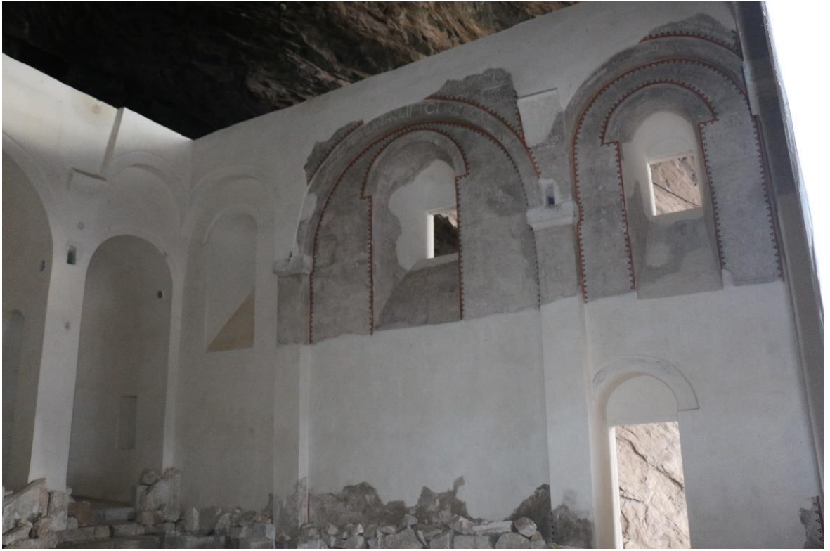
Görsel 82. Restorasyon Sonrası Kilisenin Kuzey Duvarı
