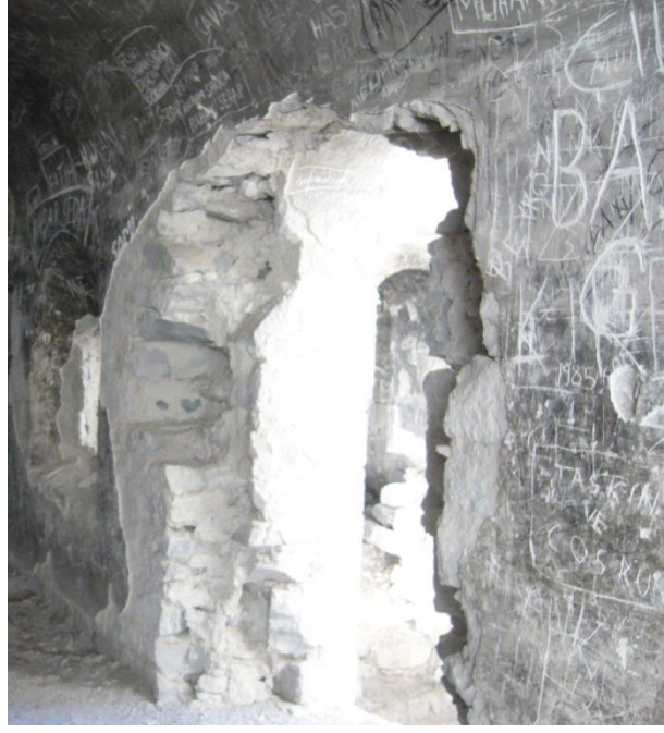
Görsel 45. Restorasyon Öncesi İkinci Kademedeki Koridorun Sağındaki Yemek Salonu Girişi (Trabzon Rölöve ve Restorasyon Anıtlar Kurulu)
