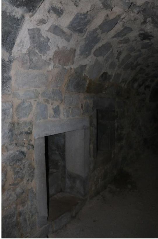
Görsel 100. Restorasyon Sonrası Kiliseye Bitişik Dehliz Doğu Duvarındaki Açıklıklar
