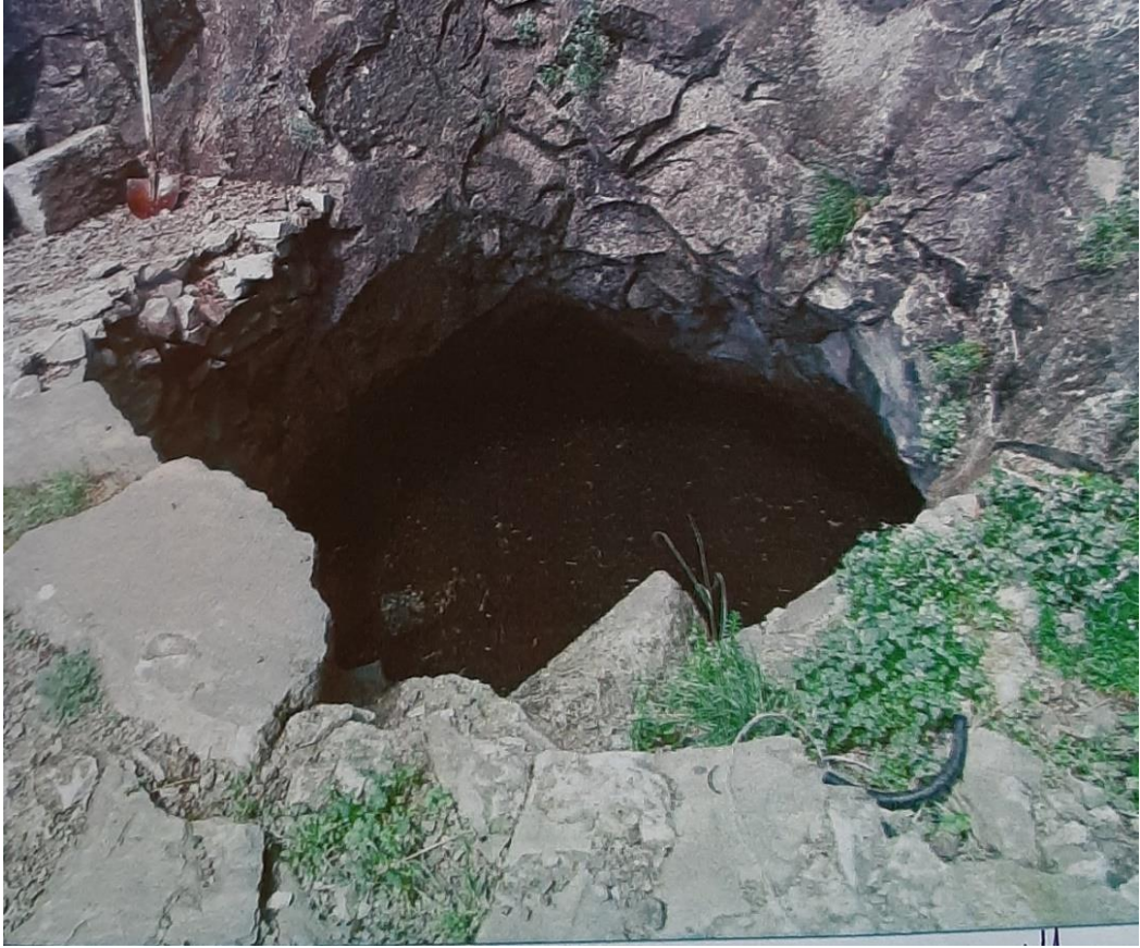
Görsel 6. Restorasyon Sonrası Ayazma
