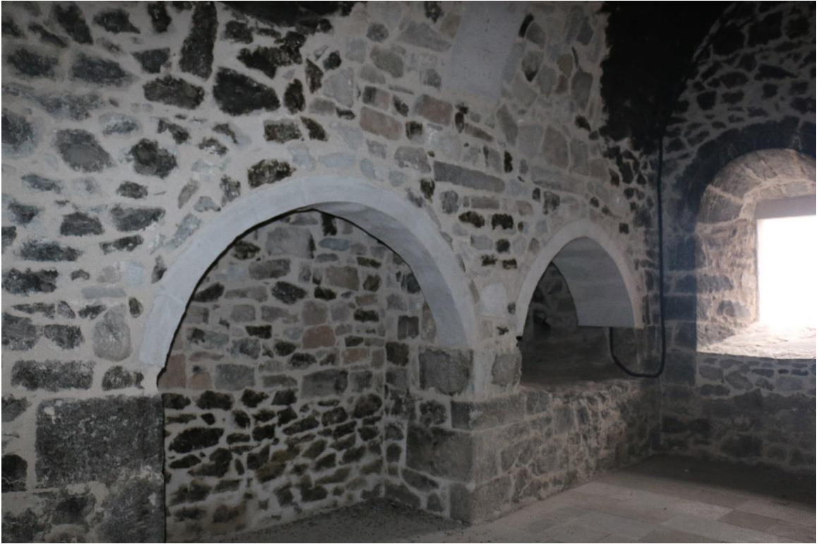
Görsel 42. Restorasyon Sonrası İkinci Kademedeki Mutfak Güney Duvarındaki Ocak
