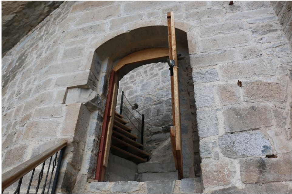
Görsel 10. Restorasyon Sonrası Birinci Kat Giriş Kapısı
