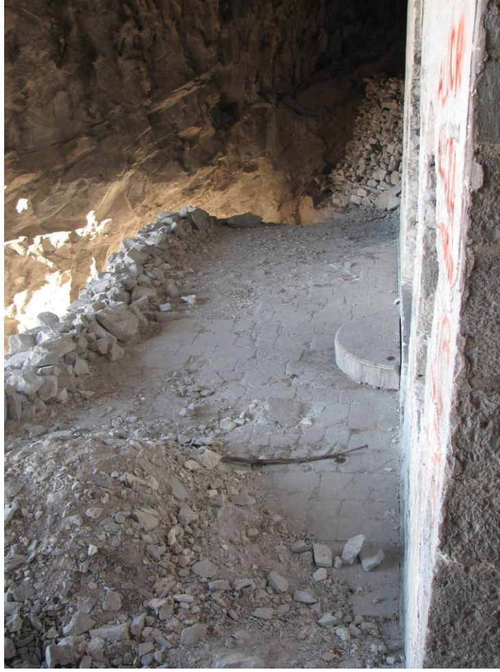
Görsel 71. Restorasyon Öncesi Kilisenin Ön Terası (Trabzon Rölöve ve Restorasyon Anıtlar Kurulu)
