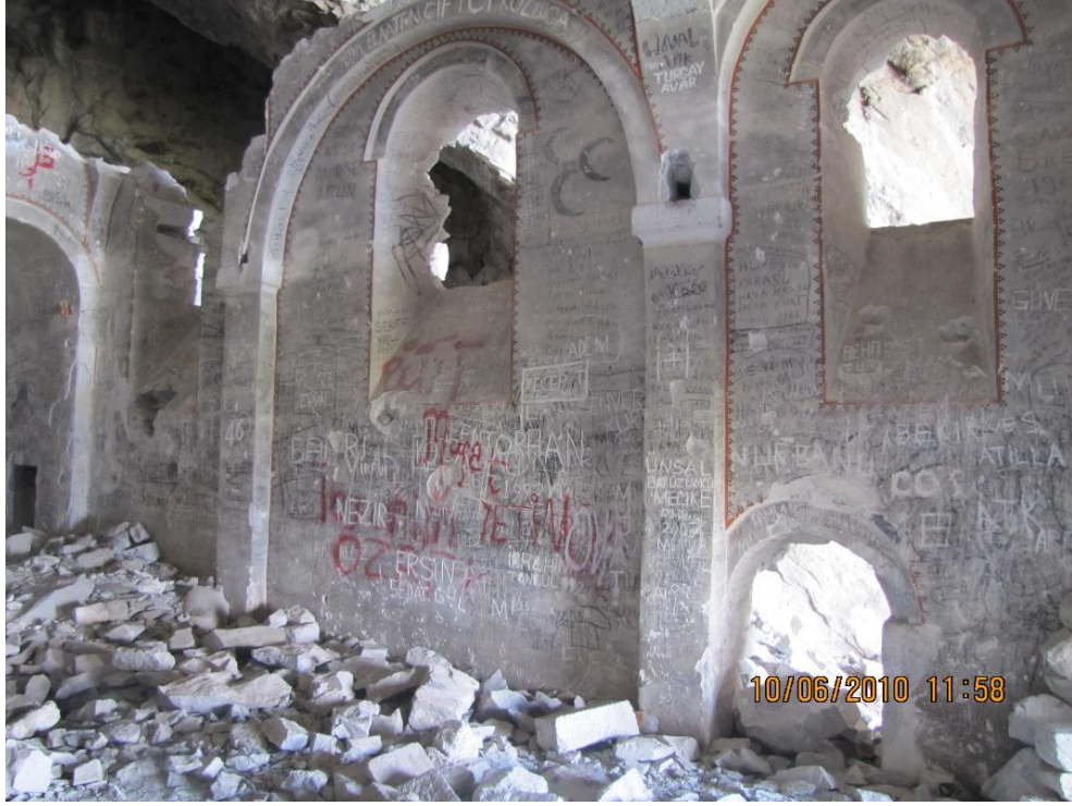
Görsel 81. Restorasyon Öncesi Kilisenin Kuzey Duvarı (Trabzon Rölöve ve Restorasyon Anıtlar Kurulu)
