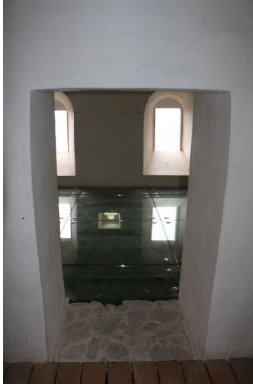
Görsel 46. Restorasyon Sonrası İkinci Kademedeki Koridorun Sağındaki Yemek Salonu Girişi
