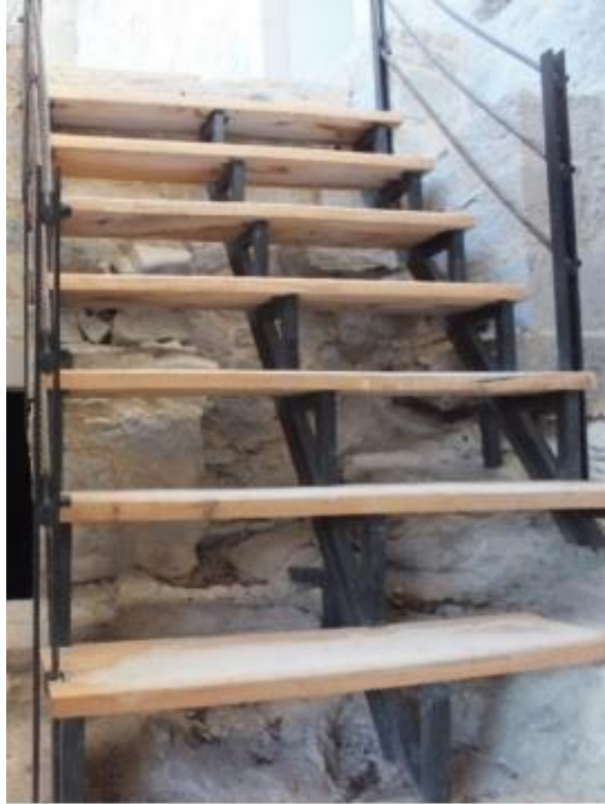
Görsel 14. Restorasyon Sonrası Birinci Kata Eklenen Ahşap Merdiven
