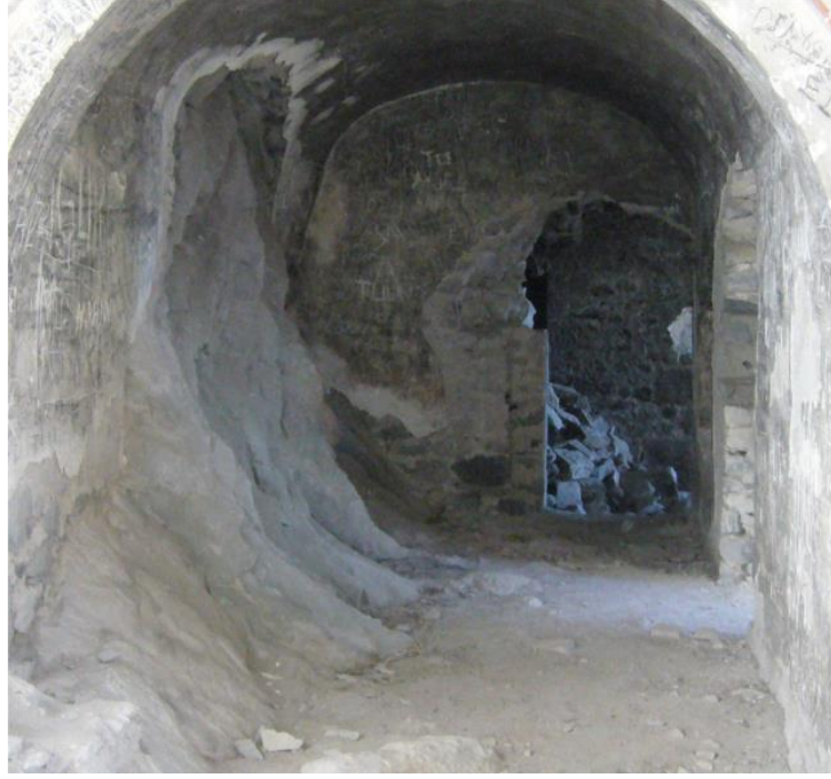
Görsel 37. Restorasyon Öncesi İkinci Kademenin Güneyindeki Koridor (Trabzon Rölöve ve Restorasyon Anıtlar Kurulu)
