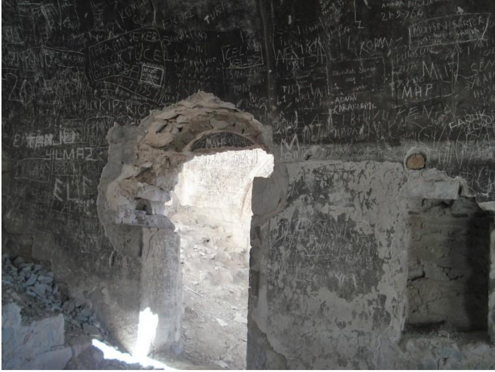
Görsel 33. Restorasyon Öncesi İkinci Kademe Odanın Güneyindeki Niş (Trabzon Rölöve ve Restorasyon Anıtlar Kurulu)
