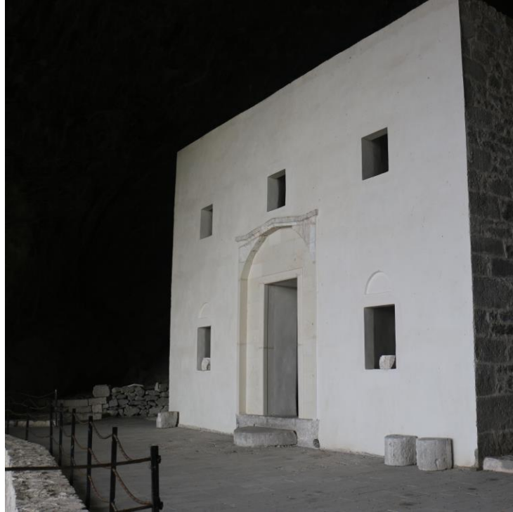
Görsel 74. Restorasyon Sonrası Kilisenin Batı Cephesi
