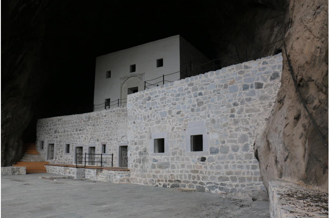
Görsel 60. Restorasyon Sonrası İkinci Kademedeki Üçüncü Kat Teras ve Gerisindeki Hücreler
