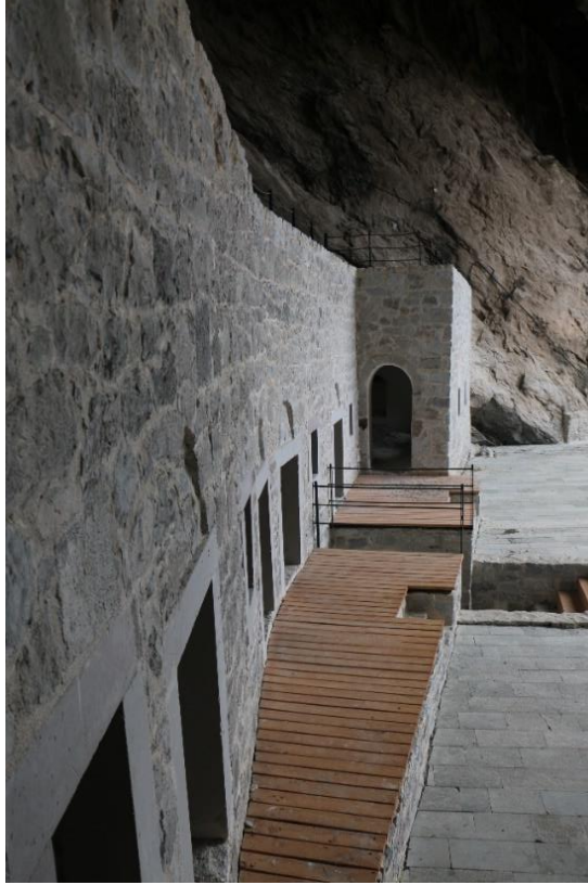
Görsel 62. Restorasyon Sonrası İkinci Kademedeki Üçüncü Kat Teras Hücrelerin Önüne Eklenen Ahşap Koridor
