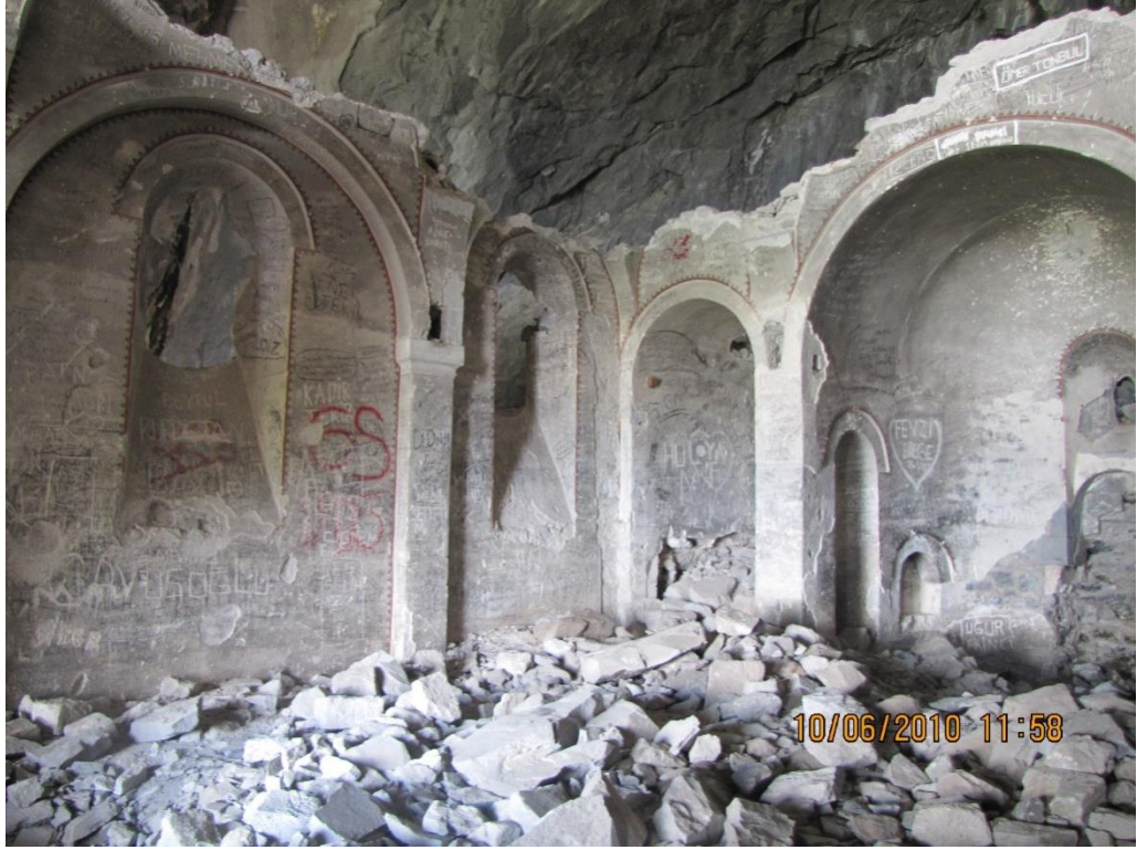
Görsel 83. Restorasyon Öncesi Kilisenin Güney Duvarı (Trabzon Rölöve ve Restorasyon Anıtlar Kurulu)
