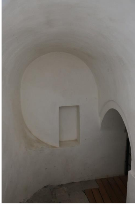
Görsel 56. Restorasyon Sonrası İkinci Kademedeki Üçüncü Kata Giriş Kapısının Güneyindeki Niş
