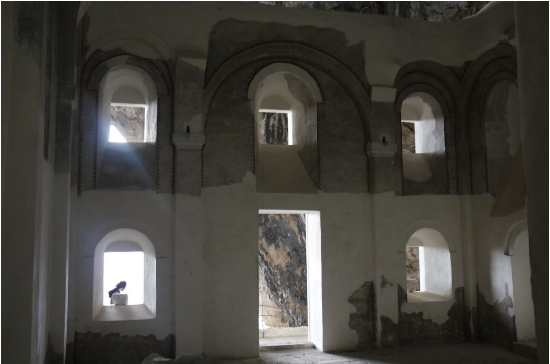
Görsel 86. Restorasyon Sonrası Kilise Batı Duvarı
