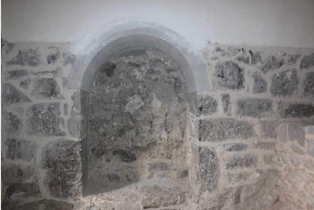
Görsel 68. Restorasyon Sonrası İkinci Kademedeki Üçüncü Kat Teras En Kuzeyindeki Hücresinin Onarılan Nişi
