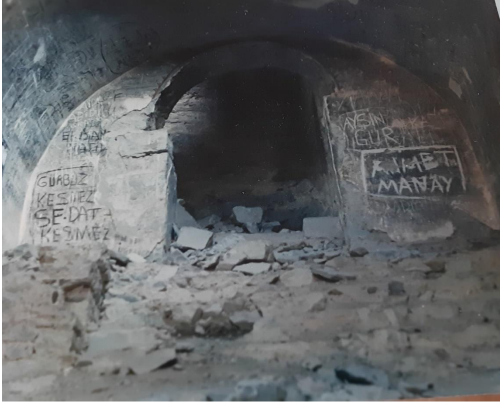
Görsel 53. Restorasyon Öncesi İkinci Kademedeki Üçüncü Kata Geçilen Giriş Kısmı (Trabzon Rölöve ve Restorasyon Anıtlar Kurulu)
