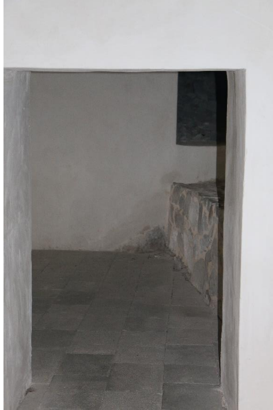
Görsel 28. Restorasyon Sonrasında İkinci Kademenin Kuzeyindeki Odanın Girişi
