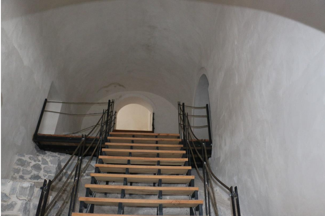
Görsel 20. Restorasyon Sonrası İkinci Kat Eklenen Ahşap Merdiven ve Tamamlanan Üst Örtü
