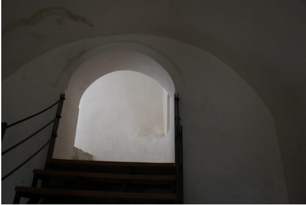
Görsel 54. Restorasyon Sonrası İkinci Kademedeki Üçüncü Kata Geçilen Giriş Kısmı
