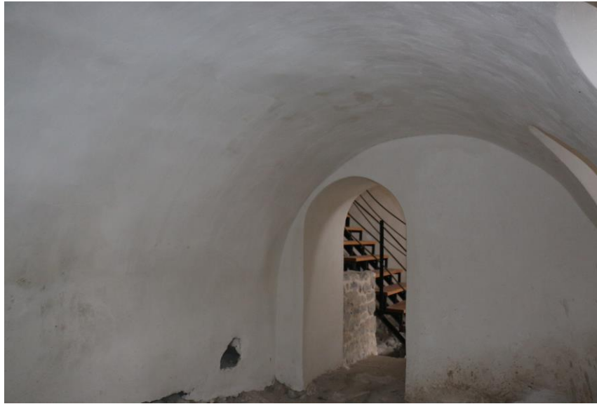
Görsel 26. Restorasyon Sonrası İkinci Kat Girişin Kuzeyindeki Oda
