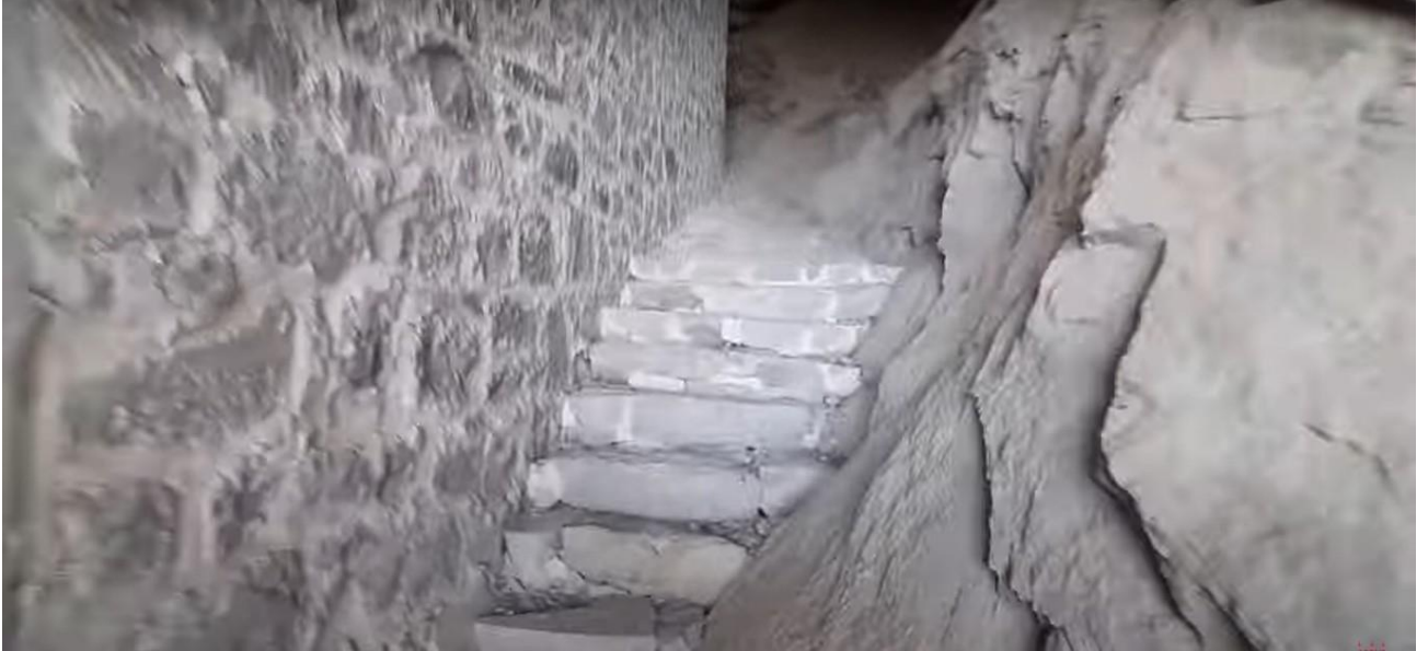
Görsel 96. Restorasyon Sonrası Kilisenin Güney Cephesinde Dehlize Giden Merdiven
