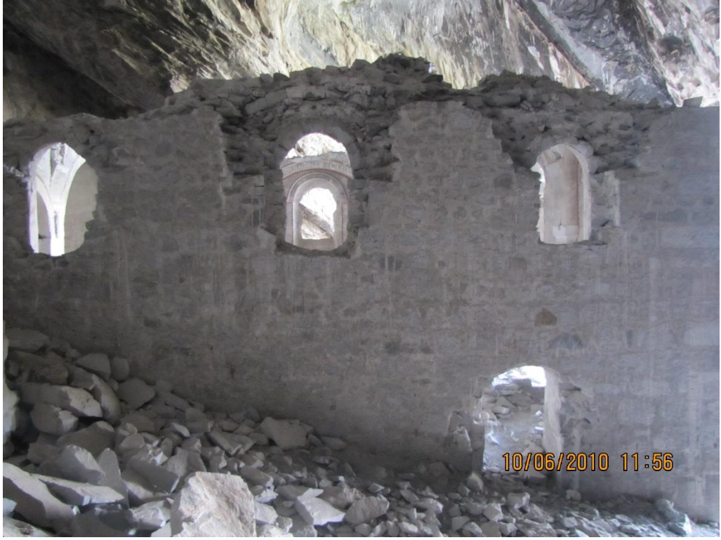
Görsel 87. Restorasyon Öncesi Kilisenin Kuzey Cephesi (Trabzon Rölöve ve Restorasyon Anıtlar Kurulu)
