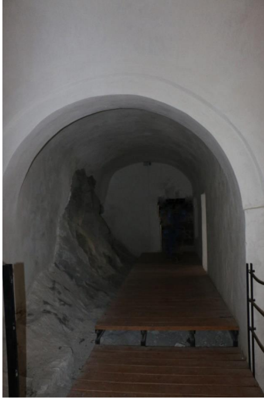
Görsel 38. Restorasyon Sonrası İkinci Kademenin Güneyindeki Koridor
