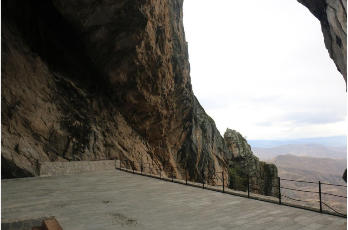
Görsel 58. Restorasyon Sonrası İkinci Kademedeki Üçüncü Kat Terasın Durumu
