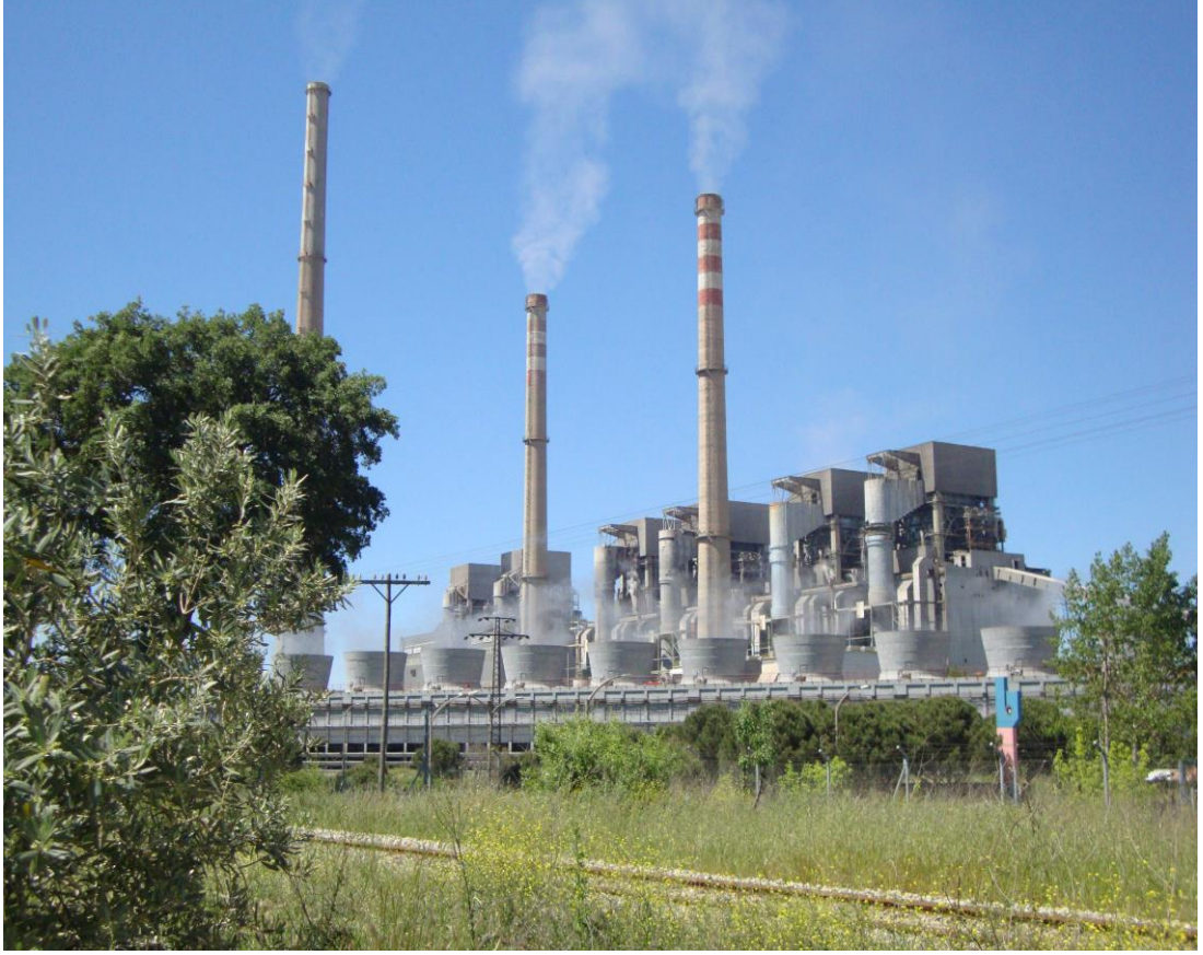
Ek 1. Soma Termik Santralinden görünüm
