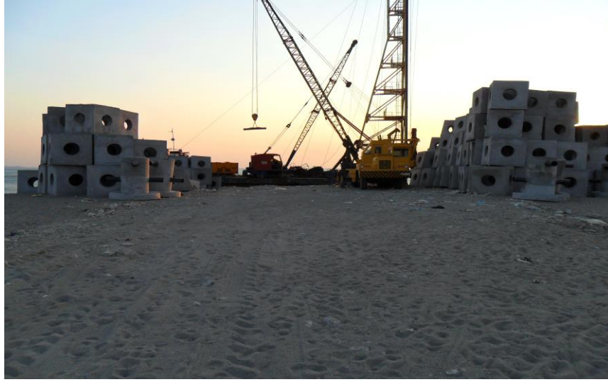
Őekil 3.14. Yapay resiflerin sahtilden yzen platforma istiflenmesi
