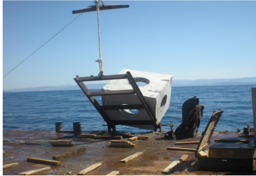
Şekil 3.17. Resif ünitesinin vinç yardımıyla kaydırılarak denize atılması
