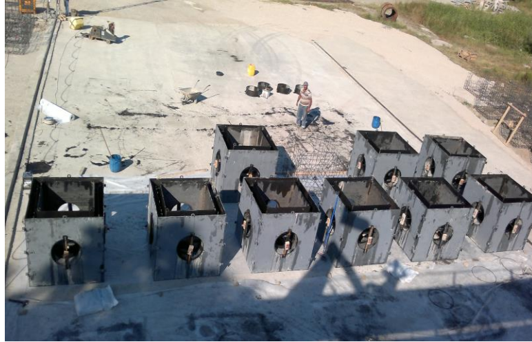
Şekil 3.9. Resif bloğu imalatında kullanılan kalıplar
