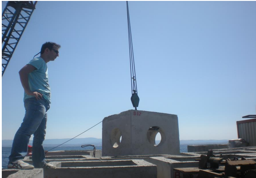
Őekil 3.15. İstiflenen yapay resif nitesinin vin yardımıyla alınması
