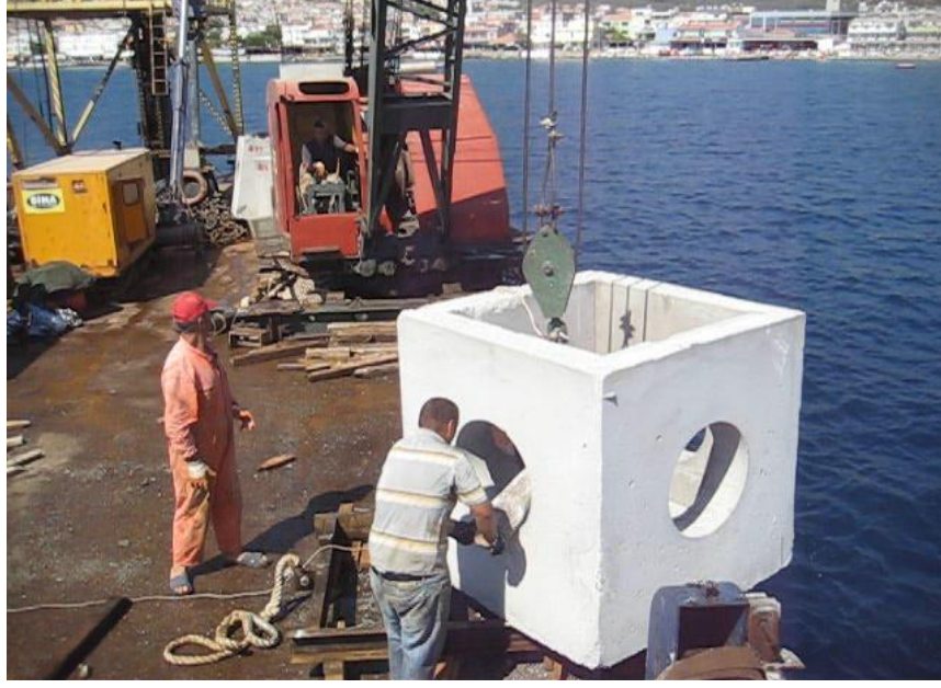
Şekil 3.16. Resif ünitesinin vinç aparatından çıkarılması
