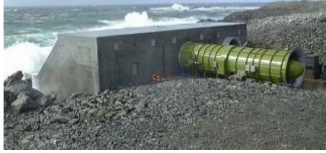
Şekil 2.1 LIMPET Genel Görünüm
