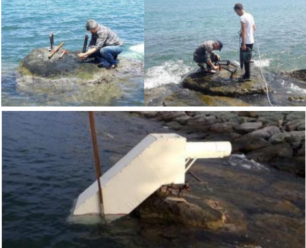
Şekil 2.37 OWC Sistemlerinin Kurulma Aşamaları
